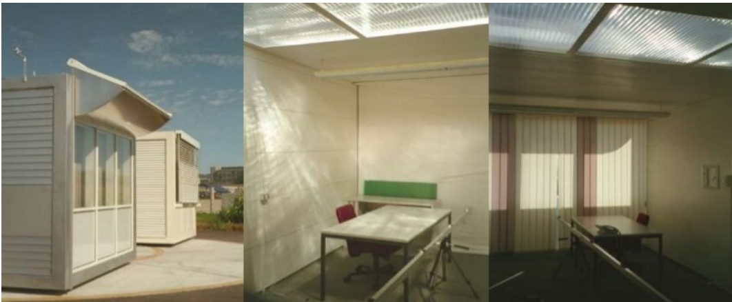
Şekil 2.5. Anidolik aydınlatma sistemleri (Scartezzini ve Münch, 2010)
