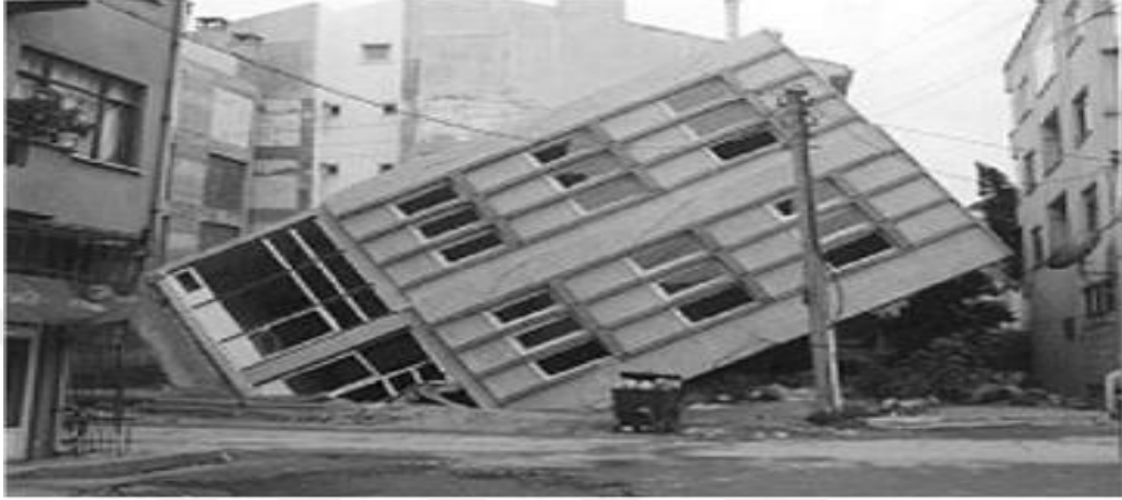
Şekil 3.5. Adapazarı depremi sonrası sıvılaşma
