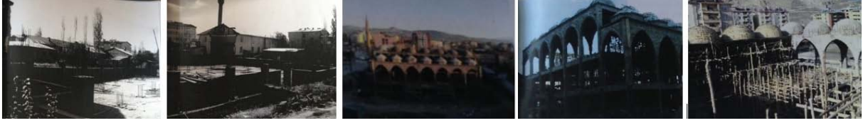
Fotoğraf 16: Yeni Norşin Camii'nin Yapım Aşamalarına Ait Fotoğraflar
