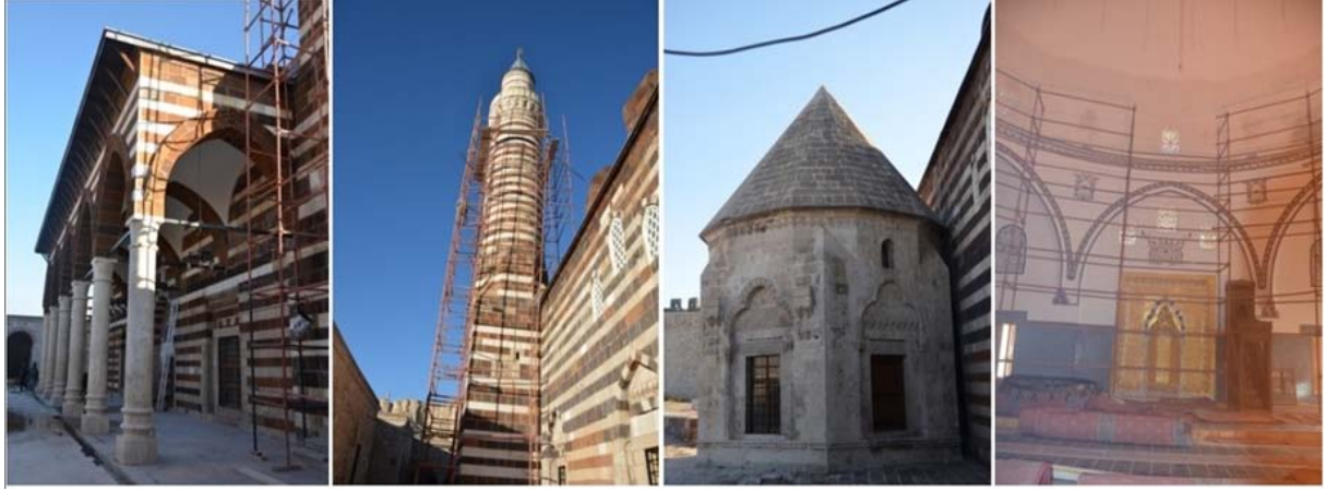
Fotoğraf 10: Hüsrev Paşa Camii'nde Restorasyon Çalışmaları
