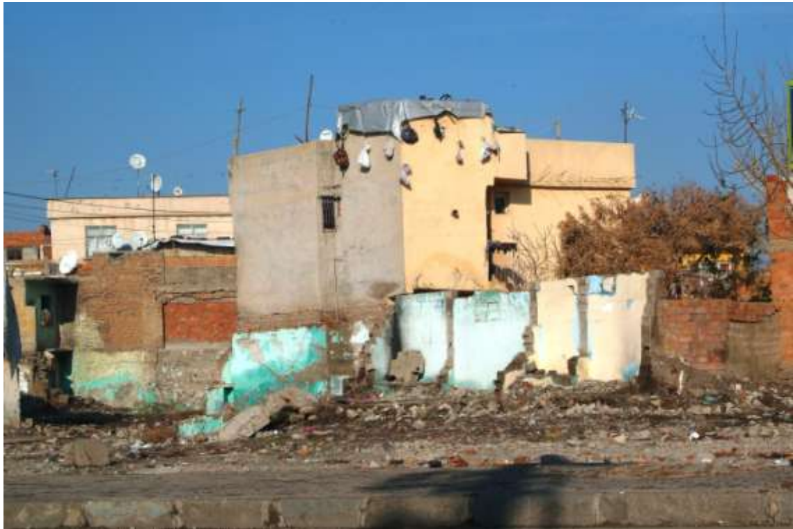
Şekil 2.1.1.4. Suriçi Alipaşa Mahallesi Kentsel Dönüşüm (11.09.2015)
