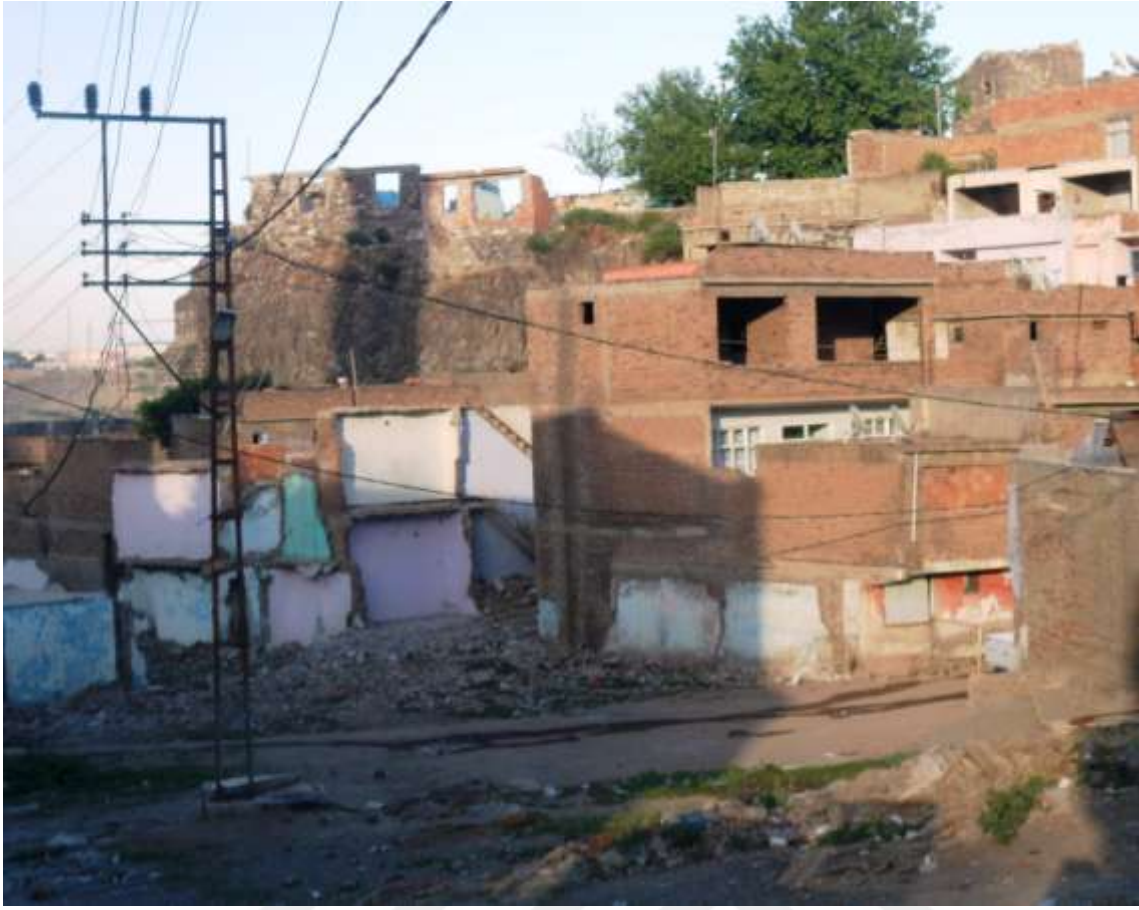
Şekil 2.1.1.3. Suriçi Cevatpaşa Mahallesi kentsel dönüşüm (02.10.2015)
