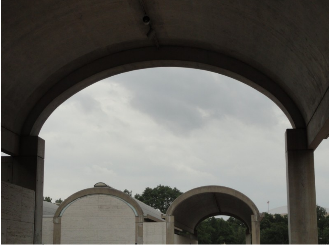
Fotoğraf 39: KSM'nin Sikloid Tonoz Çatılarının Detayı 244
