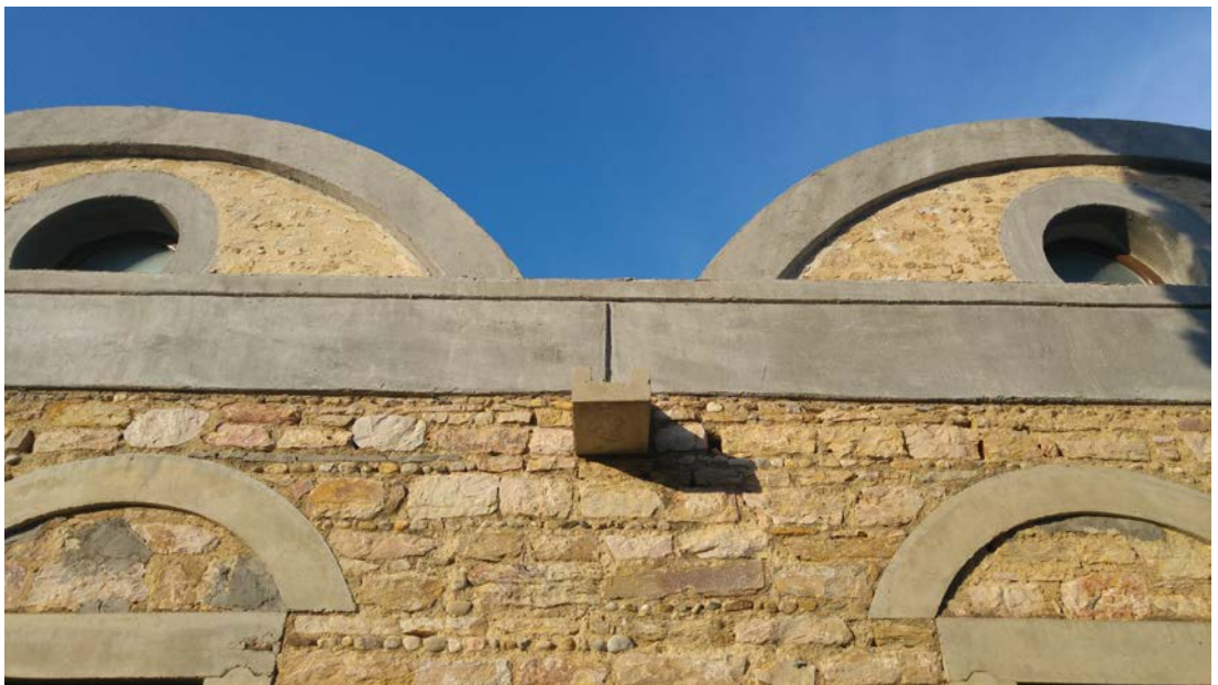
Fotoğraf 35: BSAE'nin Tonoz Çatı ve Cephe Detayı
