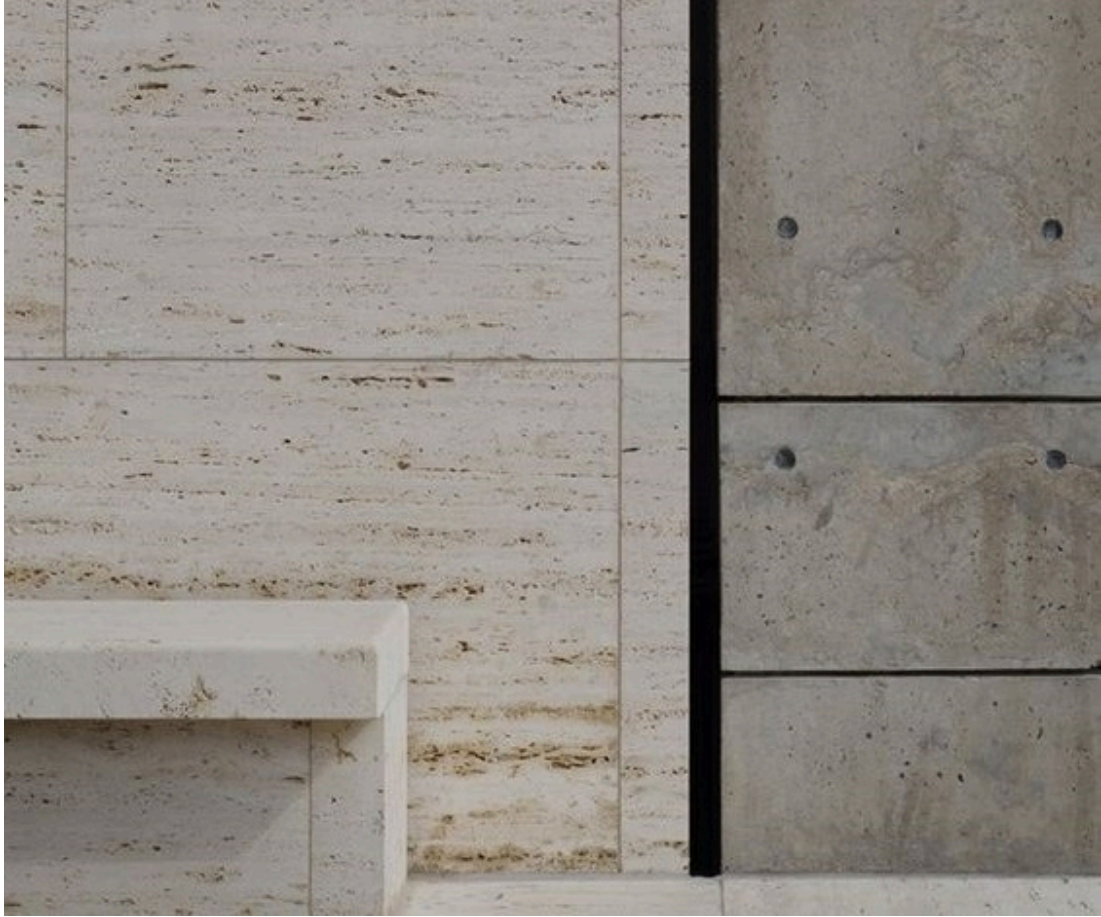
Fotoğraf 42: KSM’nin Duvarlarının Beton ve Doldurulmamış Traverten Detayı 247
