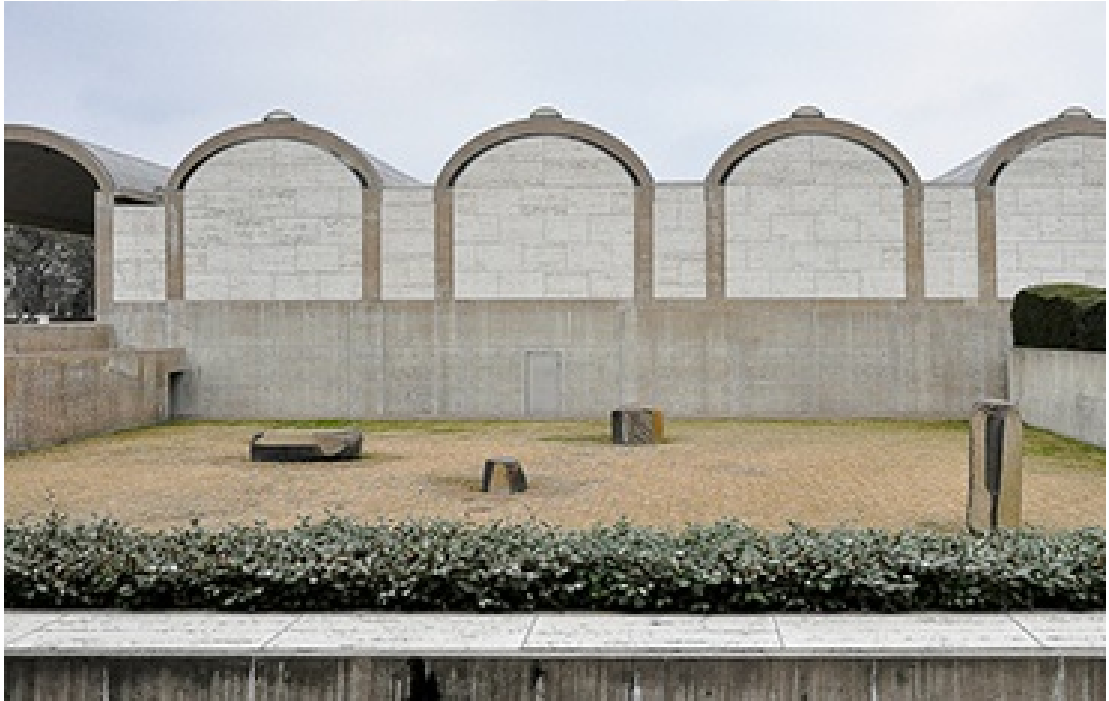
Fotoğraf 24: KSM'nin Batı Cephesi ve Portikolu Ana Girişi 235
