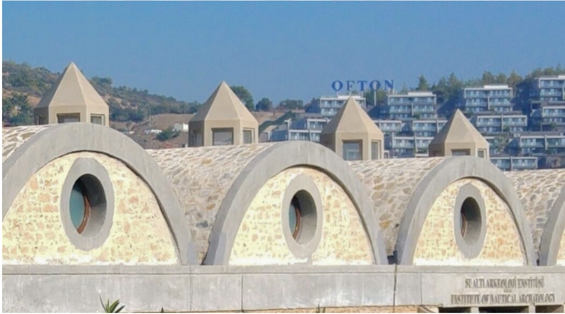
Fotoğraf 15: BSAE'nin Tonoz Biçimli Çatısı ve Işık Fenerleri
