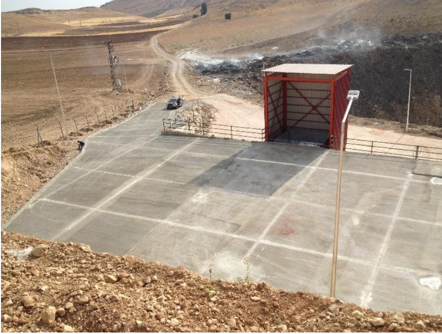
Şekil 5.37: Aktarma Yapısı, çöplerin nakliyesi sırasında toplayıcı aracının beklediği bölüm(MBB, 2016)
