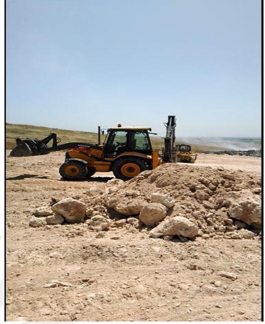
Şekil 5.34-5.35: Nihai toprak örtüsünün düzenlenmesi(MBB, 2016)
