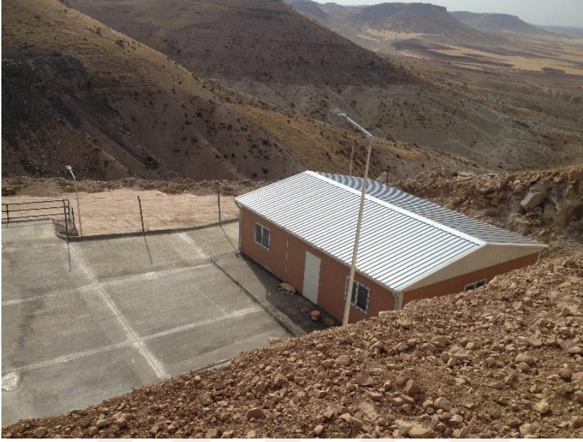
Şekil 5.39: Aktarma istasyonu İdari Binası(MBB, 2016)
