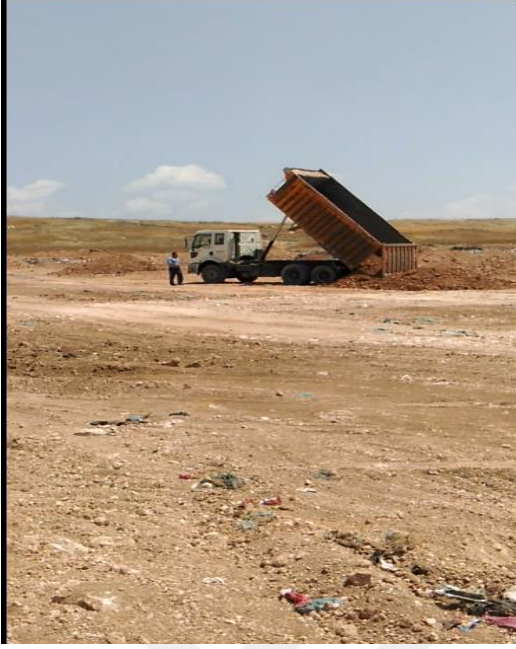
Şekil 5.34-5.35: Nihai toprak örtüsünün düzenlenmesi(MBB, 2016)
