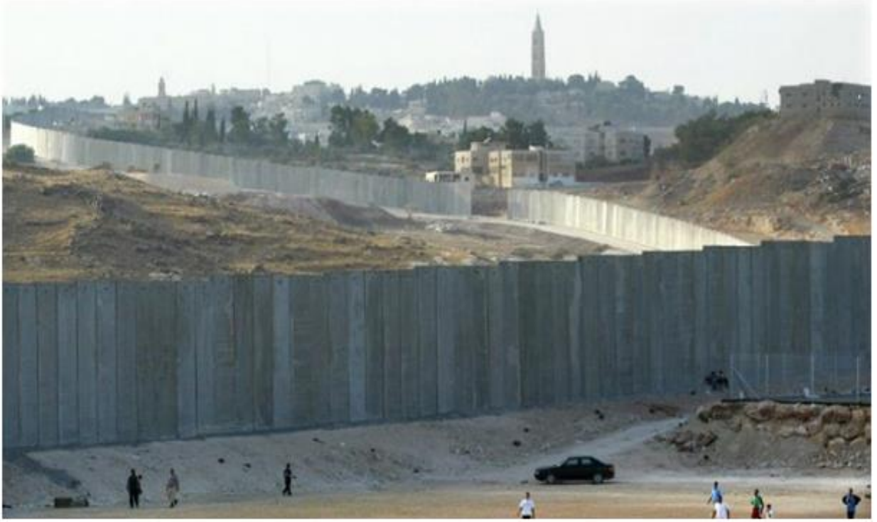
Fotoğraf 1. İsrail ve Filistin yerleşimlerini ayıran duvar,
