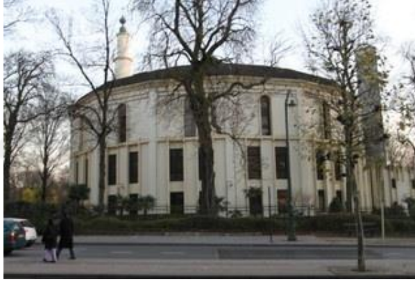
Fotoğraf 1: Grande Mosquée Bruxelles, cephe.
