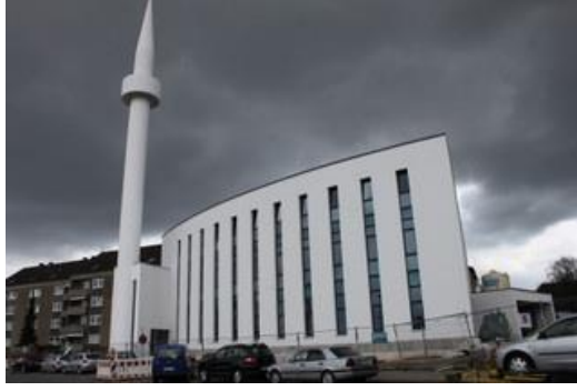
Fotoğraf 9: Aachen Yunus Emre Camii Cephesi
