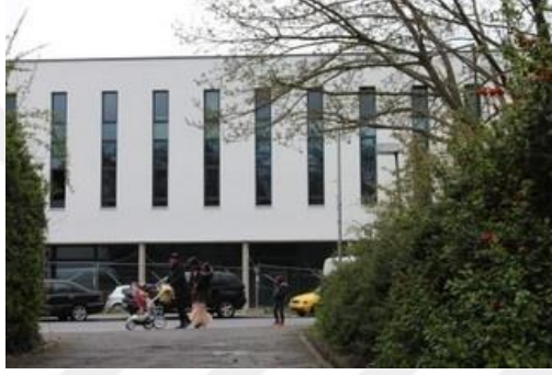
Fotoğraf 10: Aachen Yunus Emre Camii Cephesi.
