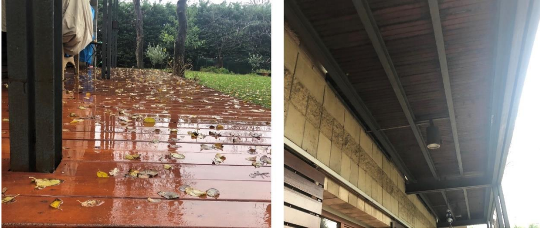
Resim 4.7. NP12 Projesi Dış Cephedeki Zemin Ve Tavan Görünüşleri (Hülya Irmak, 2018)
