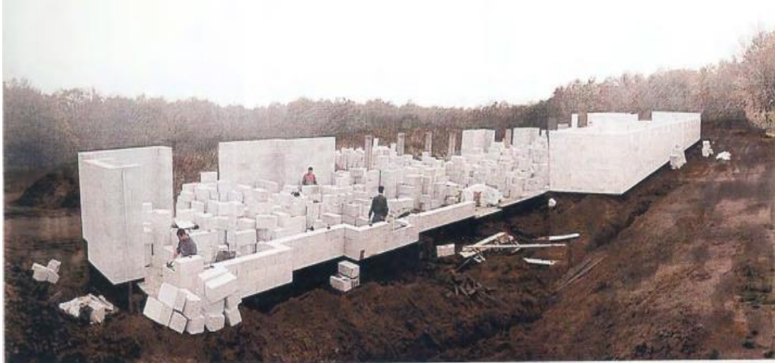
Resim 4.13. Lokman Şahin Evi Projesinde Parçaların Birleştirilmesi (URL 11)
