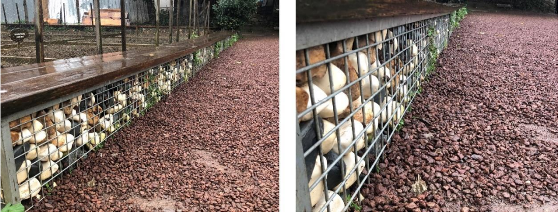
Resim 5.13. Kuzguncuk Bostanı Oturma Birimleri Ve Gabion Duvarlar (Hülya Irmak, 2018)
