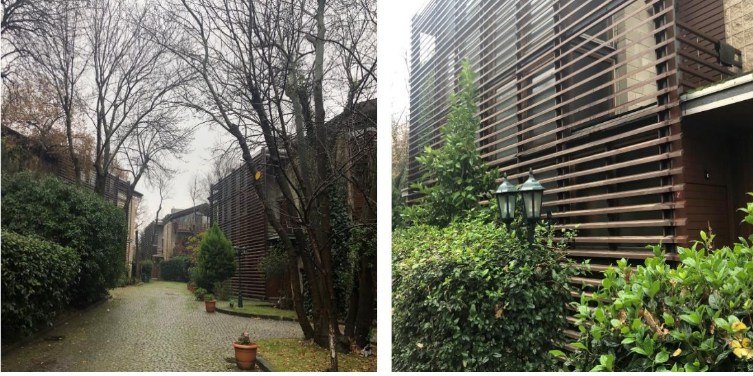
Resim 4.5. NP12 Projesi Dış Cephe Görünüş Detayları (Hülya Irmak, 2018)
