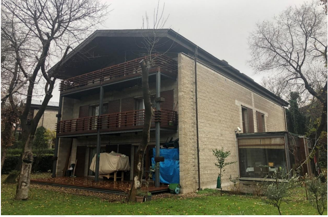
Resim 4.8. NP12 Projesi Dış Cephe Ve Bahçe Görünüşü (Hülya Irmak, 2018)
