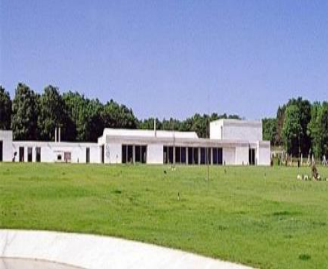
Resim 4.14. Lokman Şahin Evi Projesi Ön Cephe Görünüşü (URL 11)
