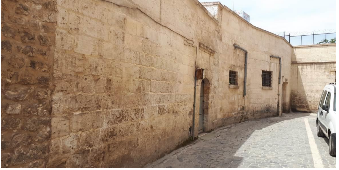
263 Ada 5 Numaralı Parsel Mevcut Cephe Görünümü.
