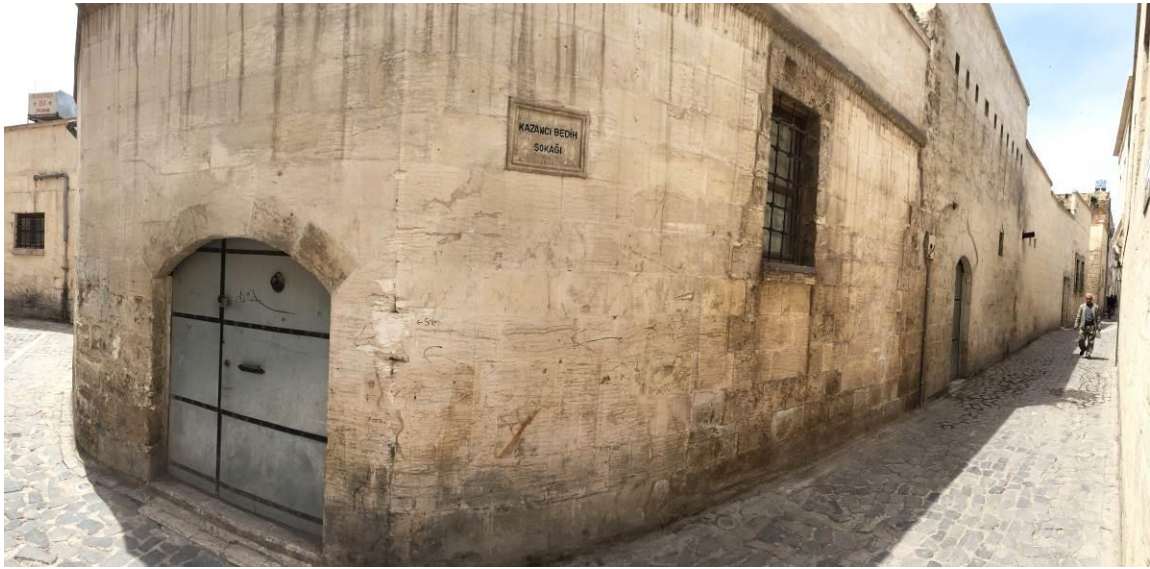
263 Ada 2 Numaralı Parsel Mevcut Güney Cephe Görünümü
