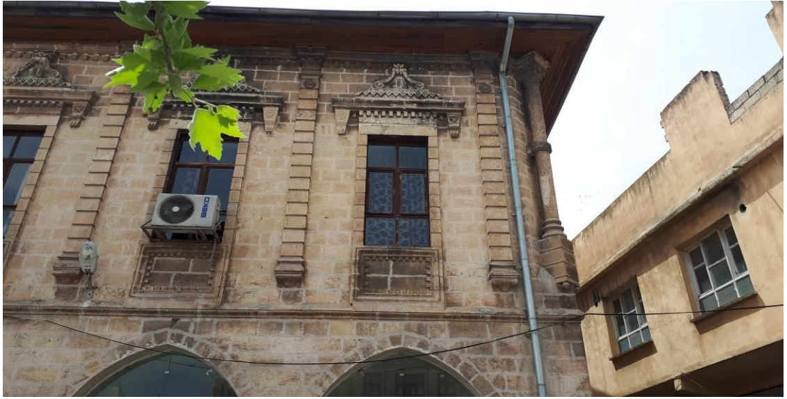
158 Ada 42 Numaralı Parsel Mevcut Kuzey Cephe Görünümü.
