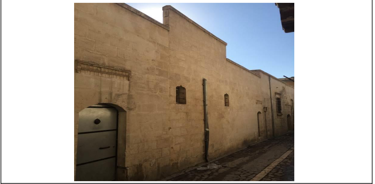
300 Ada 24 Numaralı Parsel Mevcut Cephe Görünümü.
