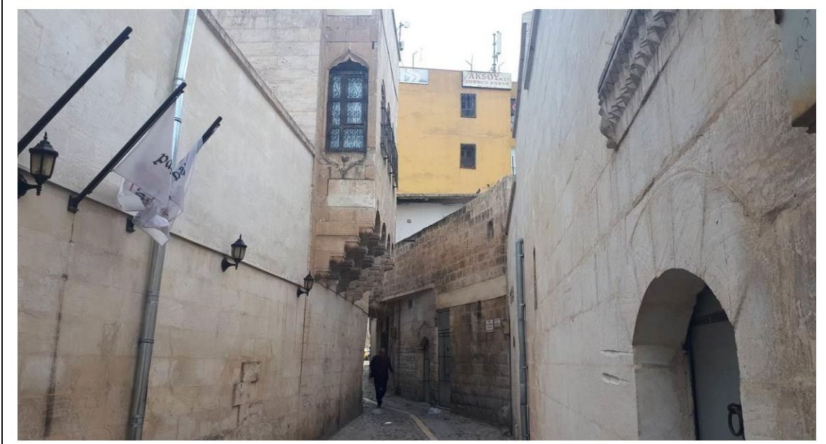
301 Ada 6 Numaralı Parsel Mevcut Durum Cephe Fotoğrafi.
