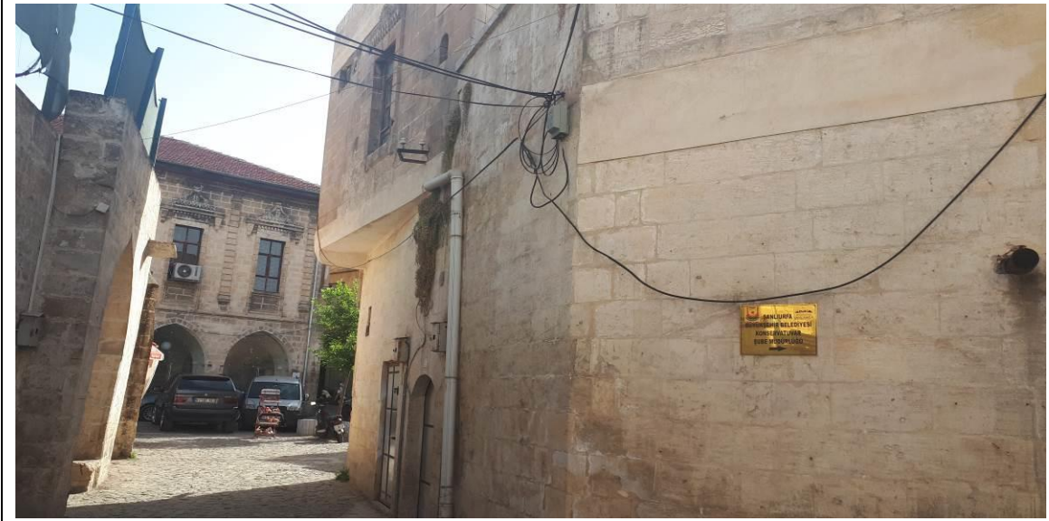
Cephe Üzerindeki bulunan Eklerin Görünümleri
