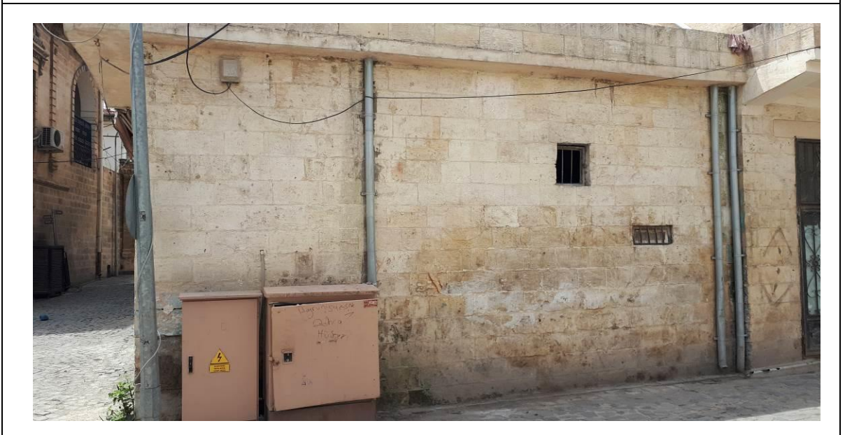
263 Ada 6 Numaralı Parsel Mevcut Cephe Görünümü.
