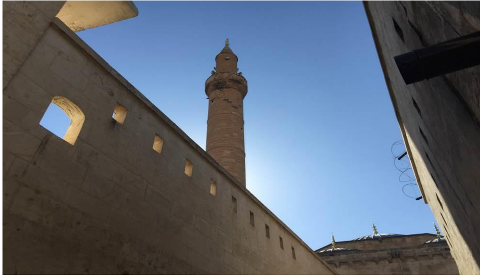
299 Ada 12 (22-23) Numaralı Parsel Mevcut Kuzey Cephe Görünümü
