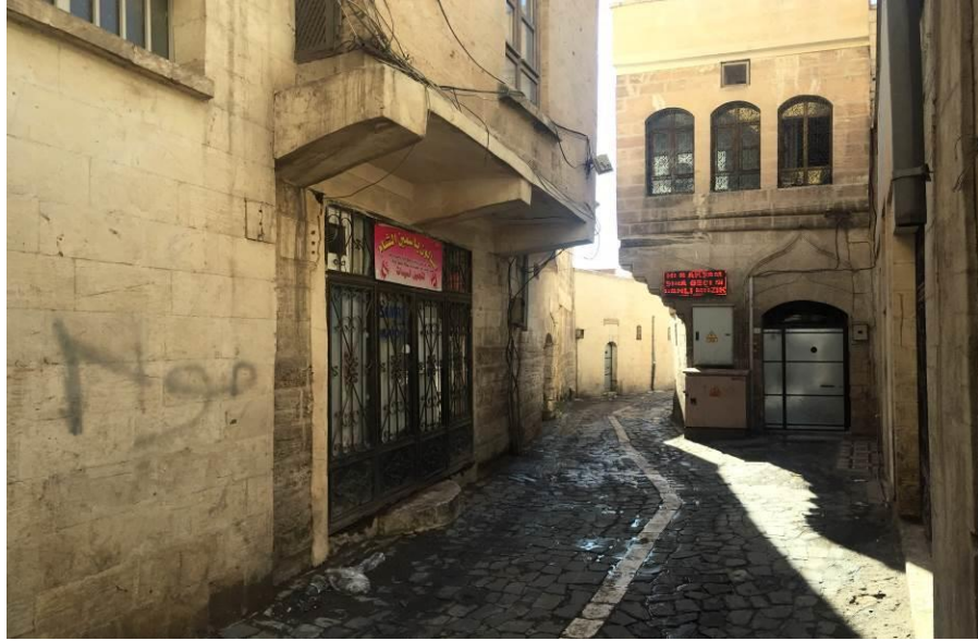
Cephe Üzerindeki bulunan Eklerin (Tabela, Elektrik Panosu) Görünümleri
