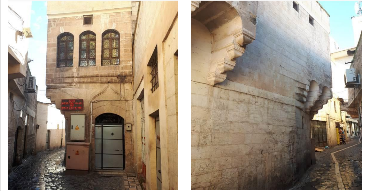
301 Ada 6 Numaralı Parsel Mevcut Sokak Görünümü.
