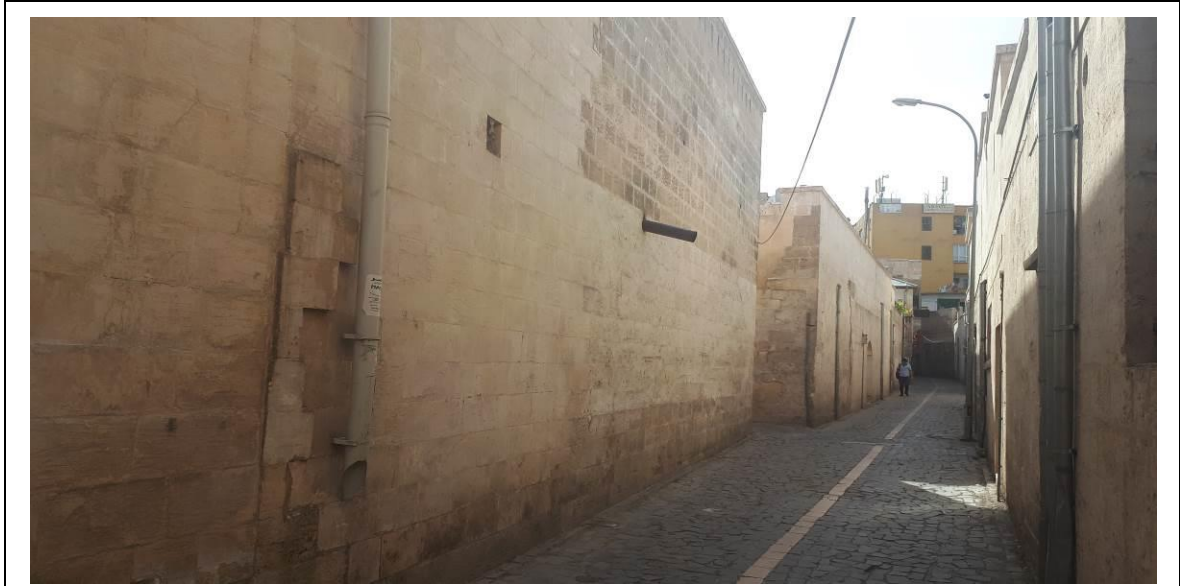
261 Ada 1 Numaralı Parsel Mevcut Sokak Görünümü.
