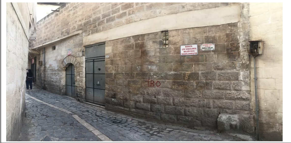
300 Ada 25 Numaralı Parsel Mevcut Cephe Görünümü.
