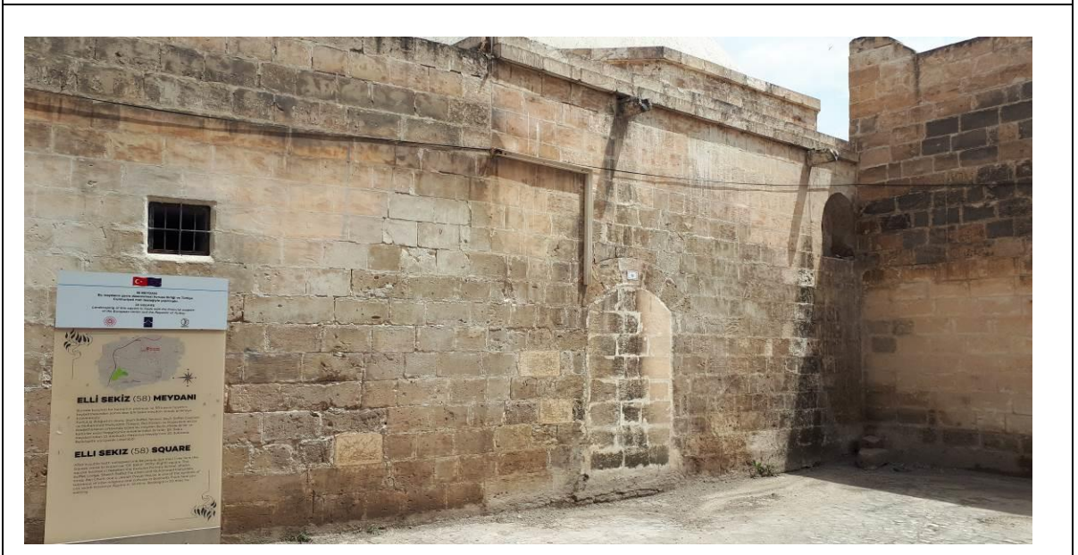
163 Ada 1 Numaralı Parsel Mevcut Güney Cephe Görünümü.
