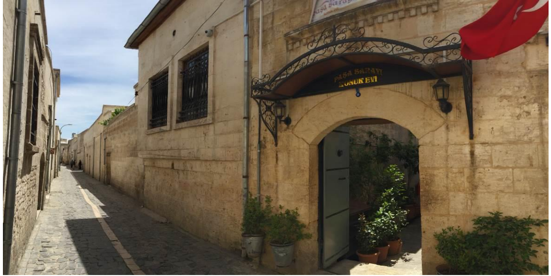
301 Ada 8 Numaralı Parsel Mevcut Cephe Görünümü
