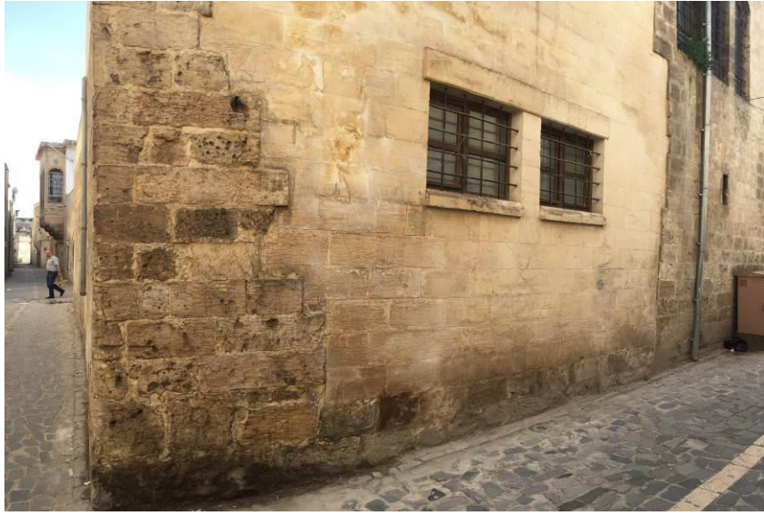
262 Ada 4 Numaralı Parsel Mevcut Cephe Görünümü
