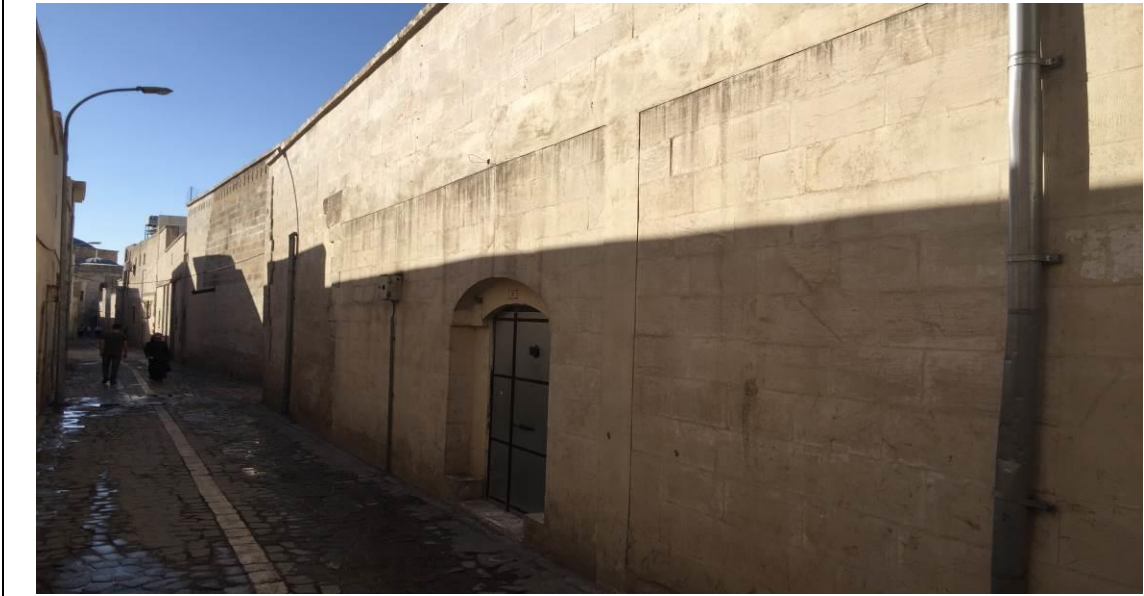
301 Ada 9 Numaralı Parsel Mevcut Sokak Görünümü.
