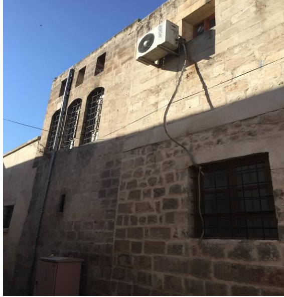
262 Ada 3 Numaralı Parsel Mevcut Cephe Görünümü
