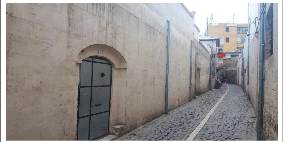
301 Ada 9 Numaralı Parsel Mevcut Sokak Görünümü.
