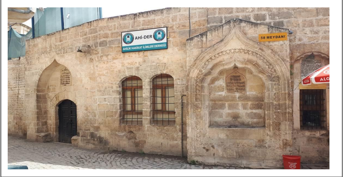
163 Ada 1 Numaralı Parsel Mevcut Cephe Görünümü.
