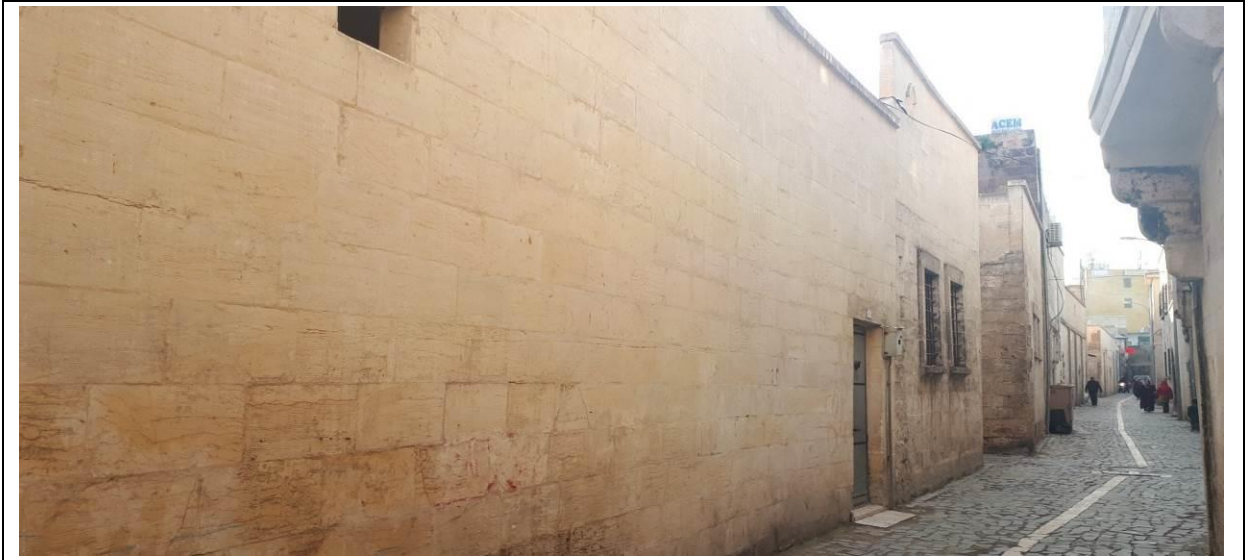
263 Ada 1 Numaralı Parsel Mevcut Sokak Görünümü.
