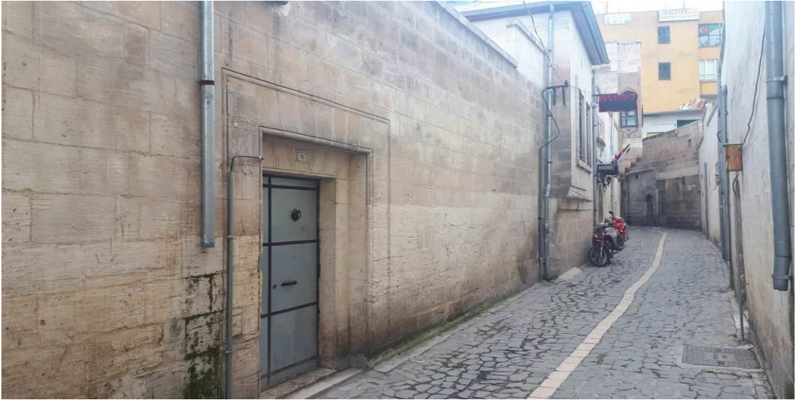
301 Ada 8 Numaralı Parsel Mevcut Sokak Görünümü.
