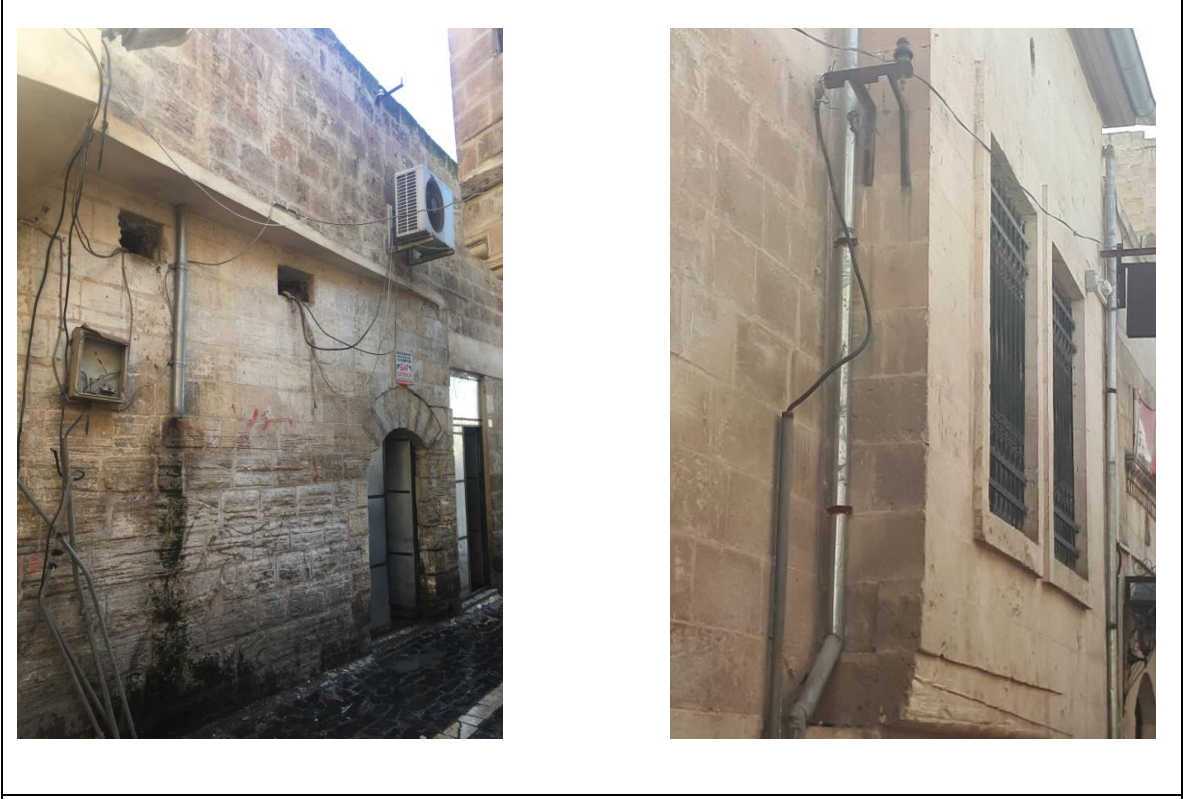
Cephe Üzerindeki bulunan Eklerin Görünümleri
