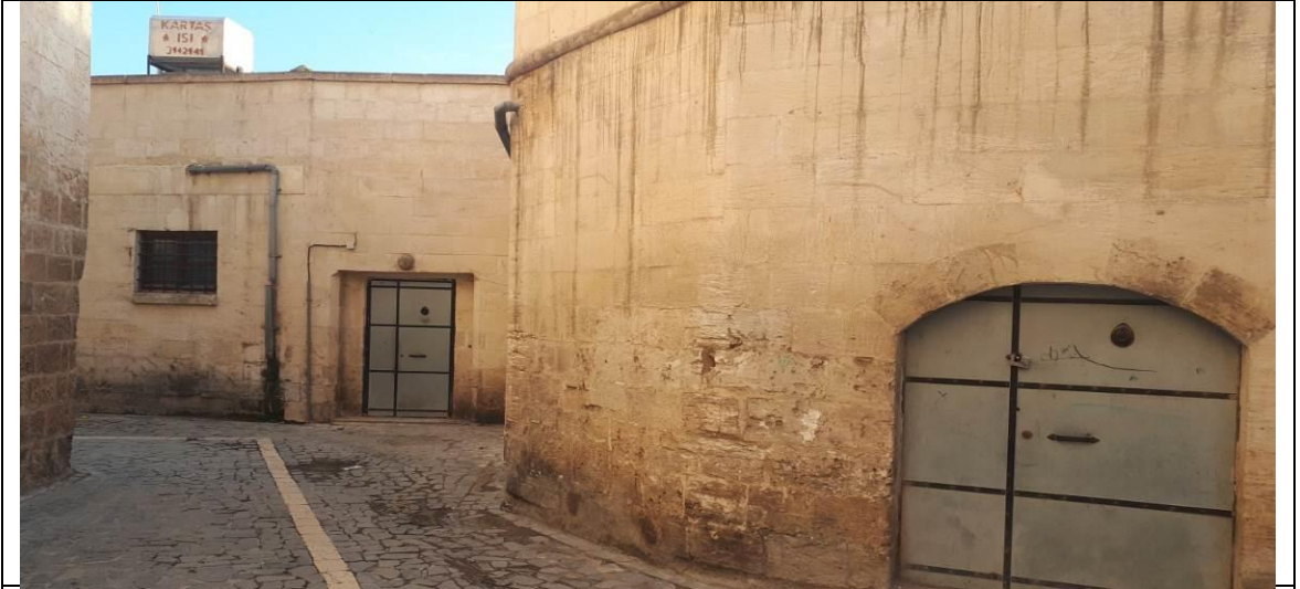
263 Ada 3 Numaralı Parsel Mevcut Güney Cephe Görünümü
