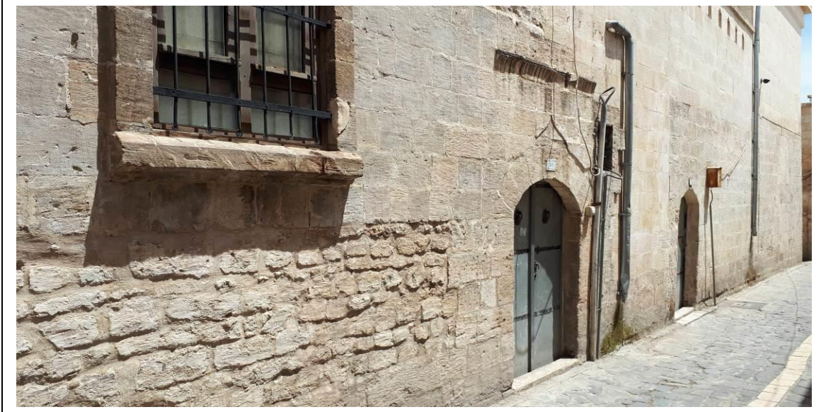
300 Ada 22 Numaralı Parsel Mevcut Cephe Görünümü.
