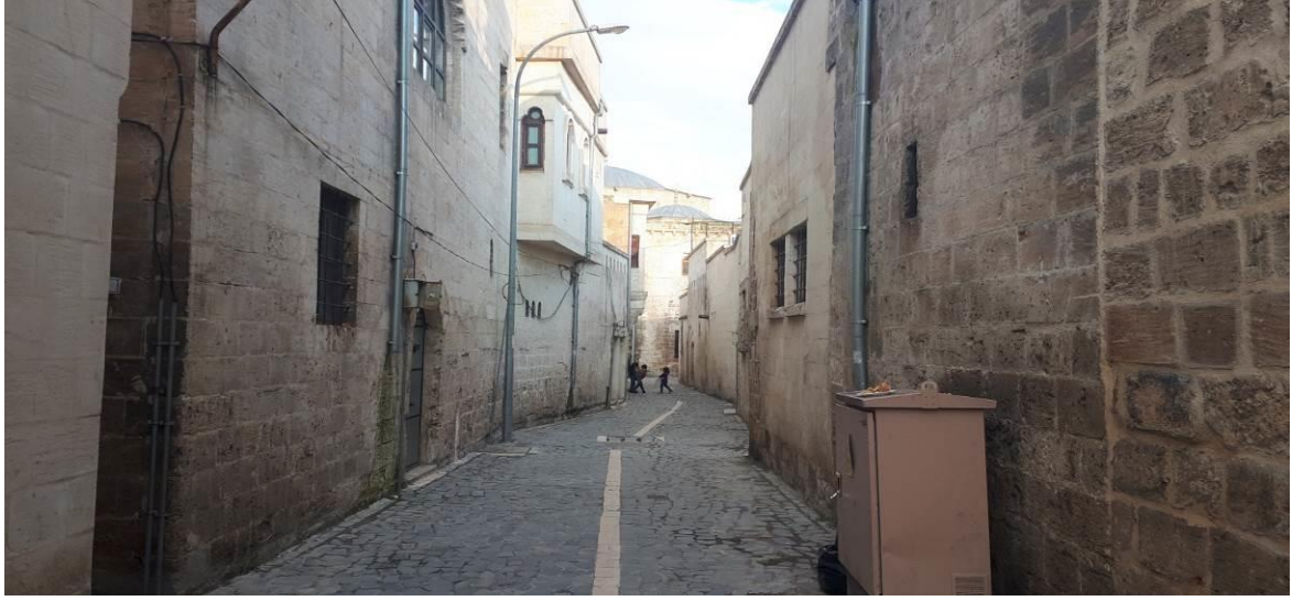
263 Ada 2 Numaralı Parsel Mevcut Sokak Görünümü
