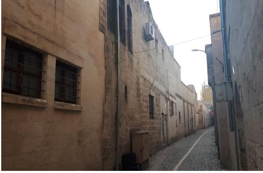
262 Ada 4 Numaralı Parsel Mevcut Sokak Görünümü.
