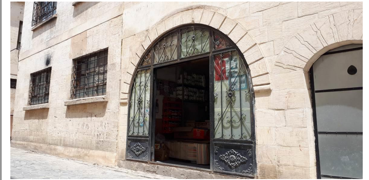
299 Ada 17 Numaralı Parsel Mevcut Cephe Görünümü.
