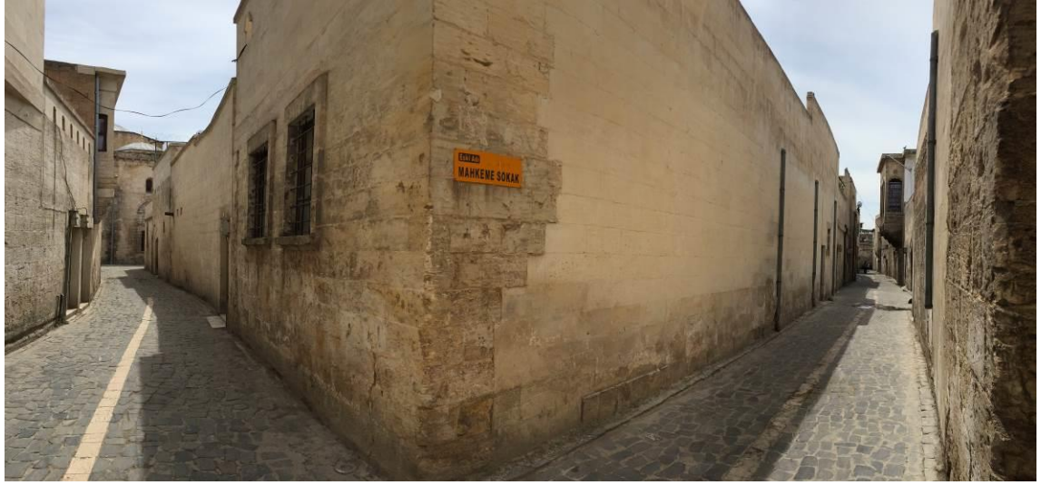
263 Ada 1 Numaralı Parsel Mevcut Güney Cephe Görünümü.
