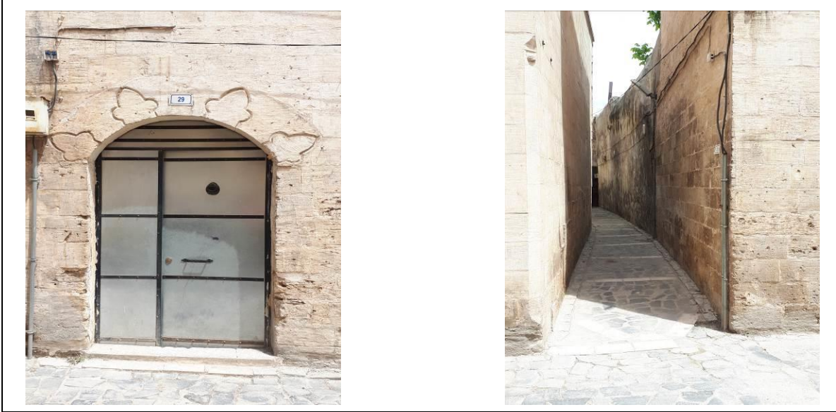
299 Ada 14 Numaralı Parsel Cephe Mevcut Durum Kapısı ve Çıkma Sokak Görünümü.
