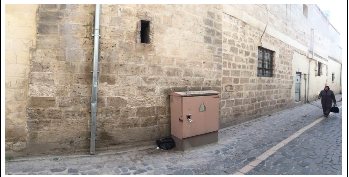
262 Ada 3 Numaralı Parsel Mevcut Cephe Görünümü
