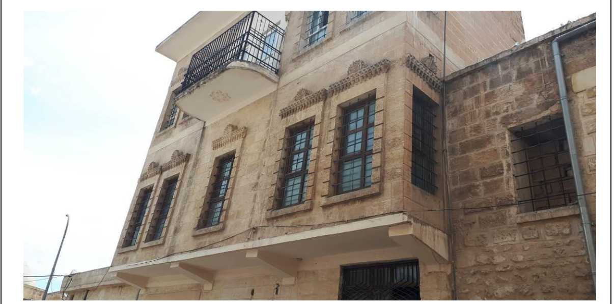
263 Ada 5 Numaralı Parsel Mevcut Cephe Görünümü.
