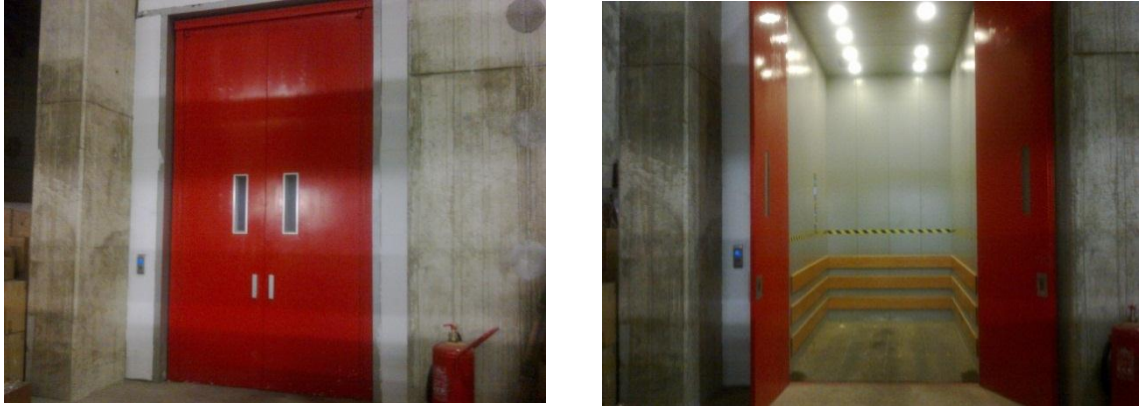
Şekil 5.21: Katlar Arası Dar Koridor Çakası Asansörü
