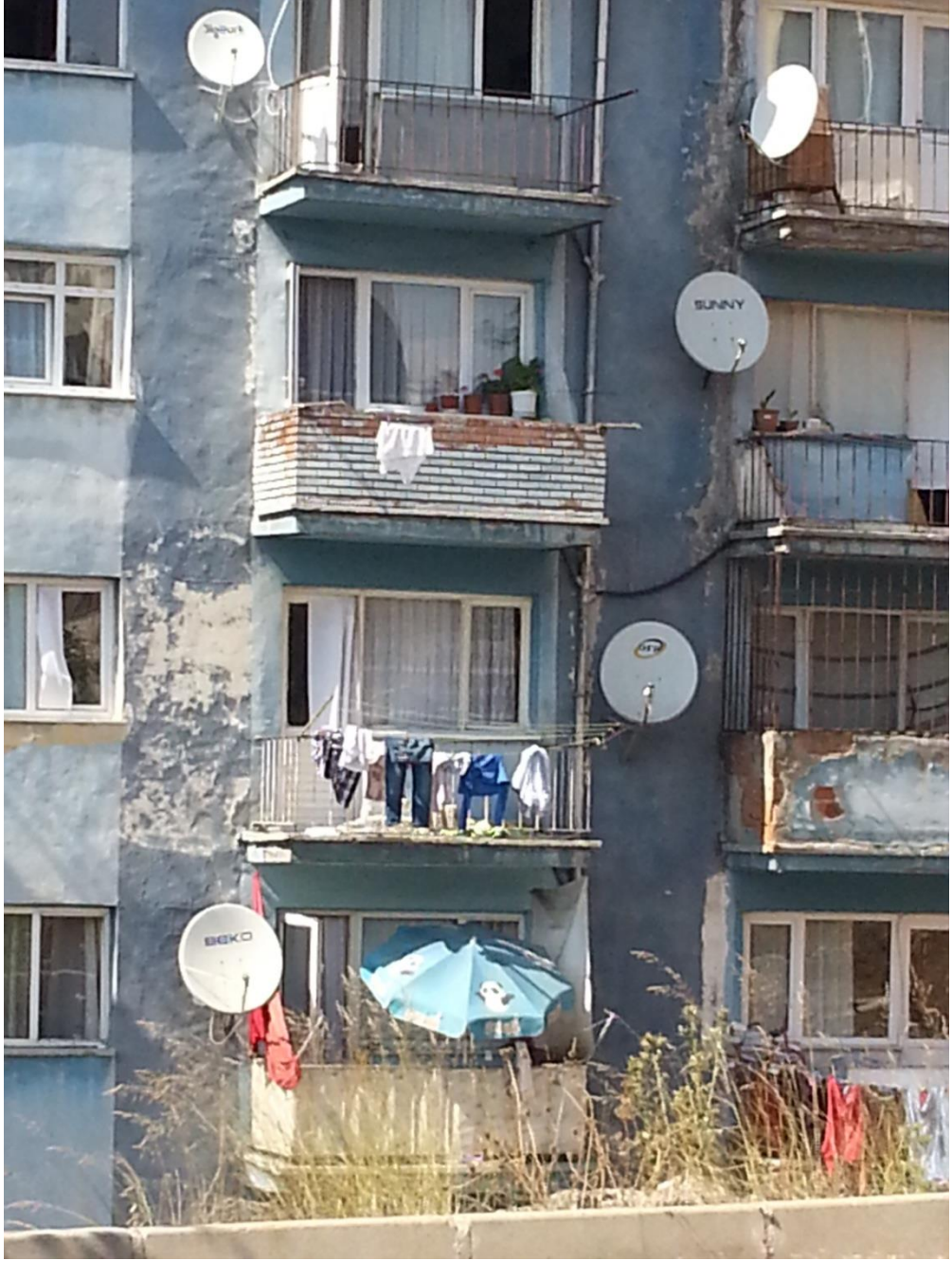
Resim 11: Şerifali İmar İskân Evlerinde bulunan bir bina görüntüsü
