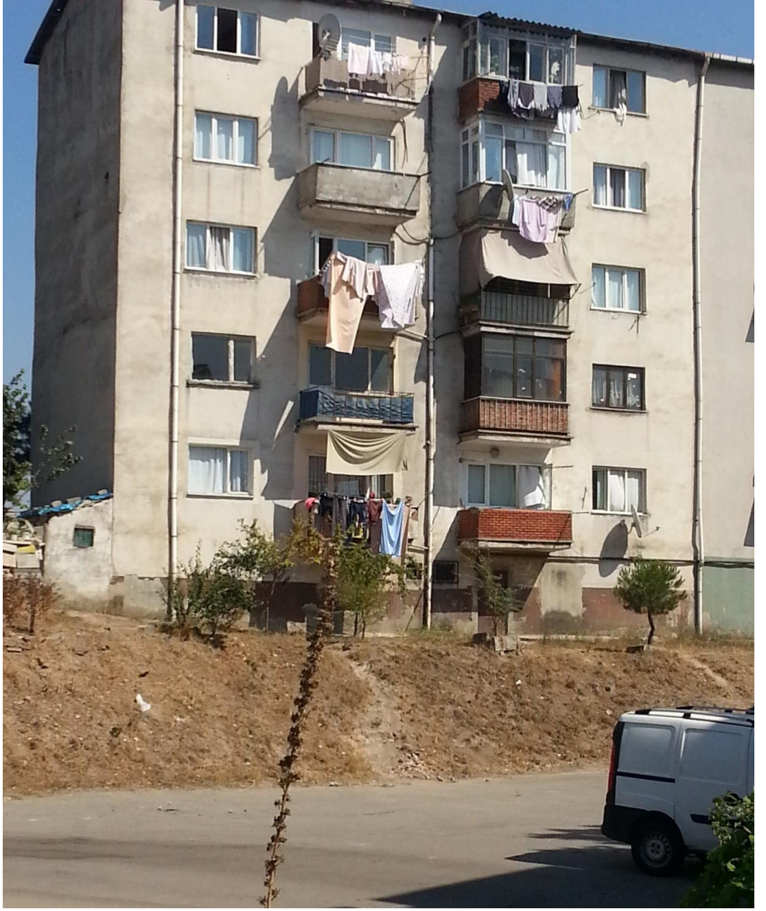
Resim 10: Şerifali İmar İskân Evlerinde bulunan bir bina görüntüsü.
