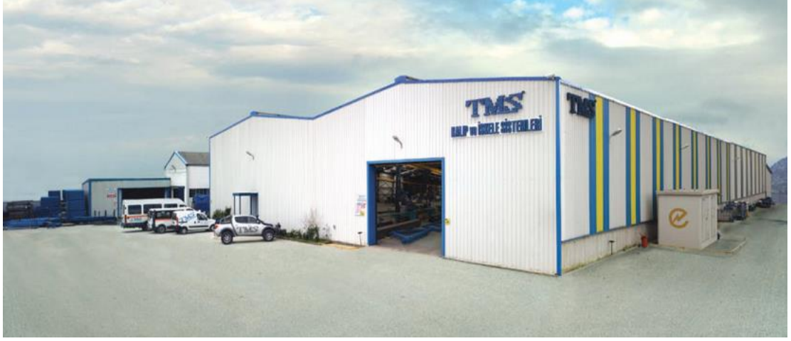
Resim 3.1 TMS Kalıp ve İskele Sistemler Kocaeli Fabrika
