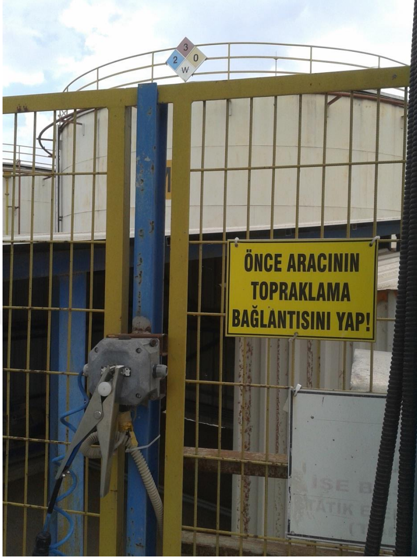
Şekil 3.14 Topraklama Yapılması
