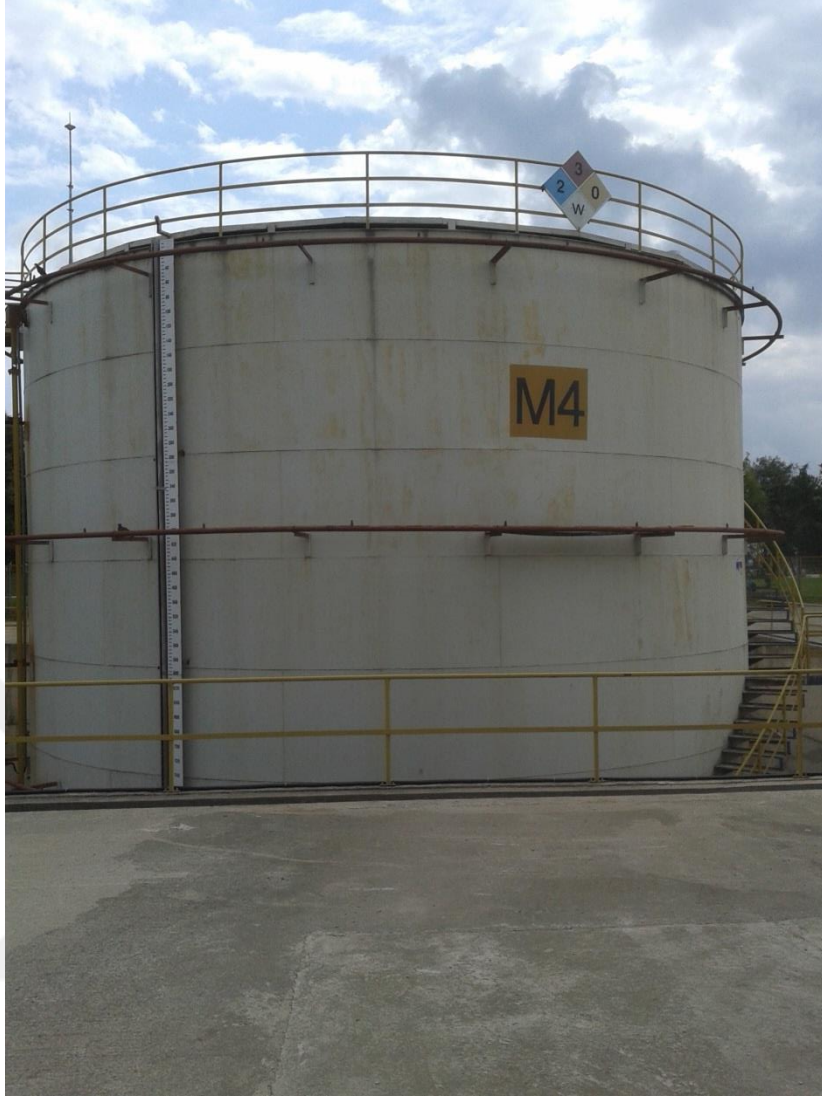
Şekil 3.13 Methanol depolama tankı
