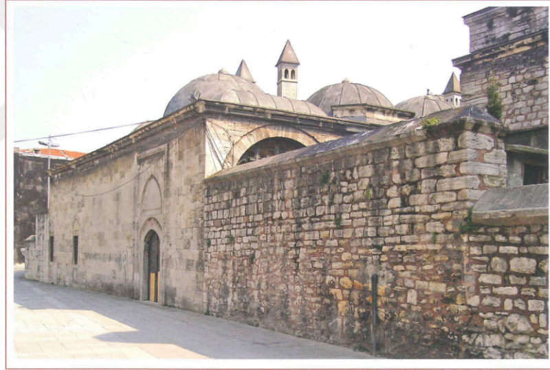
Şekil 2. 33 Dârüşşifânın Yer Aldığı Külliyenin Kuzeydoğu Cephesi
