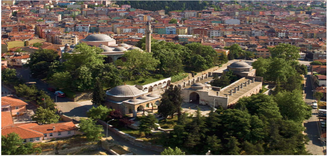
Şekil 2. 21 Bursa Yıldırım Bayezid Külliyesi
