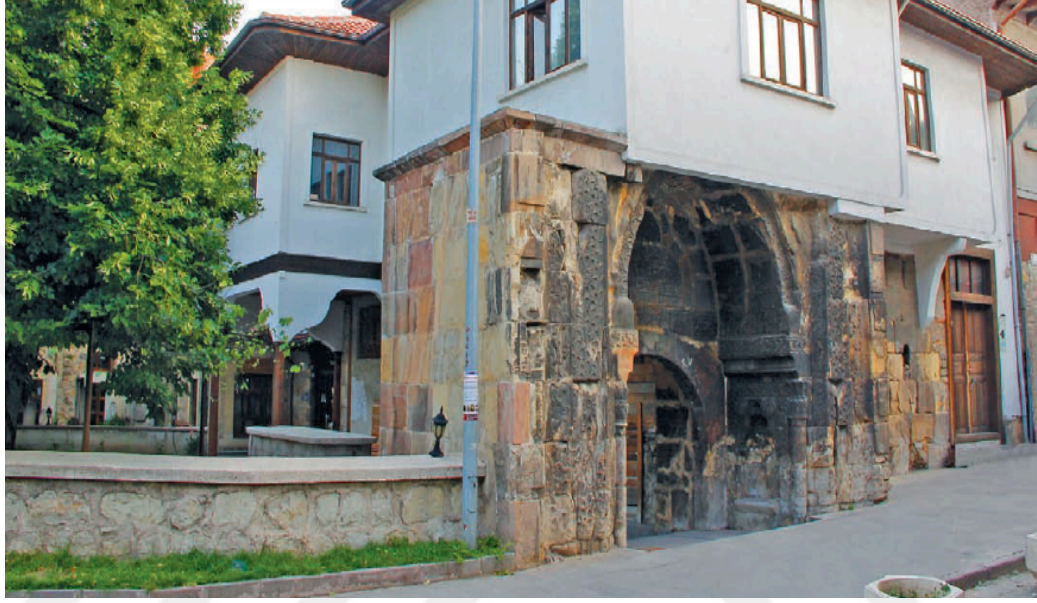
Şekil 2. 20 Dârüşşifânın Ayakta Kalabilen Son Parçası Olan Ve Zeminin Yükselmesiyle Aşağıda Kalan Taçkapısı
