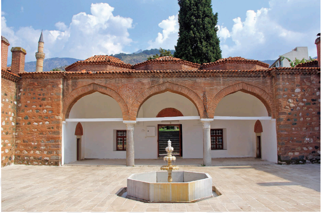
Şekil 2. 32 Hafsa Sultan Darüşşifası
