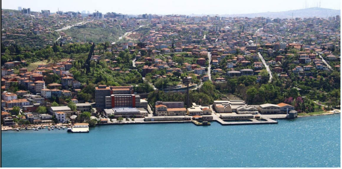
Paşabahçe Tekel ve İspirto Fabrikası – Beykoz (02.07.2017)
