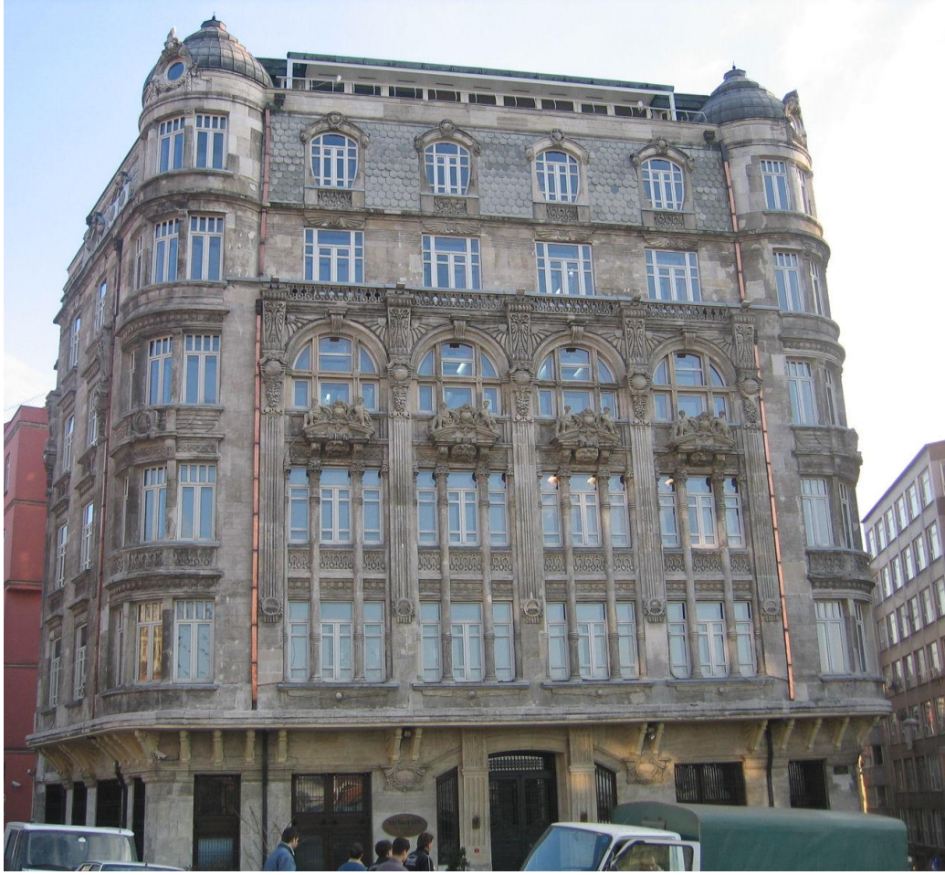
Resim79: Frej Apartmanı, řiřhane
