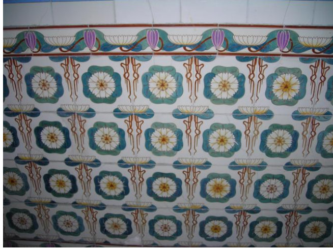
Resim48: Yıldız Sarayı II. Abdülhamit Hamamı Soğukluk Bölümü Duvar Karosu
