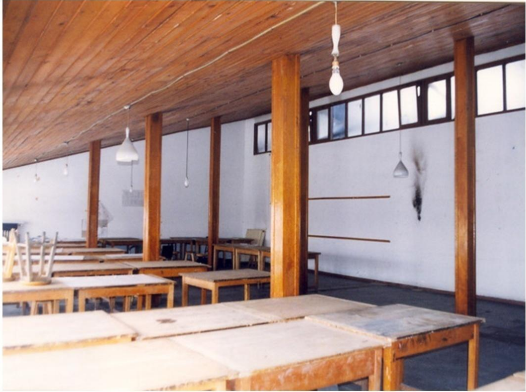
Şekil 3.40 Restorasyon Öncesi 3400'ler Bölümü Çatı Atölyesi [15]
