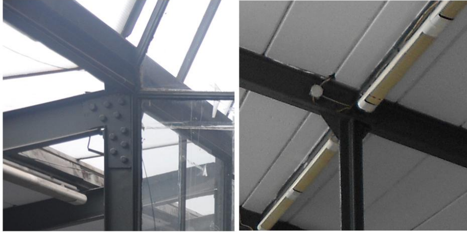
Şekil 3.33 Çelik Putrel, Blon ve Kaynak Birleşim Detayı (Y.Kocabıyık Arşivi,2013)
