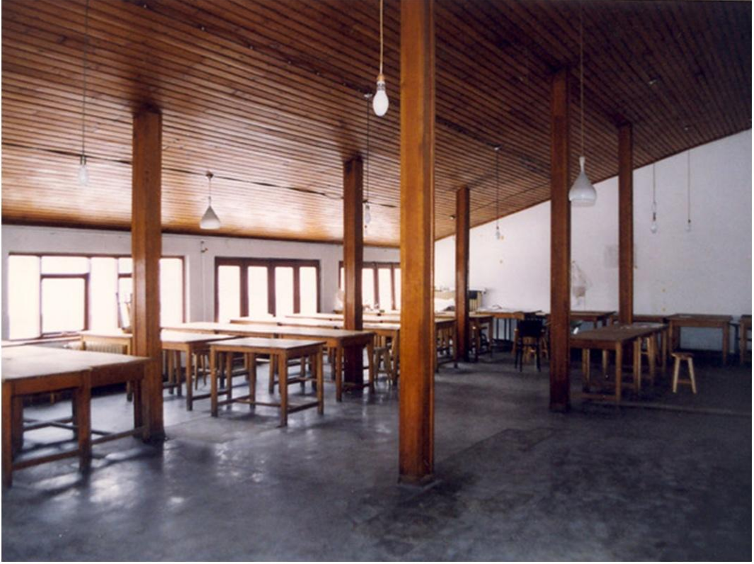
Şekil 3.39 Restorasyon Öncesi 3400'ler Bölümü Çatı Atölyesi [14]
