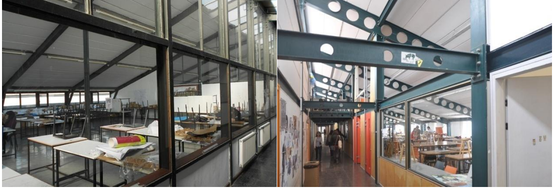
Şekil 3.46 Çatı 1,2,3,4 Bölümü (Y.Kocabıyık Arşivi,2013)
