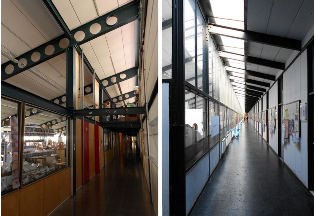
Şekil 3.45 Çatı 3400'ler Koridoru ile Çatı 1,2,3,4 Koridoru (F.Yürekli Arşivi)
