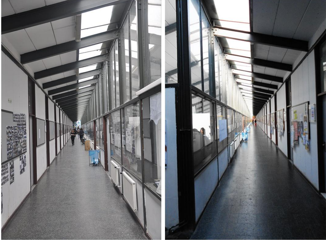
Şekil 3.32 Batı Cephesi Çatı Koridoru ve Üst Örtüsü (Y. Kocabıyık Arşivi, 2013)
