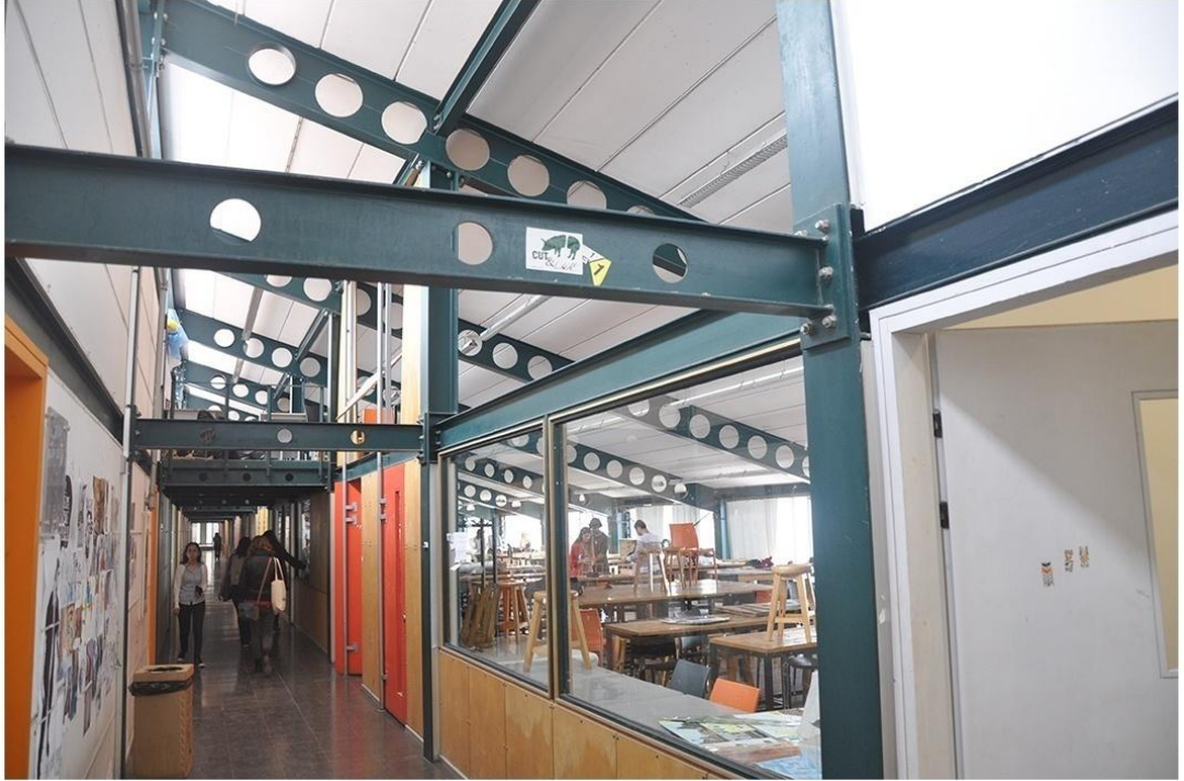
Şekil 3.44 Çatı 3400' ler Bölümü Koridoru (Y.Kocabıyık Arşivi,2013)
