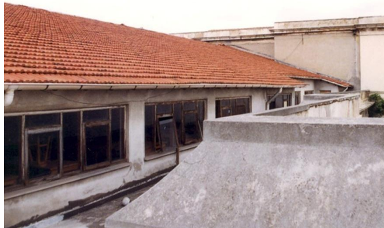
Şekil 3.38 Restorasyon Öncesi Teras Bölümü [13]
