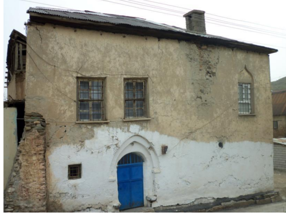
Şekil 3.15. Muş Kale Mahallesi Evi Yol Cephesi (Büte, 2013)
