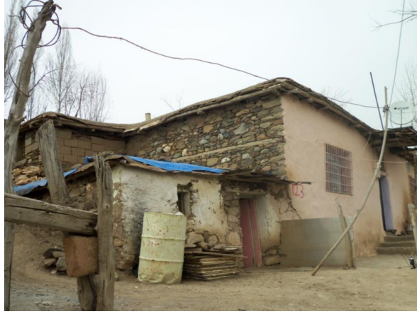
Şekil 3.16. Muş Kale Mahallesi Evi – Kerpiç, Ahşap ve Taşın kullanımı (Büte, 2013)
