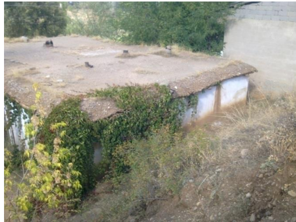
Şekil 3.13. Muş Kale Mahallesi Evi Çatı Örneği (Dam) (Büte, 2013)
