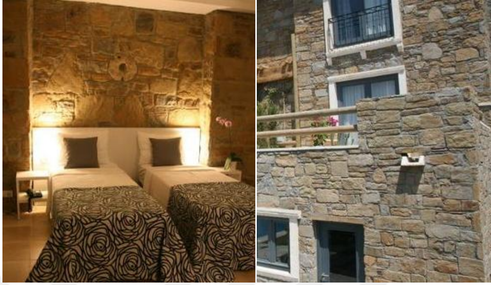
Şekil 6.9.Yatak odası dış ve iç cephe duvar kaplamaları, Anemos Hotel [65], [66].
