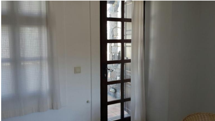
Şekil 6.84.Yatak odası balkon kapısı, Akvaryum Otel [142].
