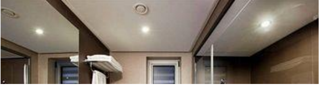
Şekil 6.114.Ortunç Hotel odalarının banyo aydınlatması [170].
