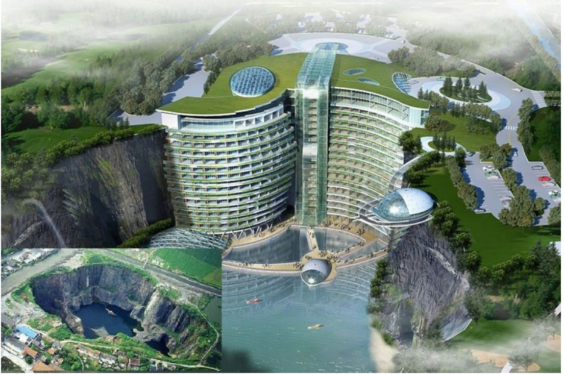
Şekil 4.5.6. Shimao Quarry Otel, ve Taş Ocağının Mevcut Durumu
