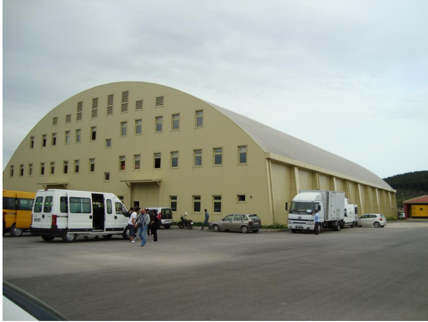
Şekil 2.7. Maltepe Üniversitesi Kampüsü İçinde Yer Alan film Platosunun (Hangar) Estetik Fikirler İçin Dış Cephesinin İncelenmesi. 2012
