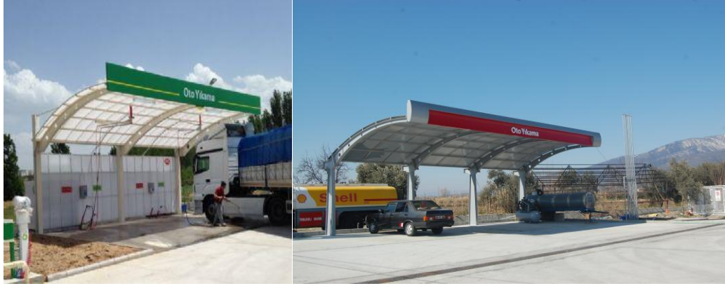
Resim 3.13. BP Akaryakıt İstasyonu Yıkama Ünitesi Polikarbon Uygulaması- Shell Akaryakıt İstasyonu Polikarbon Uygulanmamış Yıkama Ünitesi
