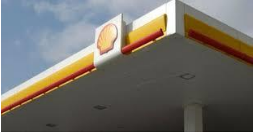
Resim 2.2. Shell Akaryakıt İstasyonu Kanopi Alnı
