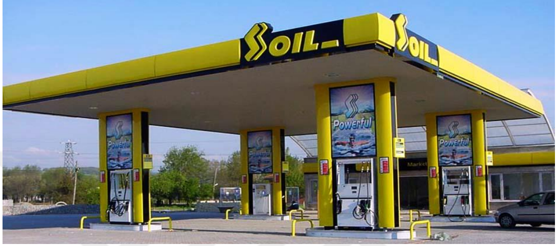
Resim 2.17. Soil Akaryakıt İstasyonu
