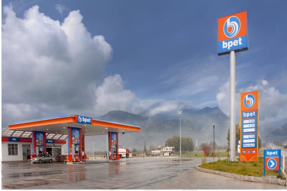
Resim 2.15. Balpet Akaryakıt İstasyonu
