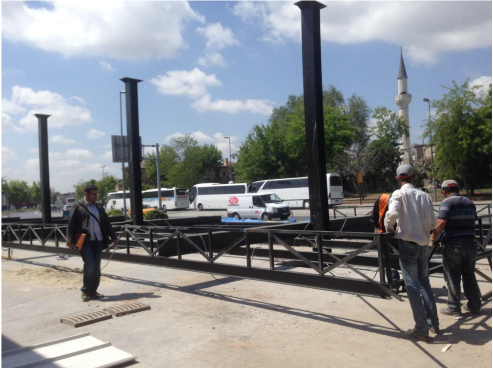
Resim 5.2. Türen Petrol Kanopi Giydirmelerinin Sökümü ve Tadilatı Kaynak: Milan Petrol Proje ve Yatırımlar Koordinatörlüğü 2014-2015 Dosya Arşivi
