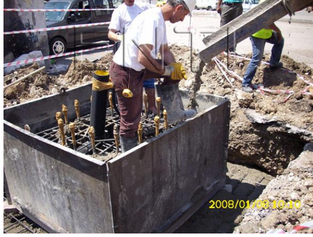
Resim 2.11. Enti Reklam Ankraj Çalışması
