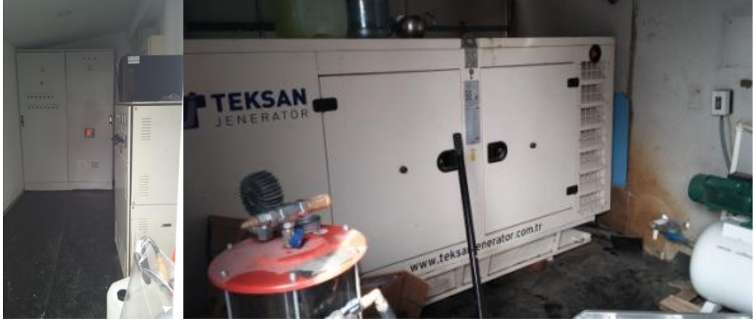
Resim 5.23. Moil Türen Petrol Teknik Ekipman Odası
