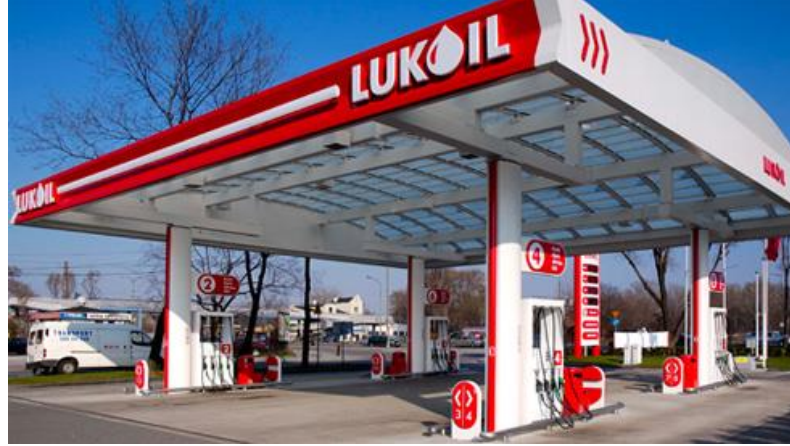
Resim 2.16. Lukoil Akaryakıt İstasyonu
