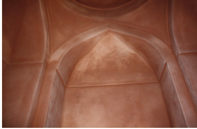
Şekil 4.2.5.3.54: Sıcaklık halvetinin Horasan harcı ile sıvanması (Tevfik İltter Arşivi EK-2[12])
