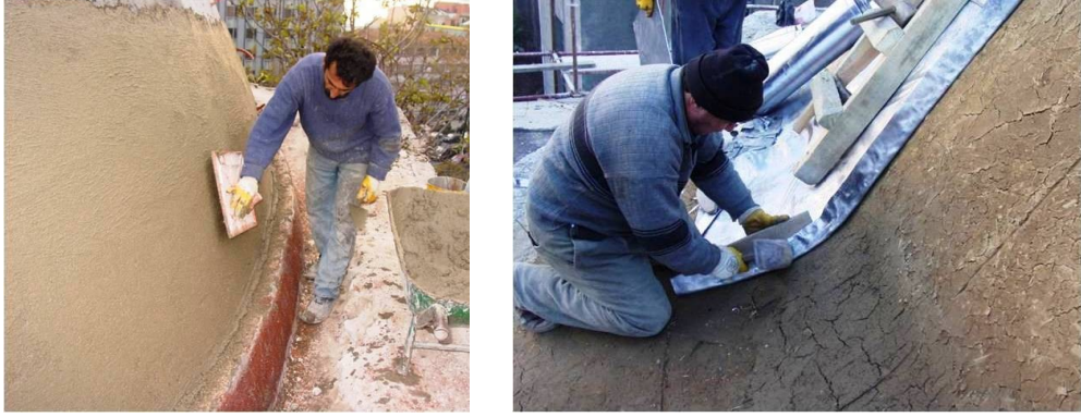
Şekil 4.1.5.3.26a - 4.1.5.3.26b: Kubbenin önce horasan harcı, çamur ve kurşun ile kaplanarak bütünlenmesi (R. A.Arşivi)
