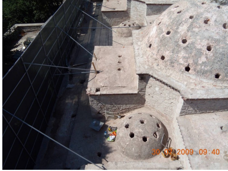
Şekil 4.2.5.2.34: Kadınlar sıcaklık orta kubbe, eyvan tonozu ve halvet kubbesi sıva raspa yapılarak temizlenmesi (V.B.M.Arşivi EK-2[8])
