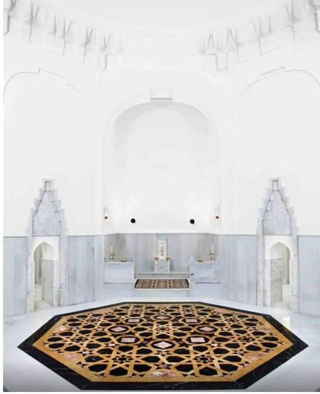
Şekil 4.2.5.3.74: Kadınlar kısmı sıcaklık bölümünde göbek taşının üstündeki merkez kubbede sıva bütünlmesi [6]
