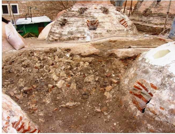
Şekil 4.1.5.2.19: Kubbeler üzerindeki toprak dolgunun temizlenmesi (R. A. Arşivi)
