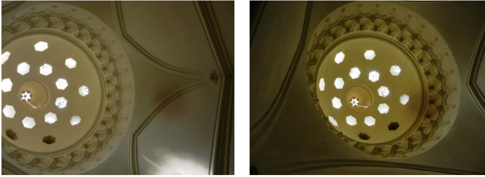
Şekil 4.1.5.3.69a - 4.1.5.3.69b: Bütünlemesi yapılan kubbe mukarnas bezemeleri (Deniz Alkan, Temmuz 2014)
