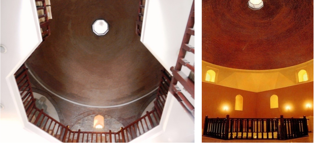
Şekil 4.3.5.3.29: Erkekler kısmı soğukluk kubbesi bütünleme (Deniz Alkan, Eylül 2014)
