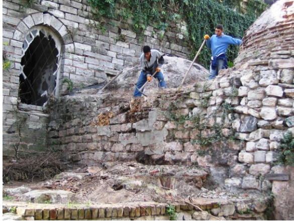
Şekil 4.1.5.2.8: Duvardaki bitki ve toprak dolgunun temizlenmesi (R. A. Arşivi)
