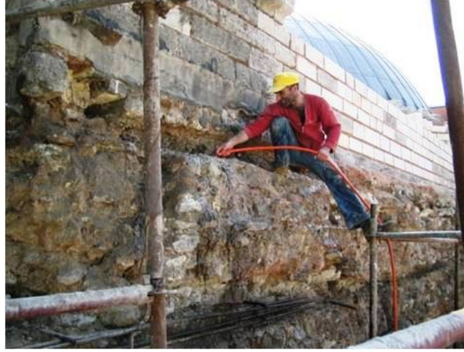
Şekil 4.1.5.2.6: Çatlak yerlerinin su ile yıkanarak temizlenmesi (R. A. Arşivi)
