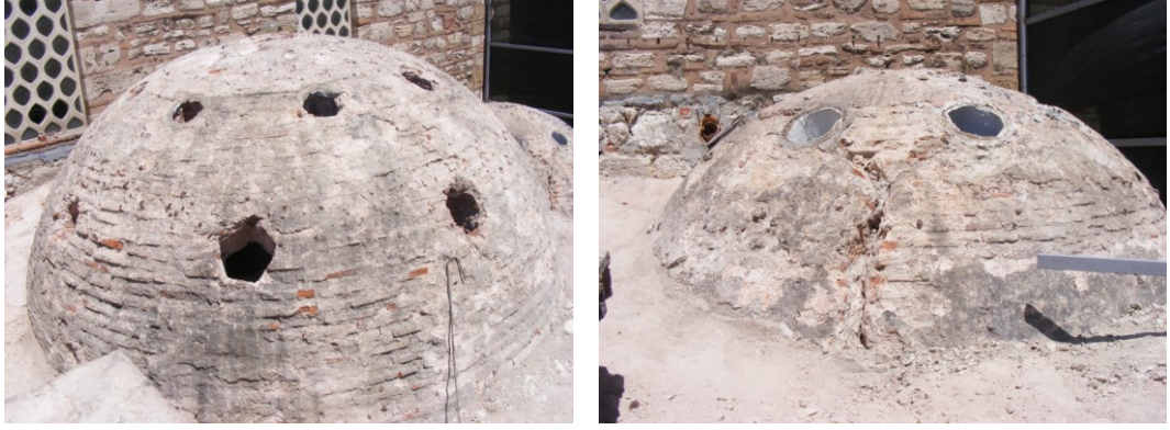
Şekil 4.2.5.1.55: Erkek ılıkık sol yan kubbe çatlağı Şekil 4.2.5.1.56: Erkek ılıkık soğuk yıkanma kubbe çatlağı (Tevfik İltter Arşivi EK-2[12])
