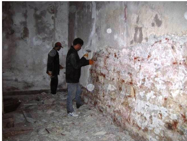
Şekil 4.1.5.2.7: İç duvarlardaki sıva raspalarının yapılması (R. A. Arşivi)
