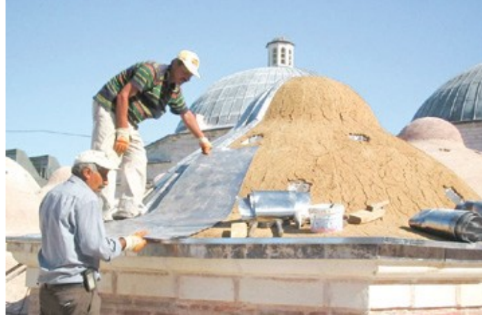
Şekil 4.1.5.3.40: Geleneksel kurşun kaplama yapılarak bütünleme uygulaması (Eyüpgiller, Kemal Kutgün, 2010)
