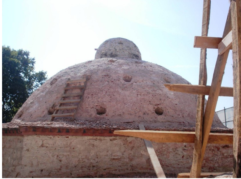
Şekil 4.2.5.2.35: Kurşunu sökülen ve sıva raspa yapılan sıcaklık kubbesi (V.B.M.Arşivi EK-2[8])
