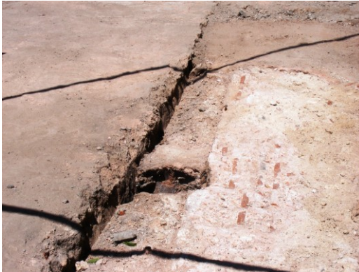
Şekil 4.2.5.1.86a - 4.2.5.1.86b: Su deposunun tonozunun üstünde oluşan çökme ve çatlaklar (Tevfik İlder Arşivi EK-2[12])
