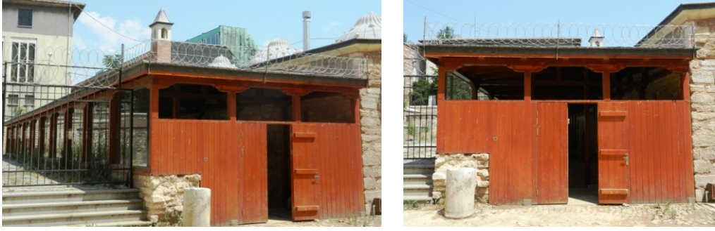
Şekil 4.1.5.5.3a - 4.1.5.5.3b: Su deposu duvarına bitişik yapılan çağdaş ek (Deniz Alkan, Temmuz 2014)
