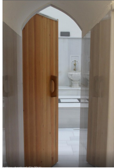
Şekil 4.2.5.3.106: Hamamın bölümlerinin geçişlerinde restitüsyona dayalı yeniden yapılan ahşap kapılar [6]
