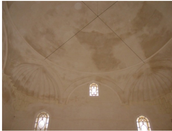
Şekil 4.1.5.1.51: Kubbenin çelik gergi ile karşılıklı bağlanması (R. A. Arşivi)
