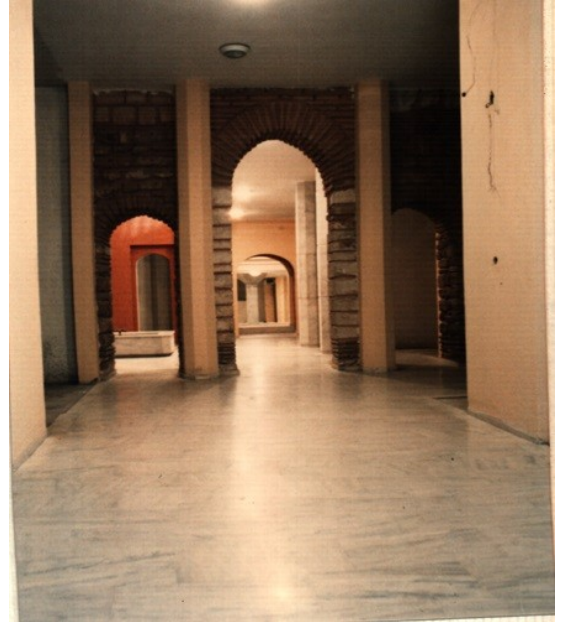
Şekil 4.3.5.3.17: Kadınlar hamamında yok olan duvarlar yerine çağdaş malzeme kullanımı (Kuban, Doğan, 1993)
