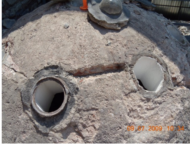
Şekil 4.2.5.2.25: Kubbelerin üstündeki çimento katkılı sıvalar ve orijinal olmayan filgözleri (Tevfik İlter Arşivi EK-2[12])
