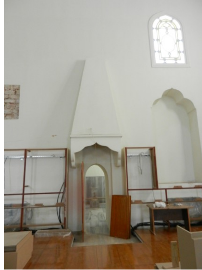
Şekil 4.1.5.3.43: Ilıkliğe geçiş kapısı üzerindeki davlumbaz ve nişlerin bütünlene (Deniz Alkan, Temmuz 2014)
