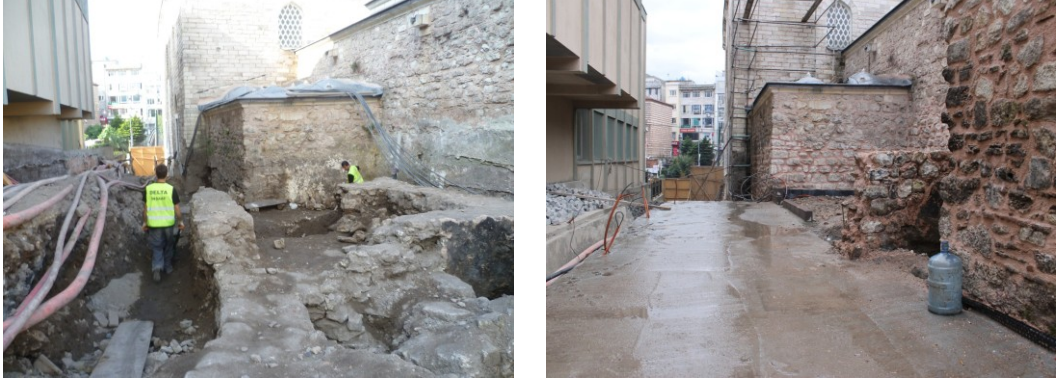
Şekil 4.1.5.2.3a - 4.1.5.2.3b: Dođu cephesinde ortaya çıkan muhdes temellerin kaldırılması [2]
