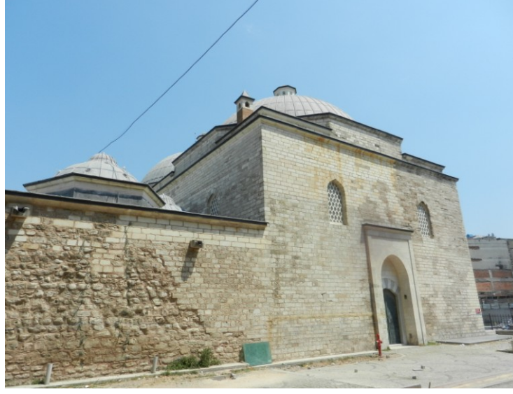
Şekil 4.1.5.3.21: Kadınlar soğukluk batı cephesi dış duvar cidar bütünlemesi (R. A. Arşivi)
