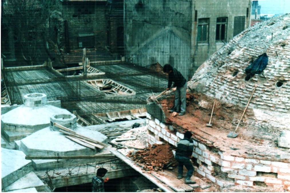
Şekil 4.3.5.3.24: Erkekler sıcaklık kubbe kasağında temizlik ve bütünleme yapılması (K.V.K.K. Arşivi, EK-3[4])
