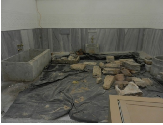
Şekil 4.1.5.3.56a - 4.1.5.3.56b: KZ05E3 no.lu eyvandaki mermer kurna ve mermer batak havuzu etrafındaki mermer sekilerin bütünlemesi (Deniz Alkan, Temmuz 2014)
