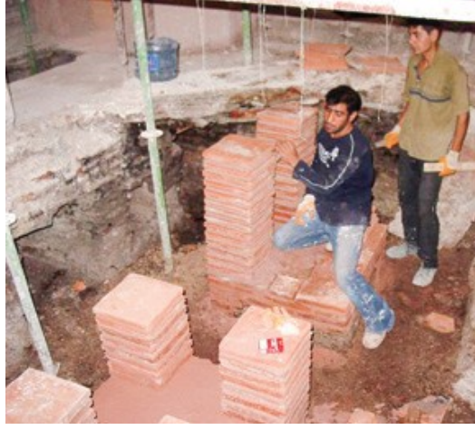
Şekil 4.1.5.3.3: Hipokast ayaklarının yeniden yapılarak bütünlenmesi (Eyüpgiller, Kemal Kutgün, 2010)
