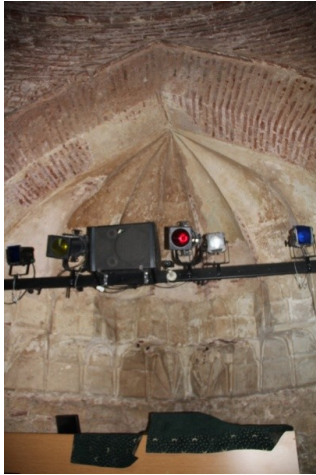
Şekil 4.4.5.2.11: Uçlarında mukarnas olan dilimli trompların sıva raspası (Deniz Alkan, Mart 2015)
