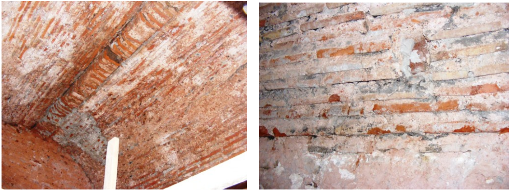
Şekil 4.2.5.2.42a - 4.2.5.2.42b: Sıcak su deposunun tonozunda iç sıvaların raspa ile temizlenmesi (V.B.M.Arşivi EK-2[8])
