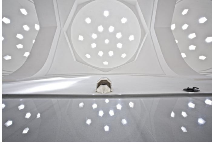
Şekil 4.2.5.3.69: Ilıklık kubbeleri ve filgözü aydınlatmaların yıldız ve altıgen formlarının kireç sıva ile sıvanarak bütünleme yapılması (Tevfik İlter Arşivi EK-2[12])
