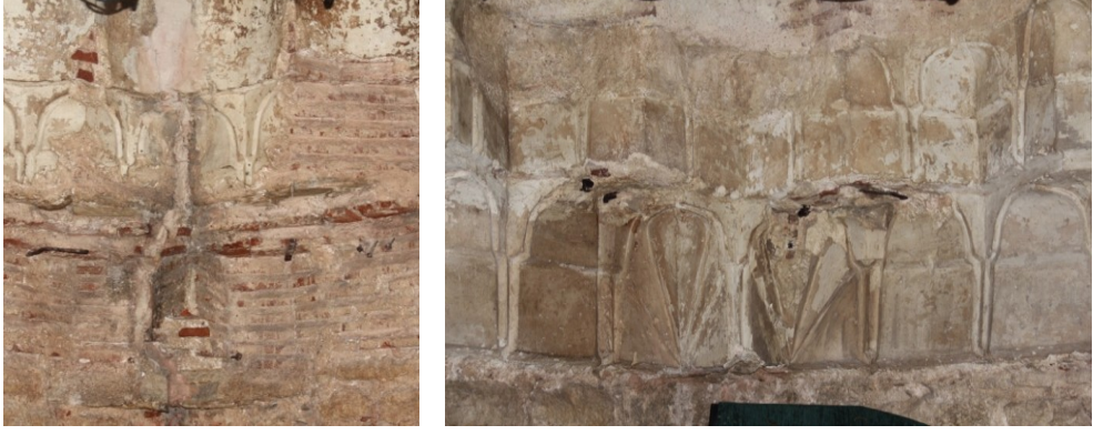
Şekil 4.4.5.1.4: Trompların uçlarındaki mukarnaslara mih çakılarak yapılan sağlamlaştırma (Deniz Alkan, Mart 2015)
