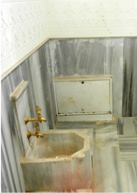
Şekil 4.1.5.4.7: Duvara gömülen tesisat panoları (Deniz Alkan, Temmuz 2014)
