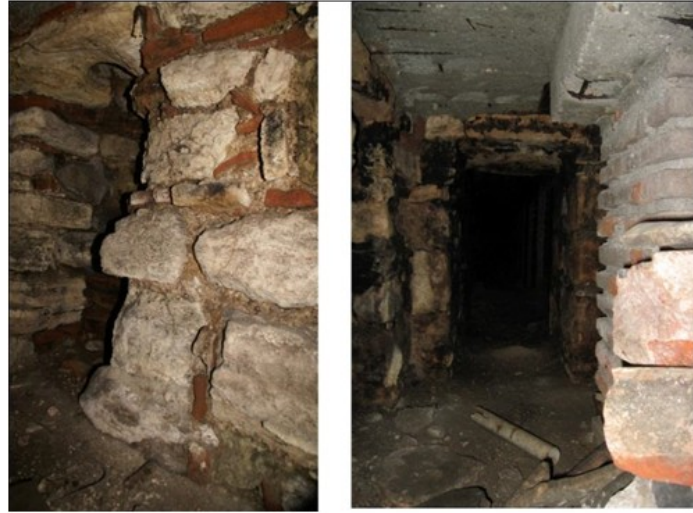
Şekil 4.2.5.1.4: Cehennemlik içinde bulunan hava bacası Şekil 4.2.5.1.5: Cehennemlik üstündeki betonarme döşeme (Tevfik İlter Arşivi EK-2[12])
