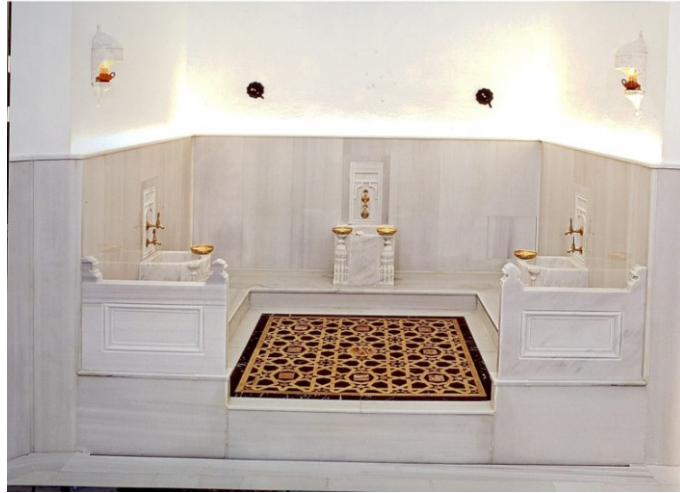
Şekil 4.2.5.3.15: Sıcaklık eyvanlarından sadece birinde olan yeniden yapılan ışıklı geometrik geçme motifli mermer yer döşemesi [5]
