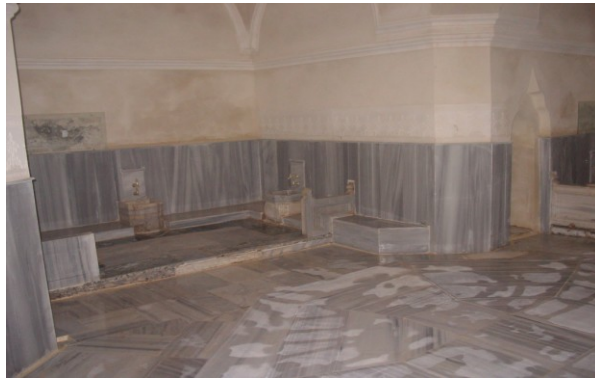
Şekil 4.1.5.3.5: Eyvanlardaki mermer döşemelerin bütünleme ile tamamlanması (R. A. Arşivi)
