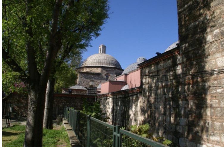
Şekil 4.2.5.3.35: Güneydoğu cephesi sıcak su deposu külhan ve arkada kadınlar soğukluk bölümü cephesi restorasyon öncesi (K.V.K.K. Arşivi, EK-2[4])
