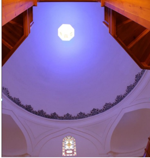
Şekil 4.2.5.3.120: Soyunmalık kubbeside dolanan palmet taş bezemenin mavi renk kalemişi ile bütünlenmesi[6]
