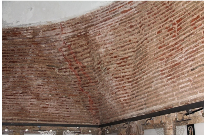
Şekil 4.4.5.2.11: Uçlarında mukarnas olan dilimli trompların sıva raspası (Deniz Alkan, Mart 2015)
