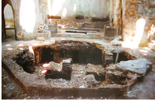
Şekil 4.1.5.1.15: Göbek taşı ve hipokast ayaklarında çökme sonucu oluşan hasarlar (K.V.K.K. Arşivi –EK-1 [13])
