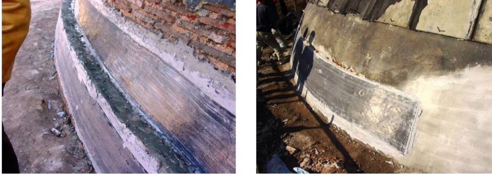
Şekil 4.1.5.1.41a - 4.1.5.1.41b : Karbon elyaf kanaviçe 230c ile kubbede çemberleme yapılması (R. A. Arşivi)
