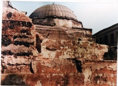
Şekil 4.3.5.2.7: Duvarlarda oluşan yosunlanmalar(K.V.K.K. Arşivi, EK-3[4])
