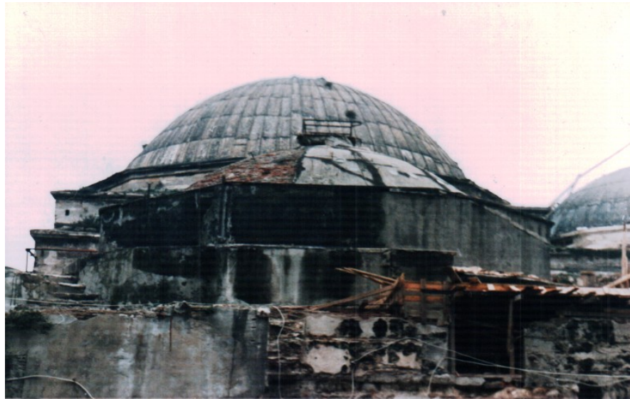
Şekil 4.3.5.2.15: Kubbelerdeki muhdes kaplama ve muhdes çatılar (K.V.K.K. Arşivi, EK-3[4])
