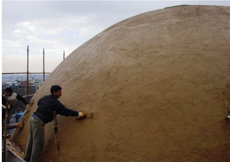
Şekil 4.1.5.3.29: Kubbede kurşun kaplama altına yapılan çamur sıva (R. A. Arşivi)
