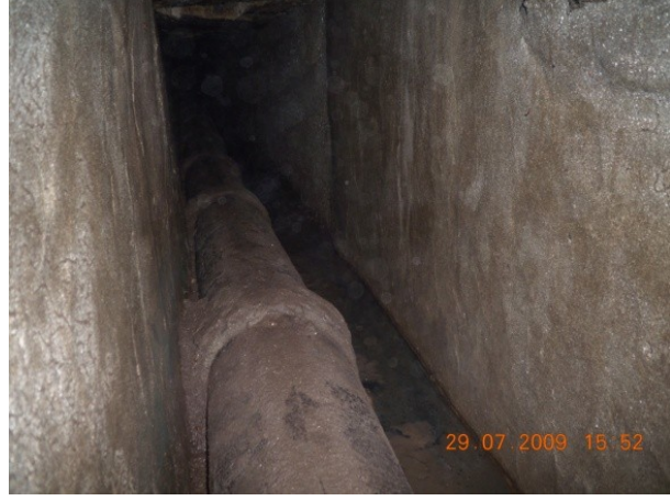
Şekil 4.2.5.1.1: Hamamın çevresinde kazı ile ulaşılan orijinal drenaj kanalları (Tevfik İlter Arşivi EK-2[12])
