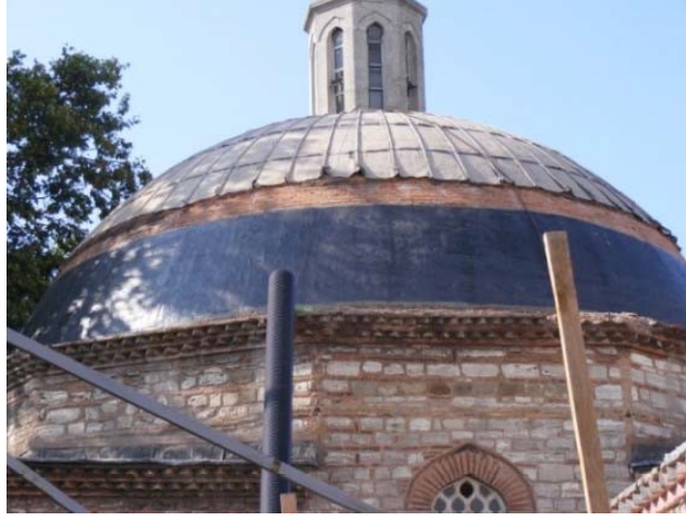
Şekil 4.2.5.1.51: Soğukluk kubbesinde karbon kumaş ile sağlamlaştırma [10]
