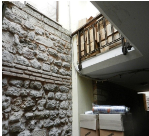
Şekil 4.3.5.5.5: Çağdaş ek çarşı binasının, külhan duvarına dibinden inen merdiven bağlantısı (Deniz Alkan, Mart 2014)
