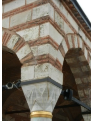
Şekil 4.2.5.1.7: Sütun başlıkların çelik kasnak ile çemberleme ile sağlamlaştırılması ( Deniz Alkan, Ocak 2015)
