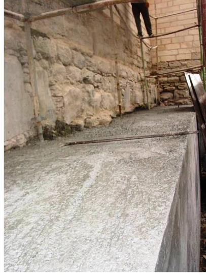
Şekil 4.1.5.1.7a – 4.1.5.1.7b: Zemin takviyesi güçlendirme betonu (R. A. Arşivi)
