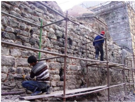
Şekil 4.1.5.3.22a - 4.1.5.3.22b: Batı cephesindeki dış duvarların bütünlenmesi (R. A. Arşivi)
