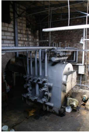
Şekil 4.2.5.2.44: Son yapılan restorasyondan sonra külhanda bulunan mevcut kazan
