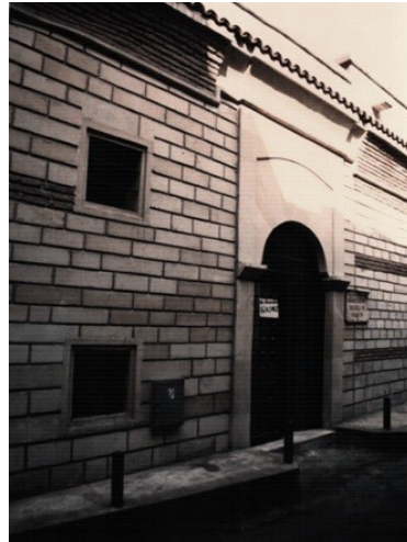
Şekil 4.3.5.3.10: Kantarcılar Sokak' ta çağdaş ek bina taç kapı girişi ve duvar taşlarının yenilenerek bütünleme yapılması (K.V.K.K. Arşivi, EK-3[4])
