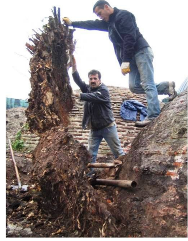
Şekil 4.1.5.2.24a - 4.1.5.2.24b: Kubbelerdeki ağaç köklerinin sökülmesi (R. A. Arşivi)
