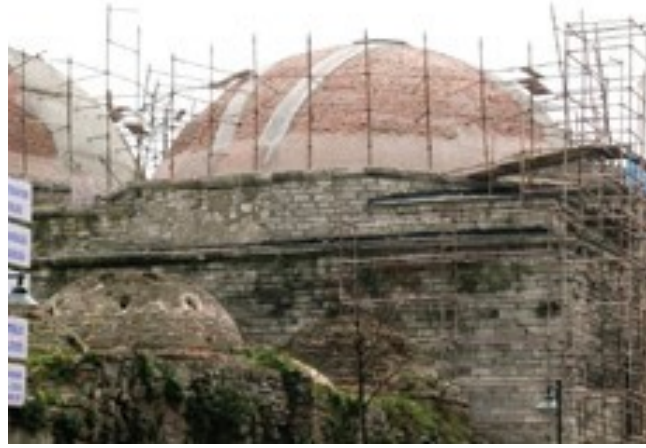
Şekil 4.1.5.1.57: Soğukluk kubbesinin karbon elyaf kanaviçe ile kuşaklama yapılarak güçlendirilmesi (Eyüpgiller, Kemal Kutgün, 2010)
