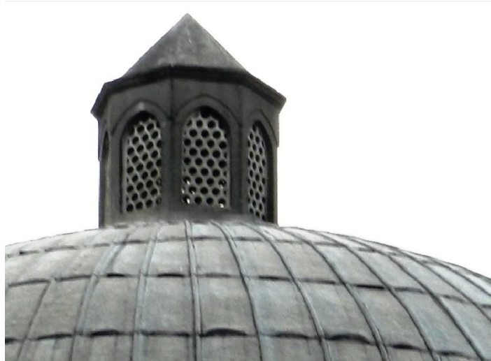
Şekil 4.3.5.2.22: Soğukluk kubbelerinin sekizgen baldekenli ve külah üst örtülü fenerleri (Deniz Alkan, Mart 2014)
