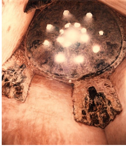
Şekil 4.3.5.3.63: Erkekler hamamında sıcaklık halvet kubbesinin çok bozulmuş olan alçı mukarnasları kısmi bütünlenme (Deniz Alkan, Mart 2014)
