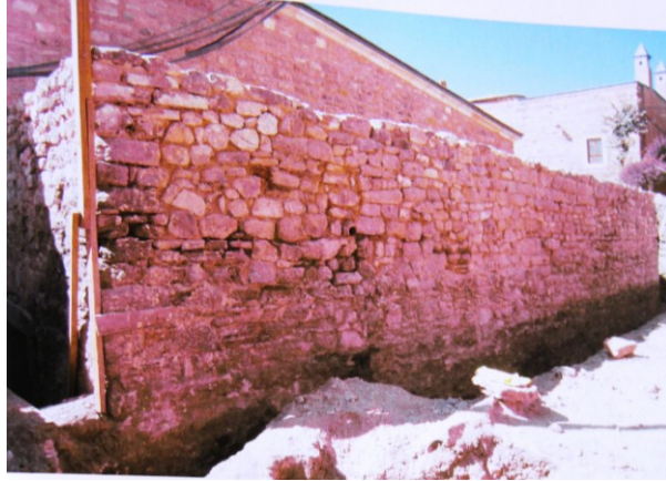
Şekil 4.1.5.2.14: Kazılar sonucu ortaya çıkan odunluk duvarları [2]
