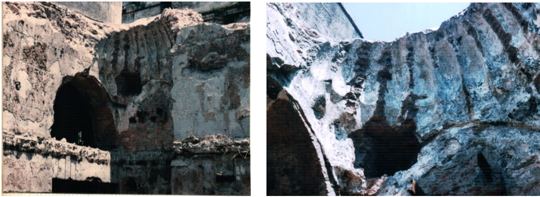
Şekil 4.3.5.3.34a - 4.3.5.3.34b: Erkekler sıcaklık eyvanı kubbe dilimlerinden kalan parça (K.V.K.K. Arşivi, EK-3[4])
