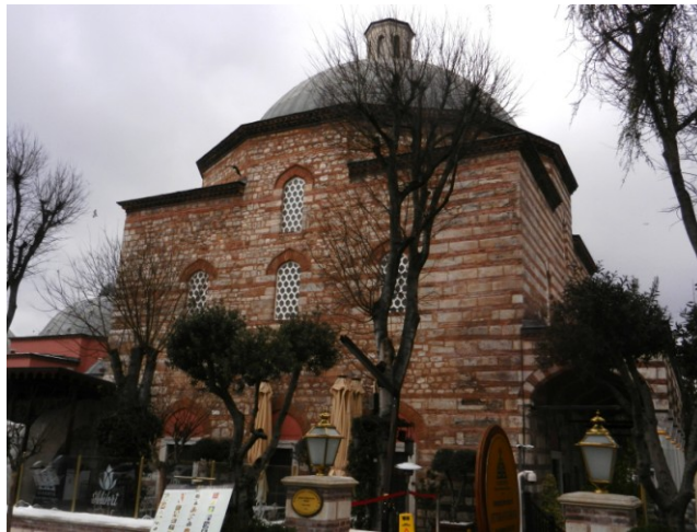
Şekil 4.2.5.3.67: Meridyenler şeklinde yapılan kurşun kaplama ile kubbelerin üst örtüsünün bütünlenmesi (Deniz Alkan, Ocak 2015)
