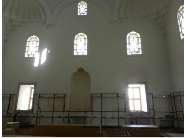
Şekil 4.1.5.3.45: Doğu cephesinde bütünleme yapılan pencere revzenleri (Deniz Alkan, Temmuz 2014)
