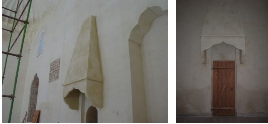
Şekil 4.1.5.3.44a - 4.1.5.3.44b: Davlumbaz ahşap kapının restitüsyona dayalı olarak analogi yöntemi ile bütünlenmesi (R. A. Arşivi)
