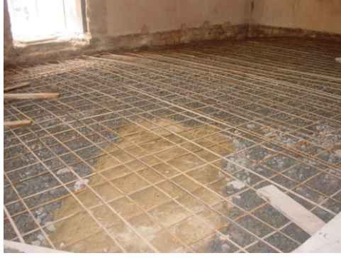
Şekil 4.1.5.1.12: Döşemede yapılan blokaj ve grobeton uygulaması (R. A. Arşivi)
