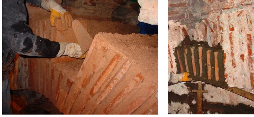
Şekil 4.1.5.1.21a – 4.1.5.1.21b: Kemerde tuğla ile dikiş yapılması (R. A. Arşivi)
