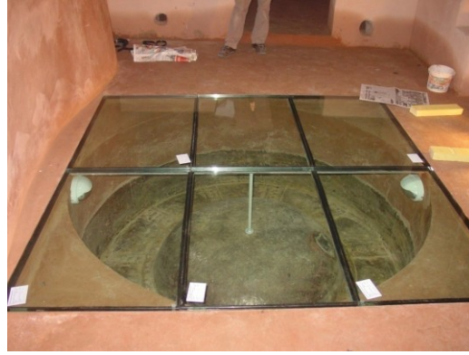
Şekil 4.1.5.4.3: Özgün bakır su kazanı üzerindeki cam örtü (R. A. Arşivi)
