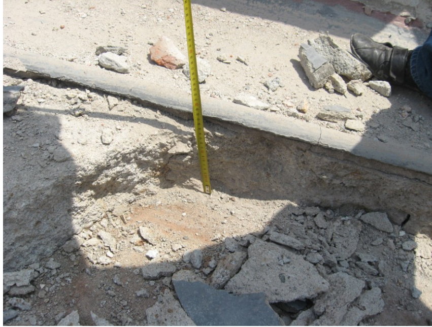
Şekil 4.2.5.2.28: Çimentolu harçların sökülmesi (Tevfik İlter Arşivi EK-2[12])
