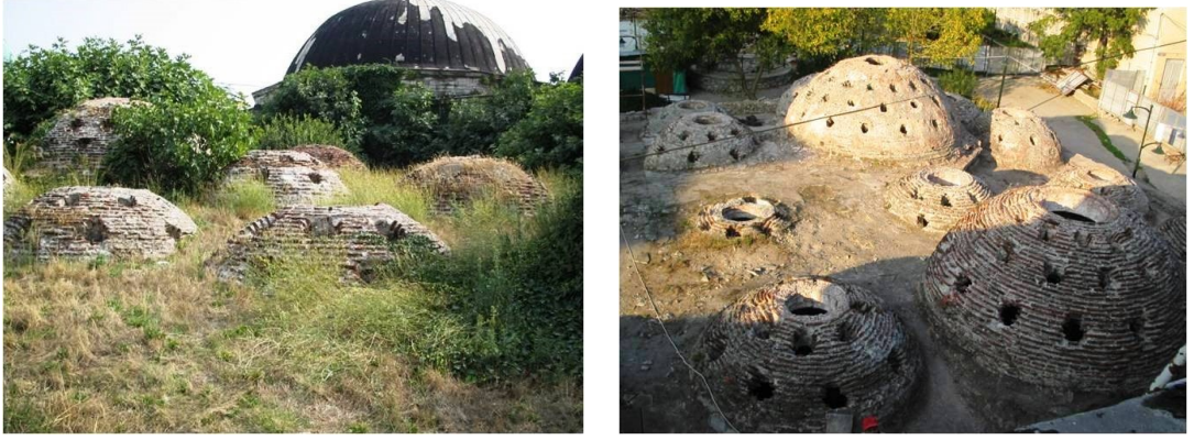
Şekil 4.1.5.2.18a - 4.1.5.2.18b: Kubbeler üzerindeki toprak dolgular ve bitkilerin temizlenmesi (R. A. Arşivi)
