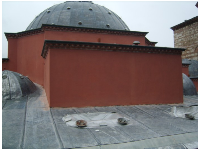
Şekil 4.2.5.3.70: Kurşun kaplaması yapılarak tamamlanan sıcaklık kubbeleri [7]
