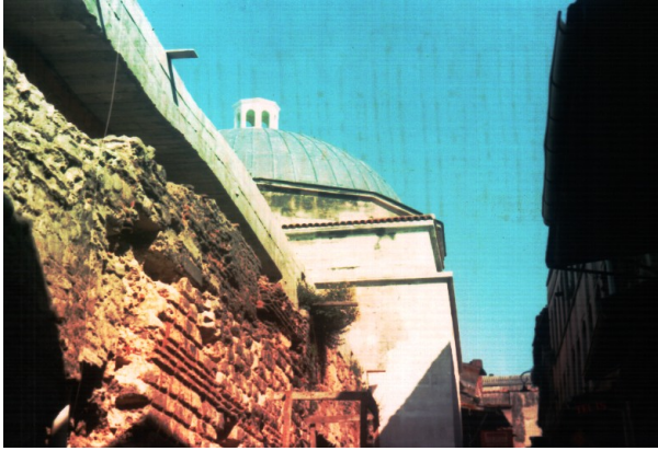
Şekil 4.3.5.3.5: Güneybatı cephesi, Kantarcılar Sokak'ta kadınlar ılıklik duvarının üstündeki betonarme ekler (K.V.K.K. Arşivi, EK-3[4])
