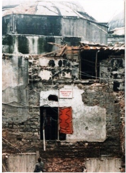
Şekil 4.3.5.2.3: Erkekler sıcaklık ve halvet duvarındaki muhdes duvarlar (Kuban, Doğan, 1993)
