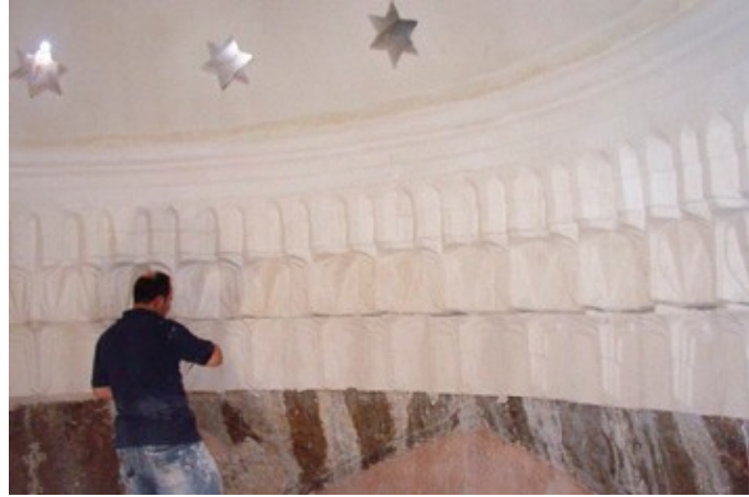
Şekil 4.1.5.3.65: Kubbedeki mukarnasların bütünleme uygulaması (Eyüpgiller, Kemal Kutgün, 2010)
