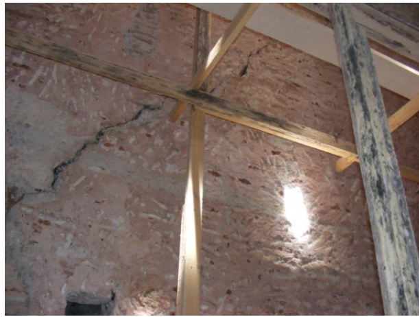
Şekil 4.2.5.1.22: Kuzeybatı cephesi ıııklık dış duvar çatlağı
