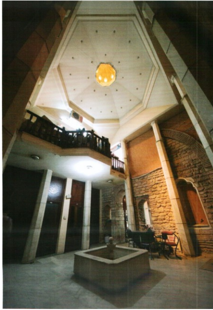
Şekil 4.3.5.3.28a - 4.3.5.3.28b: Kadınlara hamamında yok olan kubbe ve üst örtüleri yerine betonarme konik kubbelerin içten görünümü (Ortaylı, İlber, Engin, Vahdettin, Afyoncu, Erhan, 2008)
