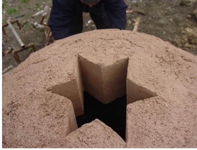
Şekil 4.1.5.3.39: Bütünlemesi yapılan yıldız figözleri (R. A. Arşivi)
