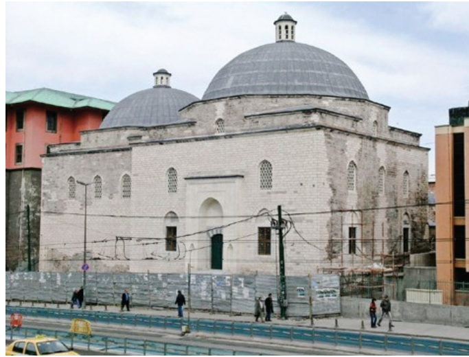
Şekil 4.1.5.3.10: Güney ve Doğu köşesinde cephenin ve üst örtünün bütünleme (Eyüpgiller, Kemal Kutgün, 2010)
