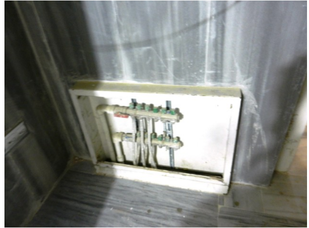
Şekil 4.1.5.4.7: Duvara gömülen tesisat panoları (Deniz Alkan, Temmuz 2014)
