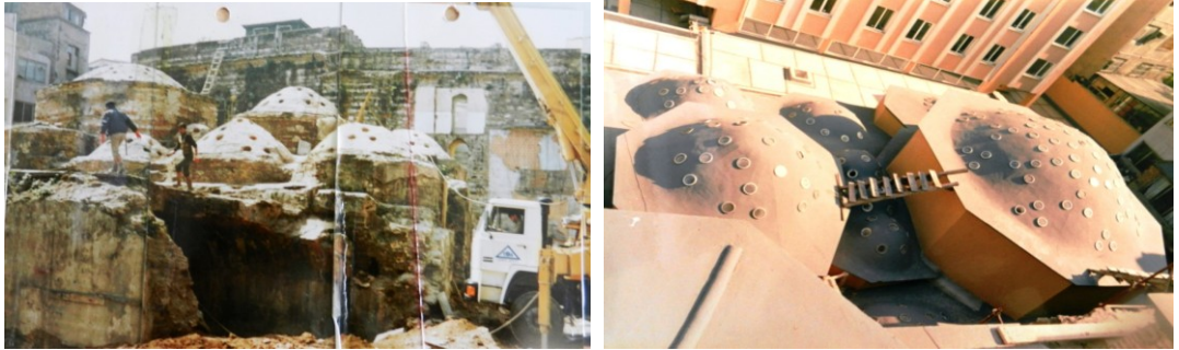
Şekil 4.4.5.3.16: Sıcaklik önüne yapılan iki katlı dükkânlar ve üst örtünün sökülerek temizlemesi (K.V.K.K. Arşivi, EK-4[1])
