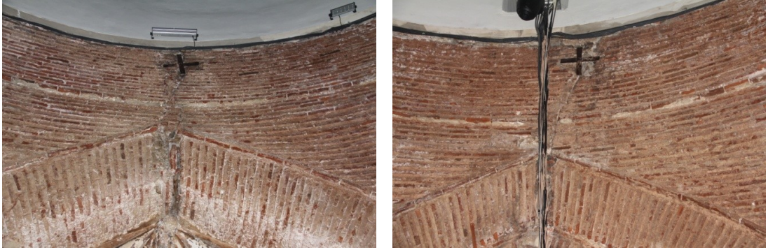
Şekil 4.4.5.1.1: Sivri kemerlerde oluşan çatlakları kenetle sağlamaştırma (Deniz Alkan, Mart 2015)
