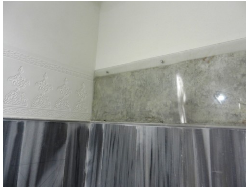
Şekil 4.1.5.3.70: Duvarlarda konsolide edilen palmet şeritli bezemeler (Deniz Alkan, Temmuz 2014)
