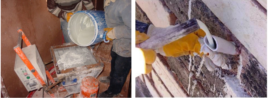
Şekil 4.1.5.1.34a – 4.1.5.1.34b: Enjeksiyon harcının hazırlanarak hortumlardan akıtılması (R. A. Arşivi)
