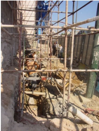
Şekil 4.1.5.1.9: Güney cephesinde yapılan karot ile delgi açılması (R. A. Arşivi)
