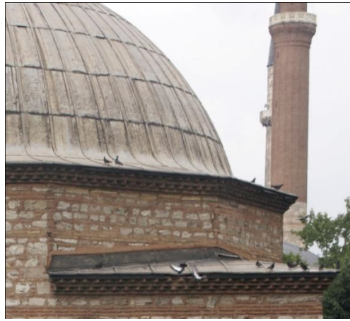
Şekil 4.2.5.2.13: Soğukluk kubbelerinin etek detayı olan çift sıra kirpi saçığında kullanılan dökme çimento tuğlalar (K.V.K.K. Arşivi, EK-2[5])
