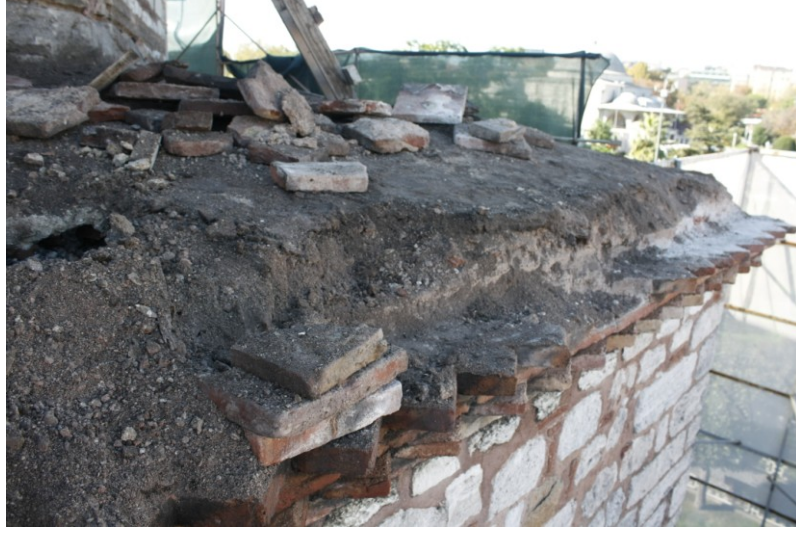
Şekil 4.2.5.2.14: Soğukluk kubbelerinin etek detayı olan çift sıra kirpi saçağında kullanılan dökme çimento tuğlaların temizlenmesi (Tevfik İlter Arşivi EK-2[12])
