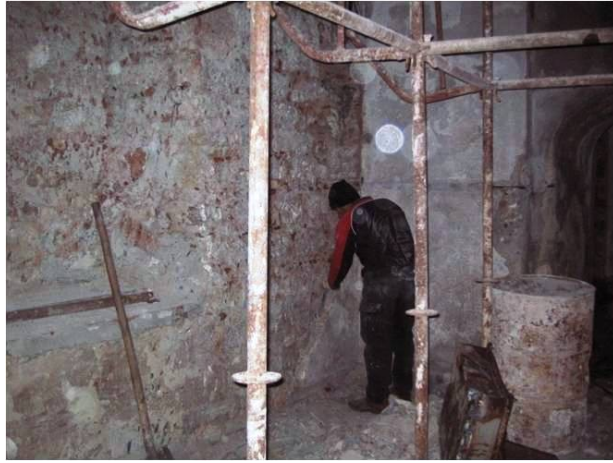
Şekil 4.1.5.2.9: Sıva raspalarının yapılması (R. A. Arşivi)
