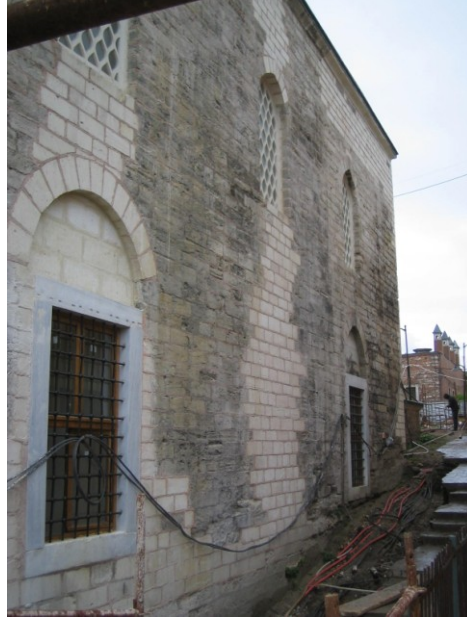
Şekil 4.1.5.3.11: Doğu cephesinde dış duvar cidarında kısmi olarak bütünleme yapılması (R. A. Arşivi)
