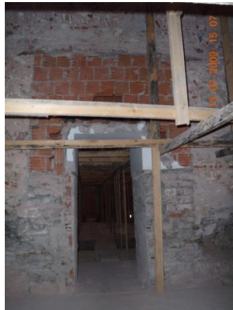
Şekil 4.2.5.2.21: Erkek-Kadın sıcaklık eyvanları arasında açılan geçit ( Tevfik İlter Arşivi EK-2[12])
