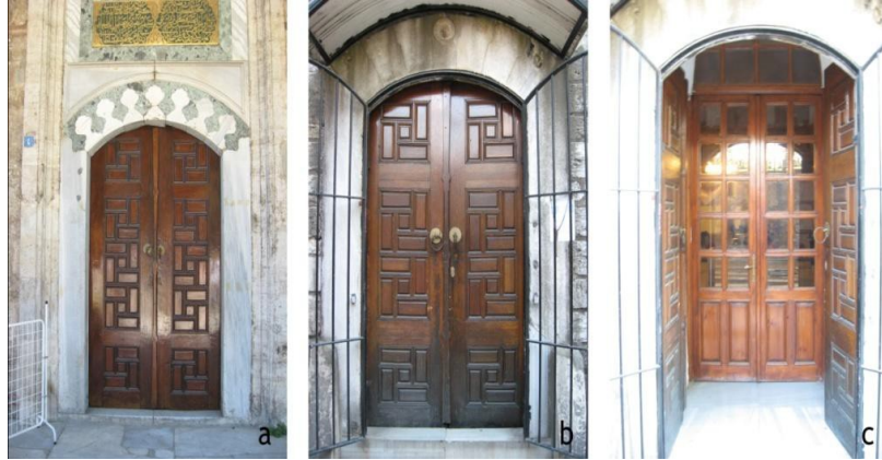
Şekil 4.2.5.3.104a - 4.2.5.3.104b - 4.2.5.3.104c: Yenilemeden önce kapılar a.) Erkekler soğukluk dış kapısı b.) Kadınlık soğukluk dış kapısı c.) Kadınlık soğukluk iç kapısı (K.V.K.K. Arşivi, EK-2[4])
