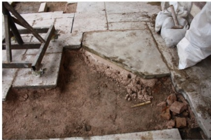
Şekil 4.2.5.3.5a - 4.2.5.3.5b - 4.2.5.3.5c: Revaklı erkekler girişinin dışındaki taşların bütünleme yapılması [8]
