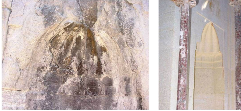
Şekil 4.1.5.3.61a - 4.1.5.3.61b: Taç kapı kenarlarındaki niřlerin mukarnas bezeme bütünlemesi (R. A. Arřivi)
