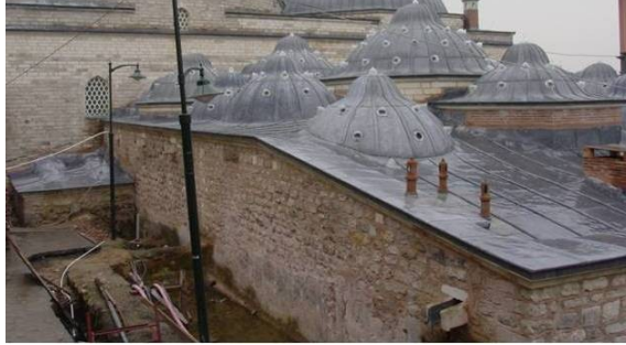
Şekil 4.1.5.3.16: Dış yüzdeki taş duvarların derz ve taş bütünlemelerinin yapılması (R. A. Arşivi)
