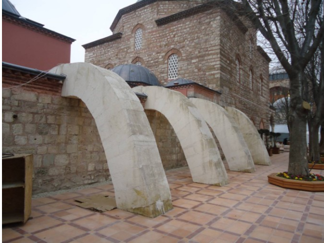
Şekil 4.2.5.1.88: Sıcak su deposunun yan duvarlarının payandalar ile desteklenmesi (V.B.M.Arşivi EK-2[8])
