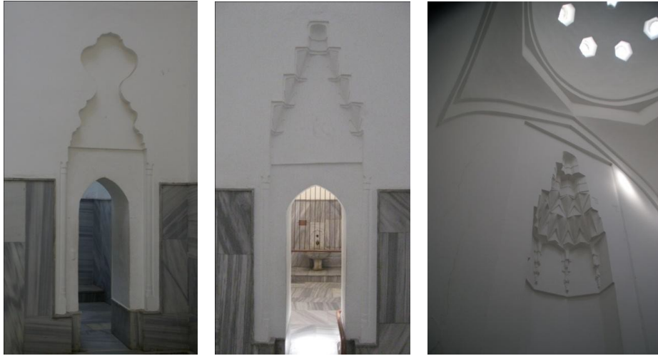
Şekil 4.2.5.2.57: Restorasyon öncesi halvet girişi alçı sövesi(K.V.K.K. Arşivi, EK-2[4])
