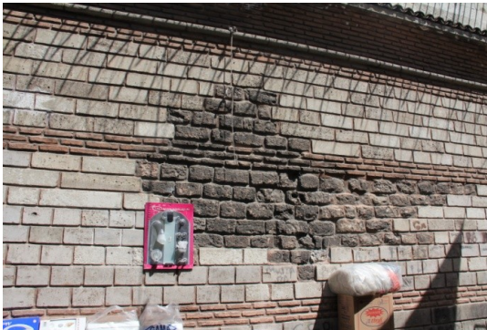
Şekil 4.3.5.3.7: Restore edilerek bütünlenen kadınlar ılıklik, sıcaklik duvarı (Deniz Alkan, Nisan 2015)
