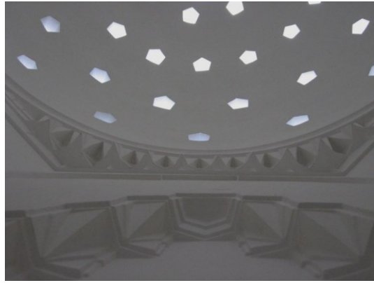
Şekil 4.2.5.2.61: Kadınlar Sıcaklık Bölümü Kubbesi mukarnasları ve çimentolu sıva ile yapılan halvet sövesi (K.V.K.K. Arşivi, EK-2[4])
