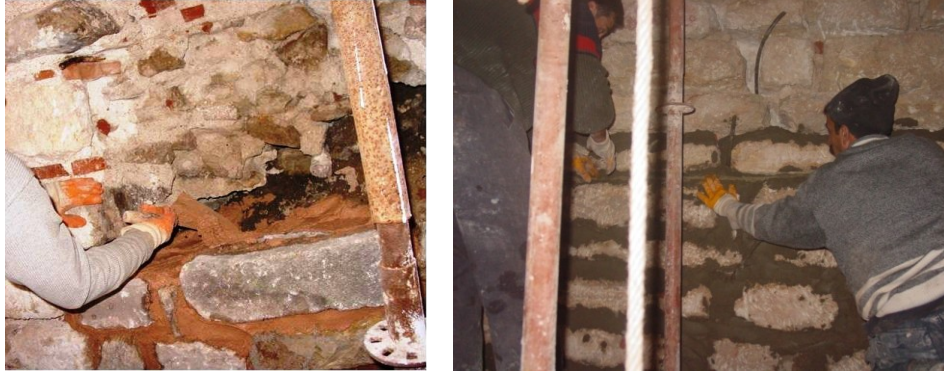
Şekil 4.1.5.1.22a – 4.1.5.1.22b: Taş duvarda taş dikiş ve karbon çubuk uygulaması yapılması (R. A. Arşivi)
