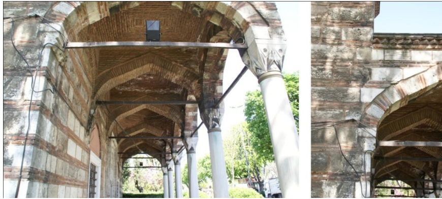
Şekil 4.2.5.3.37a - 4.2.5.3.37b : Güneydoğu cephesi revak kemerleri restorasyon öncesi (K.V.K.K. Arşivi, EK-2[4])
