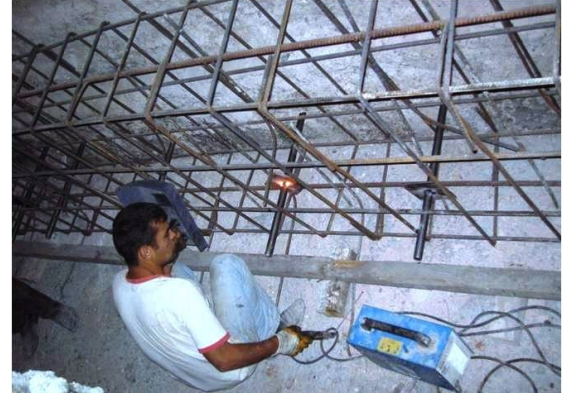
Şekil 4.1.5.1.5: Zemin takviyesi güçlendirme betonu içerisinde, çatlak aksı boyunca kullanılan çelikler (R. A. Arşivi)
