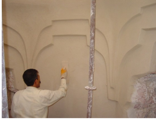
Şekil 4.1.5.3.62: Duvardaki bezemelerin sıva tamamlanması (R. A. Arşivi)
