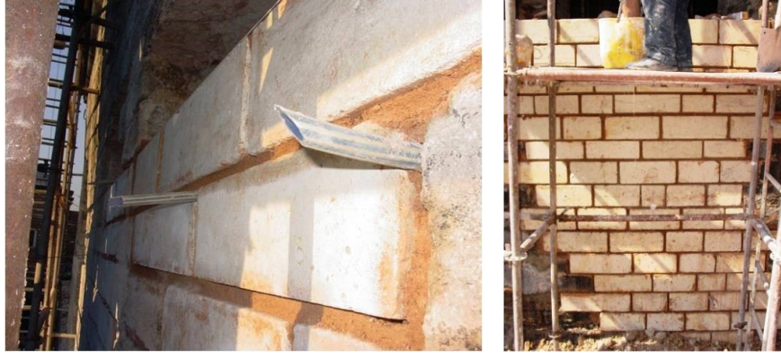
Şekil 4.1.5.1.33a – 4.1.5.1.33b: Enjeksiyon harcı dökülmesi için hortumların yerleştirilmesi (R. A. Arşivi)
