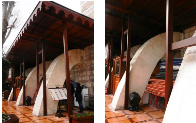
Şekil 4.2.5.4.7: Sıcak su deposu duvarını destekleyen payandalar üstüne yapılan ahşap saçak (Deniz Alkan, Ocak 2015)
