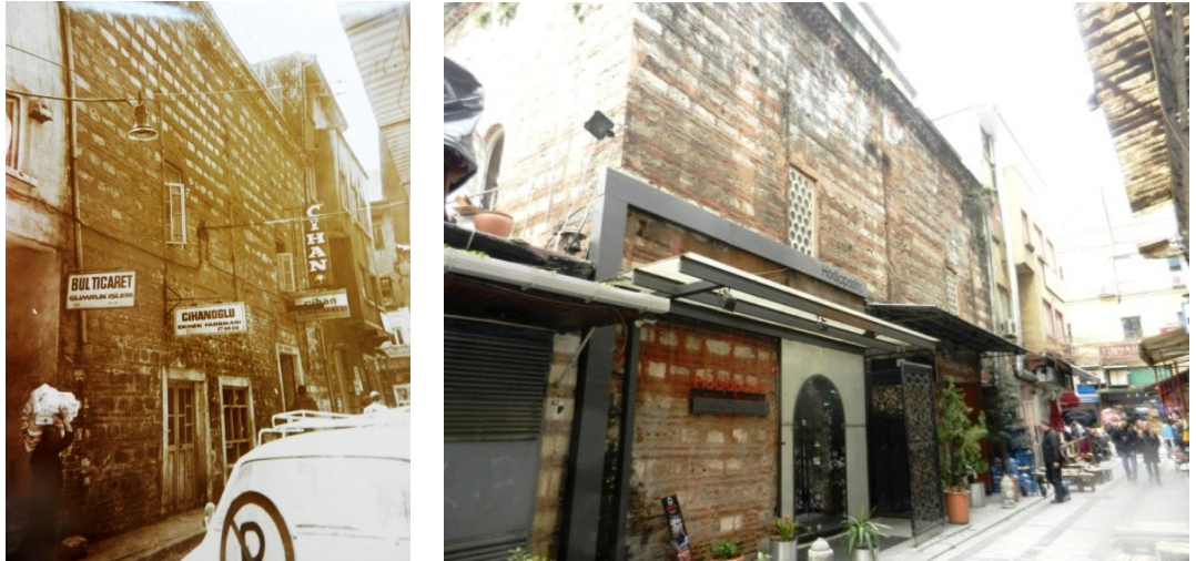
Şekil 4.4.5.2.2: Kadınlar kısmı soğukluk duvarına bitişik muhdes iki katlı bina (Ayverdi, Ekrem Hakkı, 1974)
