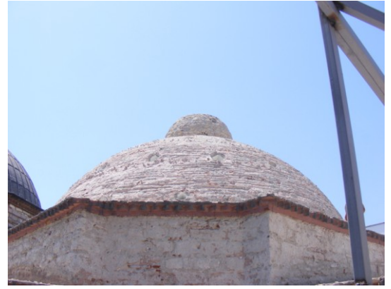
Şekil 4.2.5.2.37a - 4.2.5.2.37b : Sıva raspası yapılmış sıcaklık kubbesi(Tevfik İlter Arşivi EK-2[12])
