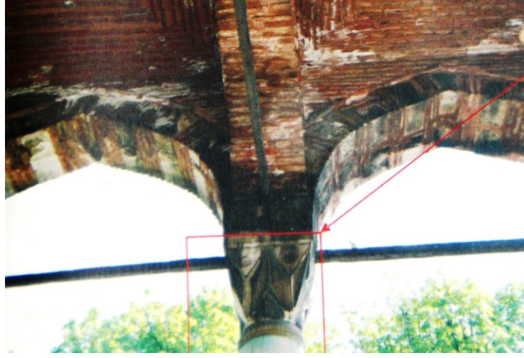
Şekil 4.2.5.2.10: Revak Kemerlerinde oluşan kir ve su almadan dolayı oluşan tuz oluşumları (K.V.K.K. Arşivi, EK-2[7])
