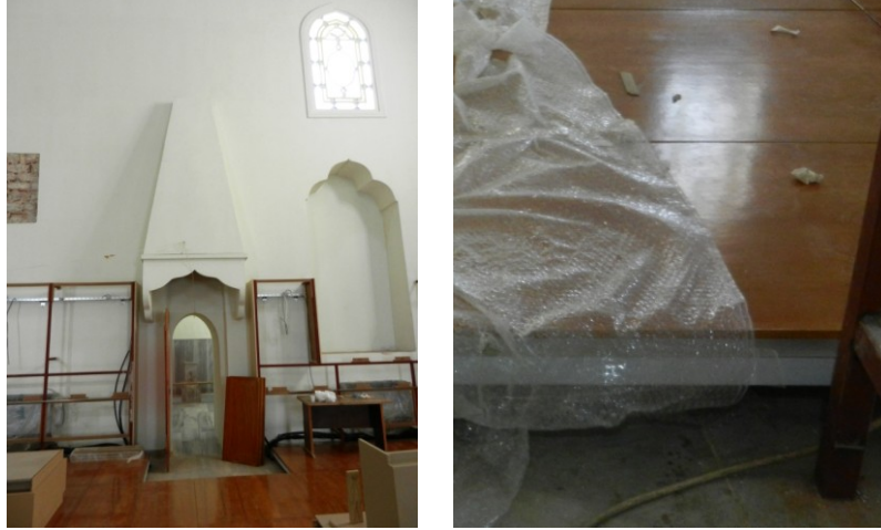
Şekil 4.1.5.4.1a - 4.1.5.4.1b: Yükseltilmiş döşeme yapılması (Deniz Alkan, Temmuz 2014)
