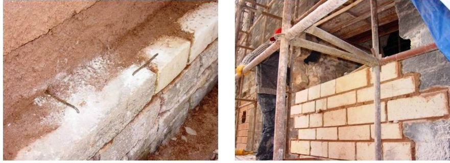
Şekil 4.1.5.1.31a – 4.1.5.1.31b: Dikiş duvar örgüleri yapılarak taşların birbirine kenet ile tutturulması (R. A. Arşivi)
