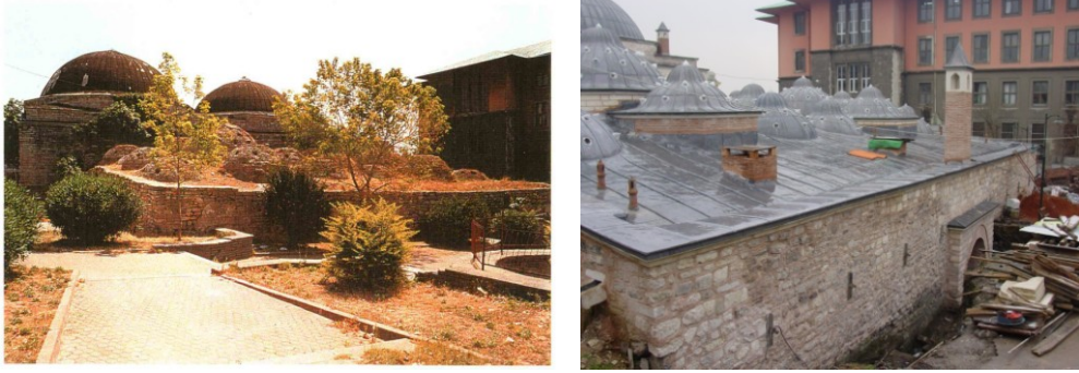
Şekil 4.1.5.3.42a - 4.1.5.3.42b: Su deposunun kurşun kaplamalarının yapılarak bütünlene (R. A. Arşivi)
