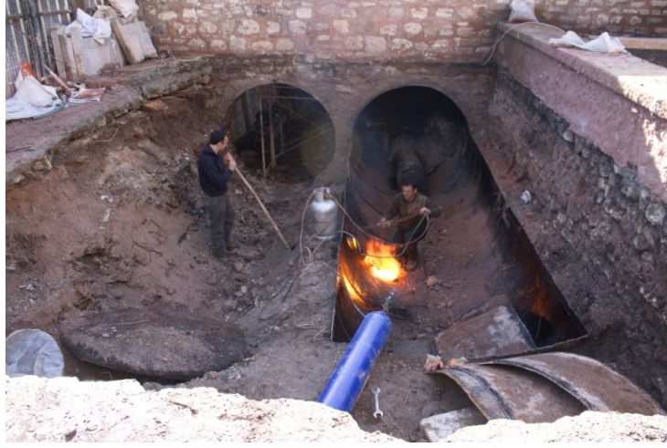
Şekil 4.2.5.2.3: Külhanın önünde toprak altına yapılan eski yakıt tanklarının sökülerek temizlenmesi ( Tevfik İlter Arşivi EK-2[12])
