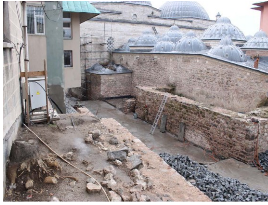
Şekil 4.1.5.3.24: Ortaya çıkarılan odunluk duvarının derzlerinin açılması [2]
