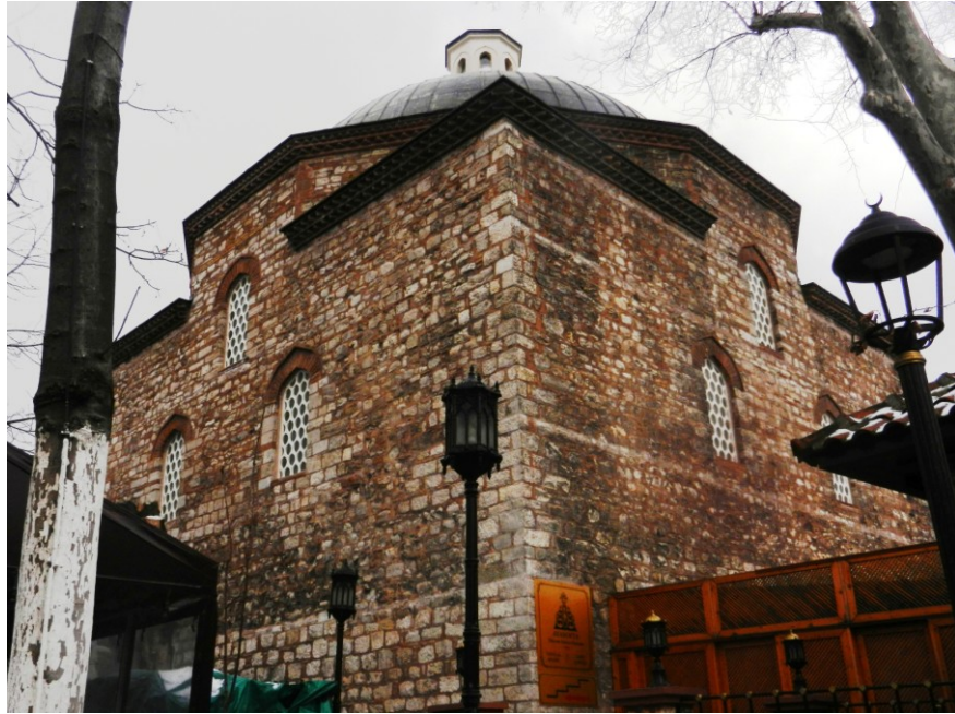
Şekil 4.2.5.3.34: Güneybatı-güneydoğu köşesi cephesinde kadınlar soğukluk duvarı (Deniz Alkan, Ocak 2015)
