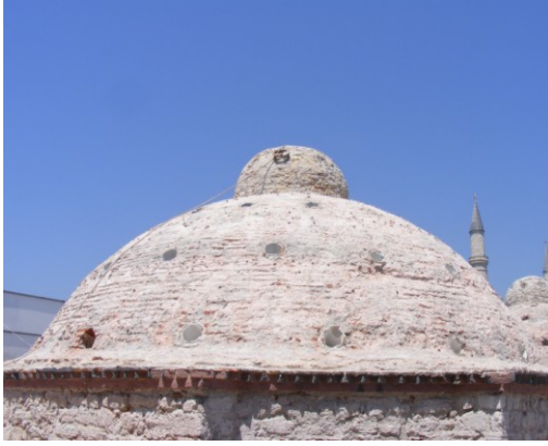
Şekil 4.2.5.2.37a - 4.2.5.2.37b : Sıva raspası yapılmış sıcaklık kubbesi(Tevfik İlter Arşivi EK-2[12])
