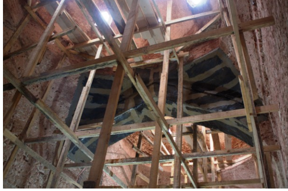
Şekil 4.2.5.1.30: İlklik kubbelerini taşıyan kemerlerde oluşan çatlakların sağlamlaştırılması (Tevfik İter Arşivi EK-2[12])
