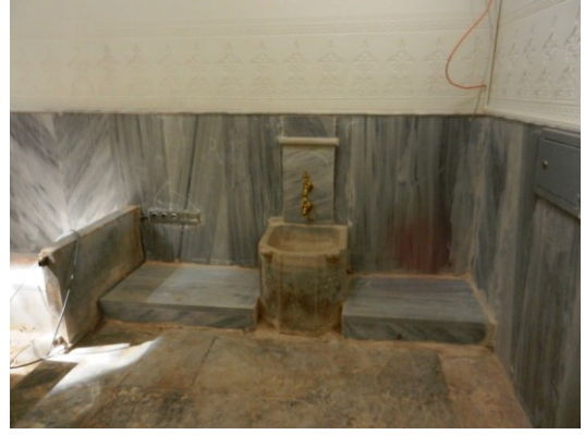
Şekil 4.1.5.3.56a - 4.1.5.3.56b: KZ05E3 no.lu eyvandaki mermer kurna ve mermer batak havuzu etrafındaki mermer sekilerin bütünlemesi (Deniz Alkan, Temmuz 2014)
