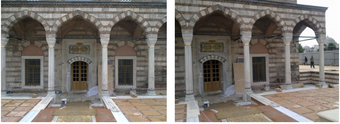
Şekil 4.2.5.3.6a - 4.2.5.3.6b: Revakların dışına döşenen taşlar [9]
