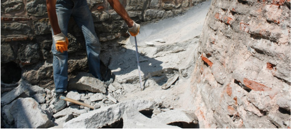
Şekil 4.2.5.2.27: Kubbe aralarında yapılmış olan çimentolu harçların sökülmesi (Tevfik İlter Arşivi EK-2[12])
