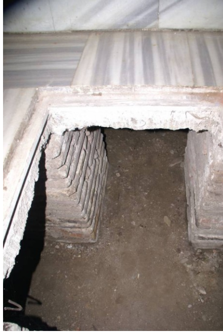
Şekil 4.2.5.2.6: Sökülen mermerler ve harcı (V.B.M.Arşivi EK-2[8])
