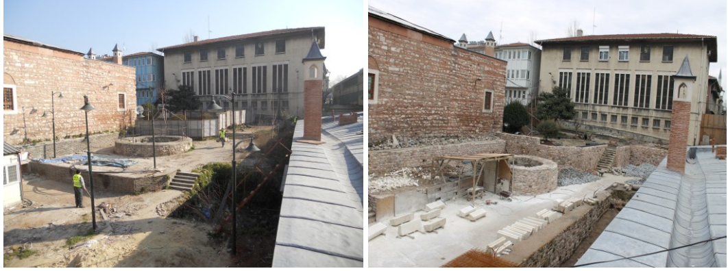
Şekil 4.1.5.1.17a – 4.1.5.1.17b: Kuyu çevresinin temizlenerek sağlamlaştırılması [2]
