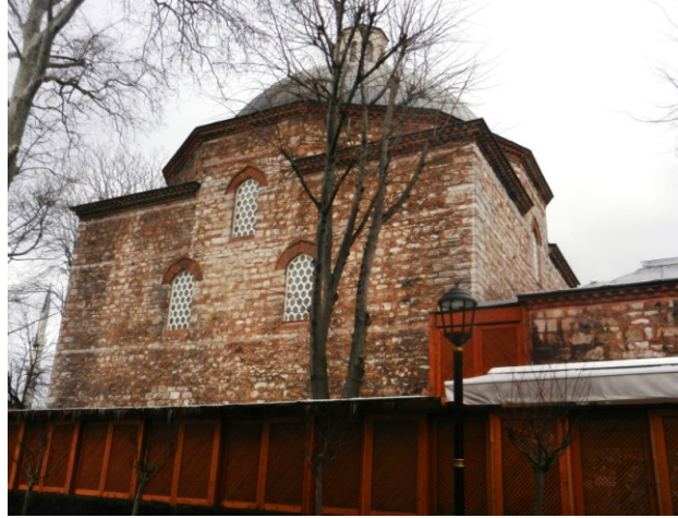
Şekil 4.2.5.3.39: Güneydoğu cephesinde kadınlar soğukluk duvarı (Deniz Alkan, Ocak 2015)
