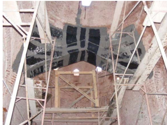
Şekil 4.2.5.1.31: İlklik kubbelerini taşıyan kemerlerin sağlamlaştırılması [10]
