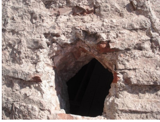
řekil 4.2.5.2.38: Sökülen aydınlatma fil gözü fanuslar (V.B.M. Arřivi EK-2[8])
