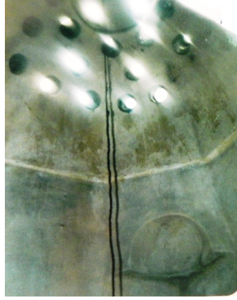
Şekil 4.4.5.2.13: Sıcaklık kubbelerinin geçiş öğeleri, basit bezemesiz tromplar (K.V.K.K. Arşivi, EK-4[1])
