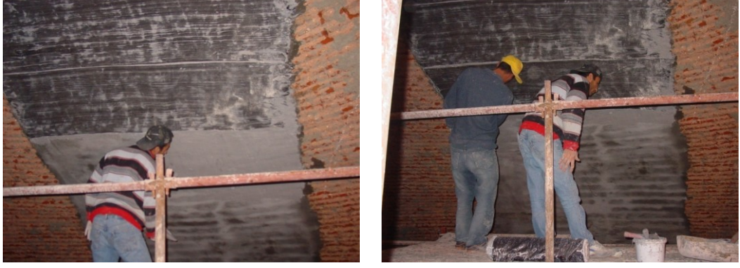
Şekil 4.1.5.1.49a - 4.1.5.1.49b: Kubbe çatlaklarının iç yüzeyinde karbon kanaviçe uygulaması (R. A. Arşivi)
