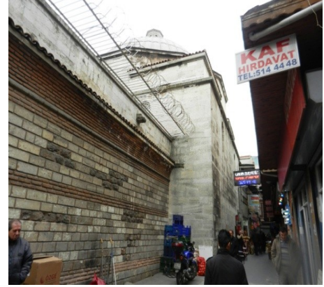
Şekil 4.3.5.3.5: Güneybatı cephesi, Kantarcılar Sokak'ta kadınlar ılıklik duvarının üstündeki betonarme ekler (K.V.K.K. Arşivi, EK-3[4])
