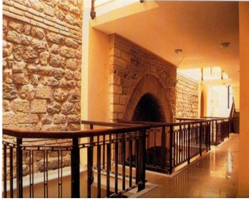
Şekil 4.3.5.3.21: Külhan duvarı ve ocak nişi bütünleme (Kuban, Doğan, 1993)
