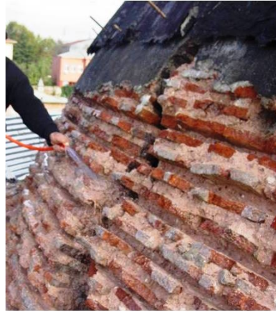
Şekil 4.1.5.1.38: Açılan çatlakların su ile temizlenmesi (R. A. Arşivi)
