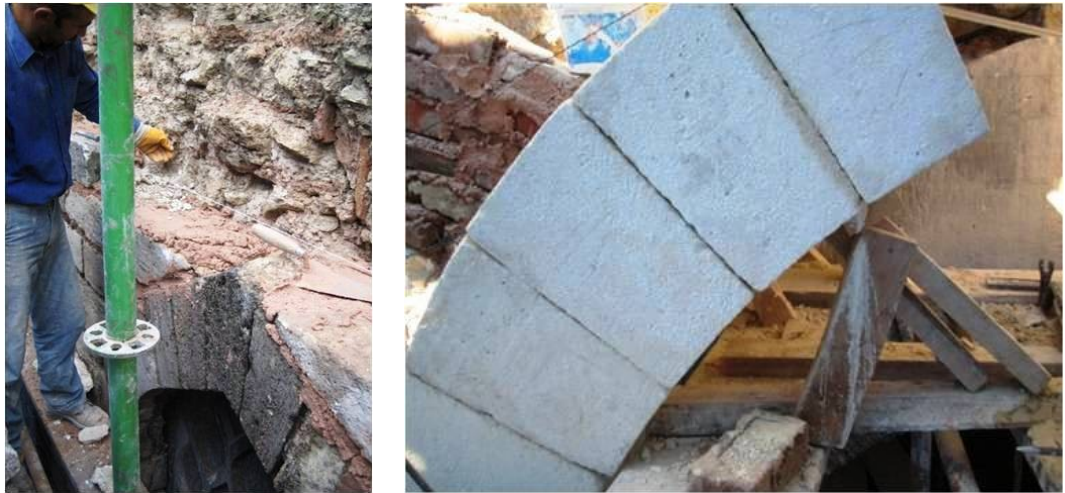
Şekil 4.1.5.3.13a - 4.1.5.3.13b: Duvarlardaki pencere kemerlerine bütünleme yapılması (R. A.Arşivi)
