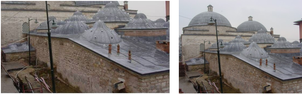
Şekil 4.1.5.3.27a - 4.1.5.3.27b: Kubbe fenerlerinin, fil gözlerin ve kaplamalarının tamamlanması (R. A. Arşivi)
