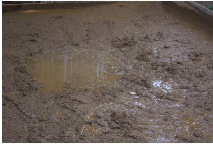
Şekil 4.2.5.3.64: Üst örtü kurşun kaplamamın altına hidrolik kireçle yapılan harcın terkbine göre hazırlanması (Tevfik İlder Arşivi EK-2[12])
