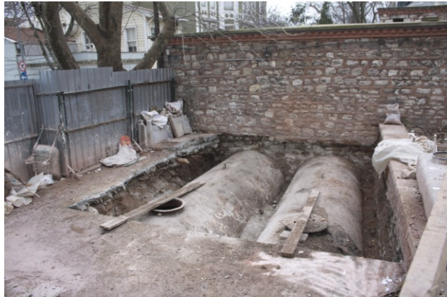
Şekil 4.2.5.2.2: Külhanın önünde toprağın altına gömülen eski yakıt kazanları ( Tevfik İlter Arşivi EK-2[12])
