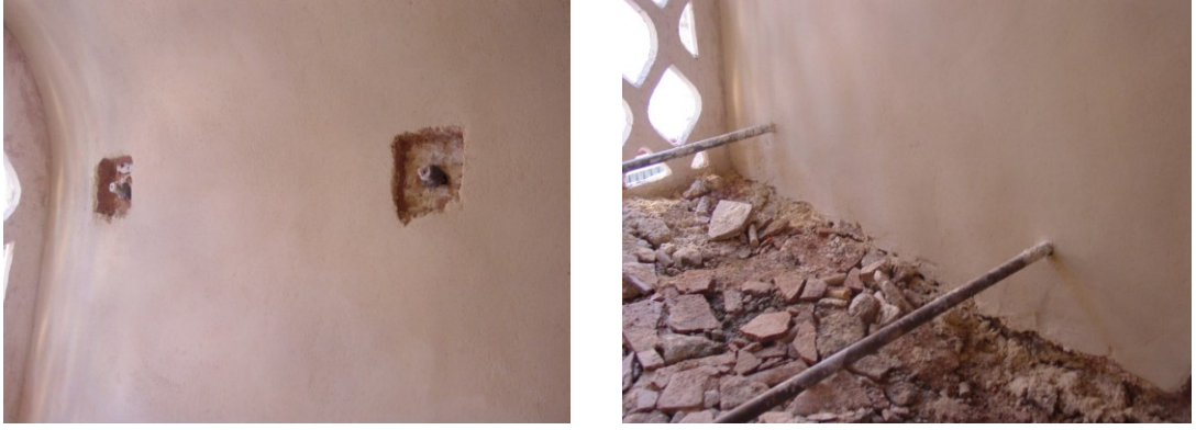
Şekil 4.1.5.1.24b – 4.1.5.1.24c: Pencere nişlerinde hatıl boşluklarına çelik donatı yerleştirilmesi (R. A. Arşivi)
