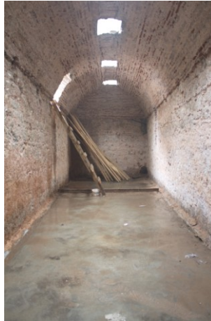
řekil 4.2.5.2.39: Soęuk su deposunun duvar ve tonozun iđer sıvalarının raspa ile temizlenmesi (Tevfik İter Arřivi EK-2[12])
