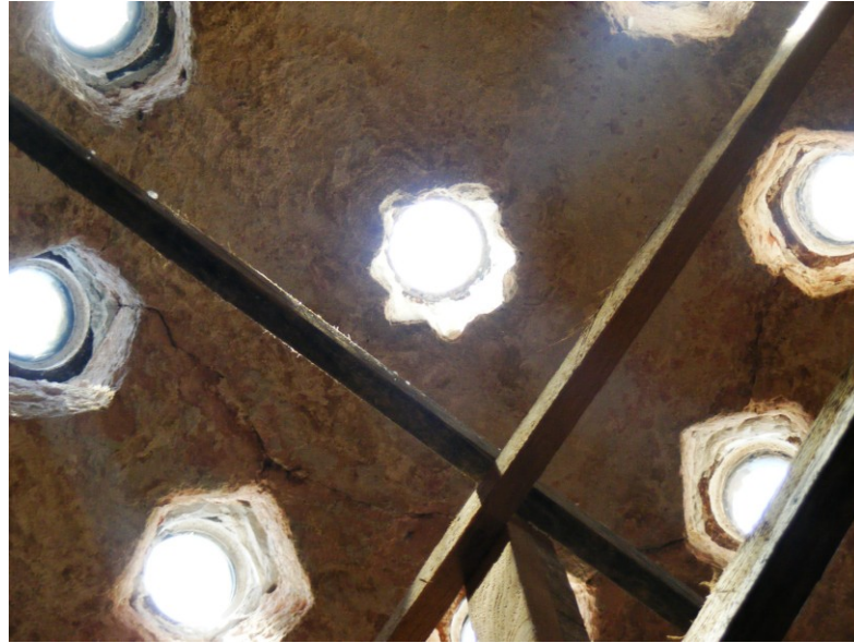
Şekil 4.2.5.2.30: Kubbelerin altıgen ve yıldız formlardaki fil gözlerinin sökülerek temizlenmesi (Tevfik İlder Arşivi EK-2[12])
