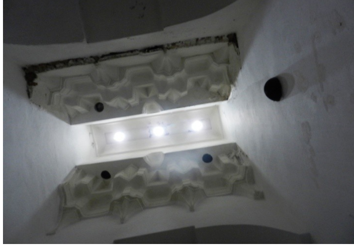
Şekil 4.3.5.3.58: Erkekler ılıklik odasında mukarnaslı tonozun bütünleme yapılması (Deniz Alkan, Mart 2014)
