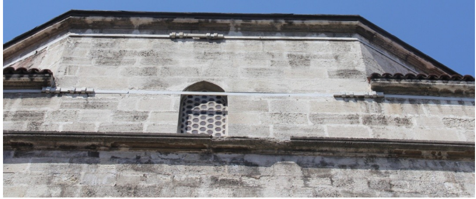
Şekil 4.3.5.1.2: Erkekler soğukluk güneydoğu cephesi, kubbede çemberleme (Deniz Alkan, Nisan 2015)
