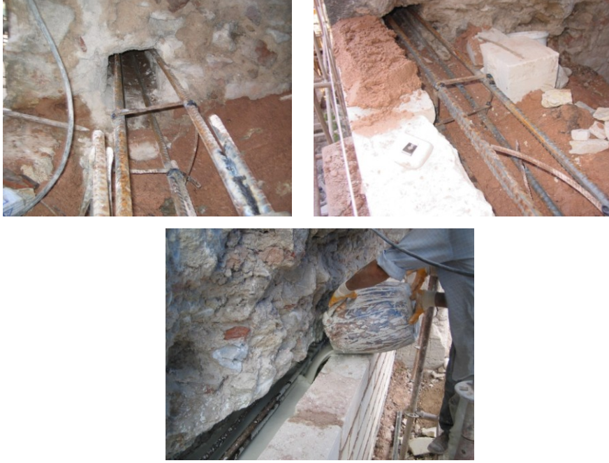
Şekil 4.1.5.1.23a – 4.1.5.1.23b – 4.1.5.1.23c: Hatıl boşluklarına çelik donatılı kiriş ve enjeksiyon yapılması (R. A. Arşivi)
