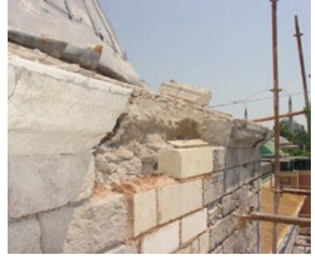
Şekil 4.1.5.3.18: Yangın geçirmiş duvarlarda taşın yenilerek bütünlenmesi (Eyüpgiller, Kemal Kutgün, 2010)
