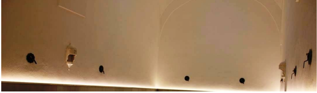
Şekil 4.2.5.3.56: Ilıklık eyvanında değişen tütek kapakları ve çırağmanlar (V.B.M. Arşivi EK-2[8])
