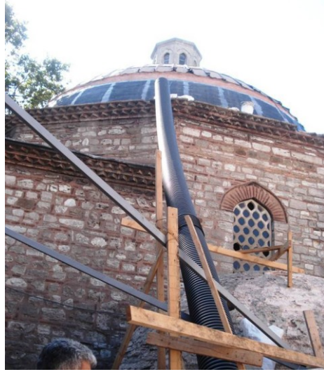
Şekil 4.2.5.1.52: Kubbeye karbon kumaş uygulaması yapılması (V.B.M. Arşivi EK-2[8])
