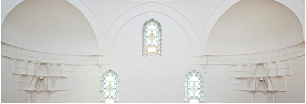
Şekil 4.2.5.3.41: Kadınlar kısmı soğukluk bölümünün iç sıva bütünlemesi [5]
