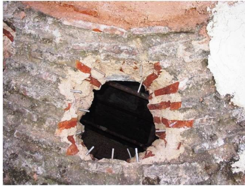
Şekil 4.1.5.1.53: Kubbelerdeki fil gözlerinde çelik filizler ile yapılan sağlamlaştırma (R. A. Arşivi)
