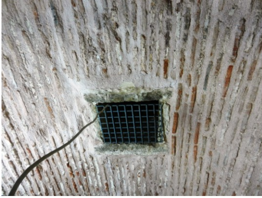
Şekil 4.1.5.4.9: Yeni işlev gereği su deposuna yapılan hava bacası (R. A. Arşivi)
