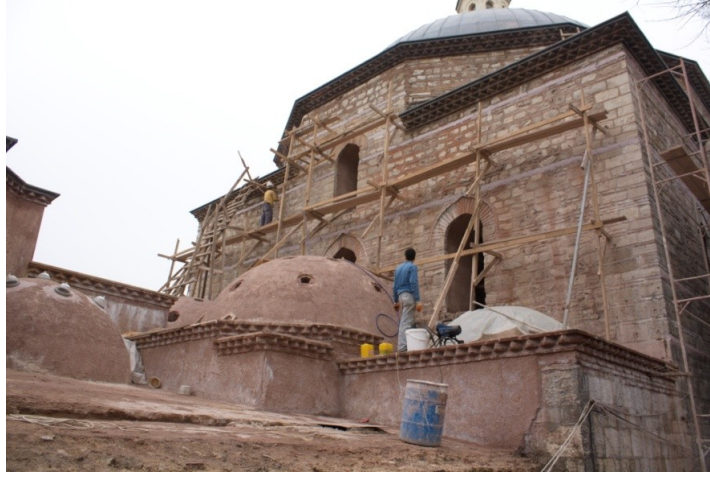
Şekil 4.2.5.1.14: Soğukluk duvarına dıştan yapılan sürekli karbon plak uygulaması (Tevfik İlater Arşivi EK-2[12])
