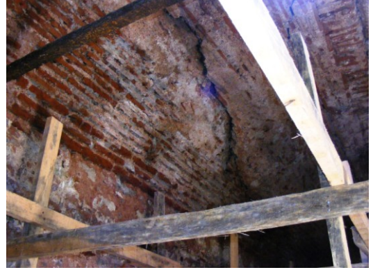
Şekil 4.2.5.1.85a - 4.2.5.1.85b: Sıcak su deposunun tonozunda oluşan çatlaklar (Tevfik İlder Arşivi EK-2[12])
