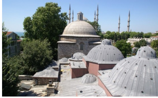
Şekil 4.2.5.2.32: Kurşun taklidi sıva ile kaplı ılık ve sıcaklık üst örtüleri (K.V.K.K. Arşivi, EK-2[4])
