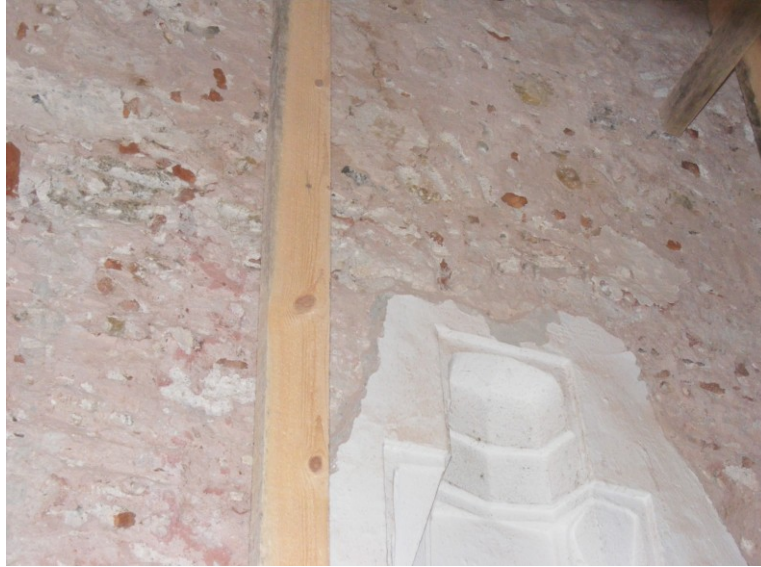
Şekil 4.2.5.2.15: Çimento esaslı iç sıvaların raspalanarak temizlenmesi (Tevfik İlter Arşivi EK-2[12])
