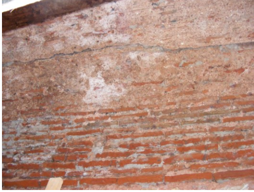
Şekil 4.2.5.1.84a - 4.2.5.1.84b: Sıcak su deposunun tonozunda oluşan çatlaklar (Tevfik İlder Arşivi EK-2[12])
