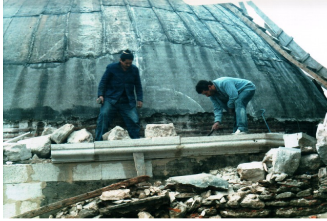
Şekil 4.3.5.3.2: Soğukluk kubbesi eteklerinde taş sövelerin yeniden yapılarak bütünleme yapılması (K.V.K.K. Arşivi)
