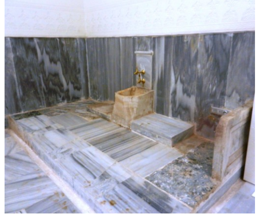
Şekil 4.1.5.3.7a - 4.1.5.3.7b: Eyvandaki mermer kurnaların etrafındaki mermer sekilerin tamamlanması (R. A. Arşivi)
