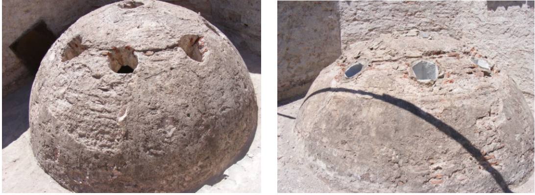
Şekil 4.2.5.1.67: Halvet (EZ07)kubbe çatlağı Şekil 4.2.5.1.68: Halvet (EZ10) kubbe çatlağı (Tevfik İlter Arşivi EK-2[12])
