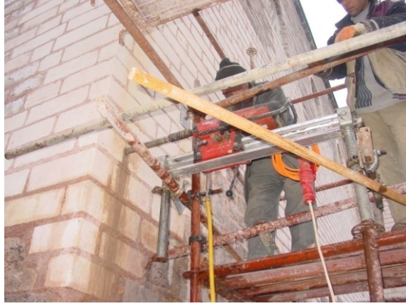
Şekil 4.1.5.1.30: Duvarlarda çelik bağlantı çubukları için karot delgilerinin açılması (R. A. Arşivi)
