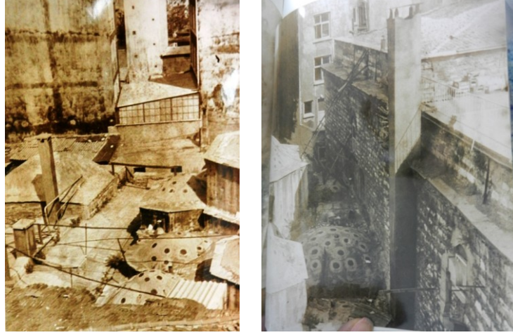
Şekil 4.4.5.2.7: Ilıklık ve sıcaklık kubbelerinin muhdes kaplamaları ve hamam avlusunda yapılan binalar (K.V.K.K. Arşivi, EK-4[1])
