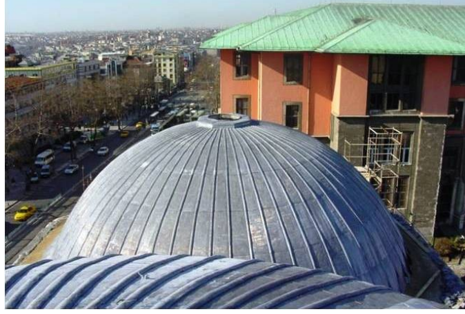
Şekil 4.1.5.3.30: Kubbenin kurşun ile kaplanması (R. A. Arşivi)
