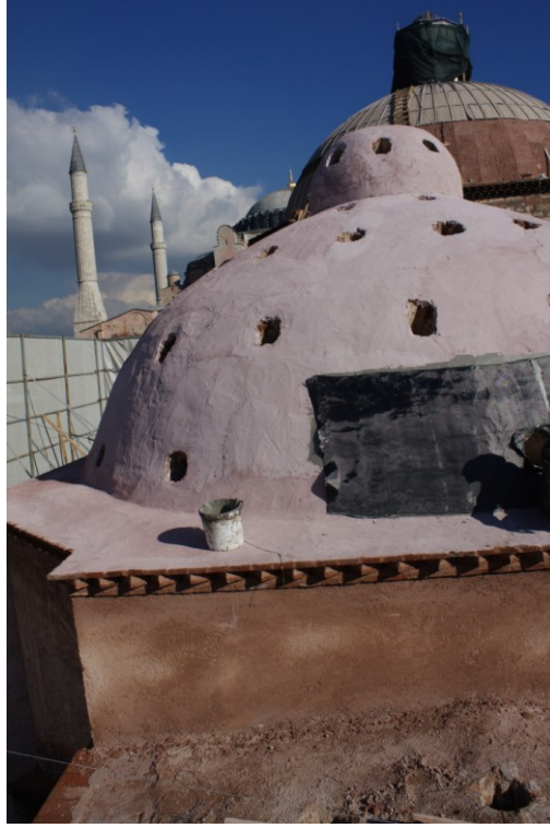
Şekil 4.2.5.1.64: Sıcaklık orta kubbe karbon kumaş ile kuşaklama yapılarak sağlaştırılması (Tevfik İlter Arşivi EK-2[12])
