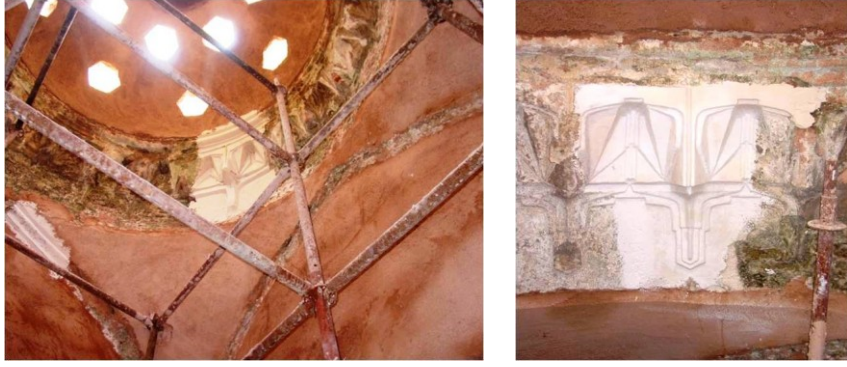
Şekil 4.1.5.3.68a - 4.1.5.3.68b: Mukarnas alçı kalıp alma çalışmaları (R. A. Arşivi)
