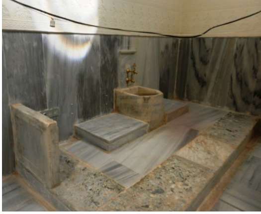
Şekil 4.1.5.3.7a - 4.1.5.3.7b: Eyvandaki mermer kurnaların etrafındaki mermer sekilerin tamamlanması (R. A. Arşivi)
