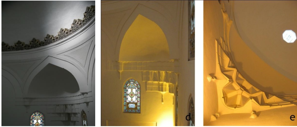
Şekil 4.2.5.2.60: Erkekler kısmı soğukluk bölümü kubbe kasağını dolanan üçlü palmet tepelikli taş bezeme bordürü ve köşe tromplarının alçı mukarnaslı bezemeler (K.V.K.K. Arşivi, EK-2[4]) d) Soğukluk köşe trompu e) Mukarnas detayı (K.V.K.K. Arşivi, EK-2[5])
