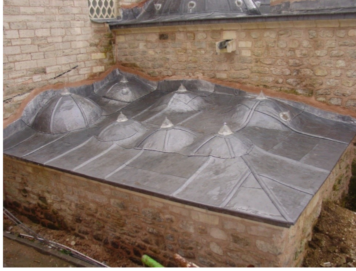
Şekil 4.1.5.3.28: Ilıktan geçilen hela grubunun üst örtüsü (R. A.Arşivi)
