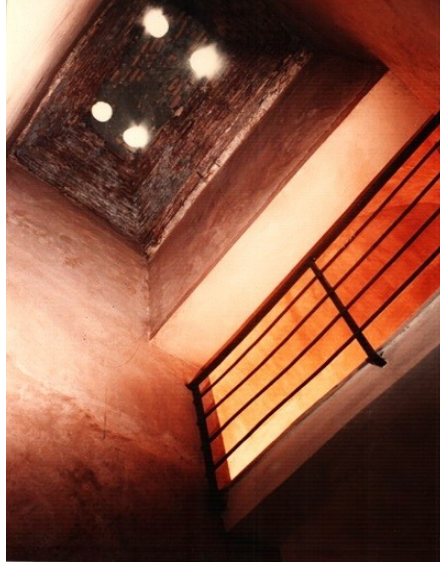
Şekil 4.3.5.3.33: Erkekler ılıkıkta yıkılan hela duvarlarının üstündeki aynalı tonoz ve figözleri (K.V.K.K. Arşivi, EK-3[4])
