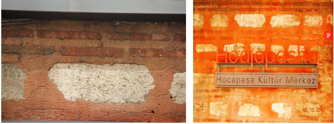
Şekil 4.4.5.3.4: Çökertme tekniği kullanılmadan yapılan derz bütünleme (Deniz Alkan, Mart 2015)
