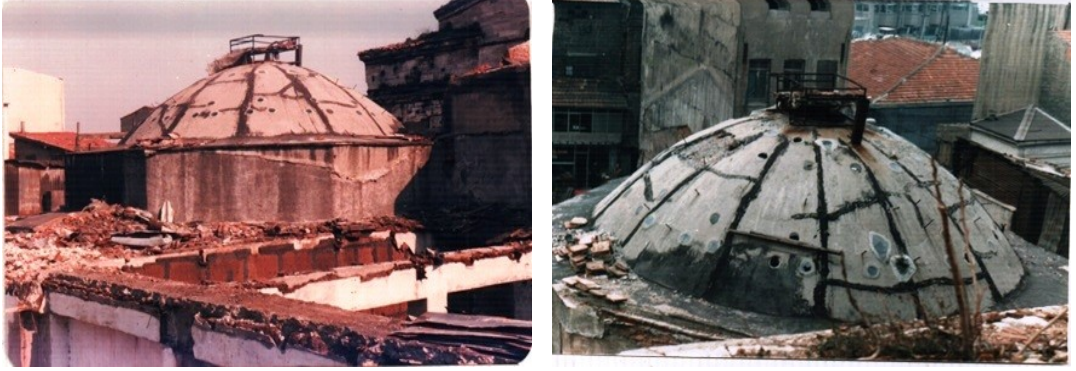
Şekil 4.3.5.2.12: Erkekler sıcaklık kubbesi üzerinde beton kaplama ve yıkılan betonarme katlar (K.V.K.K. Arşivi, EK-3[4])
