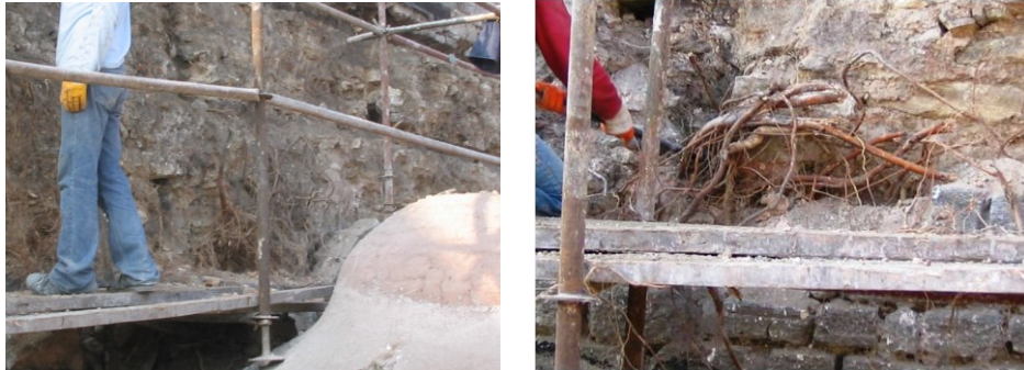
Şekil 4.1.5.2.5a - 4.1.5.2.5b: Cephelerdeki bitkilerin temizlenmesi (R. A. Arşivi)
