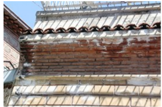
Şekil 4.3.5.3.7: Restore edilerek bütünlenen kadınlar ılıklik, sıcaklik duvarı (Deniz Alkan, Nisan 2015)
