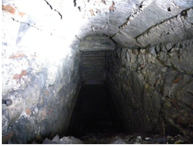
Şekil 4.2.5.2.1: Hamamın tüm çevresinde mevcut olan, toprak ve atıklar ,sonradan örülen duvarlarla kapanan orijinal drenaj kanalları ( Tevfik İlter Arşivi EK-2[12])
