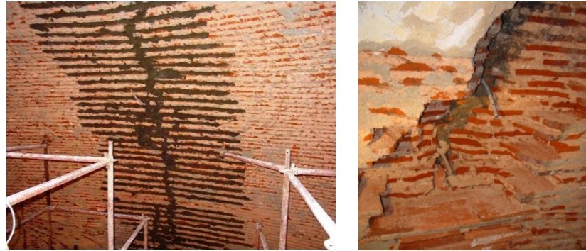
Şekil 4.1.5.1.48a - 4.1.5.1.48b: Kubbe çatlaklarının iç yüzeyinde karbon çubuk uygulaması (R. A. Arşivi)
