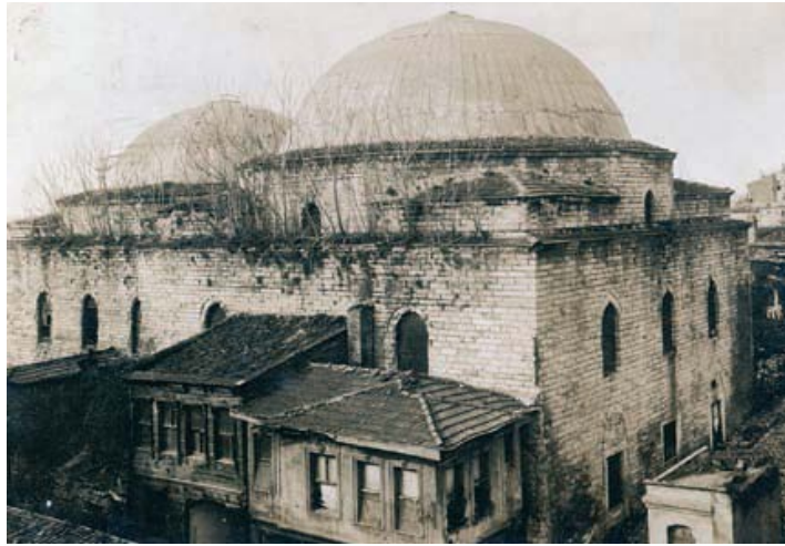
Şekil 4.1.3.4: Hamamın Ordu Caddesi cephesindeki ahşap yapılar [2]
