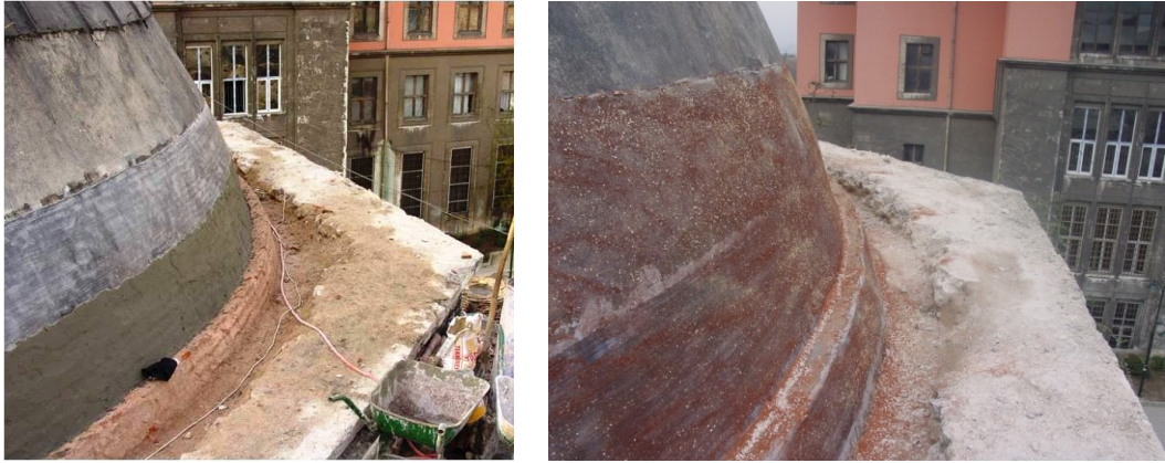
Şekil 4.1.5.1.42a - 4.1.5.1.42b : Karbon kanaviçe üzerine sürülen epoksi harçlar (R. A. Arşivi)
