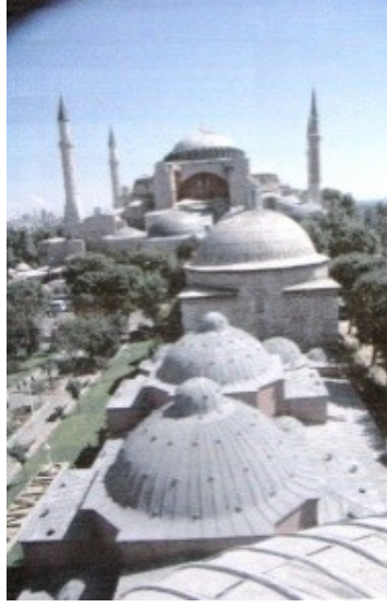
Şekil 4.2.5.3.79: 1957-1958'de onarılan hamamda kubbe tepesindeki kapalı fenerlerin, kapalı kubbecikler haline gelmiş durumu (K.V.K.K. Arşivi, EK-2[4])
