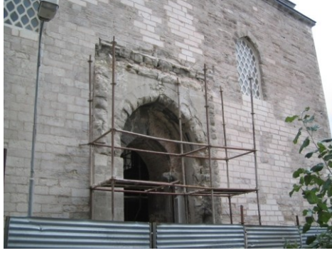
Şekil 4.1.5.3.52a - 4.1.5.3.52b: Batı cephesindeki taç kapının bütünleme çalışmaları (R. A. Arşivi)
