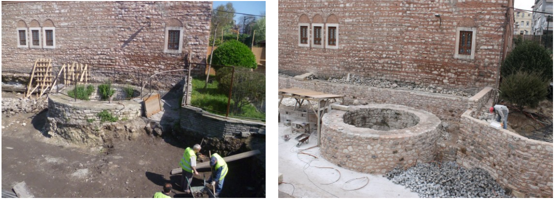
Şekil 4.1.5.2.15a - 4.1.5.2.15b: Su kuyusunun muhdes eklerinin temizliği [2]
