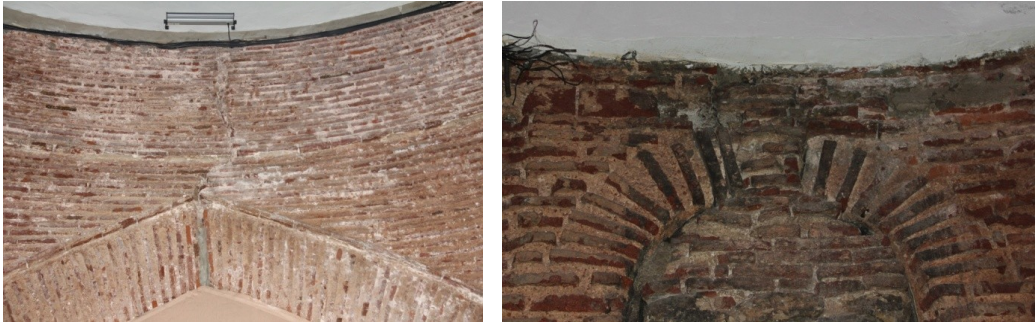
Şekil 4.4.5.1.2: Sivri kemerlerde oluşan çatlakların onarım harcı ile sağlamaştırılması (Deniz Alkan, Mart 2015)
