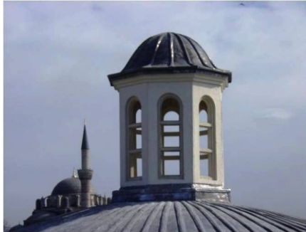
Şekil 4.1.5.3.25a - 4.1.5.3.25b: Kubbe fenerinin restitüsyona dayalı olarak yeniden yapılması (R. A. Arşivi)
