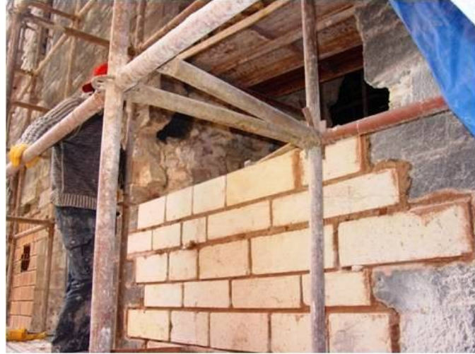
Şekil 4.1.5.3.20: Duvarda yapılan bütünleme çalışmaları (R. A. Arşivi)
