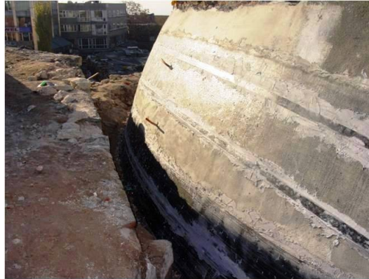
Şekil 4.1.5.1.46: Kubbe üst kasnağında karbon lama (bant) ile 3 defa kuşaklama yapılarak sağlamlaştırma (R. A. Arşivi)
