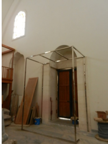
Şekil 4.1.5.4.20: Rüzgârlığın çelik konstrüksiyonu (Deniz Alkan, Temmuz 2014)
