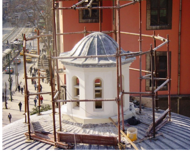
Şekil 4.1.5.3.31: Analoji yöntemi ile yapılan kubbe feneri (R. A. Arşivi)
