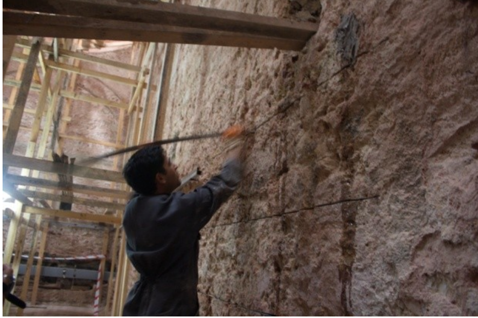
Şekil 4.2.5.1.13: Soğukluk duvarlarına içten yapılan karbon plak uygulaması ( Tevfik İlter Arşivi EK-2[12])
