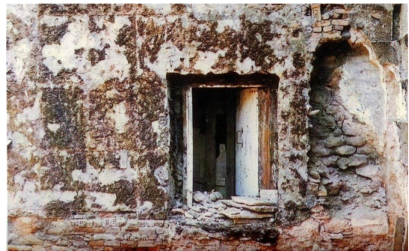
Şekil 4.3.5.2.7: Duvarlarda oluşan yosunlanmalar(K.V.K.K. Arşivi, EK-3[4])
