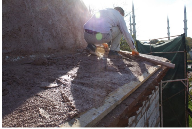
Şekil 4.2.5.3.65: Kubbelerin hazırlanan harç ile sıvanması (Tevfik İlter Arşivi EK-2[12])
