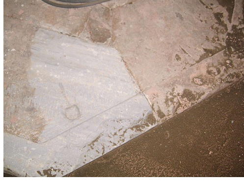
Şekil 4.2.5.2.7: Döşeme taşların kumlama ile temizlenmesi [7]
