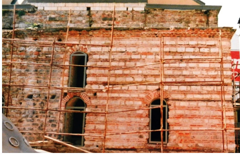
Şekil 4.4.5.3.7: Kuzeydoğu cephesinde kadınlar kısmı soğukluk duvar bütünleme (K.V.K.K. Arşivi, EK-4[1])
