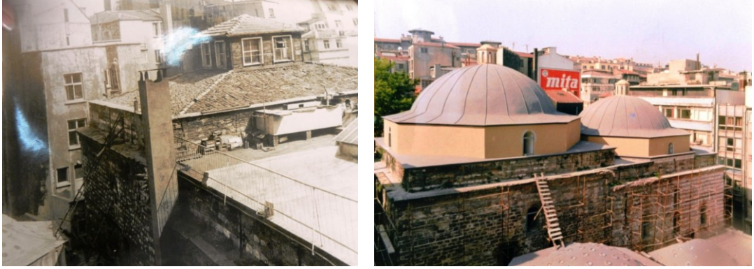
Şekil 4.4.5.3.12: Soğukluk kubbeleri yerine kiremit çatı olduğu restorasyon öncesi (K.V.K.K. Arşivi, EK-4[1])
