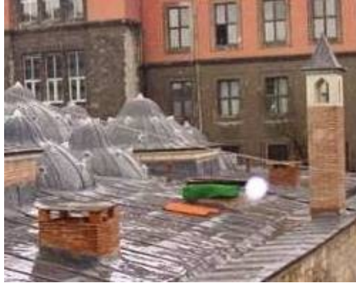
Şekil 4.1.5.3.58: Külhan bacasının yeniden yapılması (R. A. Arşivi)
