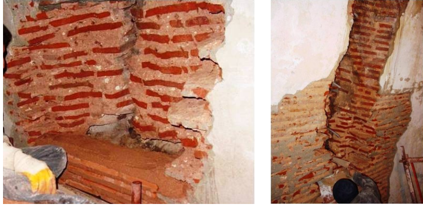
Şekil 4.1.5.1.47a - 4.1.5.1.47b: Kubbe çatlaklarının iç yüzeyindeki tuğla dikiş uygulaması (R. A. Arşivi)
