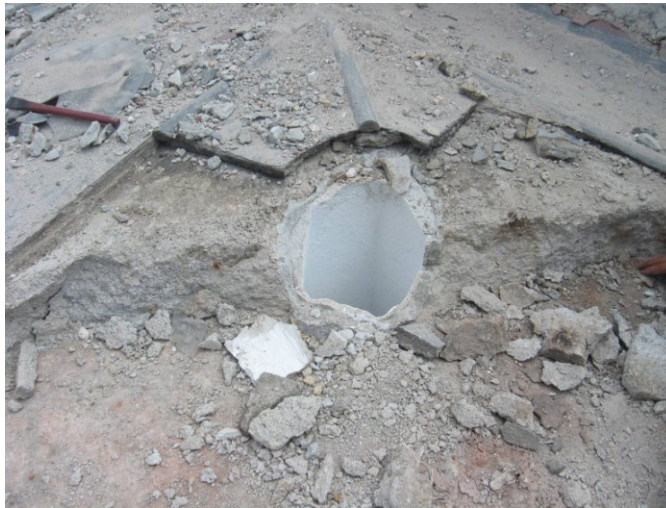
Şekil 4.2.5.2.26: Kubbelerin üstündeki çimento katkılı sıvalar ve orijinal olmayan filgözü(V.B.M.Arşivi EK-2[8])
