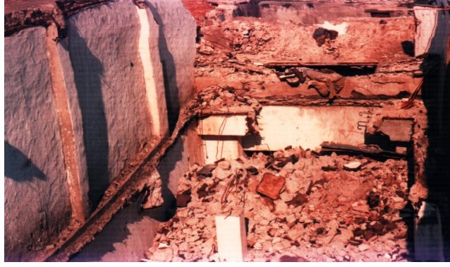
Şekil 4.3.5.2.5: Muhdes betonarme eklerin yıkılarak temizlenmesi(K.V.K.K. Arşivi, EK-3[4])
