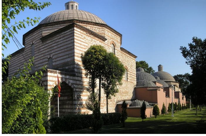
Şekil 4.2.5.3.26: Kuzeybatı cephesi erkekler soğukluk köşesi yenilemeden önce (K.V.K.K. Arşivi, EK-2[4])
