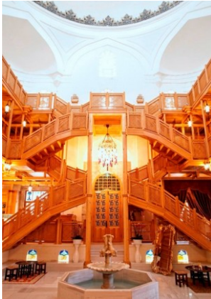
Şekil 4.2.5.3.80: Erkekler soyunmalıkta restitüsyona dayalı yeniden yapılan şirvan ve merdivenler [5]
