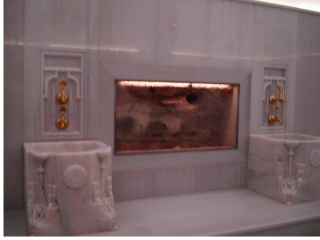
Şekil 4.2.5.3.110: Yenilenen kurnalar ve arasında teşhir edilen duvarda orijinal su tesisatı (V.B.M.Arşivi EK-2[8])
