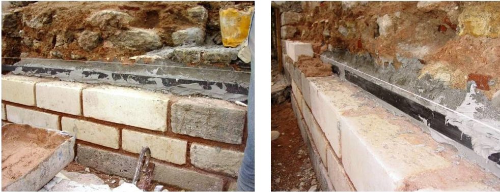
Şekil 4.1.5.1.32a – 4.1.5.1.32b: Duvarların karbon plak ile sağlamlaştırılması (R. A. Arşivi)
