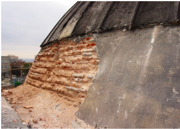
Şekil 4.1.5.2.17a - 4.1.5.2.17b: Kubbedeki muhdes kaplamaların temizlenmesi (R. A. Arşivi)
