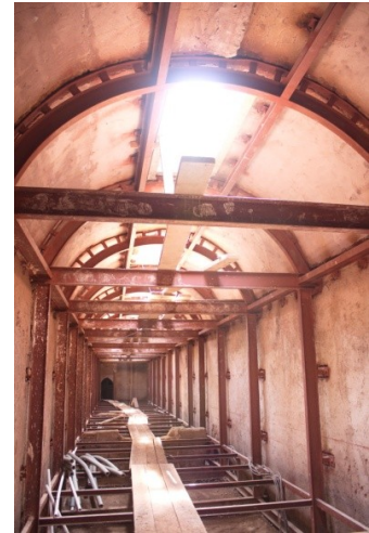
Şekil 4.2.5.1.88: Sıcak su deposunun yan duvarlarının payandalar ile desteklenmesi (V.B.M.Arşivi EK-2[8])
