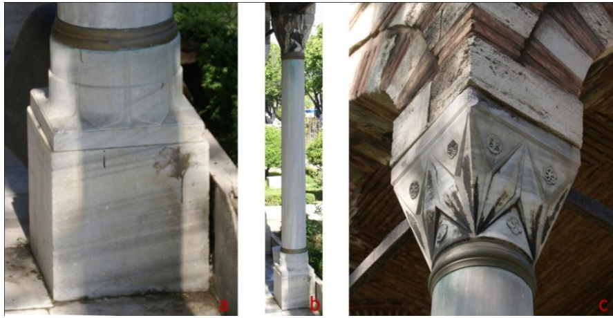
Şekil 4.2.5.2.9a - 4.2.5.2.9b - 4.2.5.2.9c: Revaklı erkek soğukluk girişindeki mermer ters lale ayak, sütun , baklava dilimi başlık ve kaidelerinde oluşan kirlenmeler (K.V.K.K. Arşivi, EK-2[5])
