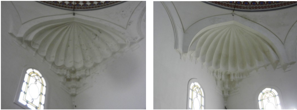
Şekil 4.1.5.3.59a - 4.1.5.3.59b: Tromplarda görülen sıva bütünleme (Deniz Alkan, Temmuz 2014)
