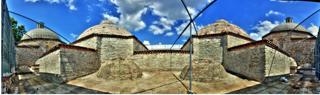
Şekil 4.2.5.1.49: Raspadan sonra ortaya çıkan kubbelerin görünüşü (Tevfik İltir Arşivi EK-2[12])
