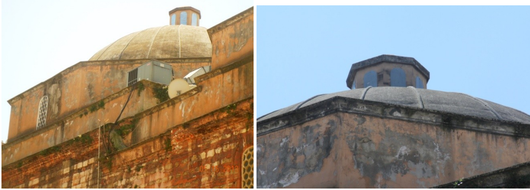
Şekil 4.4.5.3.14: Erkekler kısmı soğukluk üst örtü ve kubbe fener bütünleme (Deniz Alkan, Mart 2015)
