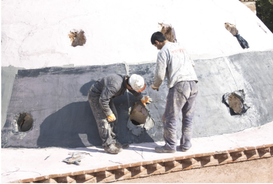
Şekil 4.2.5.1.63: Sıcaklık orta kubbe karbon kumaş ile kuşaklama yapılarak sağlamlaştırılması (Tevfik İlter Arşivi EK-2[12])
