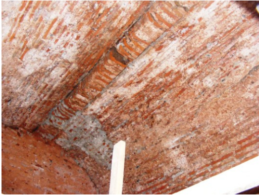
Şekil 4.2.5.1.85a - 4.2.5.1.85b: Sıcak su deposunun tonozunda oluşan çatlaklar (Tevfik İlder Arşivi EK-2[12])
