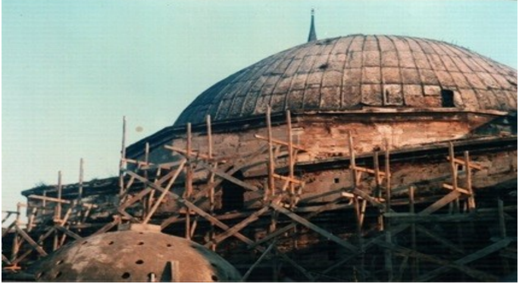
Şekil 4.3.5.3.23: Soğukluk kubbelerinde temizlik ve bütünleme çalışmaları (K.V.K.K. Arşivi, EK-3[4])
