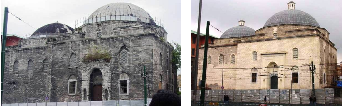
Şekil 4.1.5.3.9a - 4.1.5.3.9b: Güney cephesi taş cidarının plastik onarım ve taşlarının yenilenmesi ile bütünlenmesi (R. A. Arşivi)
