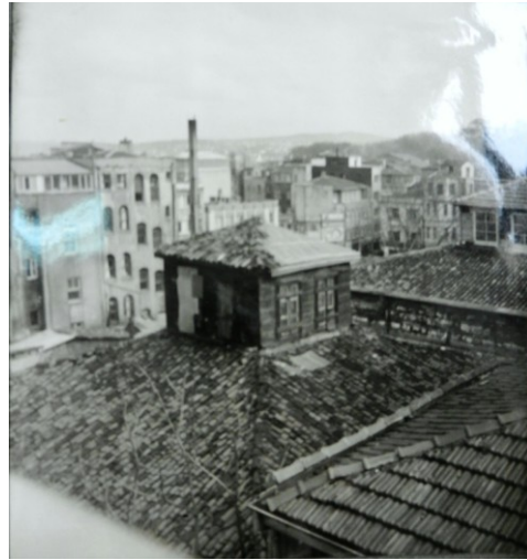
Şekil 4.4.5.2.5: Yok olan soğukluk kubbeleri yerine yapılan ahşap fenerli, kiremit çatılar (K.V.K.K. Arşivi, EK-4[1])
