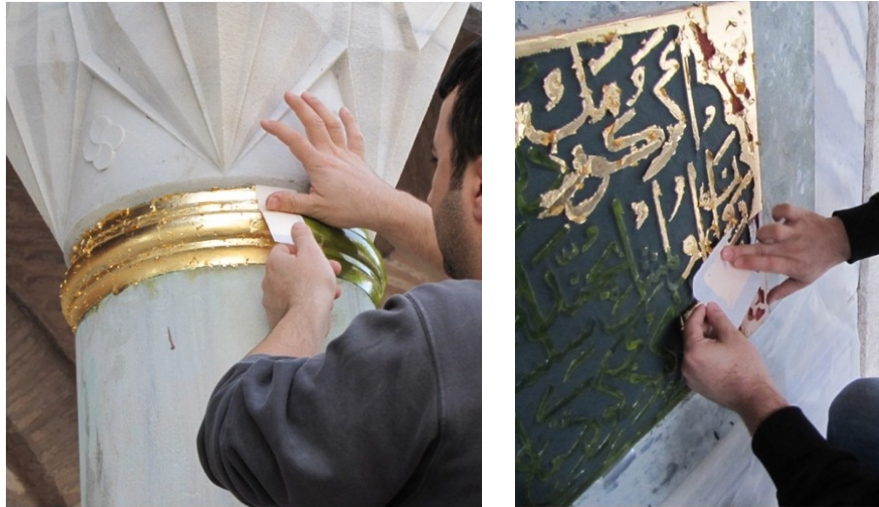
Şekil 4.2.5.3.21: Revaklı girişin mermer sütunlarında altın varak bütünlemesi
