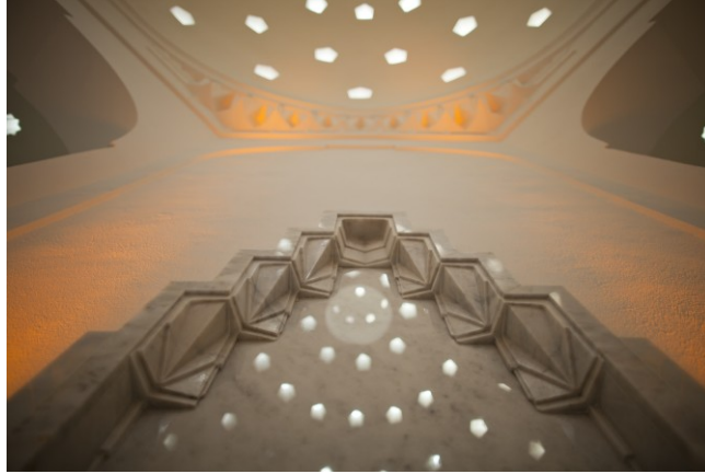
Şekil 4.2.5.3.121: Kadınlar sıcaklık bölümü kubbesi mukarnasları ve mermer ile yapılan halvet sövesi bütünlemesi(Tevfik İltter Arşivi EK-2[12])
