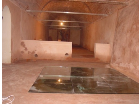
Şekil 4.1.5.1.35: Su deposunda tonoz duvarlarına çelik gergiler ile sağlamlaştırma yapılması (R. A. Arşivi)
