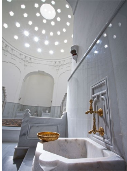
Şekil 4.2.5.3.55: Erkekler kısmı sıcaklık bölümünde duvarlara döşenen mermerlerin bittiği kottan itibaren iç sıvalar horasan sıva ile bütünleme yapılmıştır [6]
