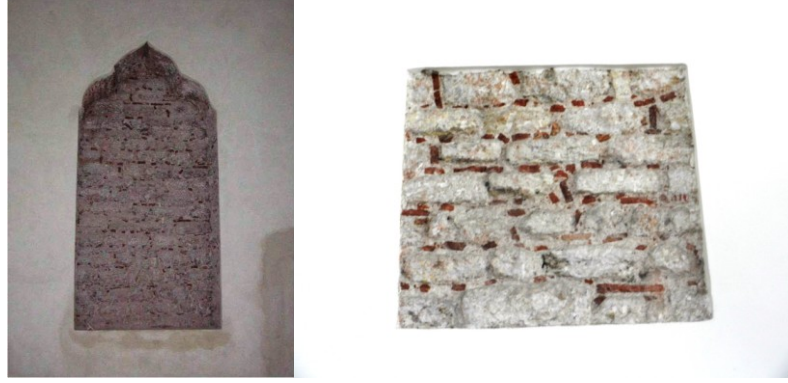
Şekil 4.1.5.3.14a - 4.1.5.3.14b: Orijinal duvar dokusunu belirtme
