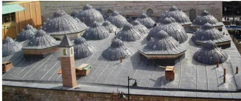
Şekil 4.1.5.3.41: Tüm kubbelerin kurşun kaplanarak bütünlenmesi (R. A. Arşivi)
