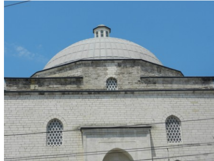
Şekil 4.1.5.3.25a - 4.1.5.3.25b: Kubbe fenerinin restitüsyona dayalı olarak yeniden yapılması (R. A. Arşivi)
