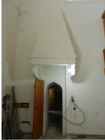
Şekil 4.1.5.3.50a - 4.1.5.3.50b: Ilıklığa giden kapının üstündeki davlumbaz ve tüteği (Deniz Alkan, Temmuz 2014)
