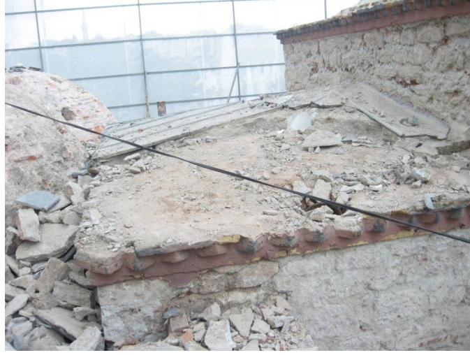
Şekil 4.2.5.2.36: Kurşun taklidi sıva ile kaplı sıcaklık eyvan tonoz üst örtüsünün raspalanarak temizlenmesi (Tevfik İlter Arşivi EK-2[12])
