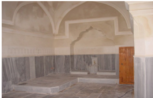
Şekil 4.1.5.3.17: Duvar mermerlerinin tamamlanması (R. A. Arşivi)
