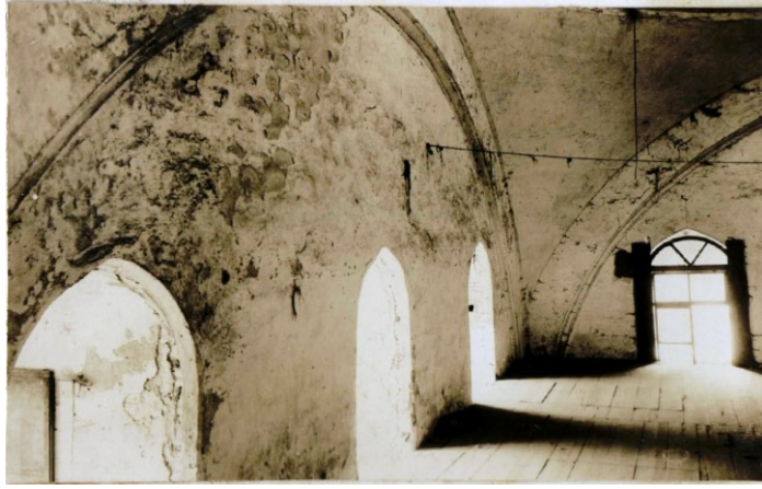
Şekil 4.1.3.2: Kadınlar kısmı soğukluk bölümüne eklenen ahşap katlar (Encümen Arşivleri,1937)
