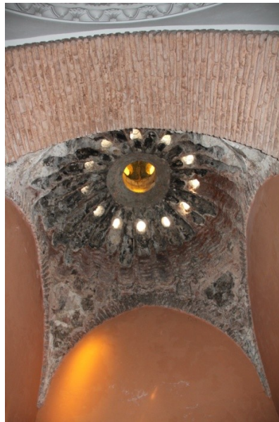
Şekil 4.3.5.3.62: Erkekler sıcaklık eyvan kubbesindeki bezeme bütünleme (Deniz Alkan, Nisan 2015)
