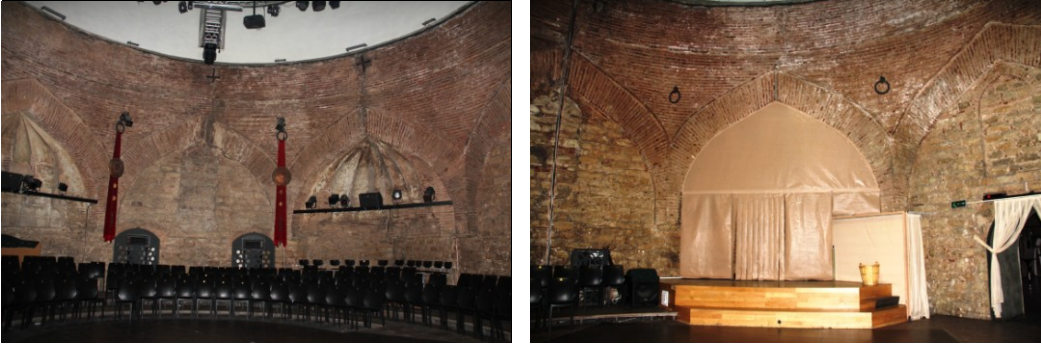
Şekil 4.4.5.3.11: Erkekler soğukluk bölümü duvarlarında sıva raspası sonrası derz bütünleme(Deniz Alkan, Mart 2015)
