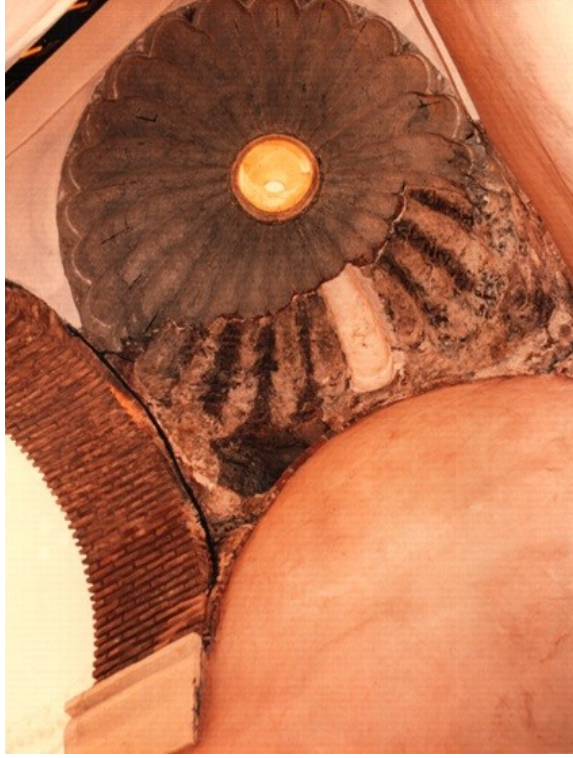
Şekil 4.3.5.3.35: Erkekler sıcaklıkta eyvan kubbesi bütünlenme (K.V.K.K. Arşivi, EK-3[4])
