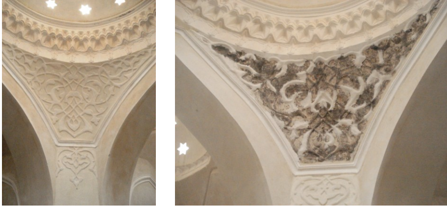
Şekil 4.1.5.3.67a - 4.1.5.3.67b: Pandantiflerde rumi ve palmet motifli malakârinin açıkta bırakılarak, sıva bütünlemesi yapılması (V.B.M. Arşivi – EK-1 [1])
