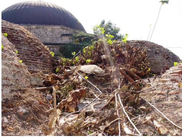
Şekil 4.1.5.2.24a - 4.1.5.2.24b: Kubbelerdeki ağaç köklerinin sökülmesi (R. A. Arşivi)
