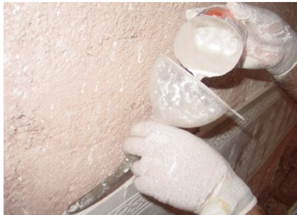
řekil 4.1.5.1.58: Bezeme saęlamlařtırmada enjeksiyon uygulaması (Eyüpgiller, Kemal Kutgün, 2010)
