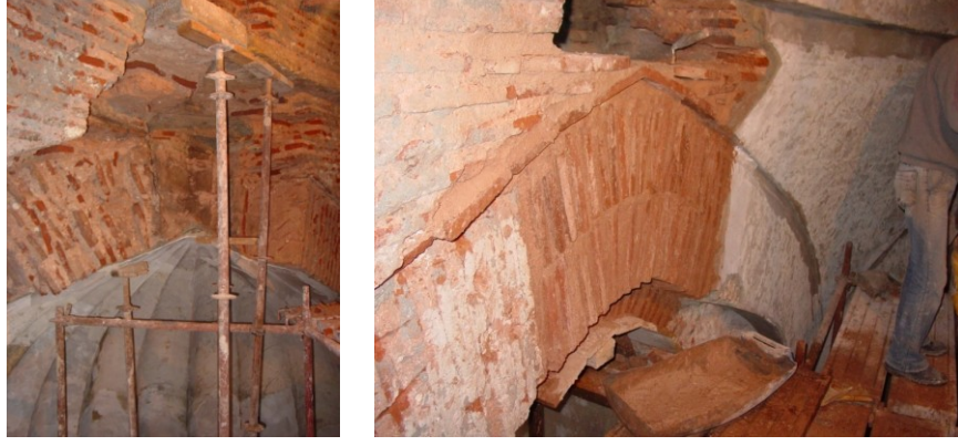
Şekil 4.1.5.1.52a - 4.1.5.1.52b: Tahkimat iskelesinin kurulması, kemerin örülmesi ve tuğla dikiş uygulaması (R. A. Arşivi)
