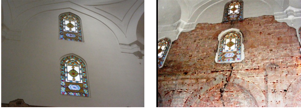
Şekil 4.2.5.1.10: Erkek soğukluk Kuzeybatı cephesi iç kemer raspa öncesi Şekil 4.2.5.1.11: Erkek soğukluk Kuzeybatı cephesi iç kemer çatlağı raspa sonrası ortaya çıkan çatlak (Tevfik İlder Arşivi EK-2[12])
