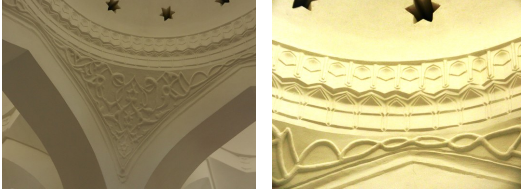
Şekil 4.1.5.3.73a - 4.1.5.3.73b: Gökbeşik üzerindeki kubbenin pandatiflerindeki rumi bezemelerin tamamlanması (Deniz Alkan, Temmuz 2014)
