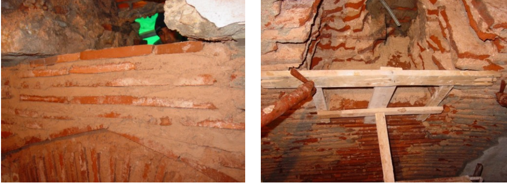
Şekil 4.1.5.1.54a - 4.1.5.1.54b: Kubbelerin iç yüzeylerindeki hasarların tuğla dikiş ile sağlanması (R. A. Arşivi)
