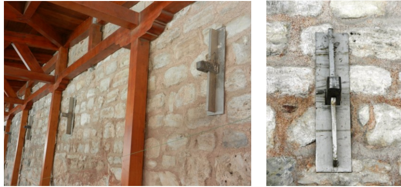
Şekil 4.1.5.1.36a – 4.1.5.1. 36b: Su deposunun dış cephe duvarının dışına çıkan çelik gergiler, plakalar ve kılıçlar yardımı ile ankraj yapılarak sağlamlaştırılması (Deniz Alkan, Temmuz 2014)
