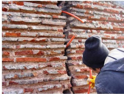
Şekil 4.1.5.1.40: Çatlaklar enjeksiyon harcı için hortumların yerleştirilmesi (R. A. Arşivi)
