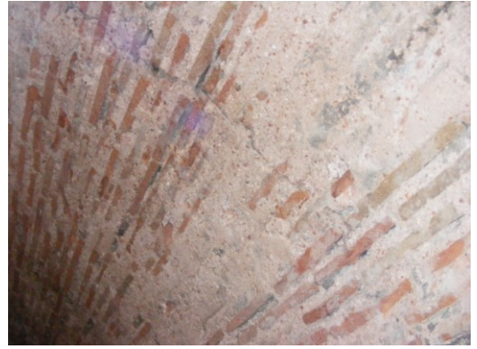
Şekil 4.2.5.1.84a - 4.2.5.1.84b: Sıcak su deposunun tonozunda oluşan çatlaklar (Tevfik İlder Arşivi EK-2[12])
