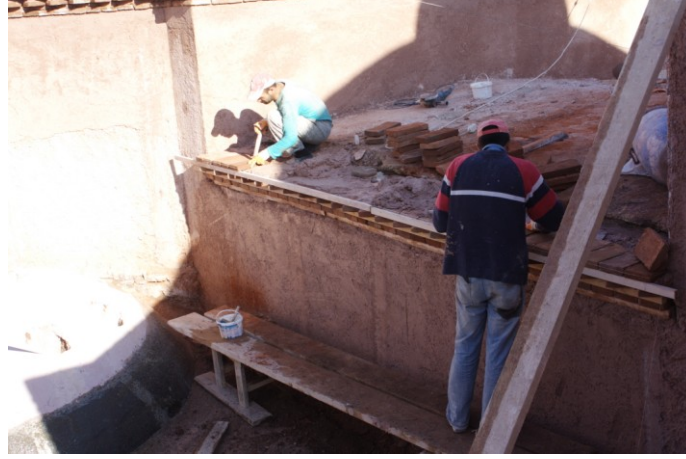
Şekil 4.2.5.3.53: Kirpi saçakların özgün olan pişmiş tuğla ile yeniden örülmesi (Tevfik İlter Arşivi EK-2[12])
