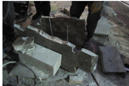
Şekil 4.2.5.3.5a - 4.2.5.3.5b - 4.2.5.3.5c: Revaklı erkekler girişinin dışındaki taşların bütünleme yapılması [8]
