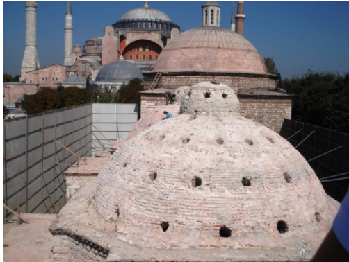
Şekil 4.2.5.2.33: Kadınlar ve erkekler sıcaklık orta kubbelerinin sıva raspaası yapılarak temizlenmesi (V.B.M.Arşivi EK-2[8])
