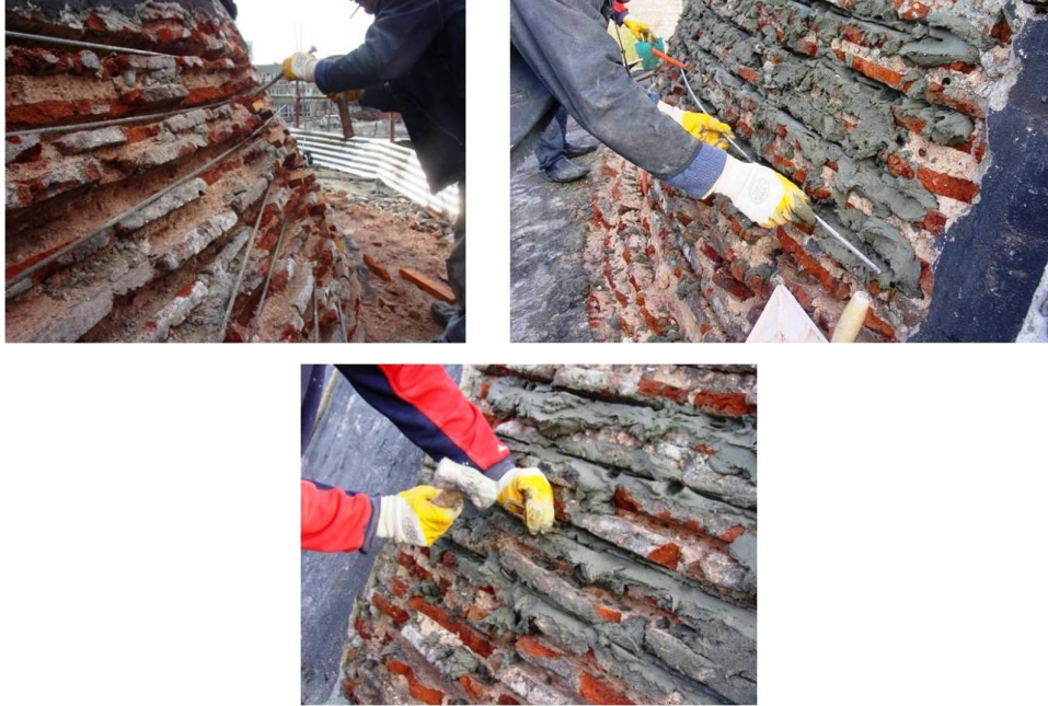
Şekil 4.1.5.1.39a – 4.1.5.1. 39b – 4.1.5.1. 39c: Karbon çubukların epoksi harçla derz aralarına montajının yapılması (R. A. Arşivi)
