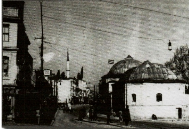
Şekil 3.2.8: Beşiktaş'ta 1957 yılında yol yapımı için sağlam iken yıktırılan Mimar Sinan eseri, Köprü (Sinan Paşa) Hamamı (Aybay, Aydın, s.36)
