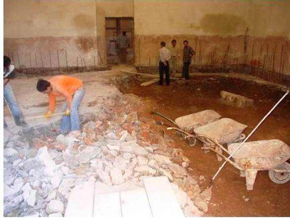
Şekil 4.1.5.2.4: Döşemede ki beton dolguların kırılarak temizlenmesi (R. A. Arşivi)
