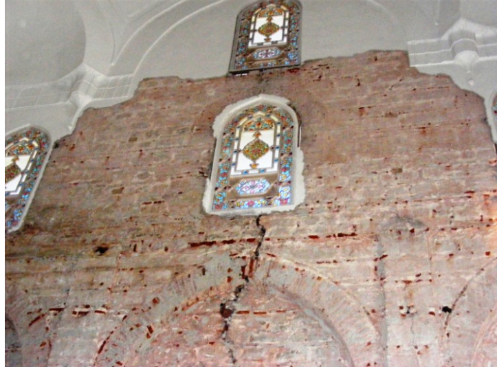
Şekil 4.2.5.2.12: Soğukluk duvarlarında çimento esaslı sıvanın raspa yapılması (Tevfik İlater Arşivi EK-2[12])
