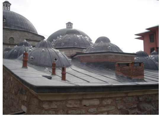
Şekil 4.1.5.4.9: Yeni işlev gereği su deposuna yapılan hava bacası (R. A. Arşivi)
