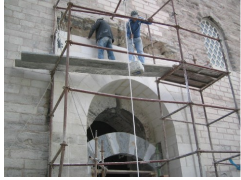
Şekil 4.1.5.3.52a - 4.1.5.3.52b: Batı cephesindeki taç kapının bütünleme çalışmaları (R. A. Arşivi)
