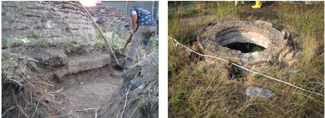
Şekil 4.1.5.2.21a - 4.1.5.2.21b: Kubbelerdeki toprak dolgu ve bitkilerin temizlenmesi (R. A. Arşivi)
