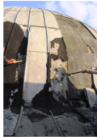
Şekil 4.1.5.2.17a - 4.1.5.2.17b: Kubbedeki muhdes kaplamaların temizlenmesi (R. A. Arşivi)
