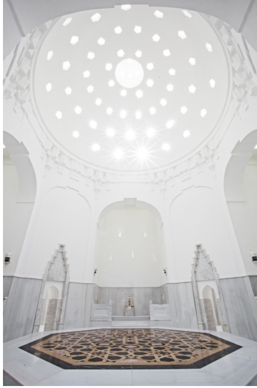
Şekil 4.2.5.3.71: Erkekler kısmı sıcaklık bölümünde göbek taşının üstündeki merkez kubbede sıva bütünlmesi (Tevfik İlder Arşivi EK-2[12])
