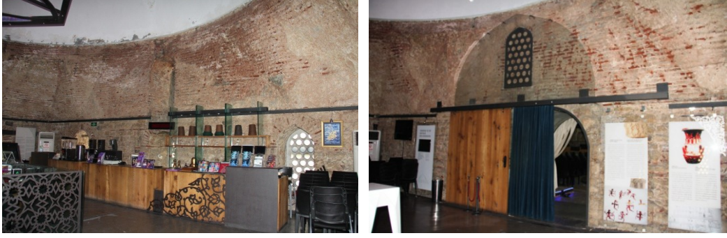
Şekil 4.4.5.3.10: Kadınlar soğukluk duvar derzlerini horasan harcı ile bütünleme (Deniz Alkan, Mart 2015)
