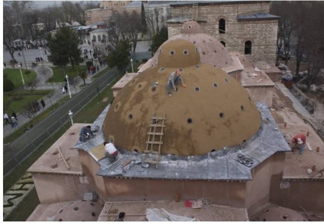
Şekil 4.2.5.3.66: Kubbelerin üstüne kaplanan kurşun kaplama ve altına geleneksel yöntemle yapılan çamurun sıvanması (Tevfik İlter Arşivi EK-2[12])
