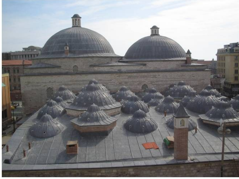
Şekil 4.1.5.3.37: Kurşun kaplamaları yapılmış kubbeler (R. A. Arşivi)
