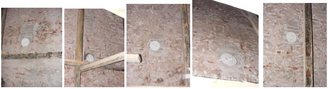
Şekil 4.2.5.2.16: Sıva rasparlarından sonra ılıkık ve sıcakık duvarlarında bulunan tütek kapakları (Tevfik İlter Arşivi EK-2[12])
