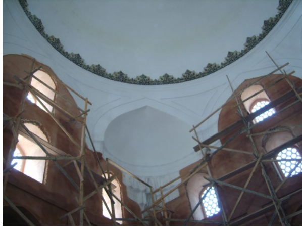
Şekil 4.2.5.3.42: Erkekler kısmı soğukluk bölümünde yapılan iç sıva bütünlemesi [7]
