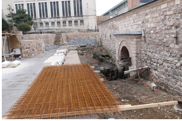
Şekil 4.1.5.5.1: Külhan kısmına yapılan yiyecek-içecek yapısının döşemesinin yapılması [2]
