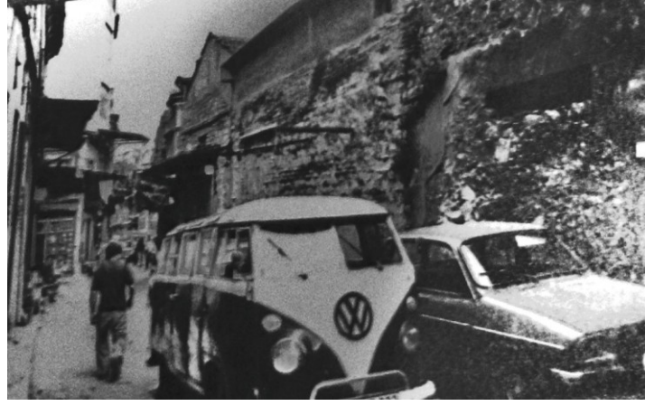
Şekil 4.3.5.3.9: Kantarcılar Sokak odunluk, külhan duvarlarının güneybatı cephesi (K.V.K.K. Arşivi, EK-3[4])
