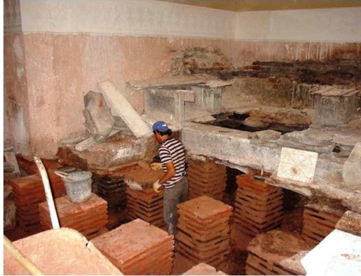
Şekil 4.1.5.1.14: Hipokast ayaklarının mevcut olanlarının sağlamlaştırılması (R. A. Arşivi)
