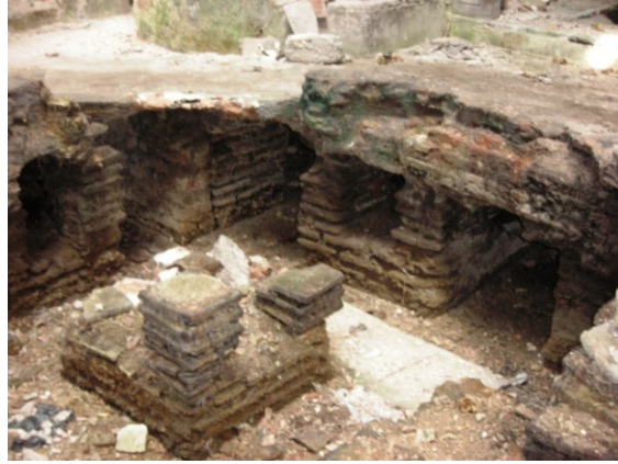
Şekil 4.1.5.1.16: Mevcut hipokast ayaklarında sağlamlaştırılan tuğla ve derzler (V.B.M. Arşivi – EK-1 [1])
