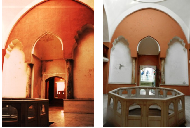
Şekil 4.3.5.3.13: Erkekler ılıklık duvarlarının mevcut niş ve soğukluk geçiş kemeri bütünleme (Deniz Alkan, Mart 2014)
