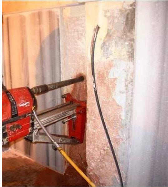
Şekil 4.1.5.1.25: Duvarların iç ve dışta açılan karot delgiler (R. A. Arşivi)
