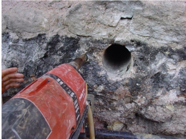
Şekil 4.1.5.1.9: Güney cephesinde yapılan karot ile delgi açılması (R. A. Arşivi)
