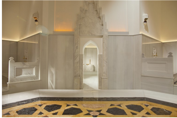
Şekil 4.2.5.3.112: Yeniden yapılan sıcaklık eyvan yıkanma mermer seki korkulukları (Tevfik İlter Arşivi EK-2[12])
