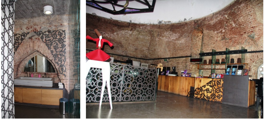
Şekil 4.4.5.4.5a - 4.4.5.4.5b : Kemer içine konan lavabo ve Sergi aydınlatması için duvarlarda oluşturulan çelik kasnak (Deniz Alkan, Mart 2015)
