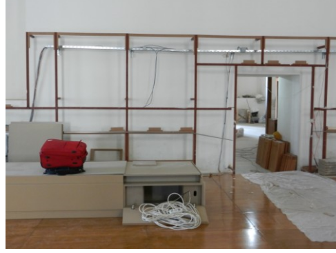
Şekil 4.1.5.4.4: Soğukluklar arasındaki kapı ve duvar panelleri için yapılan konstrüksiyon (Deniz Alkan, Temmuz 2014)
