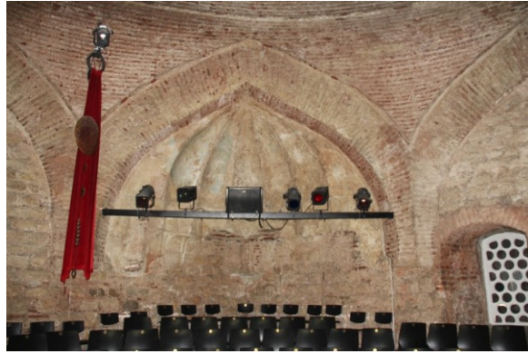
Şekil 4.4.5.3.32a - 4.4.5.3.32b : Erkekler kısmı soğukluk kubbe geçiş öğeleri tromplar (Deniz Alkan, Mart 2015)
