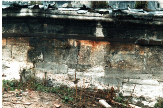
Şekil 4.3.5.3.1: Soğukluk kubbesi eteklerinde bozulan taş söveler (K.V.K.K. Arşivi, EK-3[4])
