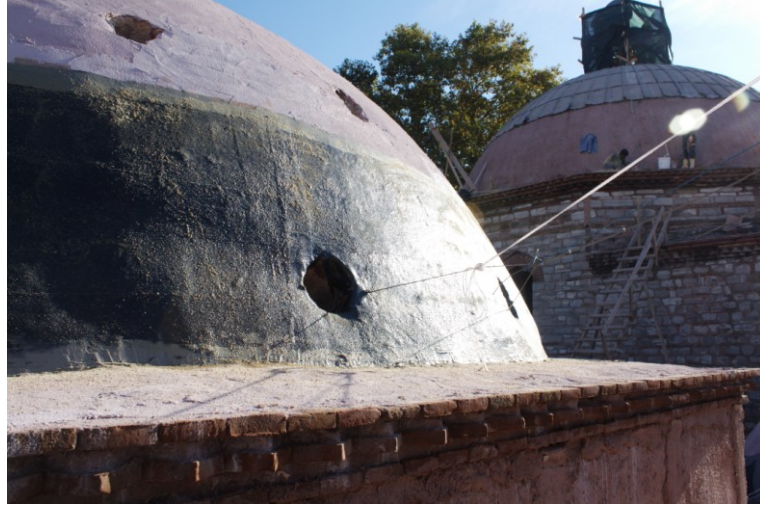
Şekil 4.2.5.1.82: Kadınlar sıcaklık orta kubbe enjeksiyon ve karbon kumaş ile kuşaklama yapılarak sağlamlaştırılması ( Tevfik İlder Arşivi EK-2[12])
