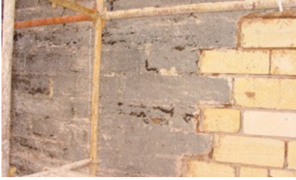
Şekil 4.1.5.3.18: Yangın geçirmiş duvarlarda taşın yenilerek bütünlenmesi (Eyüpgiller, Kemal Kutgün, 2010)
