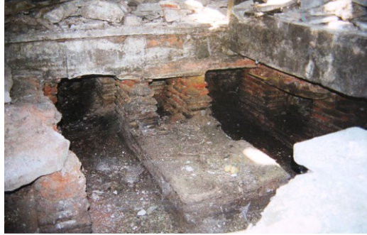
Şekil 4.1.5.1.13: Çöken ılıklık döşeme altındaki hipokast ayaklarının restorasyondan önceki durumu (K.V.K.K. Arşivi –EK-1 [13])
