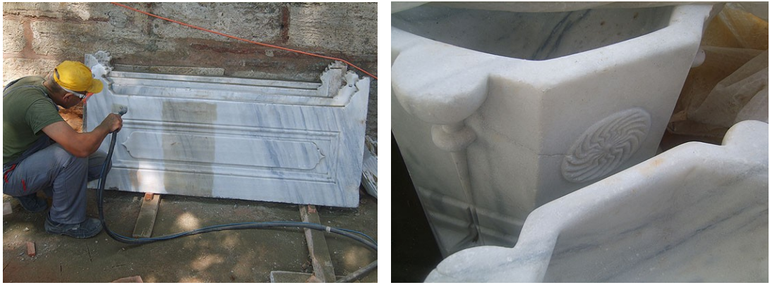
Şekil 4.2.5.2.55a - 4.2.5.2.55b.: Mermer seki korkuluk ve kurnalar, düşük basınçla rotasyon püskürtme tekniği ile temizlenmesi [7]
