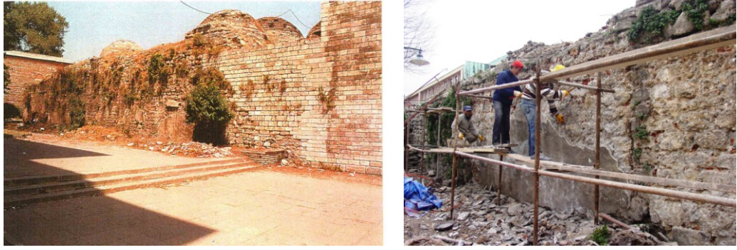
Şekil 4.1.5.2.10a – 4.1.5.2.10b: Batı cephesindeki bitki temizliği ve sıva raspası yapılması (R. A. Arşivi)
