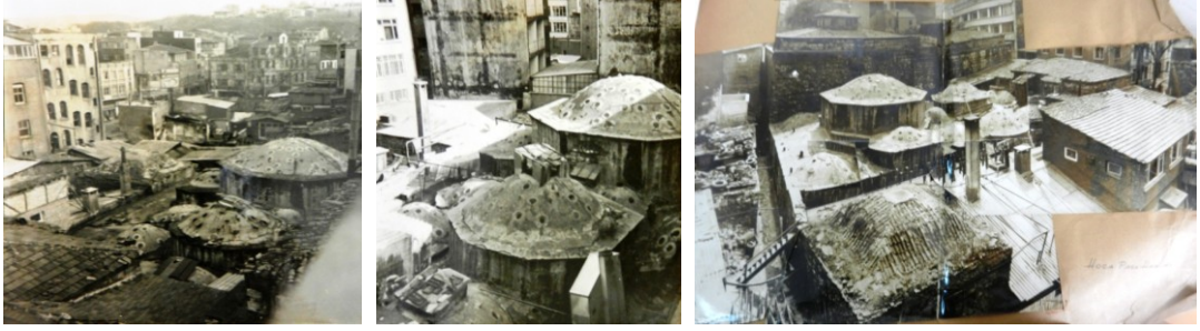
Şekil 4.4.5.3.15: Kadınlar ve erkekler ılıklik ve sıcaklik kubbelerinin muhdes üst örtü kaplamaları (K.V.K.K. Arşivi, EK-4[1])
