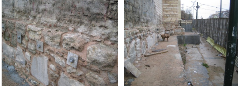
Şekil 4.1.5.1.10a – 4.1.5.1.10b: Güney cephesinde temel duvarlarının içten ve dıştan bağlantı çubukları ile yapılan ankraj uygulaması (R. A. Arşivi)
