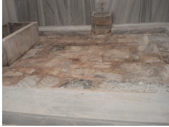
Şekil 4.1.5.3.6: Eyvanlardaki mermer döşemelerin bütünleme ile tamamlanması (V.B.M. Arşivi – EK-1 [1])
