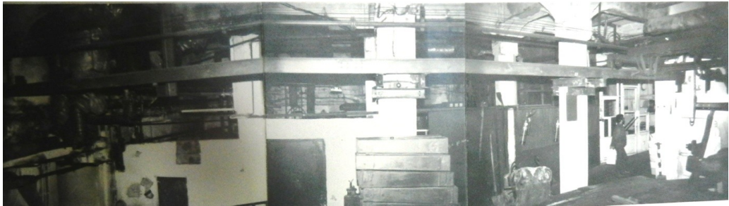
Şekil 4.3.5.2.1: Erkekler soğukluk içine yapılan betonarme katların kolonları ve soğuk depo (K.V.K.K. Arşivi, EK-3[4])
