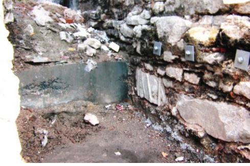
Şekil 4.1.5.1.8a – 4.1.5.1.8b: Hamamın batı cephesindeki güçlendirme çalışmasından görünüş (K.V.K.K. Arşivi - EK-1 [21])
