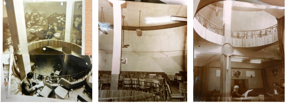
Şekil 4.4.5.2.1: Kahvehane olarak kullanılan kadınlar kısmı soğukluk bölümüne yapılan betonarme iki kat (K.V.K.K. Arşivi, EK-4[1])
