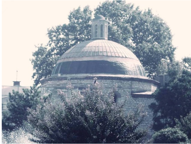
Şekil 4.2.5.1.71: Soğukluk kubbeleri enjeksiyon ve karbon kumaş ile kuşaklama yapılarak sağlamlaştırılma yapılması (V.B.M. Arşivi EK-2[8])
