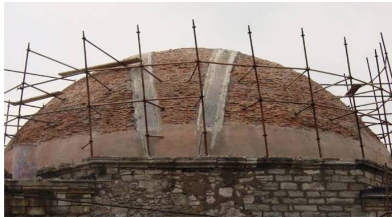
Şekil 4.1.5.1.44: Soğukluk kubbesinin karbon elyaf kanaviçe ile kuşaklama yapılarak güçlendirilmesi (R. A. Arşivi)
