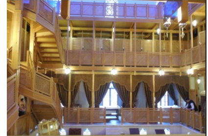
Şekil 4.2.5.3.80: Erkekler soyunmalıkta restitüsyona dayalı yeniden yapılan şirvan ve merdivenler [5]
