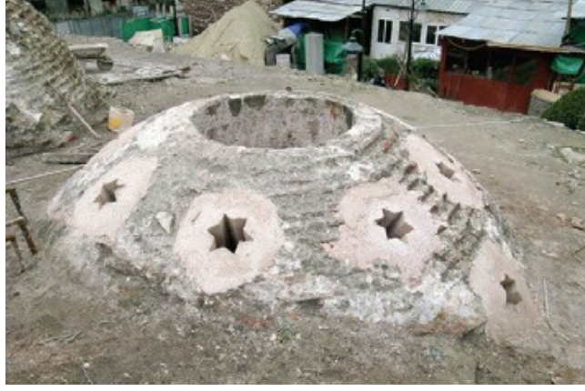
Şekil 4.1.5.3.35: Kubbelerdeki yıldız figözü bütünlemesi (Eyüpgiller, Kemal Kutgün, 2010)
