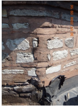
Şekil 4.2.5.2.22: Duvarda taş derzleri ( Tevfik İlter Arşivi EK-2[12])
