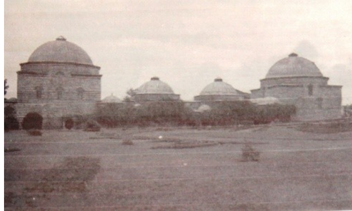
Şekil 4.2.5.3.78: 1942 yılındaki kubbelerin üstündeki kapalı fenerler (V.B.M. Arşivi EK-2[8])
