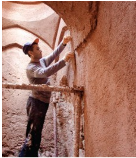
Şekil 4.1.5.3.15: Kaba Horasan Sıva Yapılması Eyüpgiller, Kemal Kutgün, (2010)
