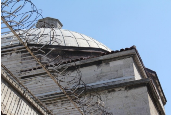
Şekil 4.3.5.1.3: Erkekler soğukluk kuzeydoğu cephesinde kubbe çemberleme (Deniz Alkan, Nisan 2015)
