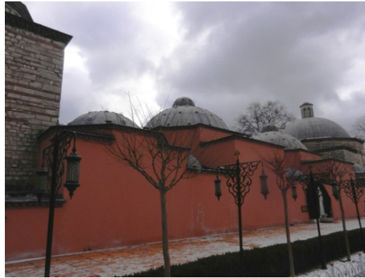
Şekil 4.2.5.3.48: Kuzeybatı cephesi erkek ılıklık-sıcaklık bölümü duvarı (Deniz Alkan, Ocak 2015)
