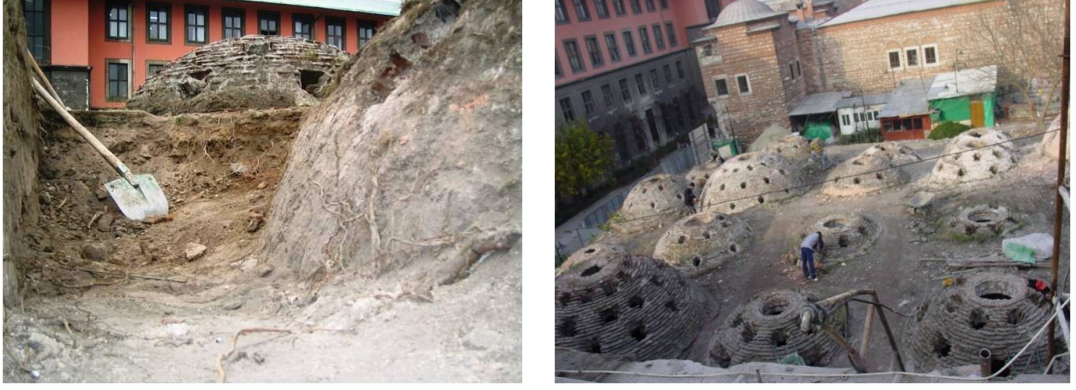
Şekil 4.1.5.2.22a - 4.1.5.2.22b: Kubbelerdeki toprak dolguların temizlenmesi (R. A. Arşivi)
