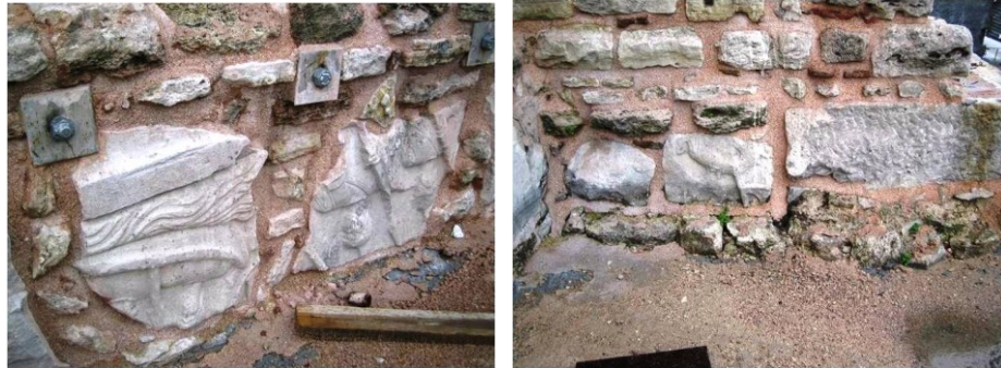
Şekil 4.1.5.1.11a – 4.1.5.1.11b: Temel duvarlarında yapılan ankraj uygulaması (R. A. Arşivi)
