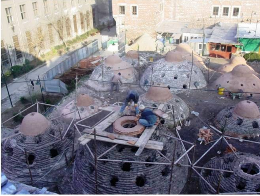
Şekil 4.1.5.3.38a - 4.1.5.3.38b: Bütünlemesi yapılan kubbe fenerleri (R. A. Arşivi)
