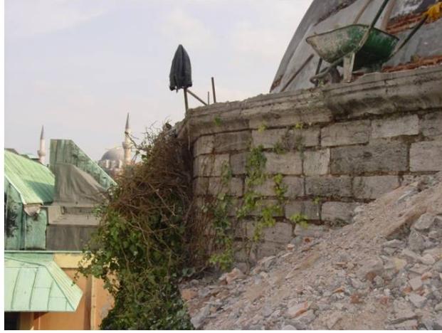
Şekil 4.1.5.2.16: Kubbe kasnaklarında görülen bitkilerin temizlenmesi (R. A. Arşivi)
