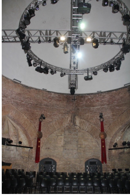
Şekil 4.4.5.4.6: Sahne aydınlatması için tavana asılan dairesel çerçeve (Deniz Alkan, Mart 2015)
