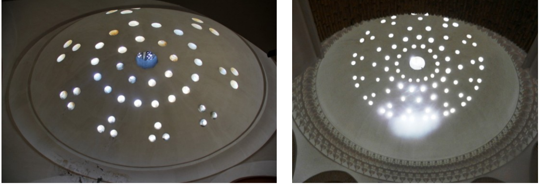
Şekil 4.3.5.3.31: Erkekler kısmı ılıklık kubbesi rekonstrüksiyon ile bütünleme (Deniz Alkan, Nisan 2015)
