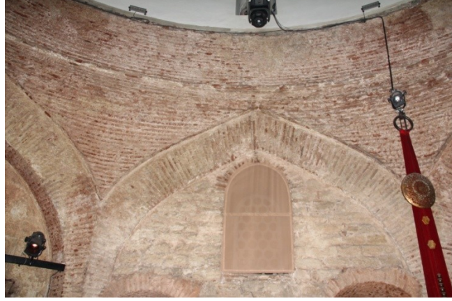
Şekil 4.4.5.2.4: Soğukluk duvarlarının iç sıva raspası ile temizlenmesi (Deniz Alkan, Mart 2015)
