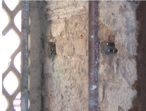
Şekil 4.1.5.1.24a: : Pencere nişlerinde hatıl boşluklarına çelik donatı yerleştirilmesi (R. A. Arşivi)
