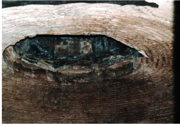
Şekil 4.3.5.2.14: Soğukluk kubbesinde aydınlatma fener boşluğu (K.V.K.K. Arşivi, EK-3[4])
