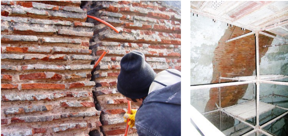
Şekil 4.1.5.1.55: Kubbe dış yüzeyindeki çatlaklara enjeksiyon hortumlarının yerleştirilmesi (R. A. Arşivi)
