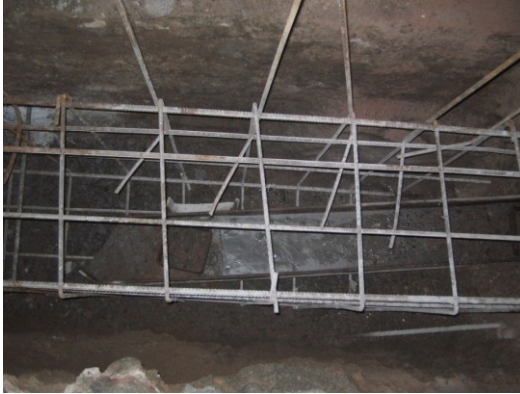
Şekil 4.1.5.1.5: Zemin takviyesi güçlendirme betonu içerisinde, çatlak aksı boyunca kullanılan çelikler (R. A. Arşivi)
