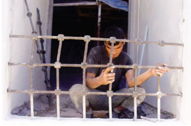
Şekil 4.1.5.3.46: Lokma demir parmaklıkların montajı (Eyüpgiller, Kemal Kutgün, 2010)
