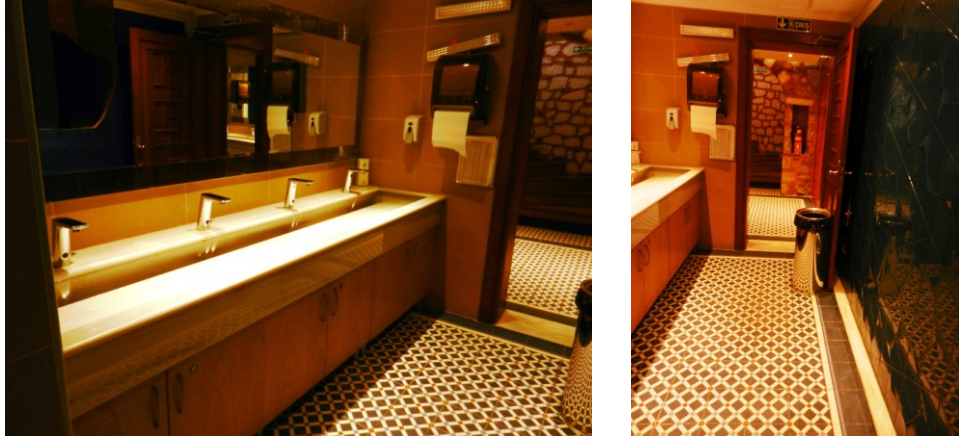
Şekil 4.2.5.4.10: Külhanın önünde zemin kotunun altına yapılan çağdaş tuvalet ve lavabolar (Deniz Alkan, Ocak 2015)
