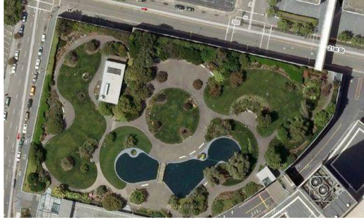
Şekil 2.32. Kaiser İş Merkezi tepeden görünüm [32]
