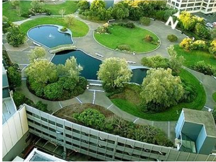
Şekil 2.33. Kaiser İş Merkezi yeşil çatı [32]
