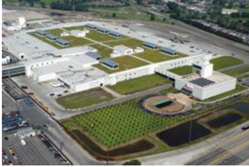
Şekil 2.17. Ford Motor Company River Rouge Plant yeşil çatısı [29]
