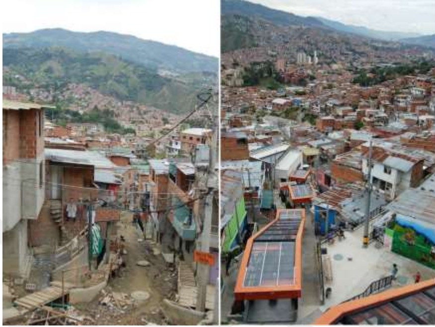
Şekil 4.40 Medellín kenti yürüyen merdiven sistemleri
