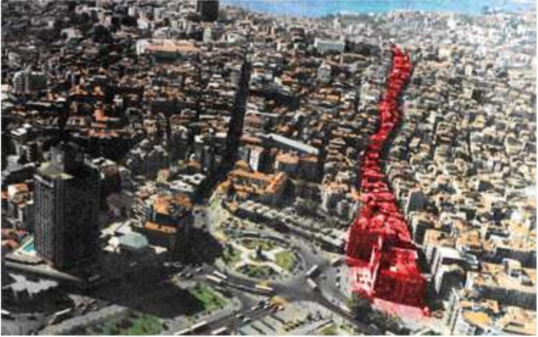
Şekil 4.17 Tarlabası Bulvarı'nı oluşturmak için yıkılan binalar
