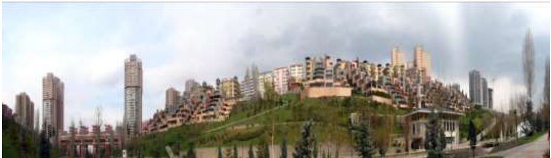
Şekil 4.5 Dikmen Vadisi 3. Etap sonrası
