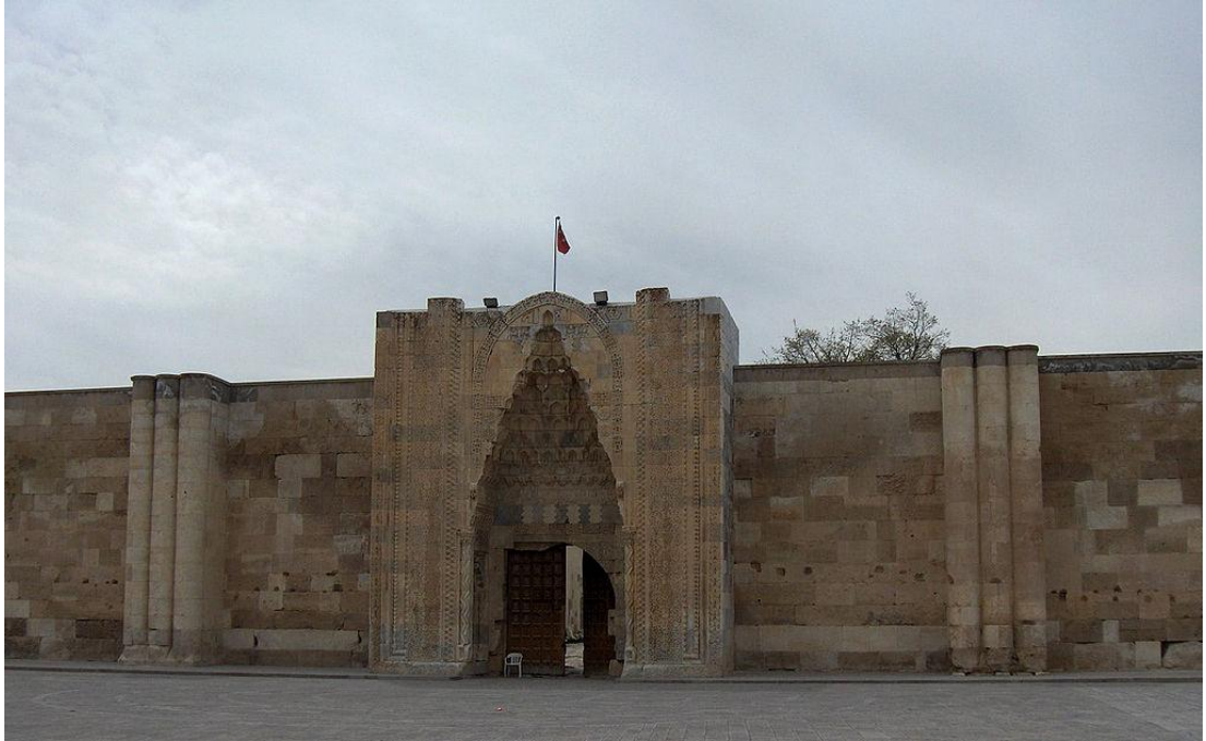
Şekil 2.1. Sultan Han Kervansarayı, Aksaray
