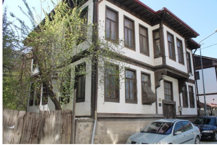
Şekil 3.23- 247 ADA 58 Parselde Bulunan Yapı
