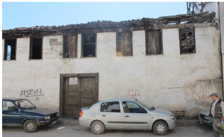
Şekil 3.44- 247 ADA 5 Parselde Bulunan Yapı (Nisan 2017)
