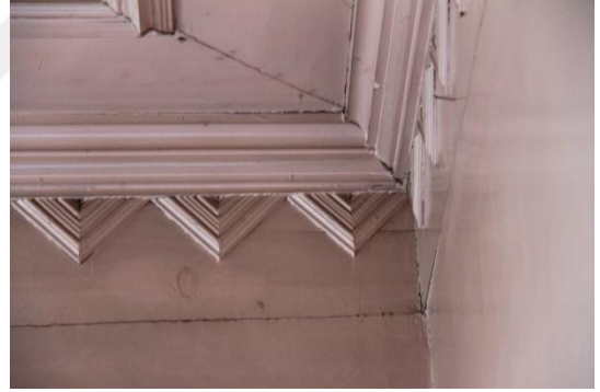
Şekil 4.33- Damlalıklı profilli ahşap kat silmesi
