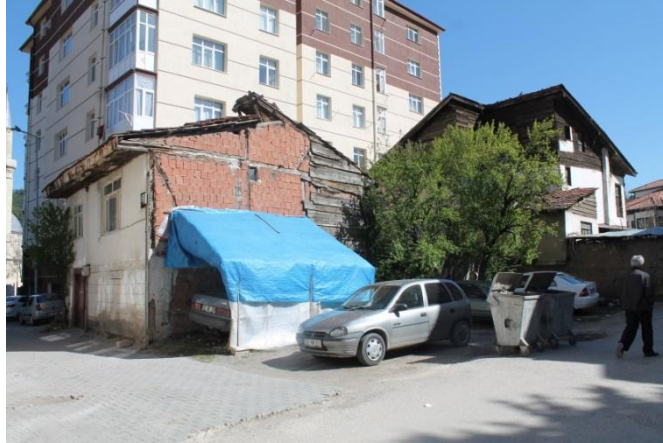
Şekil 3.58- 283 ADA 2 Parselde Bulunan Yapı (Nisan 2017)
