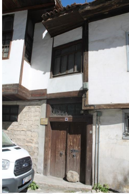
Şekil 3.43- 282 ADA 35 Parselde Bulunan Yapı (Nisan 2017)
