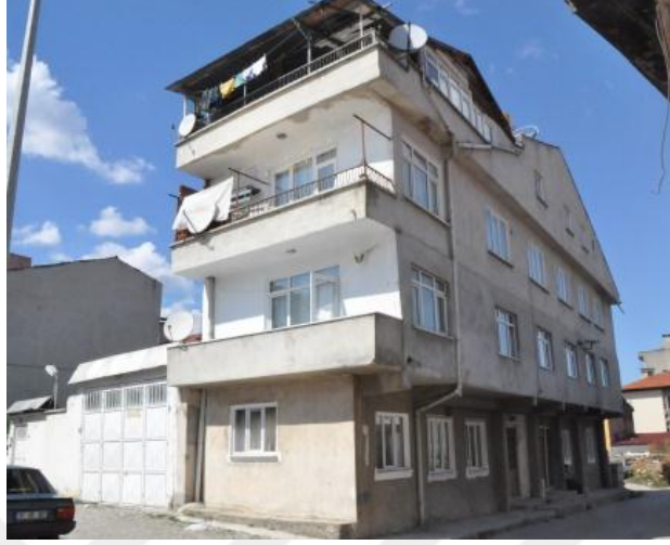
Şekil 3.62- 247 ADA 64 Parselde Bulunan Yapı (Nisan 2017)
