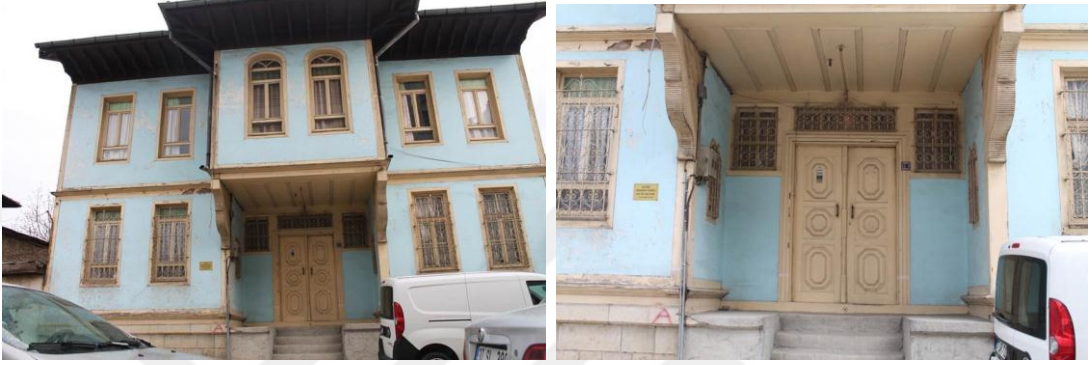
Şekil 3.5- Boyacızade Konağı Ön Cephe ve Selamlık Girişi 2016
