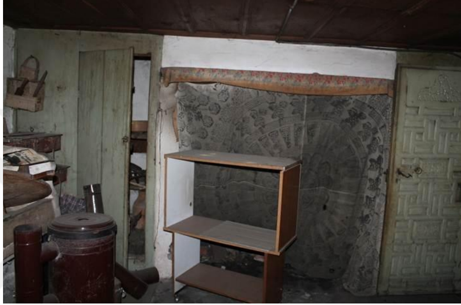
Şekil 4.22- Bodrum katta mutfakta yer alan ocak
