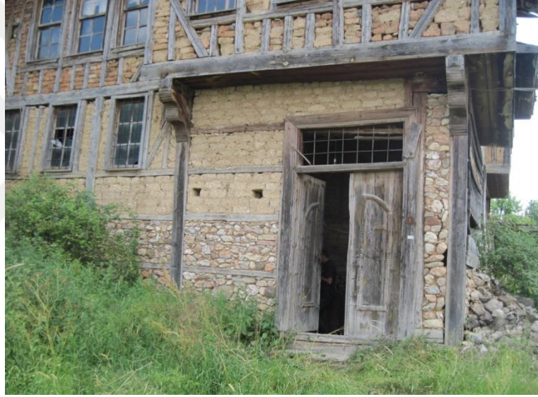
Şekil 2.45-Taş ve Kerpiç Duvar (Melekoğlu Konağı) 2011
