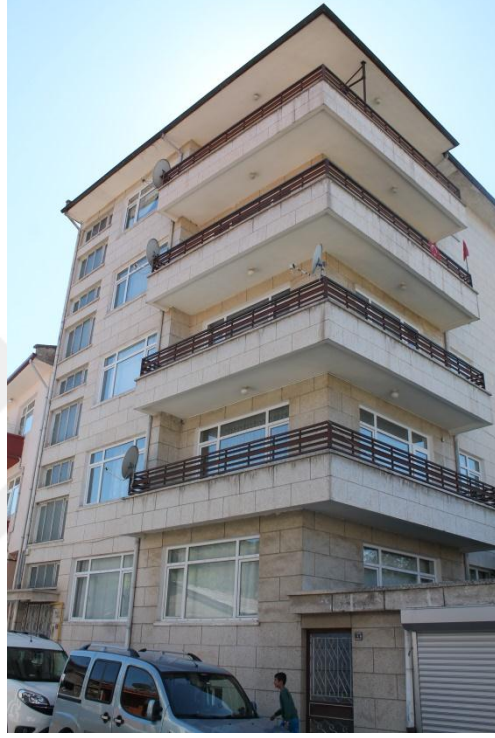
Şekil 3.64- 284 ADA 33 PARSEL de bulunan yapı (Nisan 2017)
