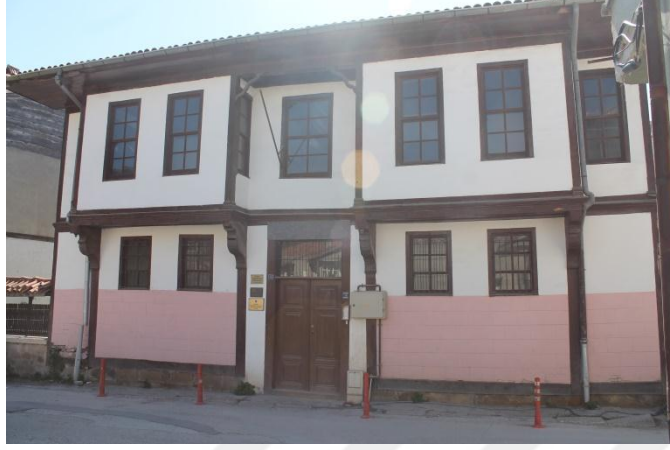
Şekil 3.22- 247 ADA 3 Parselde Bulunan Yapı
