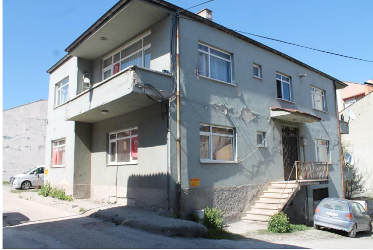
Şekil 3.46- 284 ADA 62 Parselde Bulunan Yapı (Nisan 2017)
