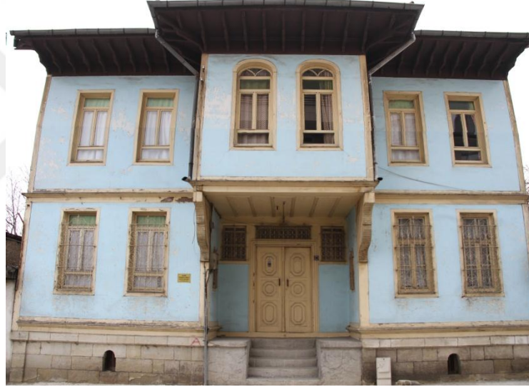
Şekil 4.5- Batı cephesi (Sokak Cephesi)
