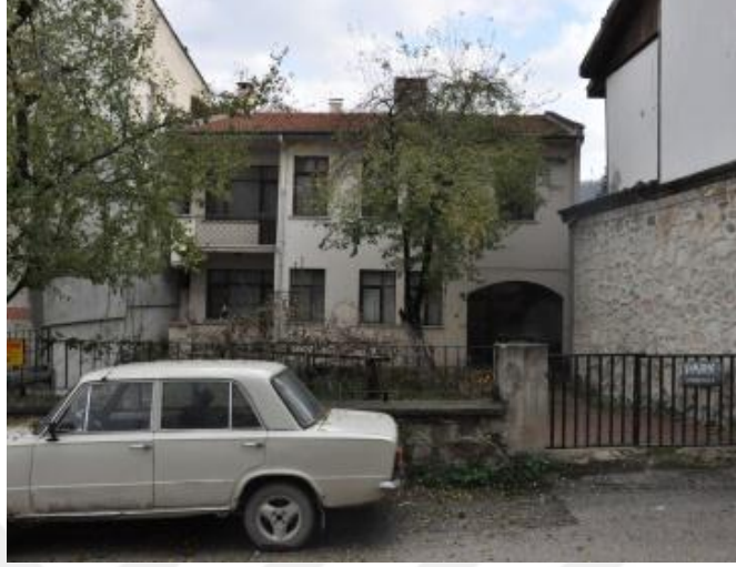
Şekil 3.57- 282 ADA 37 Parselde Bulunan Yapı (Nisan 2017)
