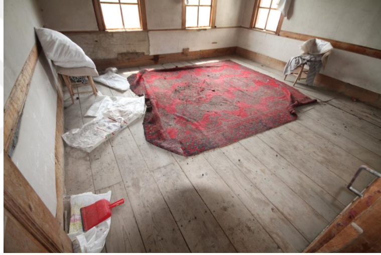
Şekil 2.47- Taban Döşemesi (Ünsürler Konağı) 2013
