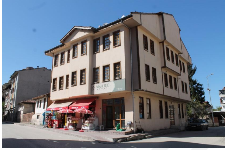
Şekil 3.61- 249 ADA 7 Parselde Bulunan Yapı (Nisan 2017)
