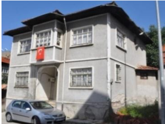
Şekil 3.27- 282 ADA 40 Parselde Bulunan Yapı
