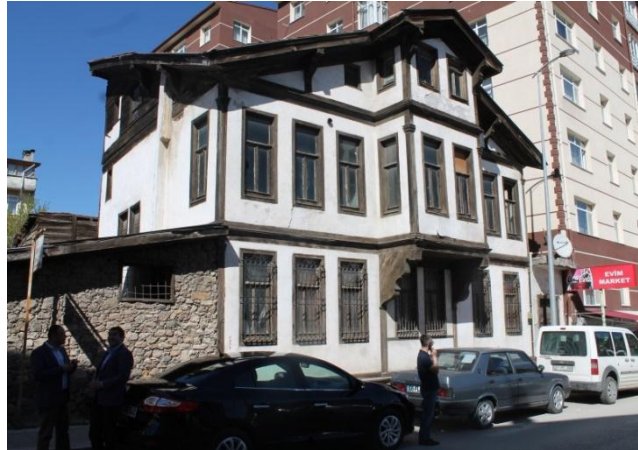
Şekil3.31- 283 ADA 4 Parselde Bulunan Yapı
