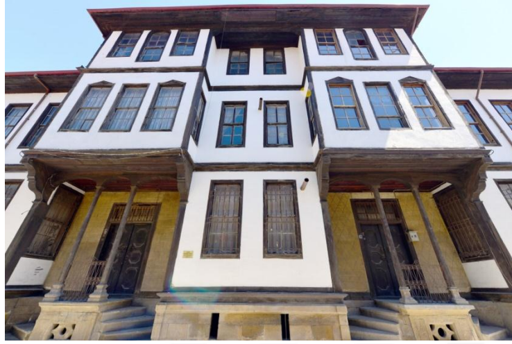
Şekil 3.26- 284 ADA 61 Parselde Bulunan Yapı
