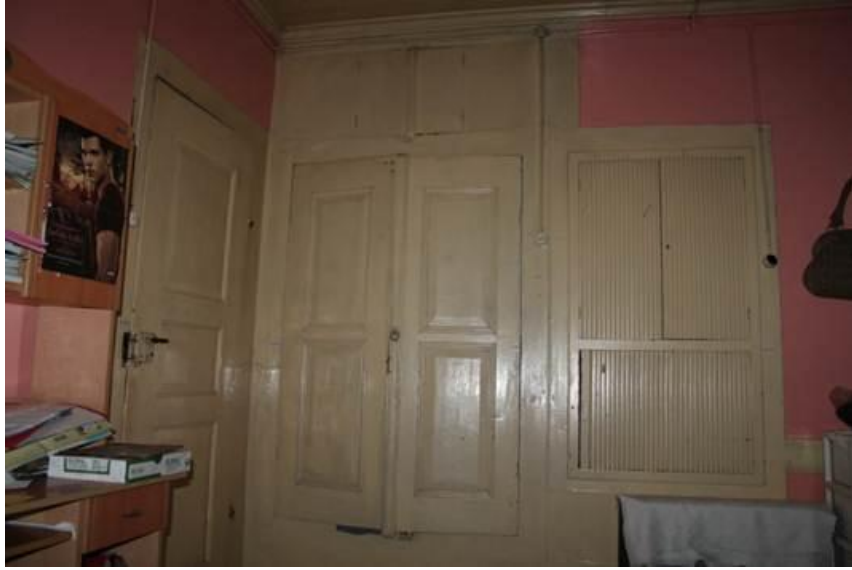
Şekil 4.19- Zemin katta Z10 no.lu odada yer alan dolaplar
