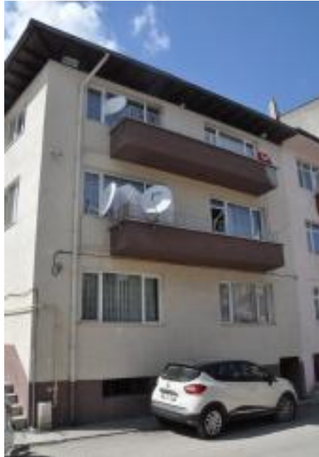
Şekil 3.54- 247 ADA 48 Parselde Bulunan Yapı (Nisan 2017)
