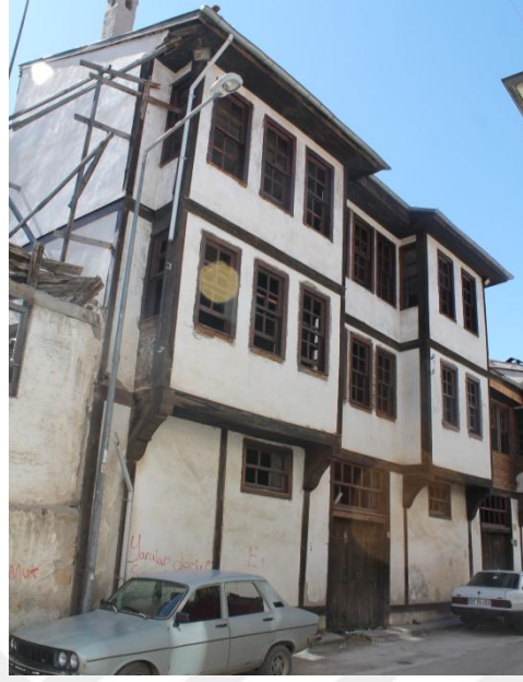
Şekil 3.24- 247 ADA 5 Parselde Bulunan Yapı
