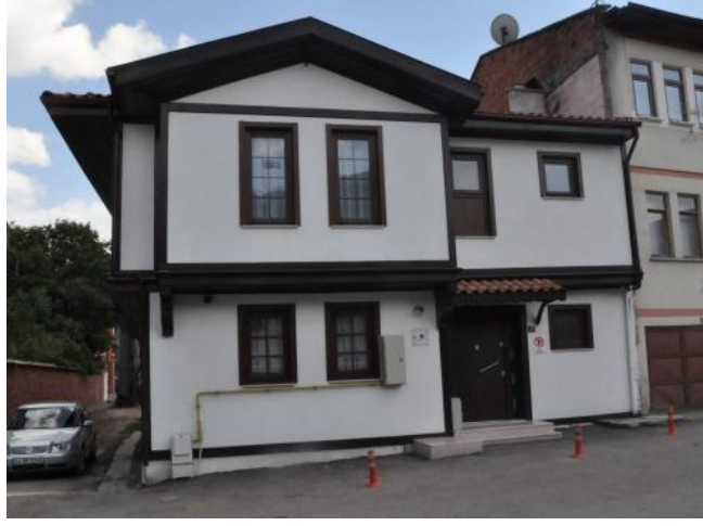
Şekil 3.55- 282 ADA 20 Parselde Bulunan Yapı (Nisan 2017)
