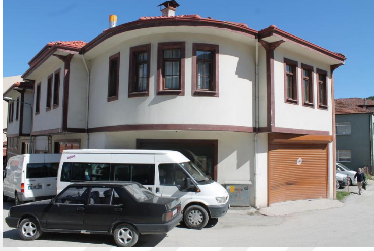
Şekil 3.45- 284 ADA 1 Parselde Bulunan Yapı (Nisan 2017)
