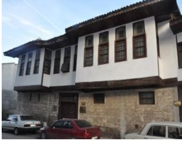
Şekil 3.30- 282 ADA 36 Parselde Bulunan Yapı
