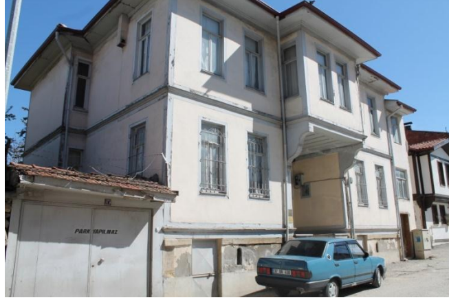
Şekil 3.28- 282 ADA 19 Parselde Bulunan Yapı
