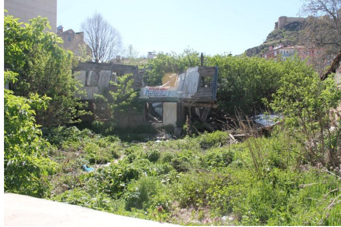
Şekil3.32- 247 ADA 9 Parselde Bulunan Yapı (Nisan 2017)
