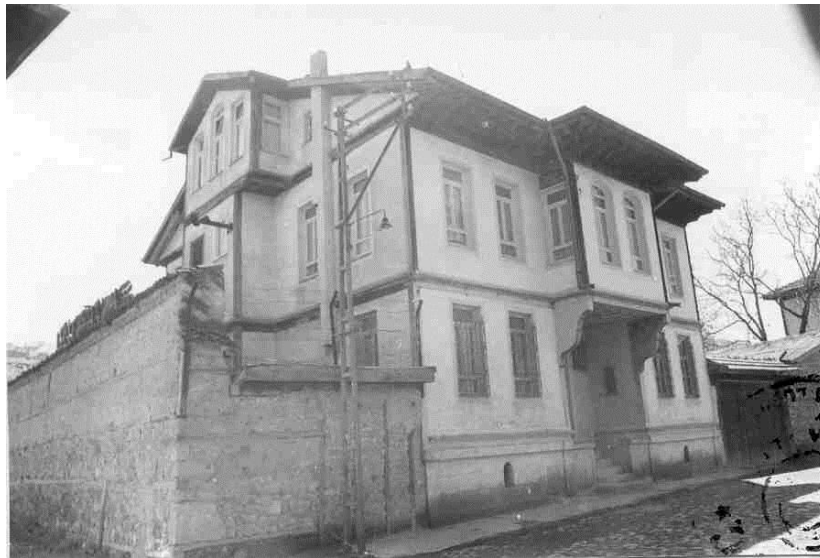
Şekil 4.1- Boyacızade Konağı (Kastamonu Belediyesi)
