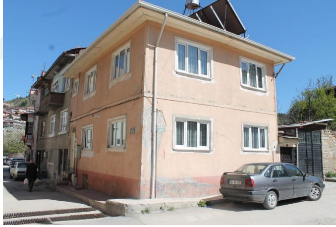
Şekil 3.50- 282 ADA 1 Parselde Bulunan Yapı (Nisan 2017)
