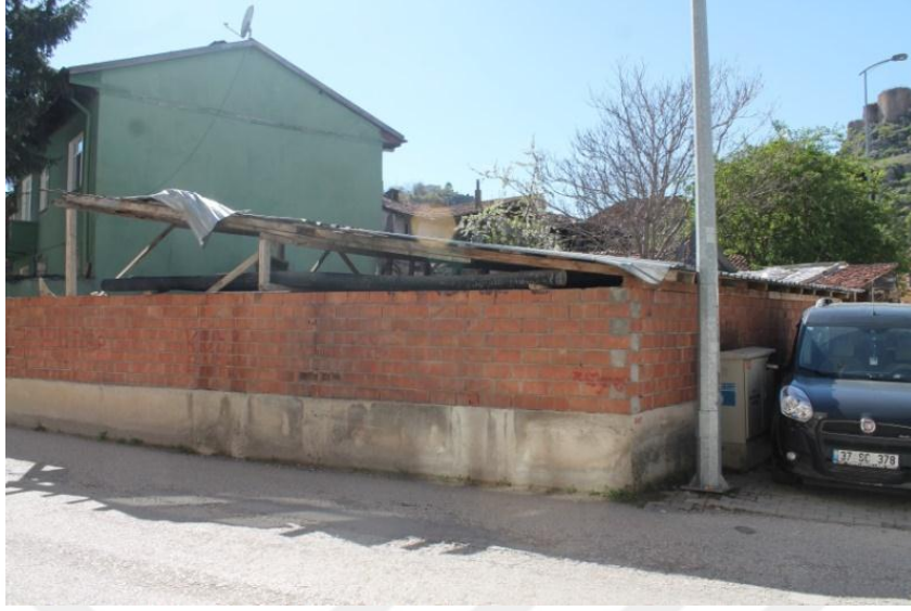
Şekil 3.37- 248 ADA 7 Parselde Bulunan Yapı (Nisan 2017)
