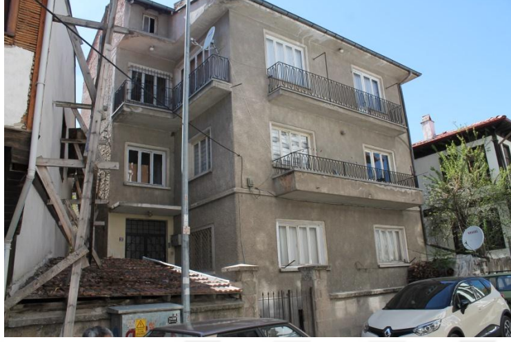
Şekil 3.47- 247 ADA 59 Parselde Bulunan Yapı (Nisan 2017)
