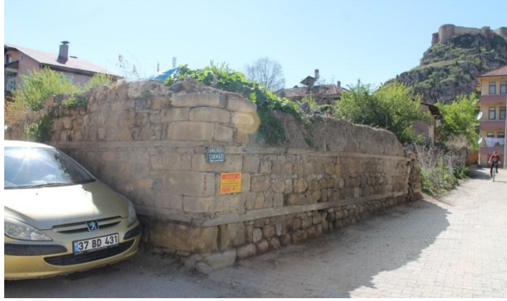
Şekil 3.35- 247 ADA 22-21 Parselde bulunan yapı (Nisan 2017)
