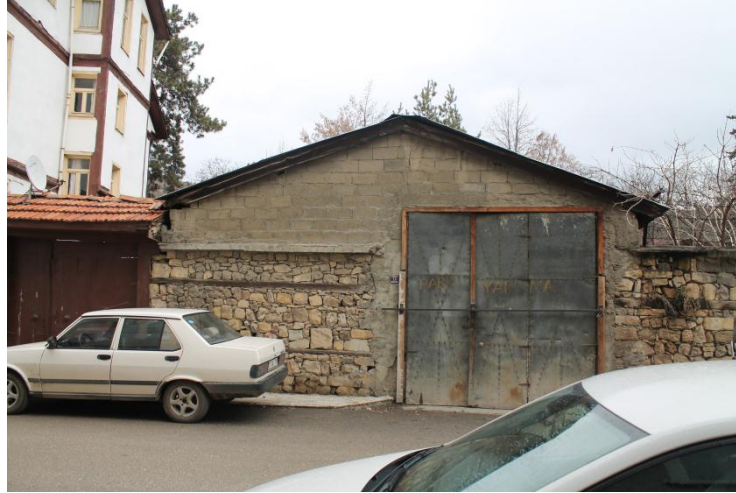
Şekil 3.52- 282 ADA 18 Parselde Bulunan Yapı (Nisan 2017)
