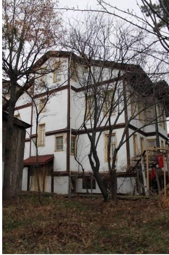
Şekil 4.6-Güney cephesi (Sağ Yan)
