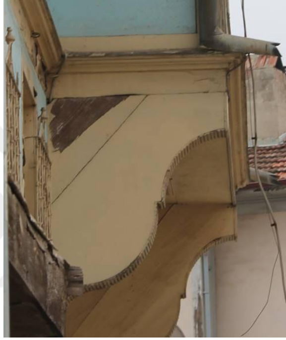
Şekil 4.26- Ön cephe payandaları
