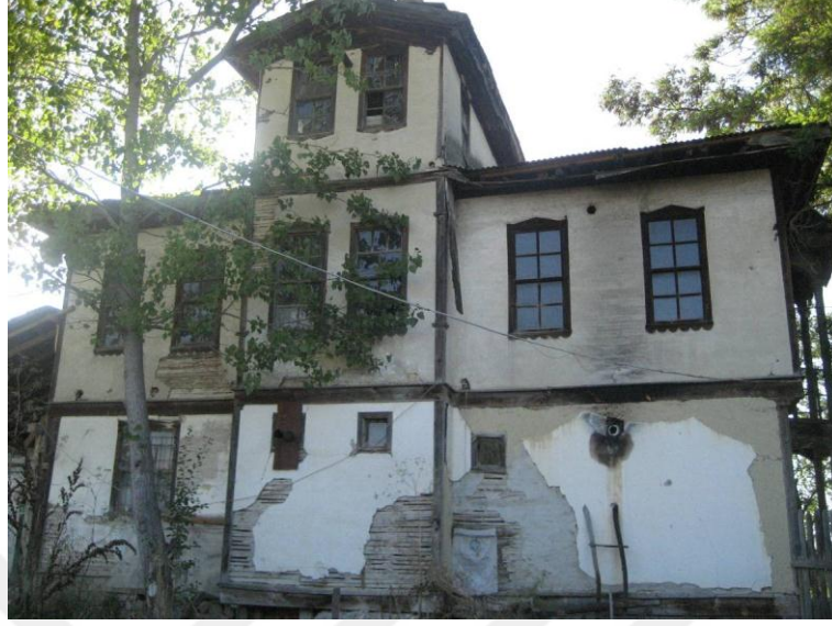
Şekil 2.46-Bağdadi Duvar i (M.Ali Aslan Evi) 2011
