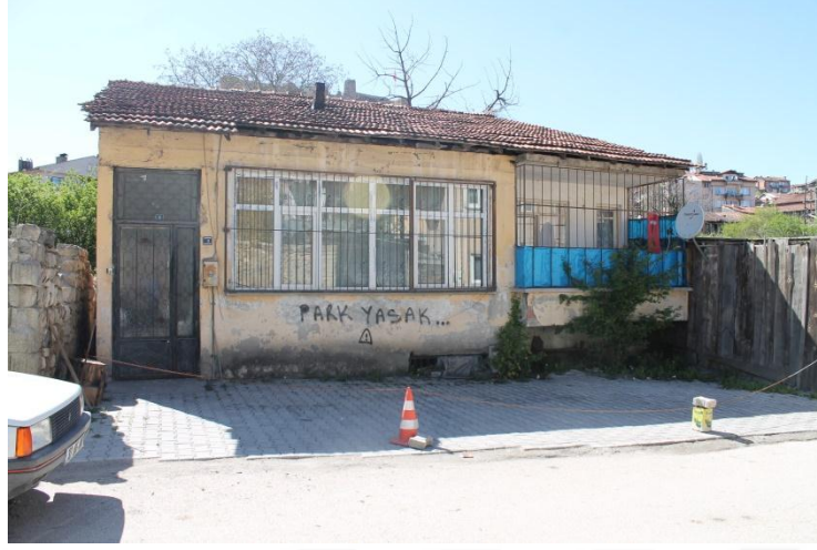
Şekil 3.51- 247 ADA 8 Parselde Bulunan Yapı (Nisan 2017)
