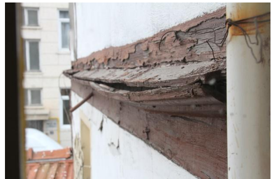
Şekil 4.31- Damlalıklı profilli ahşap kat silmesi
