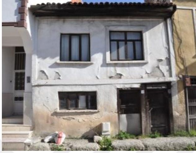
Şekil 3.39- 284 ADA 30 Parselde Bulunan Yapı (Nisan 2017)
