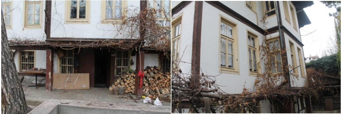
Şekil 4.17- Boyacızade Konağı'nın arka cephesinde yer alan pencere örnekleri
