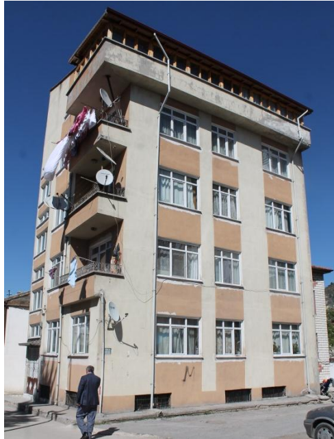
Şekil 3.63- 282 ADA 34 Parselde Bulunan Yapı (Nisan 2017)
