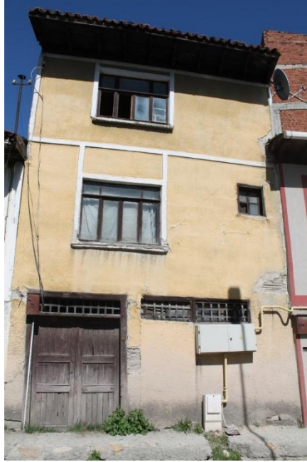
Şekil 3.40- 284 ADA 29 Parselde bulunan yapı (Nisan 2017)
