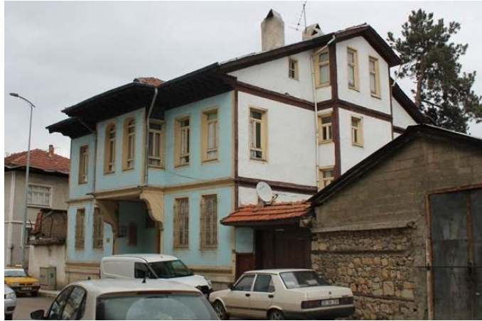
Şekil 3.29- 282 ADA 17 Parselde Bulunan Yapı (Tez Konusu Yapı)
