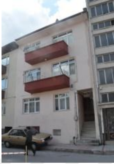
Şekil 3.53- 247 ADA 50 Parselde Bulunan Yapı (Nisan 2017)
