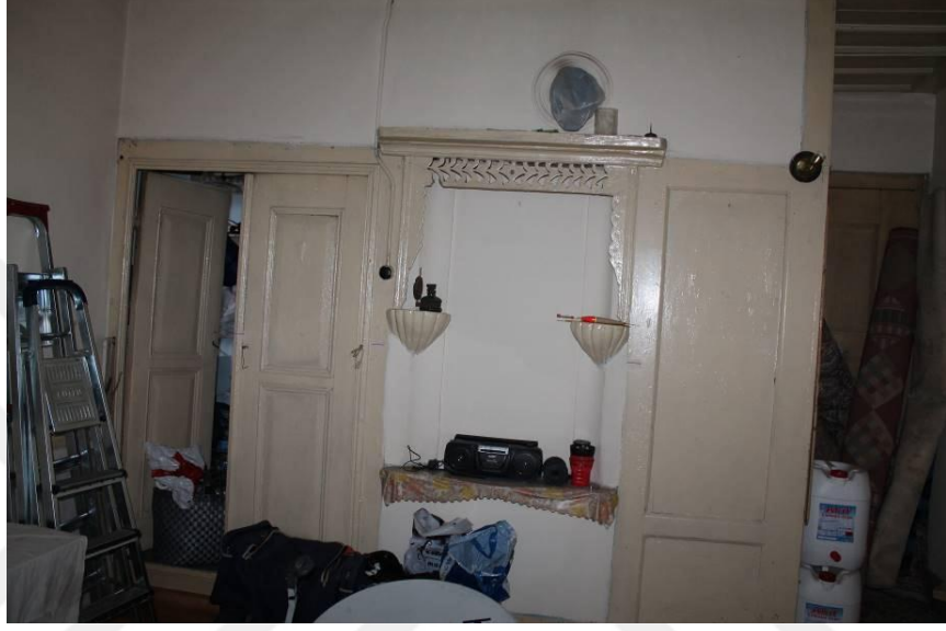
Şekil 4.18- Zemin katta Z03 no.lu odada yer alan dolaplar
