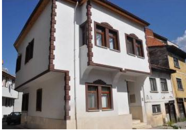
Şekil 3.49- 284 ADA 31 Parselde Bulunan Yapı (Nisan 2017)
