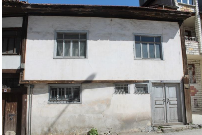
Şekil 3.42- 282 ADA 32 Parselde Bulunan Yapı (Nisan 2017)
