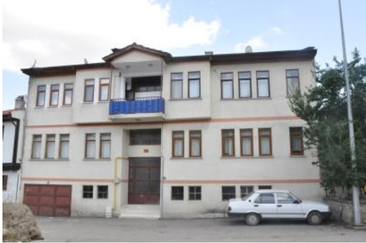
Şekil 3.56- 282 ADA 38 Parselde Bulunan Yapı (Nisan 2017)
