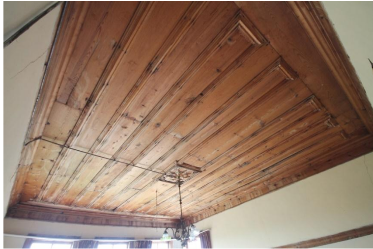
Şekil 2.48- Tavan Kaplaması (Ünsürler Konağı) 2013
