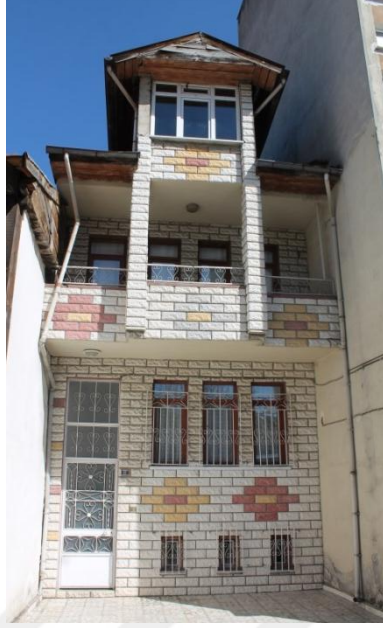
Şekil 3.59- 282 ADA 33 Parselde Bulunan Yapı (Nisan 2017)
