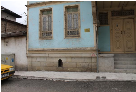
Şekil 4.30- Bodrum kat seviyesindeki kesme taş duvarlar
