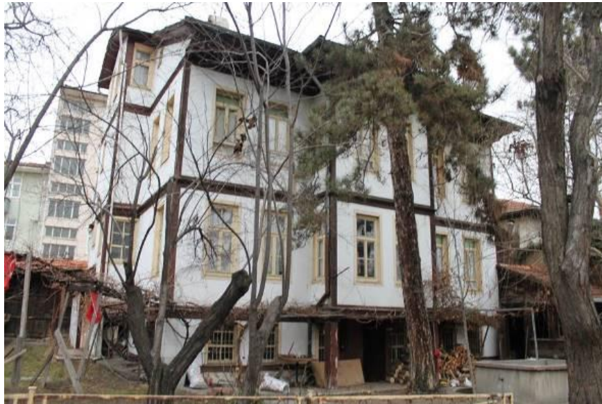
Şekil 4.7- Doğu cephesi (Arka Cephe)
