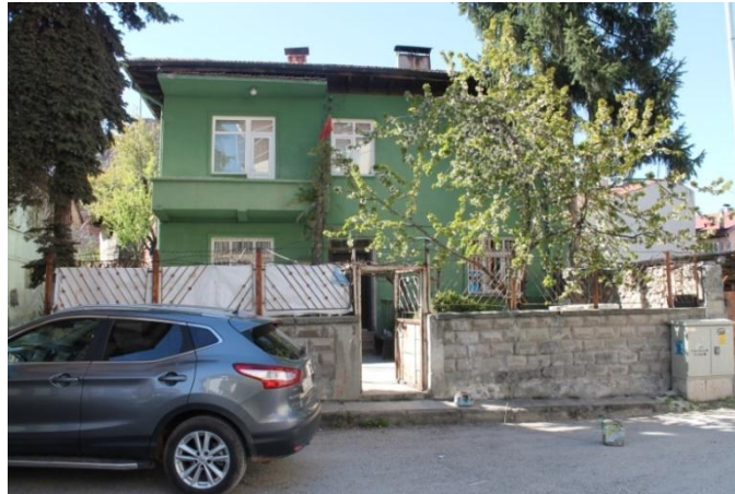
Şekil 3.60- 248 ADA 8 Parselde Bulunan Yapı (Nisan 2017)
