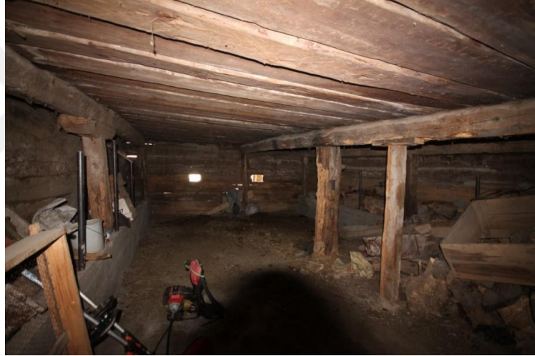
Şekil 2.29- Ahır ve Odunluk Örneği (Ünsürler Konağı) 2013
