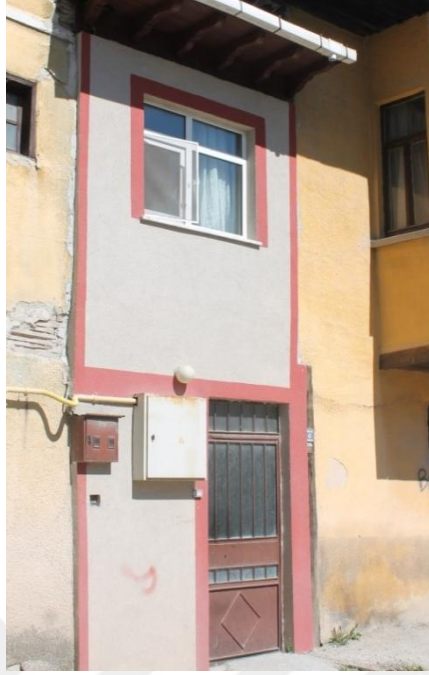
Şekil 3.41- 284 ADA 28 Parselde Bulunan Yapı (Nisan 2017)
