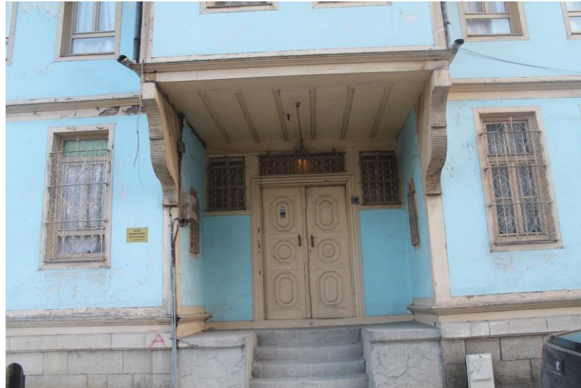
Şekil 4.25- Ön cephe çıkması
