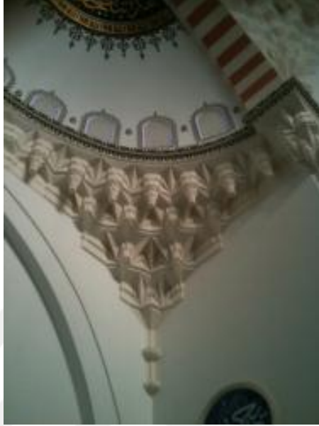
Şekil 3.6.16. Mimar Sinan Cami Köşe Birleşim Yerleri [55]
