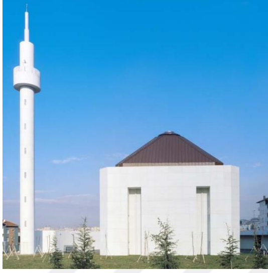
Şekil 3.3.6. Refiye Soyak Cami Minare [102]
