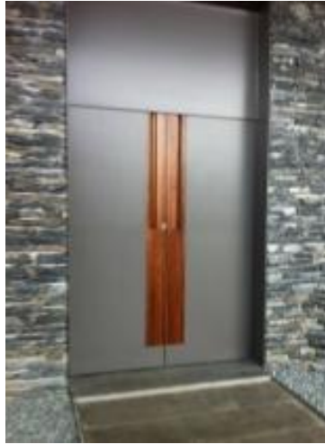
Ŗekil 3.11.4. Sancaklar Cami İbadet Mekan GiriŖ Kapısı [55]
