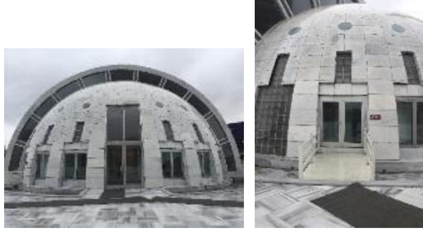
Şekil 3.2.3. Yeşil Vadi Cami İbadet Mekanı ve Kadınlar Mahfili Giriş Kapısı [55]
