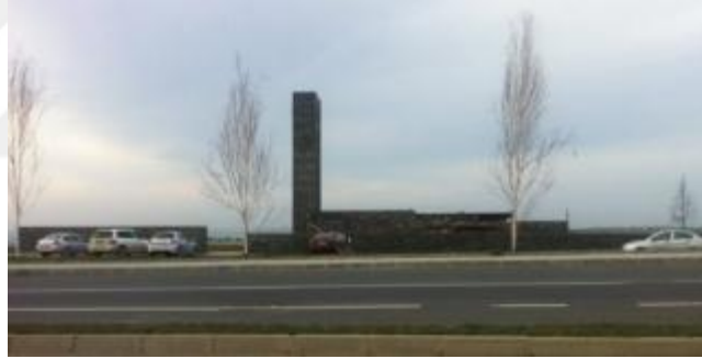
Şekil 3.11.1. Sancaklar Cami Genel Görünüş [55]
