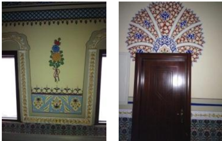
Şekil 3.10.5. Bilali Habeşi Cami Duvar Süslemeleri [55]
