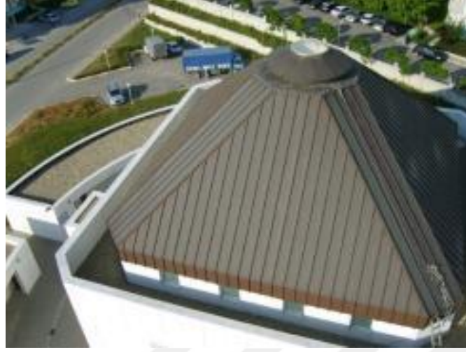
Şekil 3.3.13. Refiye Soyak Cami Kırma Çatı [68]
