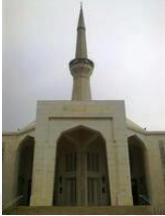
Şekil 3.4.3. Dumankaya Cami Minare [70]
