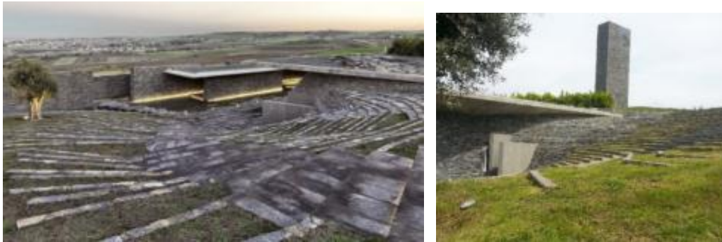
Şekil 3.11.2. Sancaklar Cami Merdivenler [98]
