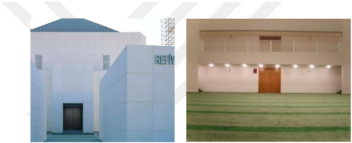
Şekil 3.3.7. Refiye Soyak Cami Giriş Kapısı [102] [68]
