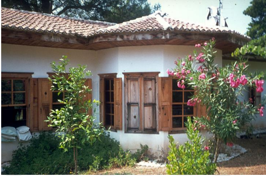
Şekil 3.41: Nail Çakırhan Evi Akyaka
