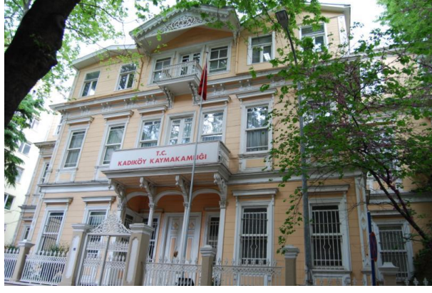
Ek 33. Reşit Paşa Konağı'nın arka cephesinin günümüzdeki hali [48]
