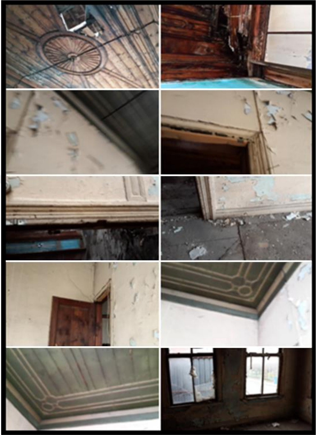
Ek 10. Adnan Bey Konağı restorasyon öncesi iç mekan detayları [40]
