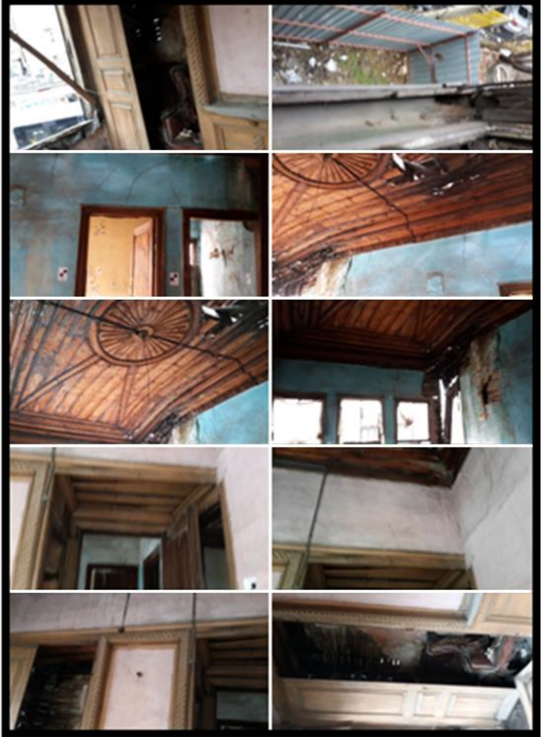
Ek 7. Adnan Bey Konağı restorasyon öncesi iç mekan detayları [40]
