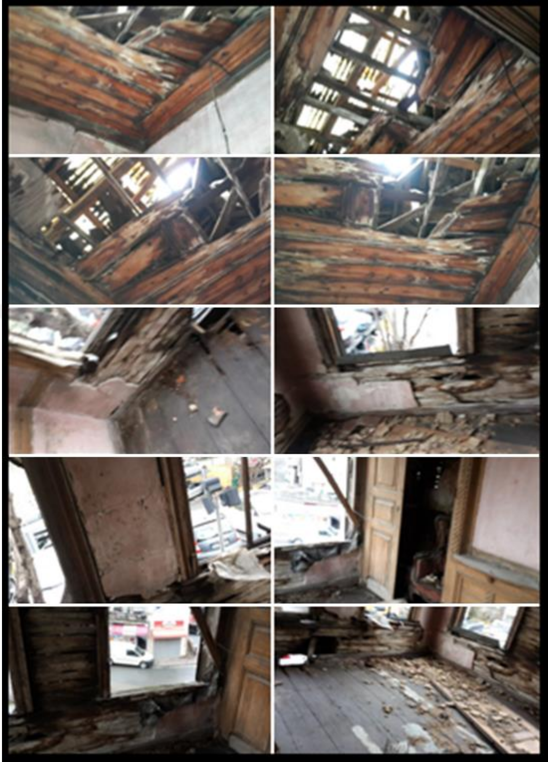
Ek 6. Adnan Bey Konađı restorasyon öncesi iç mekan detayları [40]
