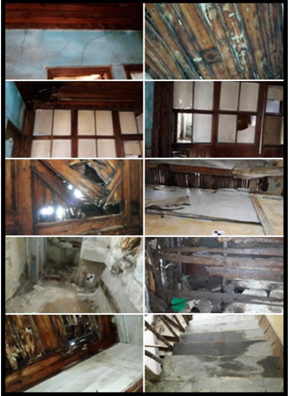
Ek 14. Adnan Bey Konağı restorasyon öncesi iç mekan detayları [40]
