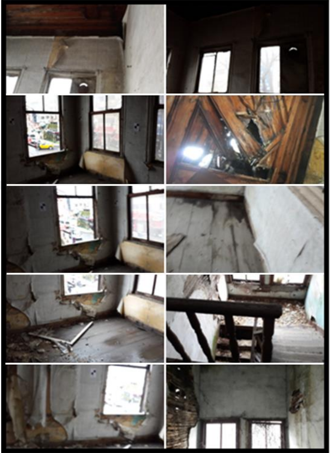
Ek 12. Adnan Bey Konađı restorasyon öncesi iç mekan detayları [40]
