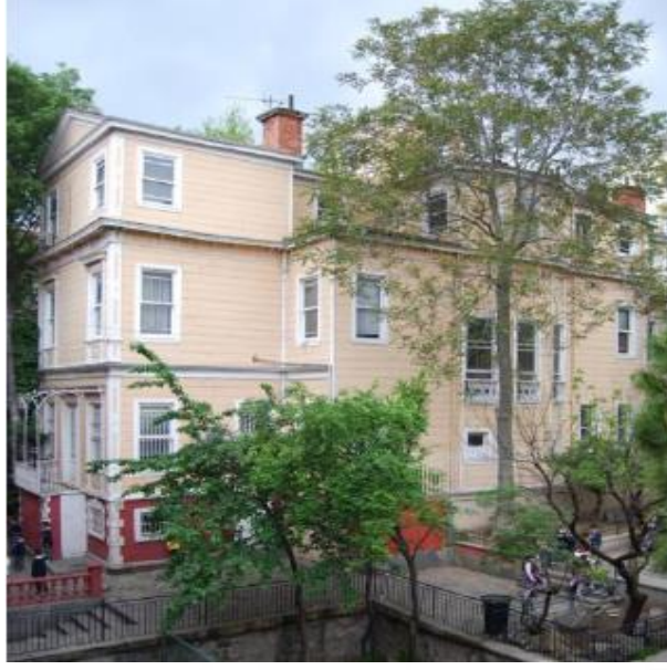
Ek 24. Reşit Paşa Konağı'nın arka cephesinin günümüzdeki hali [48]
