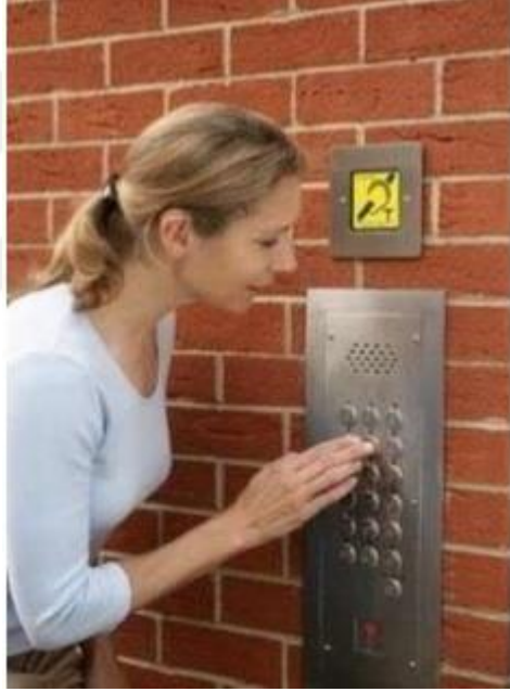
Resim 45: Kapı Girişinde Kameralı Görüşme Sistemi
