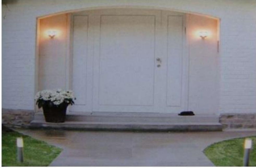
Resim 50: Dış kapı ve bahçe aydınlatmaları
