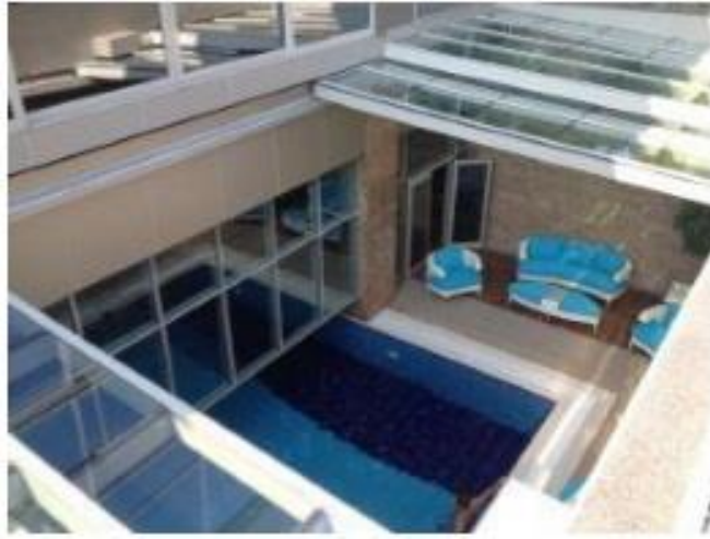
Resim 70: Teleskopik Ray Üzerinde Açılıp Kapanabilen Teras Kapatma Sistemi
