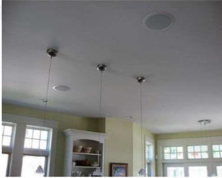
Resim 41: Tavana ankastre montajı yapılan speaker. ( hoparlör )
