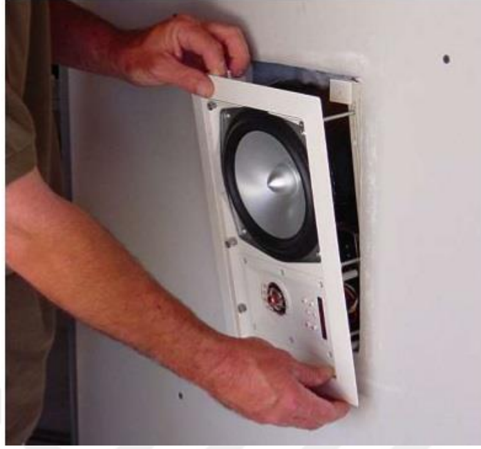
Resim 42: Duvara ankastre montajı yapılan speaker
