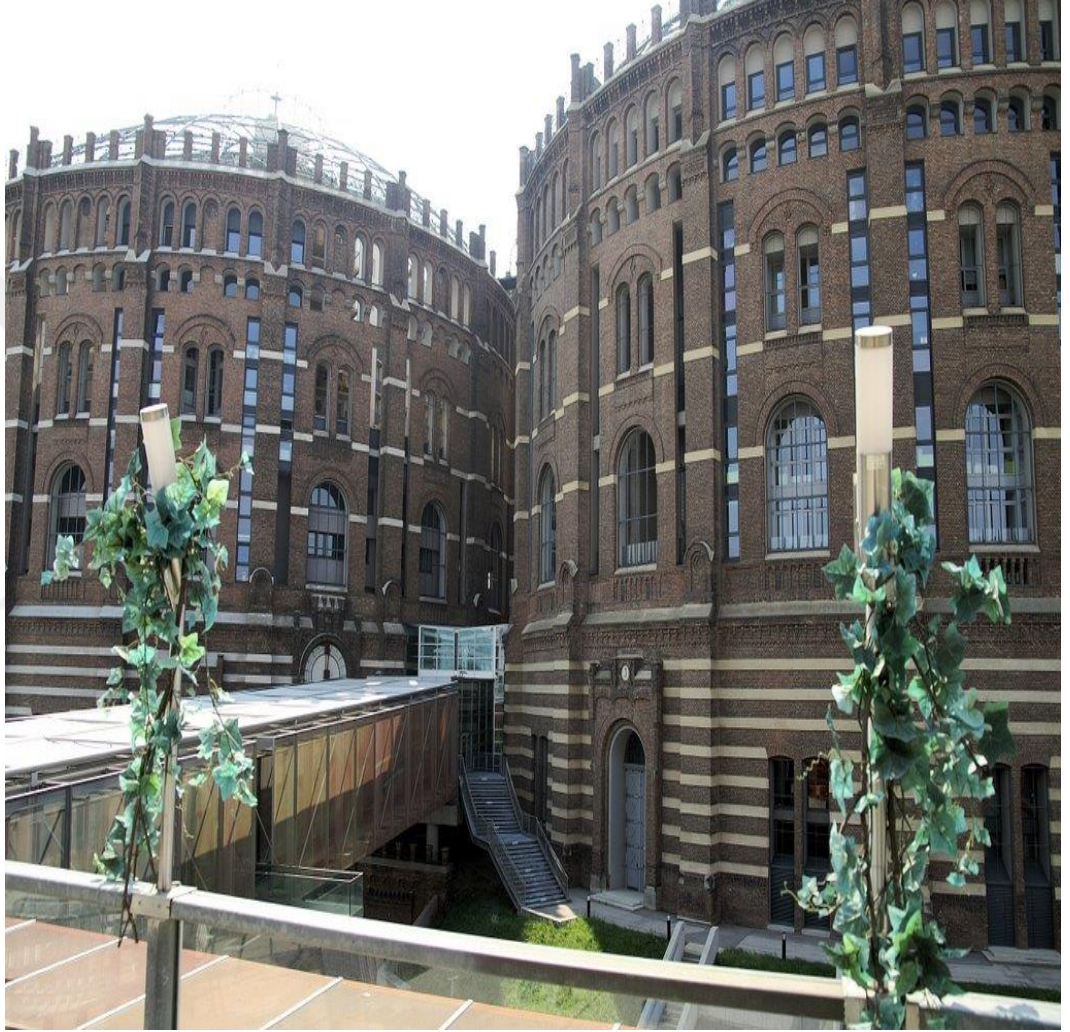
Şekil5.4 Viyana Simmering Gazometresi
