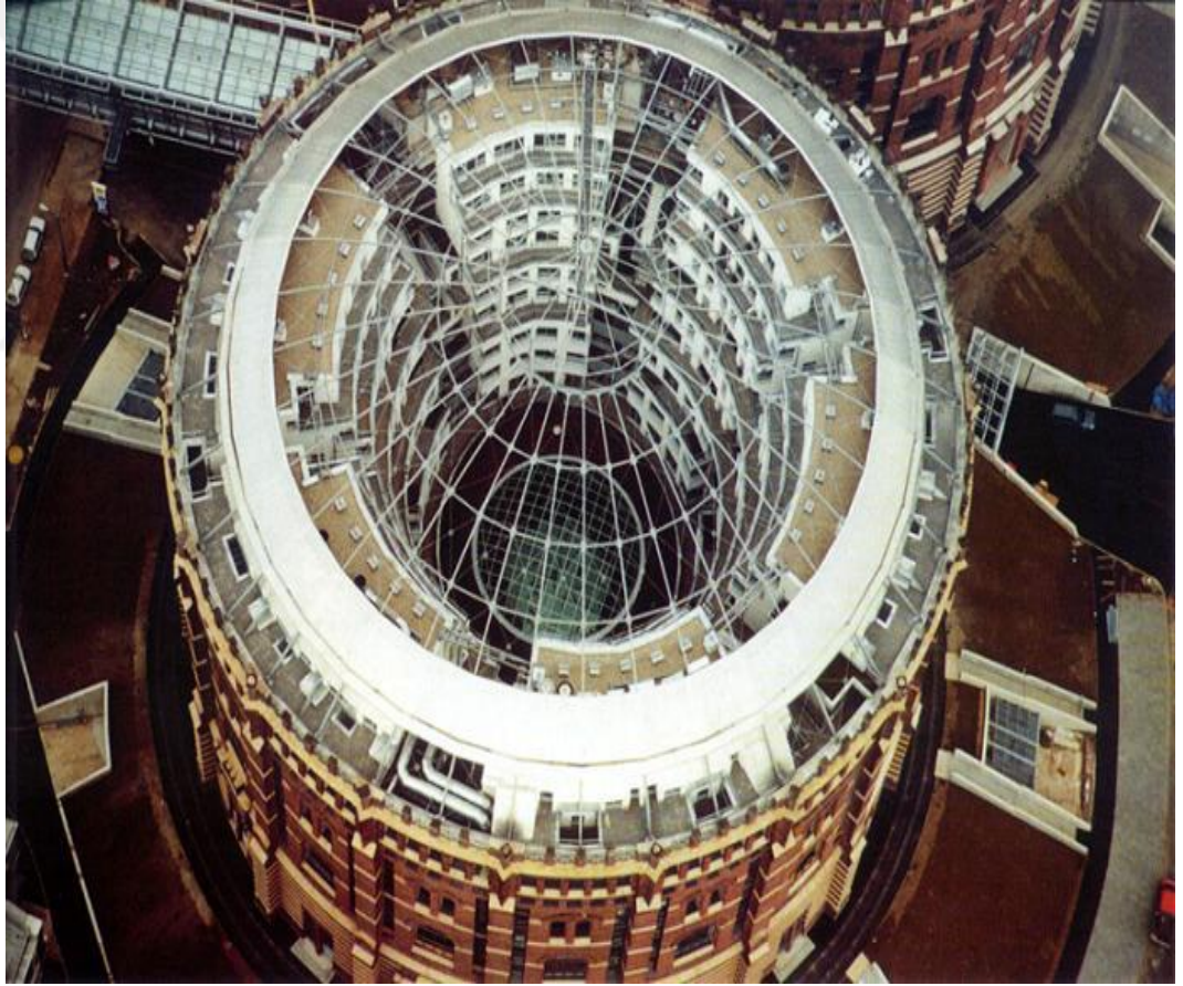
Şekil5.6 Viyana Simmering Gazometresi 2
