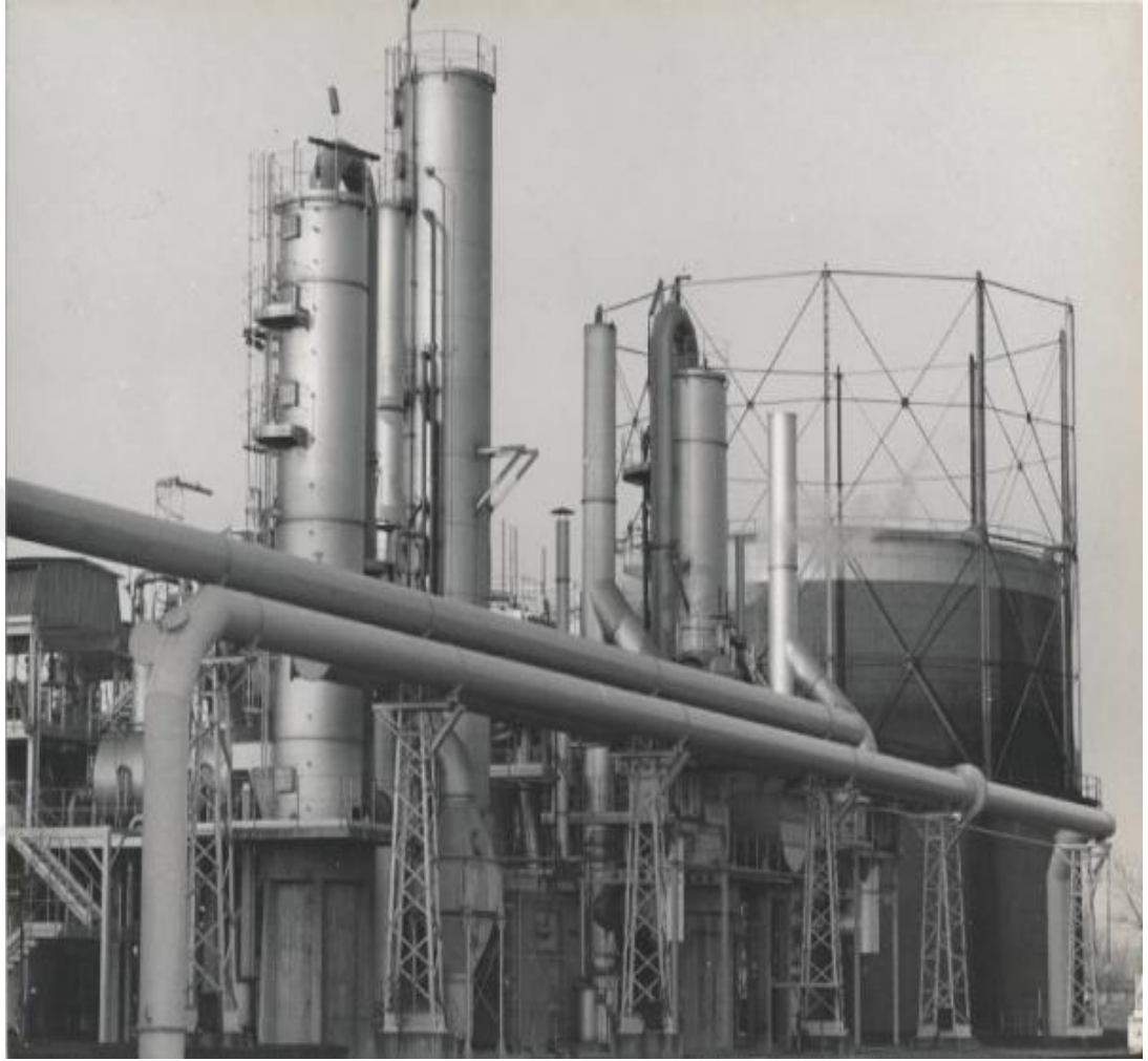
Şekil5.12 Bovisa Gazometresi- Milano 1920
