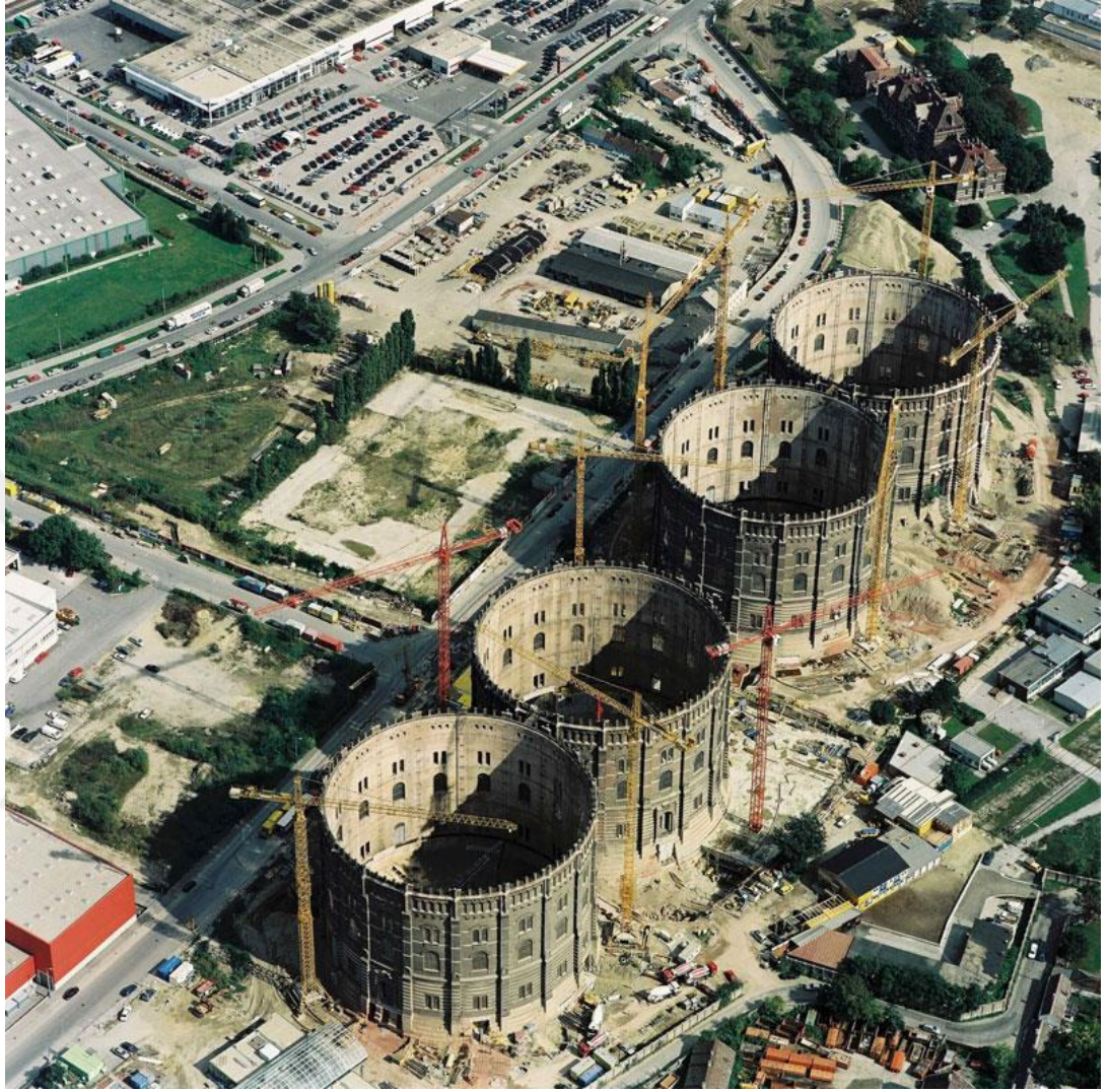
Şekil5.3 Viyana Simmering Gazometresi 1999-2001
