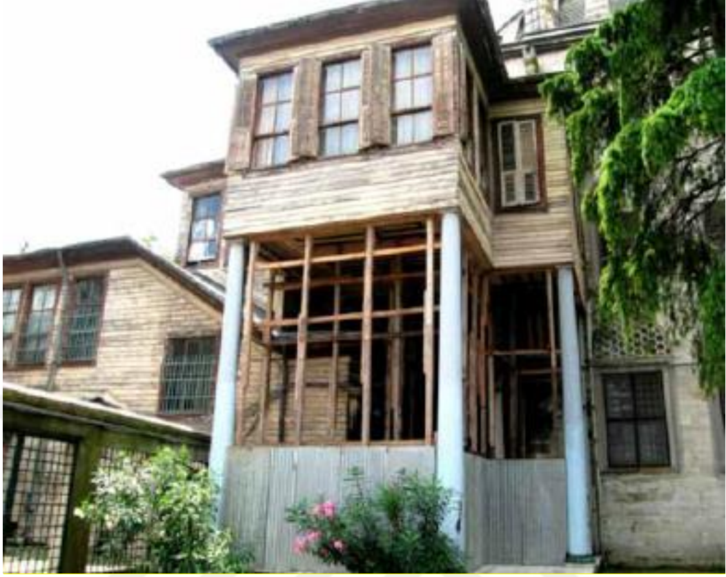
Şekil 6.94 Hünkar Köşkü'nün restorasyon sırasındaki onarımı (Vakıflar Arşivi)
