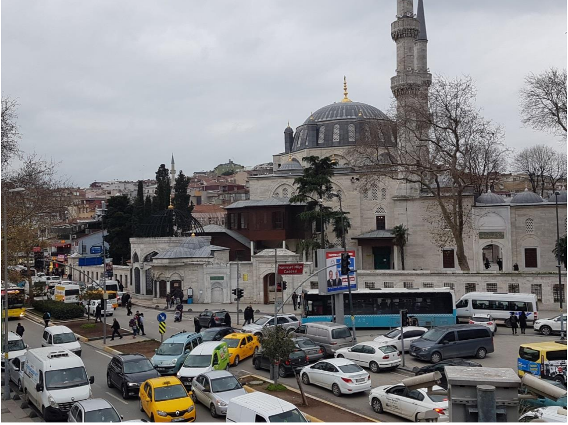
Şekil 6.1 Valide-i Cedid Külliyesi Genel Görünümü (Kasım, 2017)
