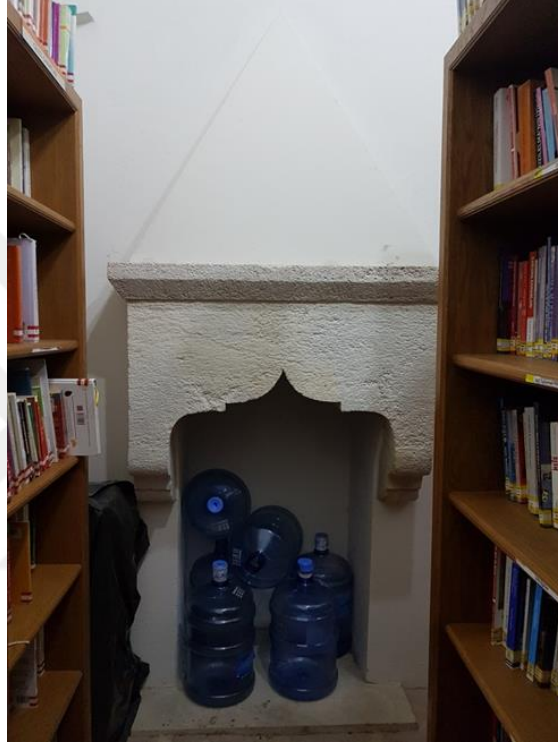
Şekil 5.46 Medrese odalarındaki ocakların görünümü (Aralık, 2017)
