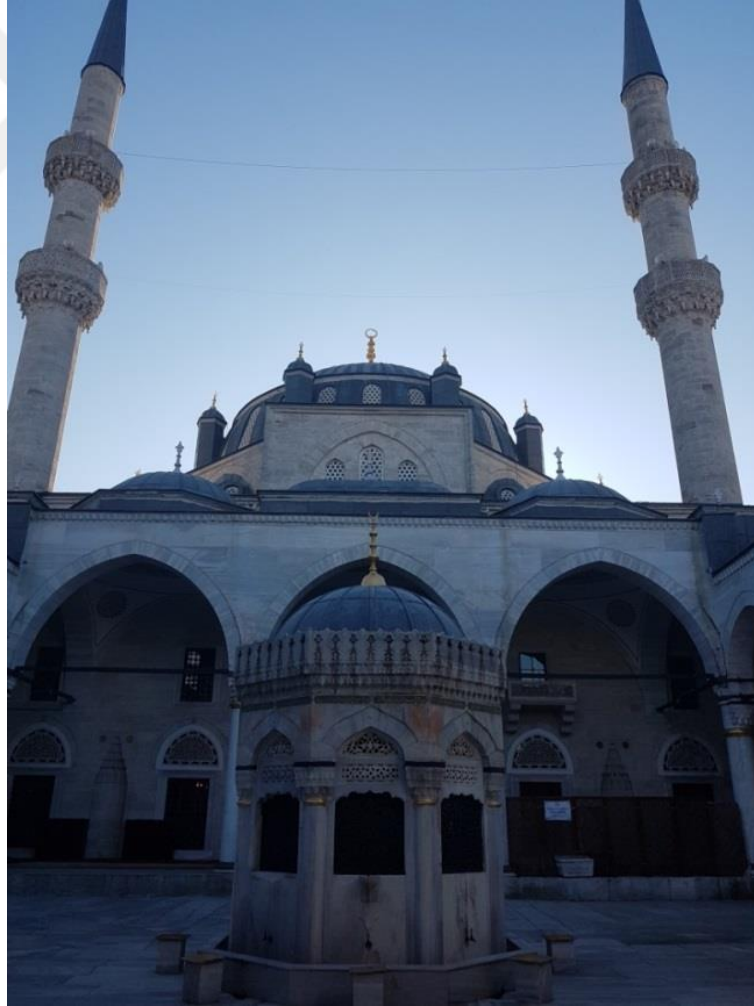
Şekil 6.12 Valide-i Cedid Külliyesi iç avludan görünüm
