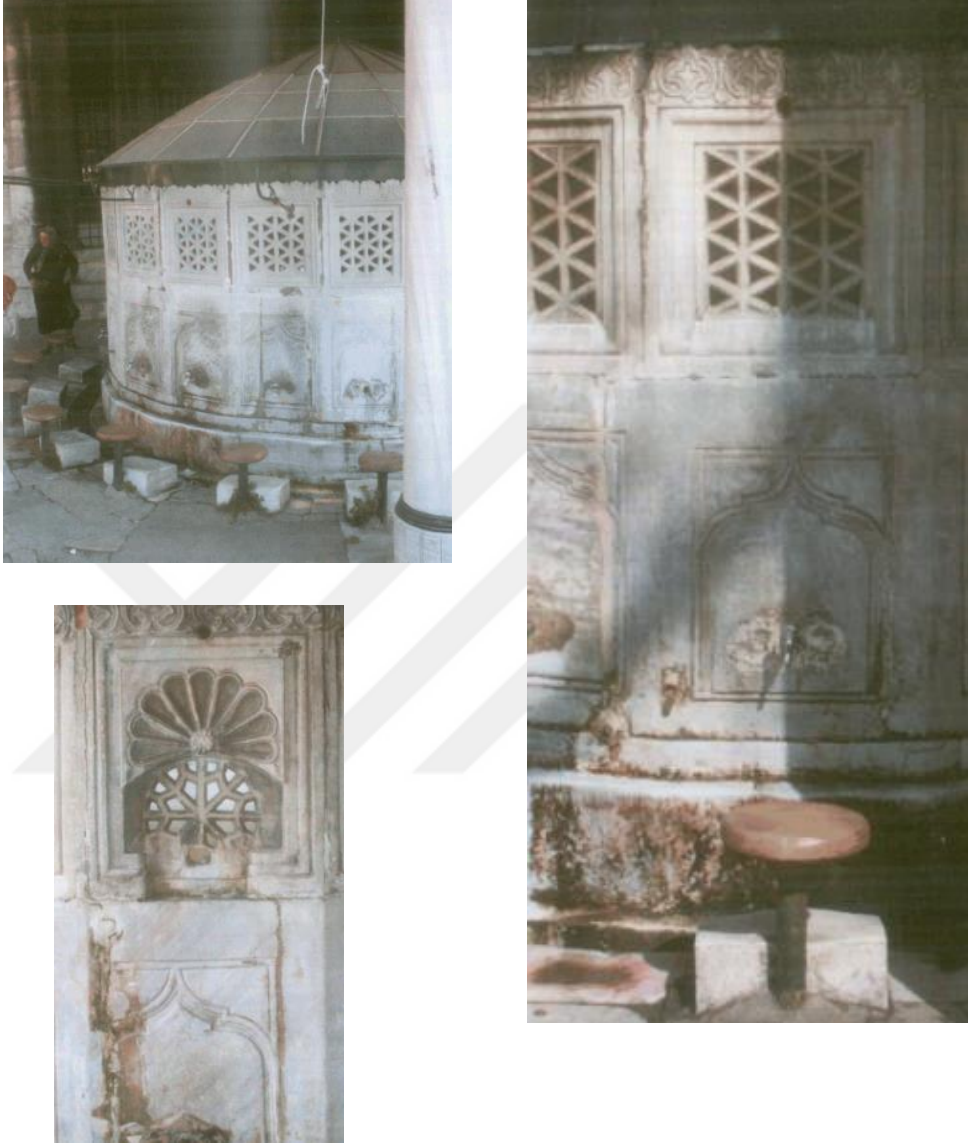
Şekil 4.69 Şadırvanın eski hali (Vakıflar Arşivi, 2008)
