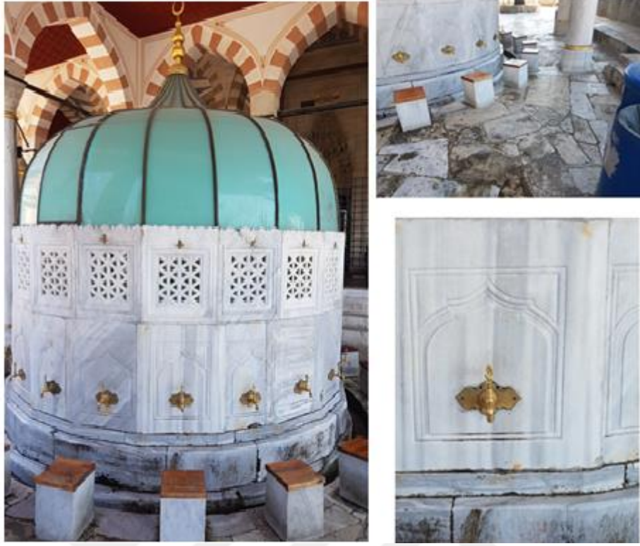
Şekil 4.17 Şadırvanın genel ve çatı örtüsünün görünümü (Ekim, 2017)
