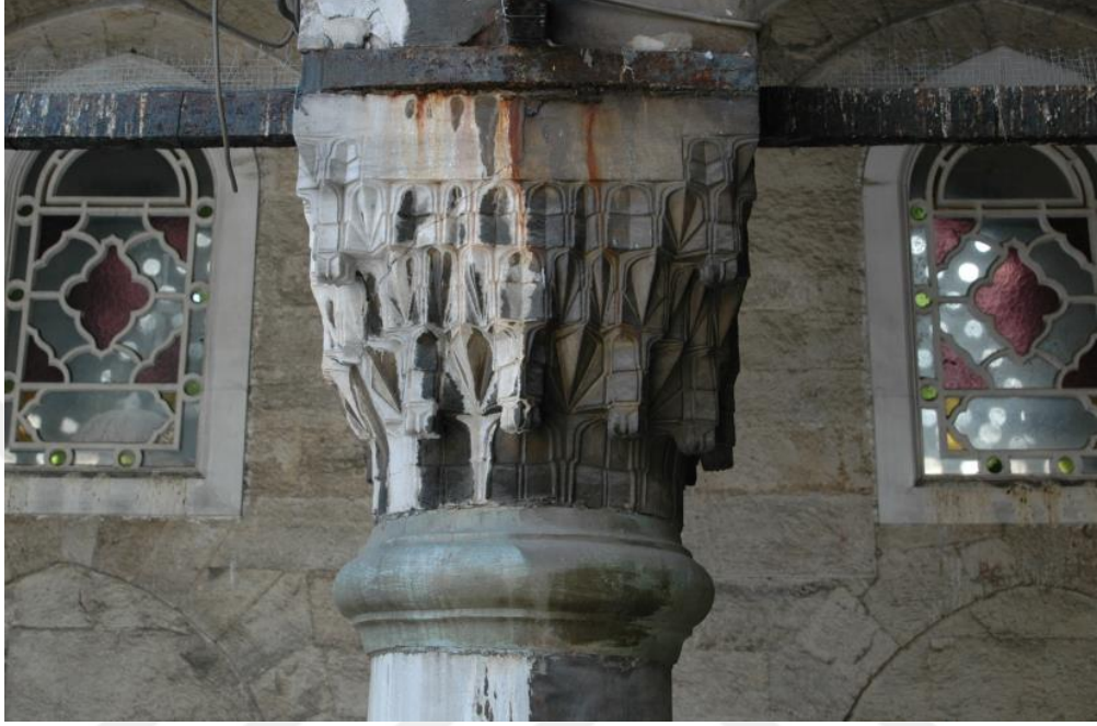
Şekil 6.75 Restorasyon öncesi bozulan sütun başlarının görünümü (Acar Avunduk Albümü)
