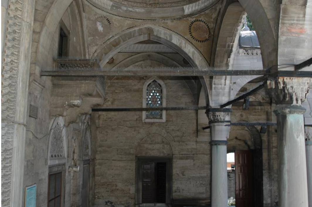
Şekil 6.75 Restorasyon öncesi bozulan sütun başlarının görünümü (Acar Avunduk Albümü)
