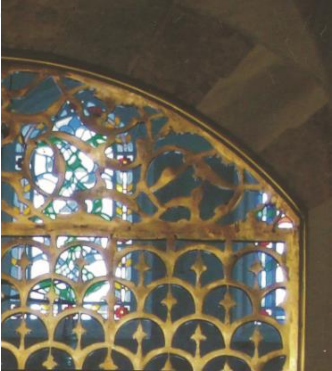
Şekil 5.67 Türbedeki demir şebekenin onarım sonrası (Aralık, 2017)
