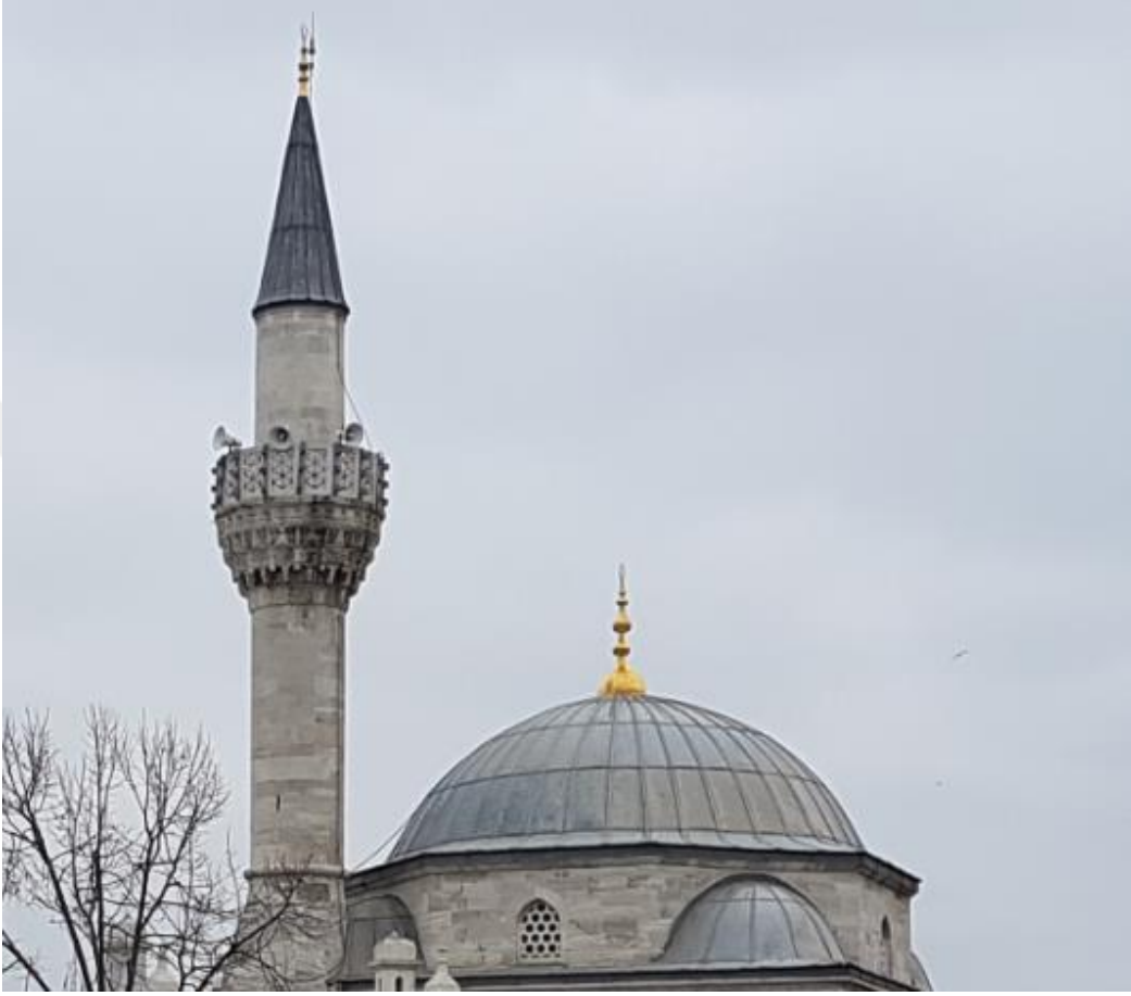
Şekil 5.35 Cami üst örtü ve kurşunların görünümü (Kasım, 2017)
