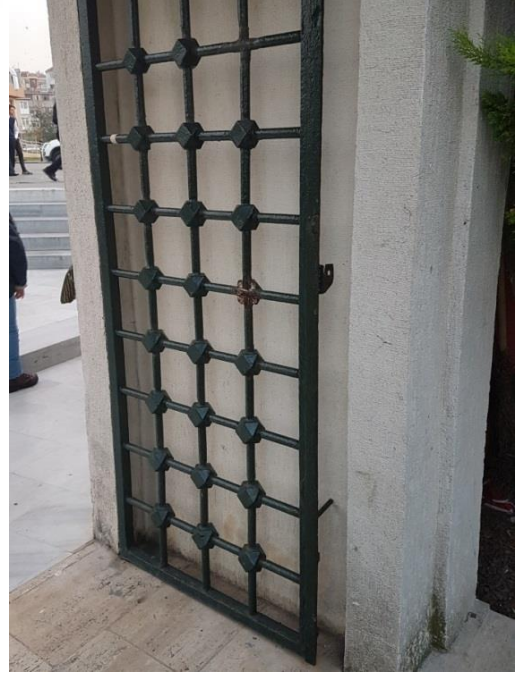
Şekil 5.19 - 5.20 Külliye'nin cadde yönündeki avlu giriş kapısı ve kapının lokmalı parmaklıklarının görüntüsü (Kasım, 2017)
