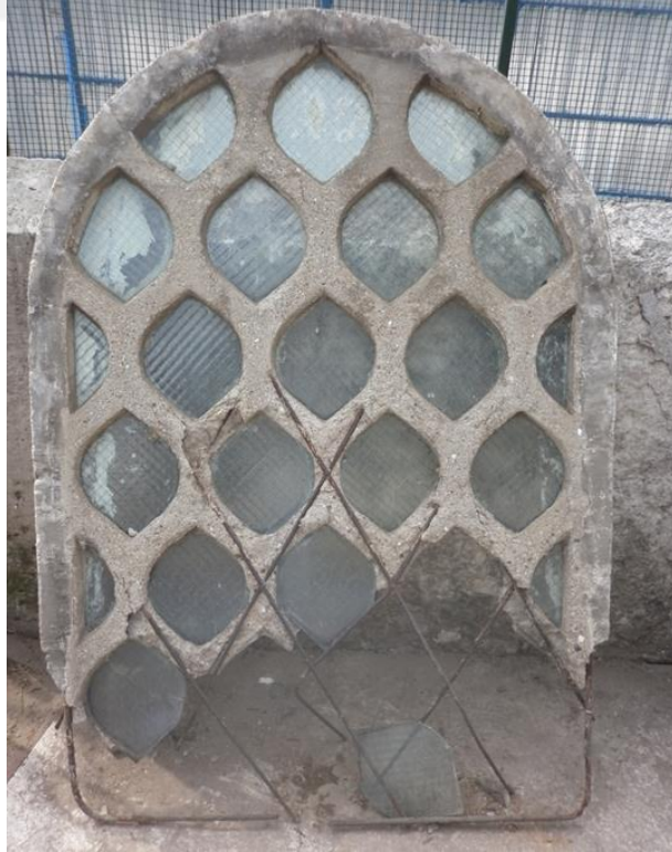
Şekil 4.66 Dışlık pencerelerde bozulmalar (Ansa-Abide, 2012)
