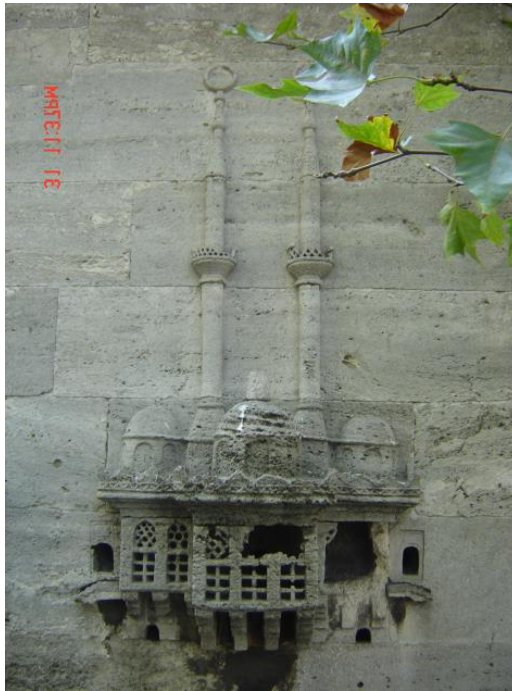
Şekil 6.79 Kuş evlerinin eksik ve kırık olan bölümleri (Acar Avunduk)
