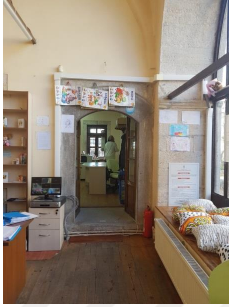
Şekil 4.130 Sıbyan mektebinin yazlık bölümden kışlık bölümüne geçiş kısmı (Kasım, 2017)
