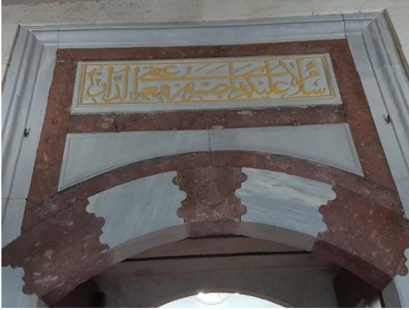
Şekil 5.56 Çift Renkli Makaralı Kemer Taşları dıştan ve içten görünümü (Ocak, 2018)
