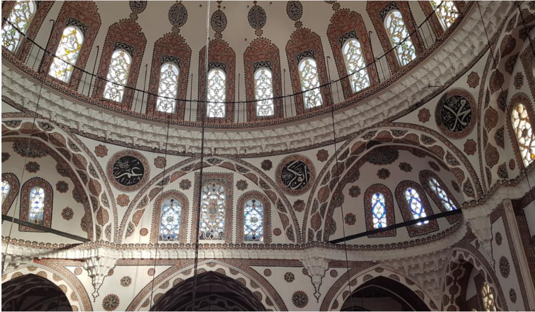
Şekil 6.67 Taşıyıcı sistemde kemerler (Eylül, 2017)
