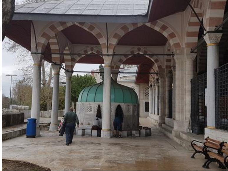
Şekil 4.16 Şadırvanın genel ve çatı örtüsünün görünümü (Ekim, 2017)
