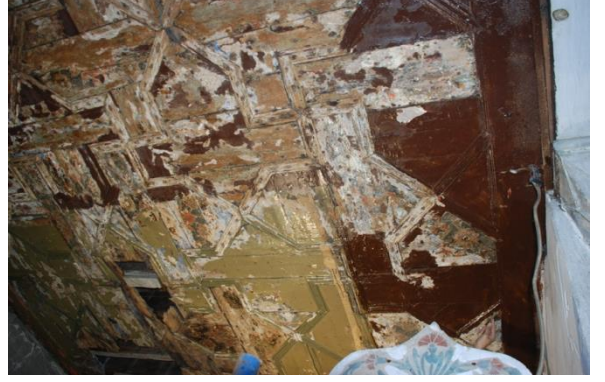
Şekil 4.96 Mihrimah Sultan Cami içinde müezzin mahfili alt kısmı olan Edirnekâri tavan raspaşı yapımı (2012)
