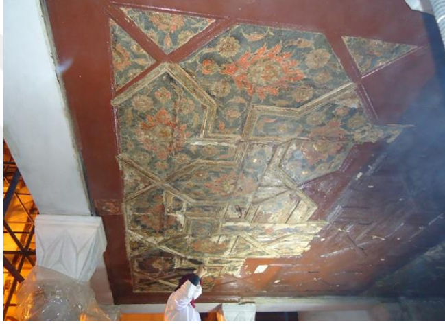
Şekil 4.97 Edirnekâri tavan raspaşı 2012 yılı restorasyonu sırasında öncesi ve sonrası (2012)
