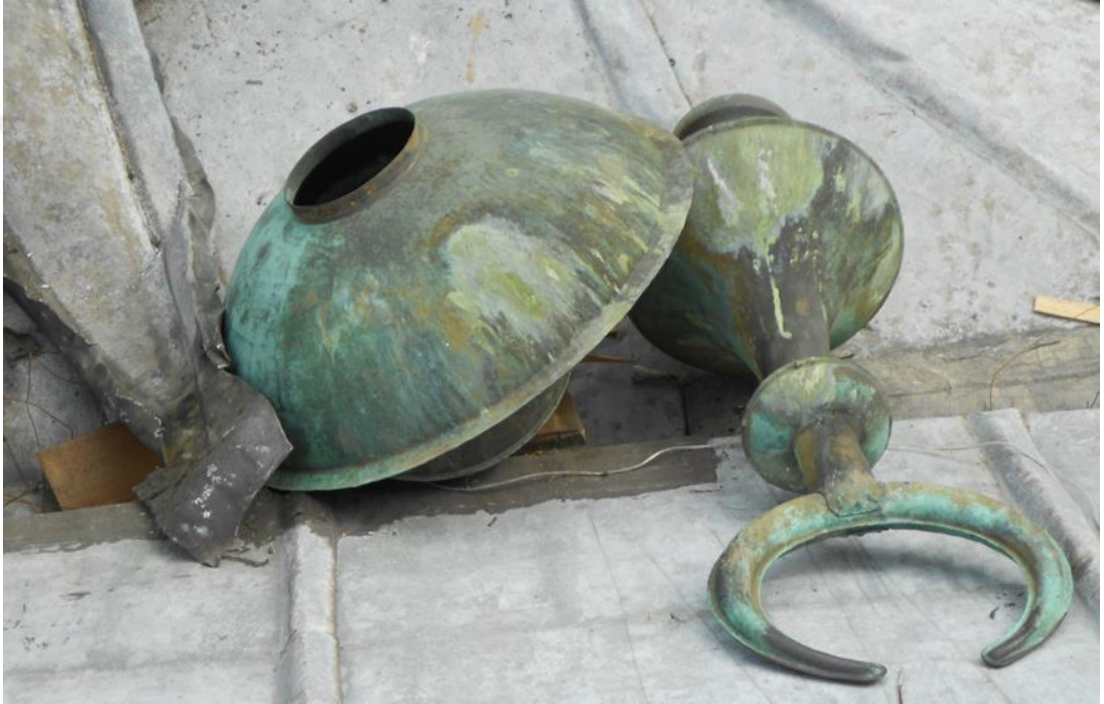
Şekil 4.99 Onarım öncesi minare alemlerinin görünümü (Ansa Abide, 2013)
