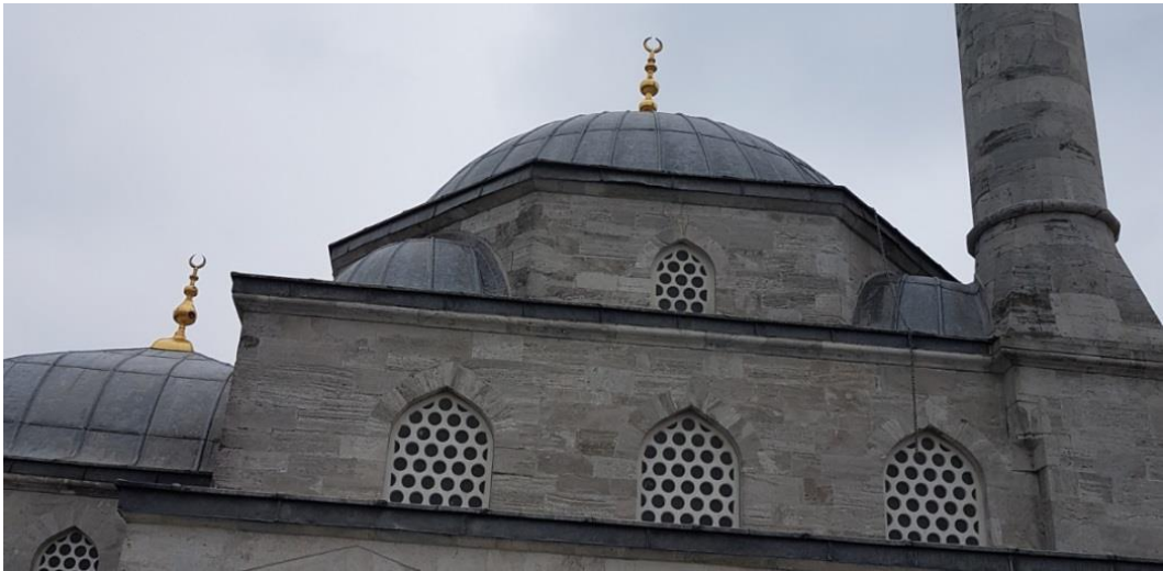
Şekil 5.35 Cami üst örtü ve kurşunların görünümü (Kasım, 2017)
