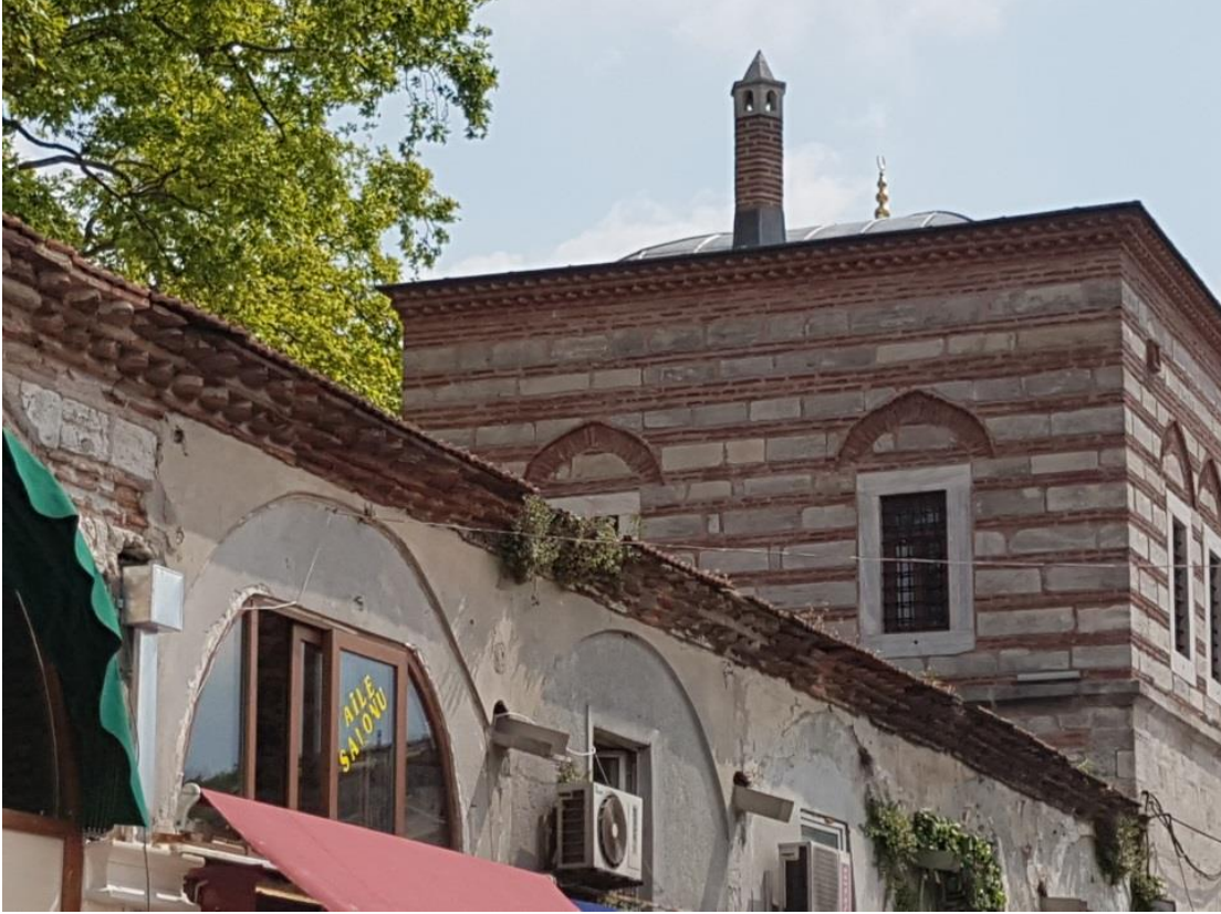
Şekil 6.103 Sıbyan Mektebinin dersane ocağının bacasının görünümü (Aralık, 2017)
