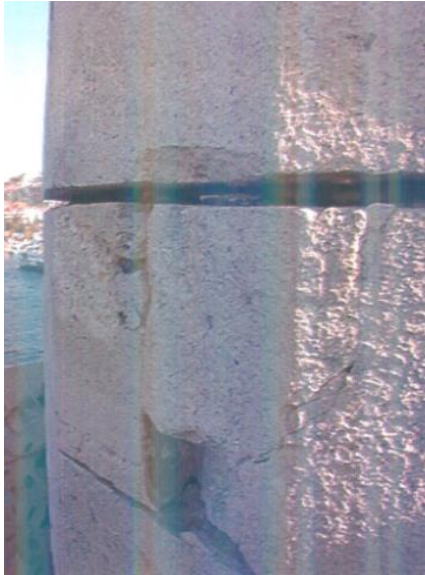
Şekil 5.38 Minare gövdesinin iç ve dış cephe bozulmaları (Yılmaz Yapı, 2010)
