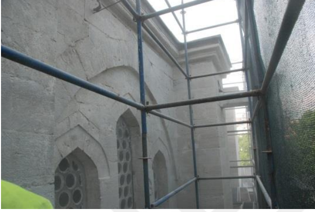
Şekil 6.84 Dış Cephe Temizliği (An-sa Abide Arşivi)
