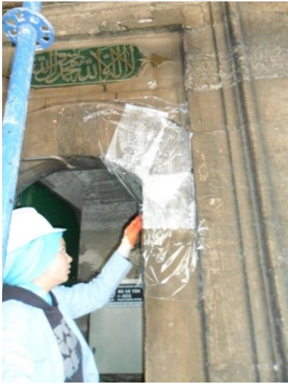
Şekil 4.94 Restorasyon sırasında dış cephe temizliği AB57 ile (Ansa Abide, 2012)
