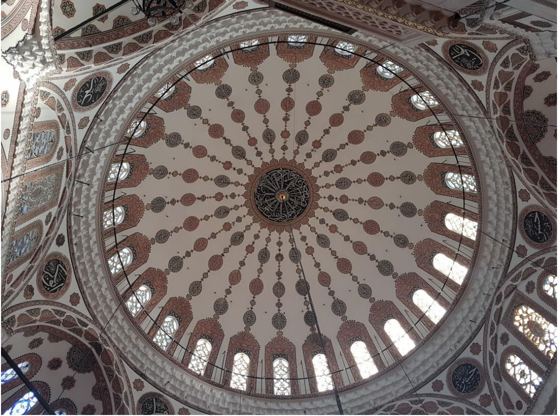
Şekil 6.68 Üst örtü görünümü (Aralık, 2017)
