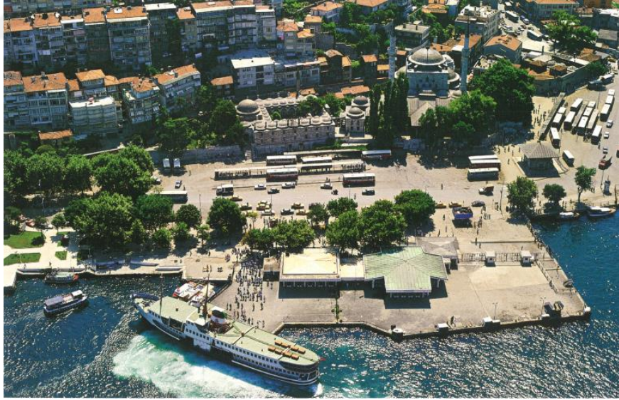
Şekil 4.77 Mihrimah Sultan Külliyesi'nin havadan görünümü (Vakıflar Arşivi, 1990)
