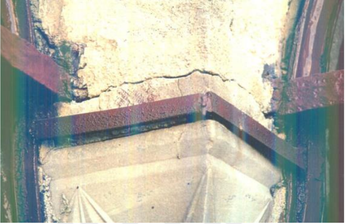
Şekil 5.61 Sütun başlıklarının çelik malzeme ile birleşmesi (Acar Avunduk, 1990)
