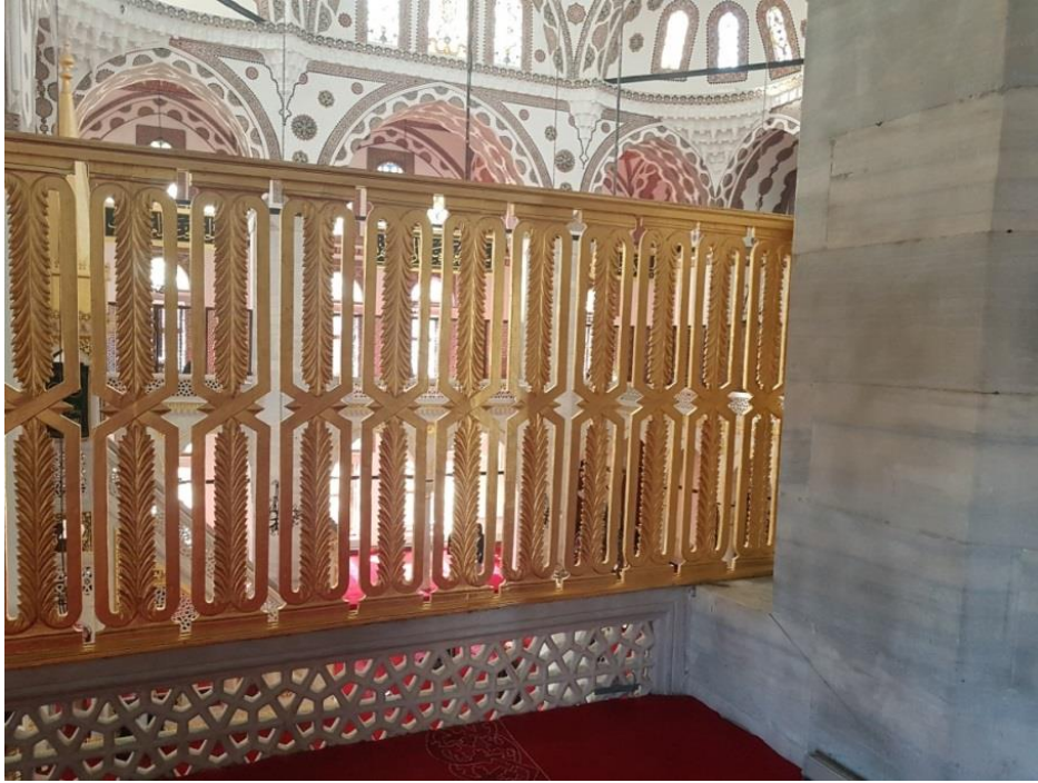
Şekil 6.45 Hünkar Mahfilinin Korkuluğunun Görünümü (Kasım, 2017)
