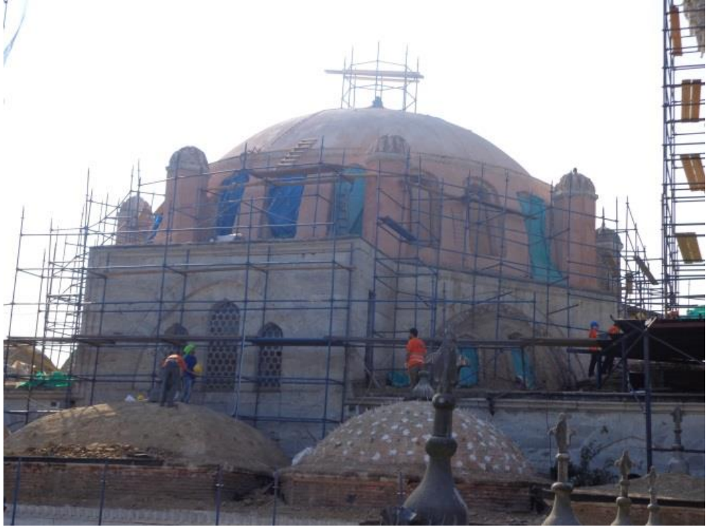
Şekil 6.82 Üst Örtü Kurşunlarının Restorasyon Öncesi Bozulmuş Durumu ve Restorasyon Sırasındaki Görünümü (An-sa Abide)
