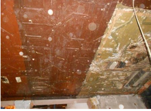
Şekil 4.96 Mihrimah Sultan Cami içinde müezzin mahfili alt kısmı olan Edirnekâri tavan raspaşı yapımı (2012)
