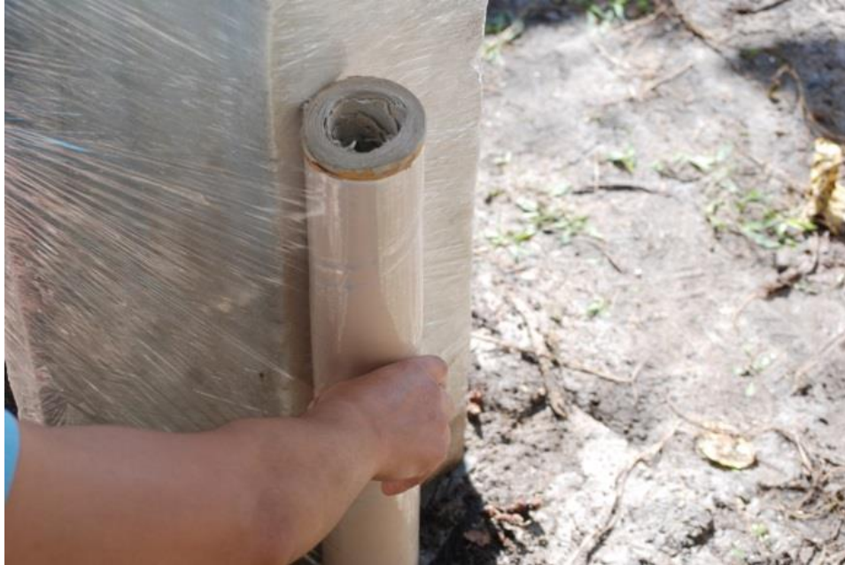
Şekil 6.85 Dış Cephe temizlik onarımı (An-sa Abide Arşivi)
