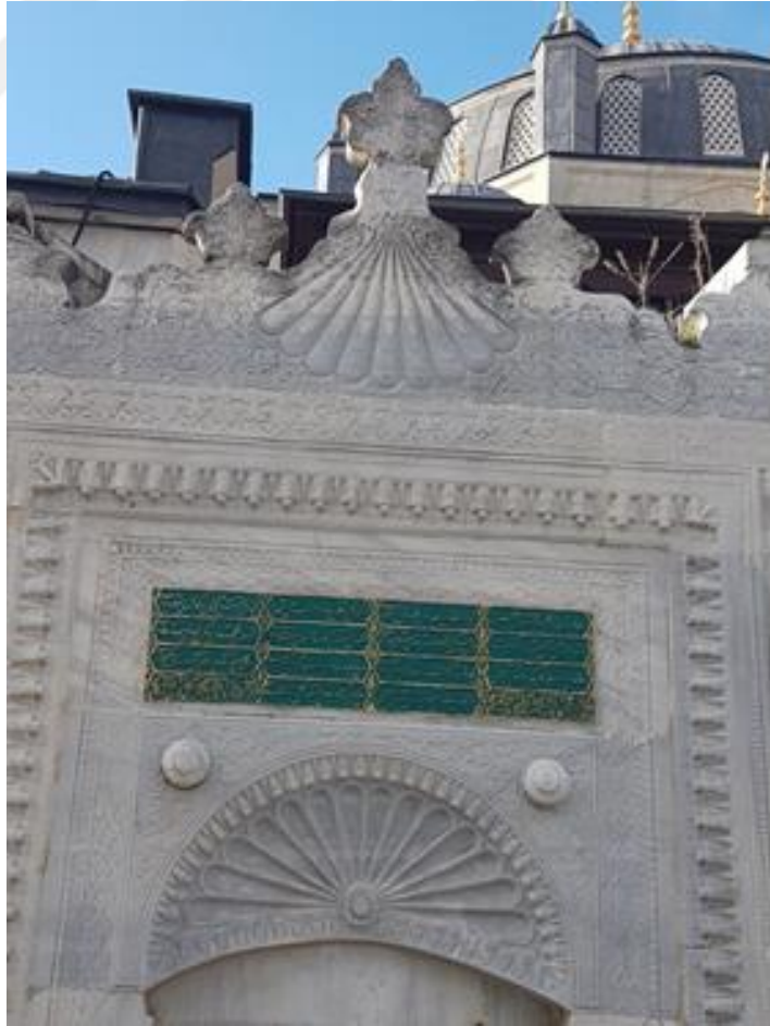
Şekil 6.128 Çeşmenin restorasyon sonrası (Aralık, 2017)
