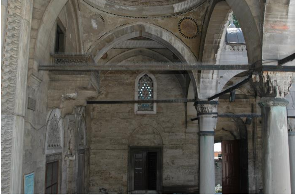
Şekil 6.80 Revaklı avludaki sütun başlıklarının bozulmalarının görünümü (Acar Avunduk Albümü)
