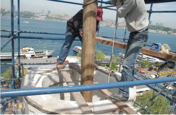
Şekil 4.103 Minare petekte ahşap hatıl çakılması (Ansa Abide, 2013)
