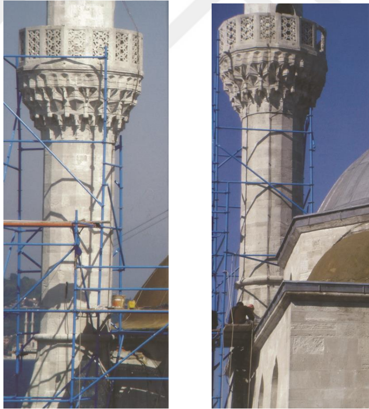
Şekil 5.44 Minarede yapılan onarımların görüntüsü (Yılmaz Yapı)
