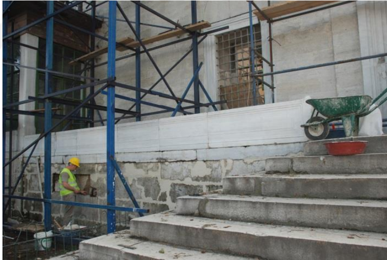
Şekil 6.87 Taş çürütme yöntemi (An-sa Abide Arşivi)
