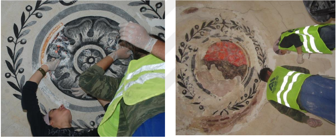
Şekil 6.88 Kubbelerde enjeksiyon yapımı (An-sa Abide Arşivi)
