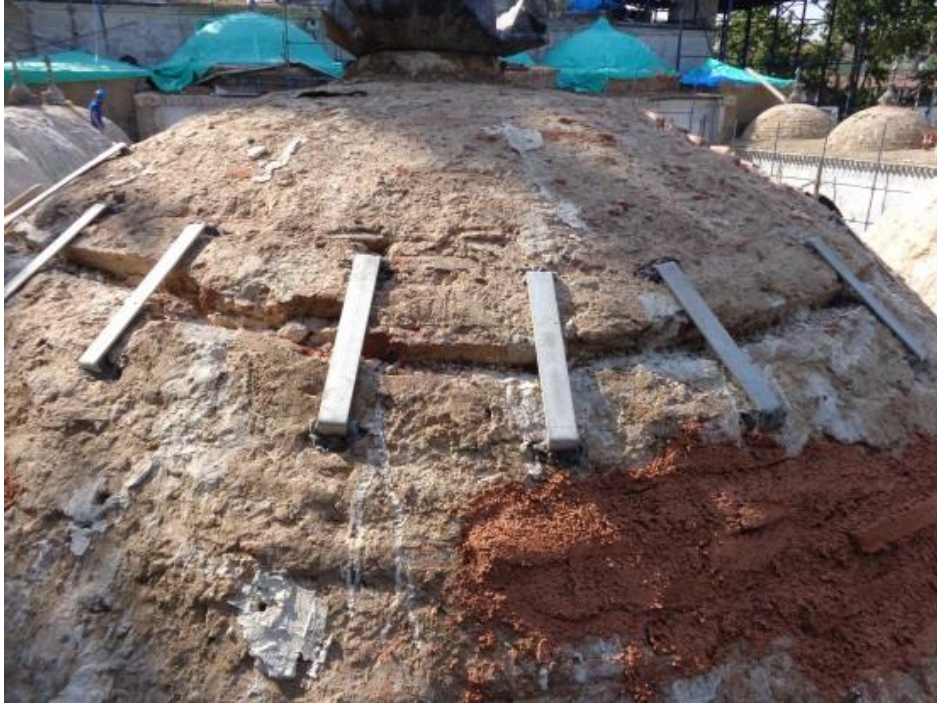
Şekil 6.90 Kubbelerde Kenet Sistemi yapımı (An-sa Abide Arşivi)
