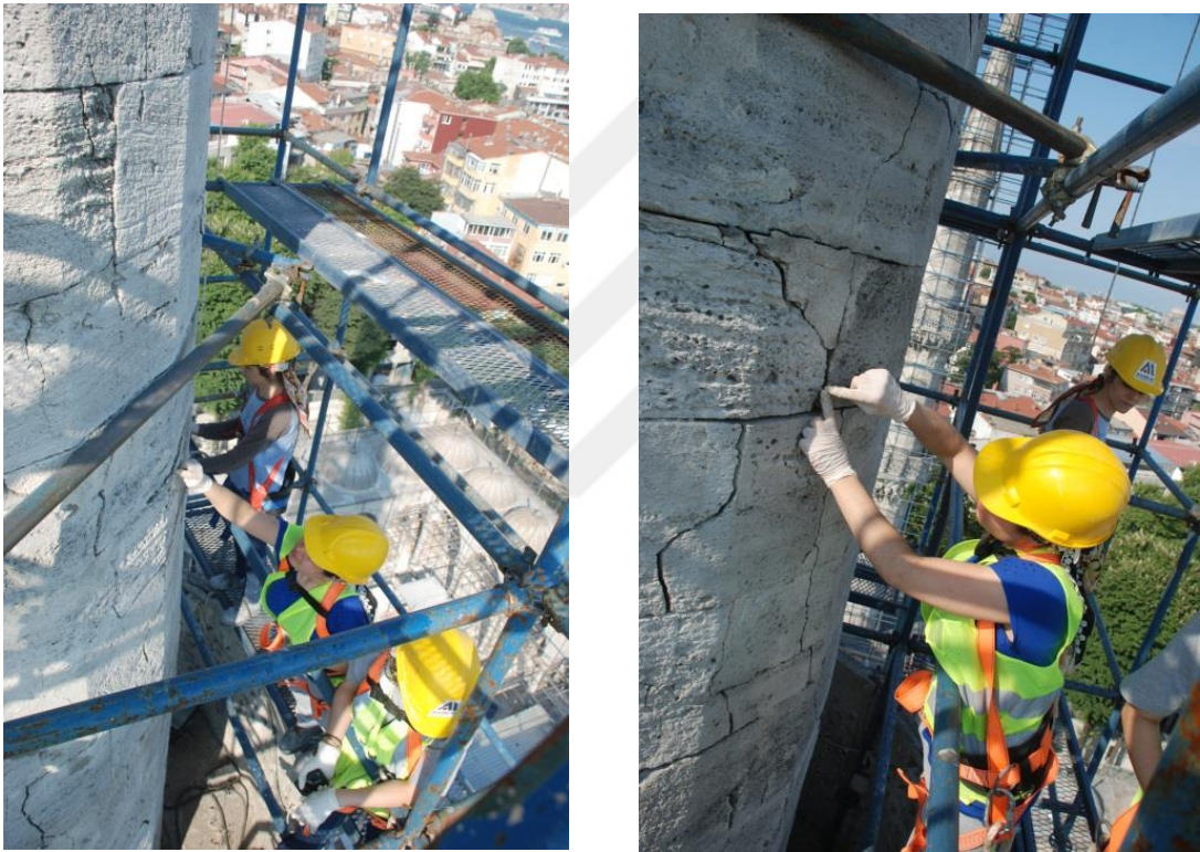
Şekil 6.86 Restorasyon onarımlarında taş tütleme yöntemi (An-sa Abide Arşivi)
