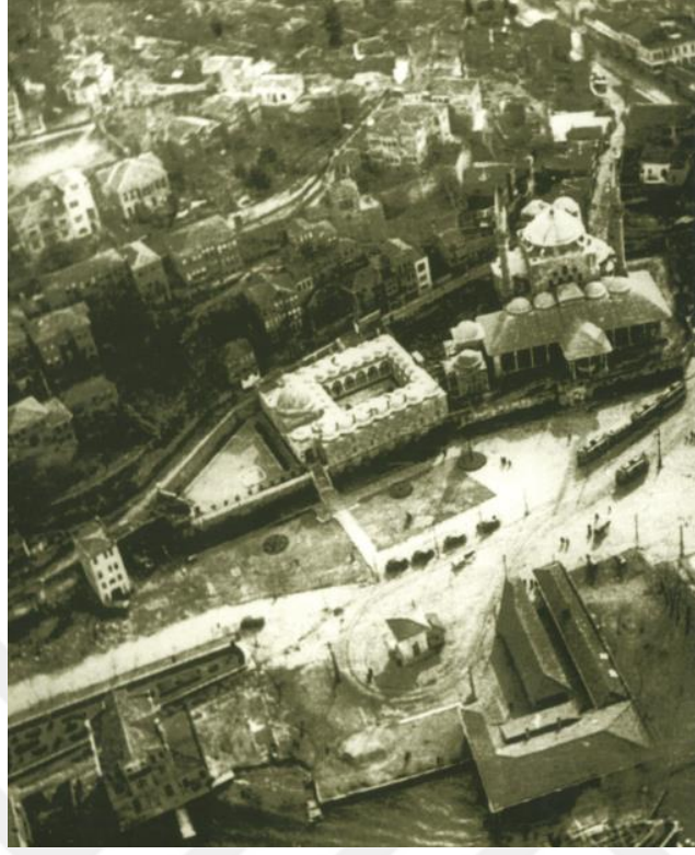
Şekil 4.76 Mihrimah Sultan Külliyesi'nin havadan görünümü (Vakıflar Arşivi, 1970)
