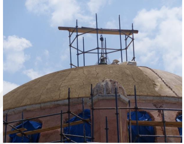
Şekil 6.89 Üst örtü sisteminde kurşun kaplamasının aşamaları (An-sa Abide Arşivi)
