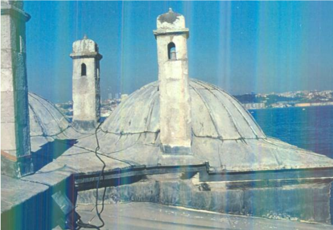
Şekil 5.58 Şemsi Ahmed Paşa Külliyesinin üst örtüsünde oluşan bozulmaların görünümü (Acar Avunduk, 1990)
