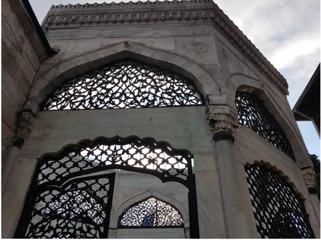
Şekil 6.115 Valide Sultan Türbesi üst kısmı (Aralık, 2017)
