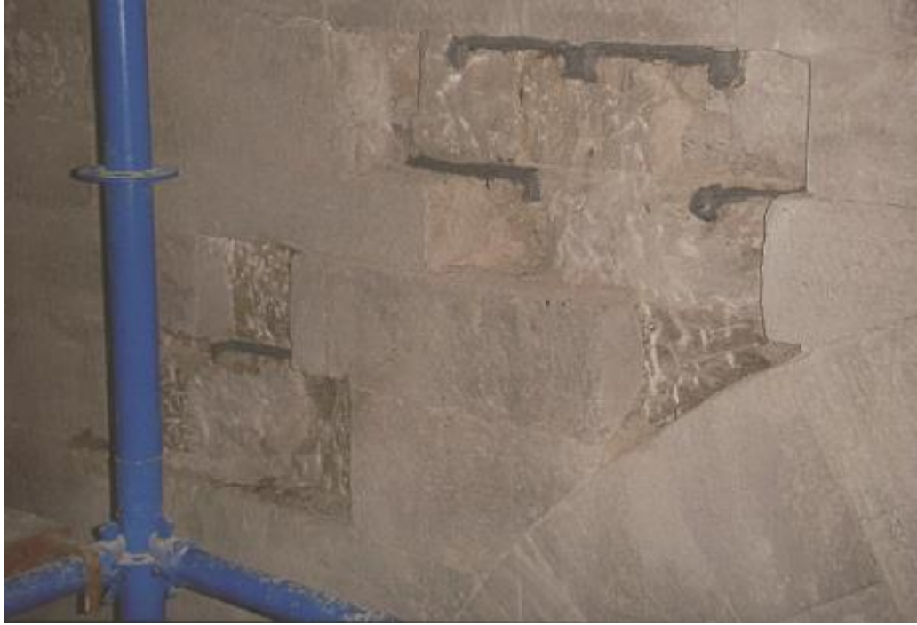
Şekil 5.42 Cami iç duvarlarında oluşan taş boşalmalarının onarım sonrası (Yılmaz Yapı, 2008-2010)
