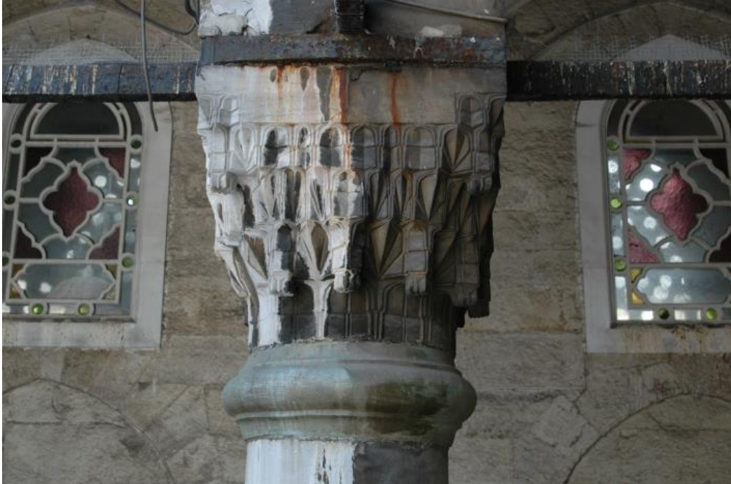
Şekil 6.80 Revaklı avludaki sütun başlıklarının bozulmalarının görünümü (Acar Avunduk Albümü)
