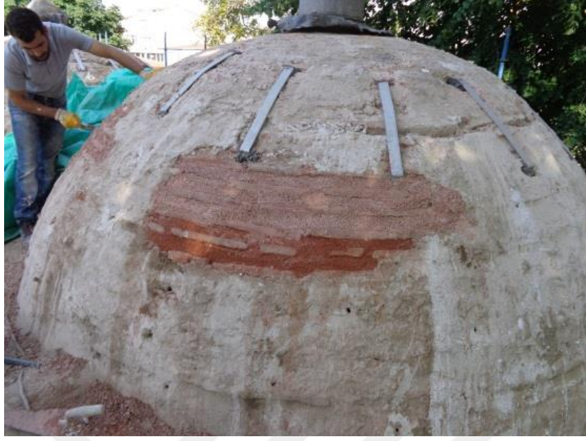
Şekil 6.90 Kubbelerde Kenet Sistemi yapımı (An-sa Abide Arşivi)
