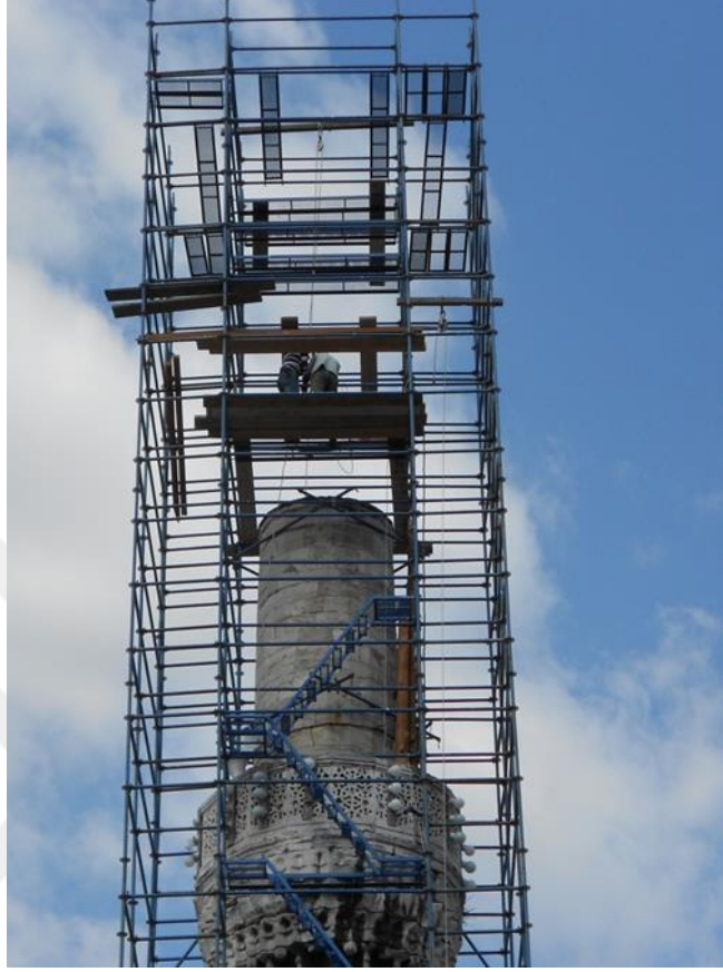
Şekil 4.100 Restorasyon sırasında minare onarım görünümü (Ansa Abide, 2013)
