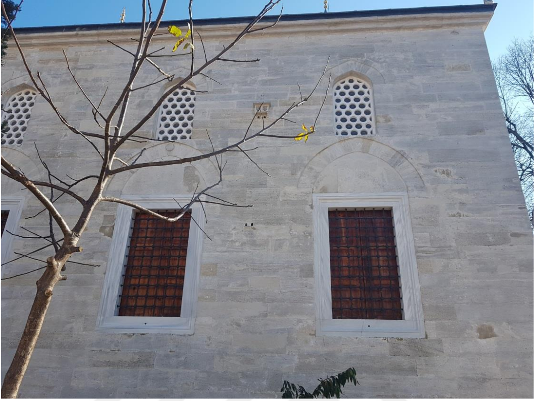
Şekil 6.28 Cami pencerelerinin farklı cephelerden görünümü (Ekim, 2017)
