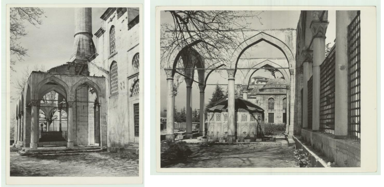
Şekil 4.70 - 4.71 Şadırvan ve dış revakların çatısının sökülmüş olduğu dönem (Vakıflar Arşivi, 1958)
