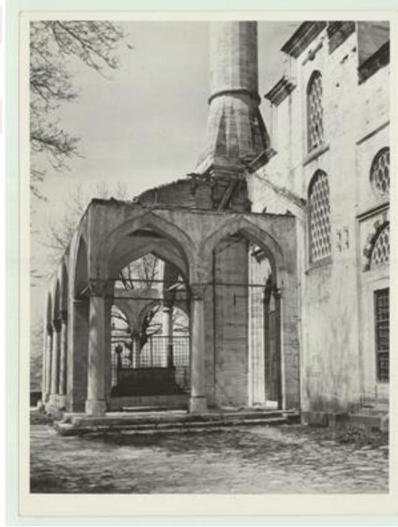
Şekil 4.55 Dış revak çatısı 1958 (Vakıflar Arşivi)
