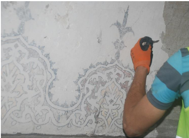
Şekil 6.88 Kubbelerde enjeksiyon yapımı (An-sa Abide Arşivi)
