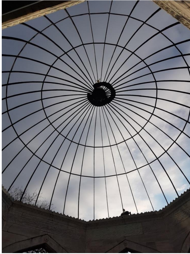
Şekil 6.116 Valide Sultan Türbesi üst kısmı (Aralık, 2017)
