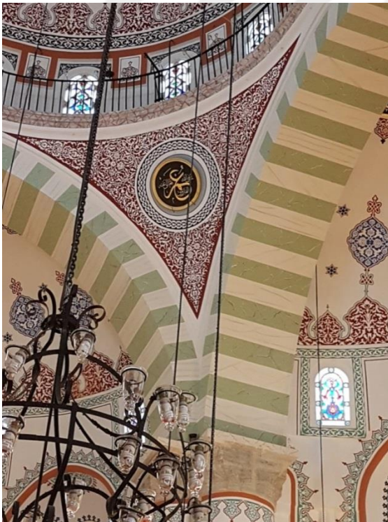
Şekil 4.50 Mihrimah Sultan Cami taşıyıcı fil ayakları ve kemerler (Aralık, 2017)
