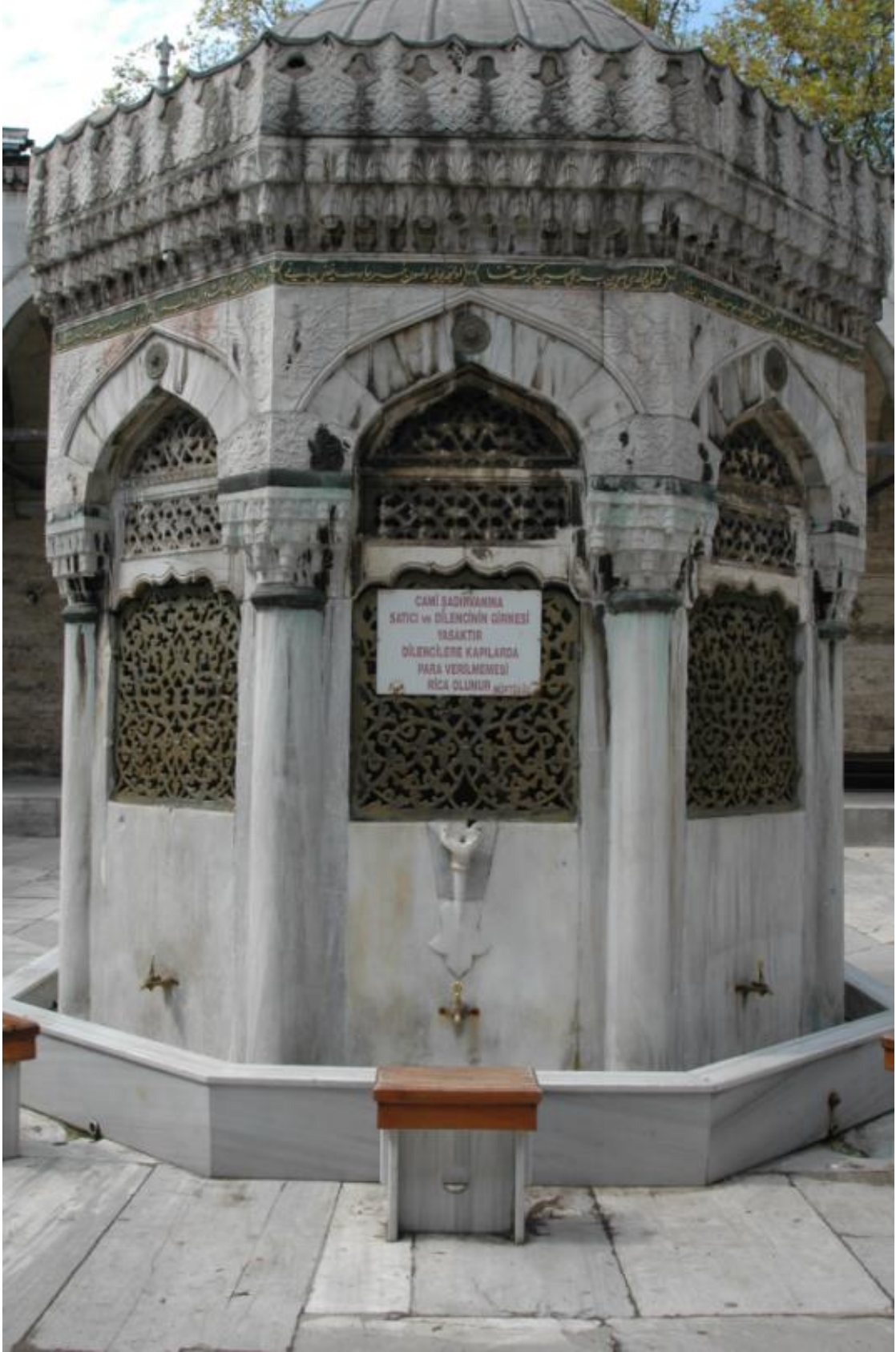
Şekil 6.78 Şadırvanın restorasyon öncesi görünümü (Vakıflar Arşivi)
