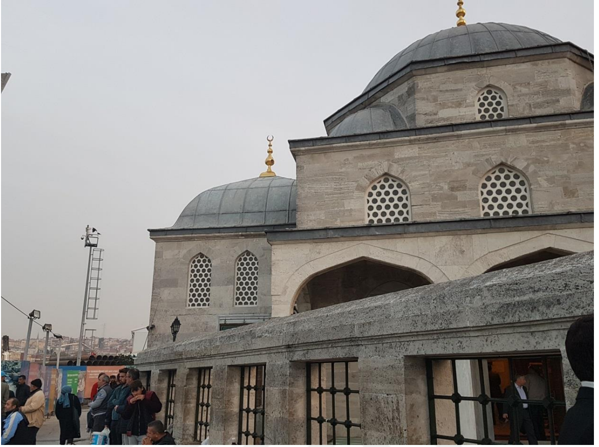
Şekil 5.12 Şemsi Ahmed Paşa Cami deniz tarafı cephe görünümü (Kasım, 2017)
