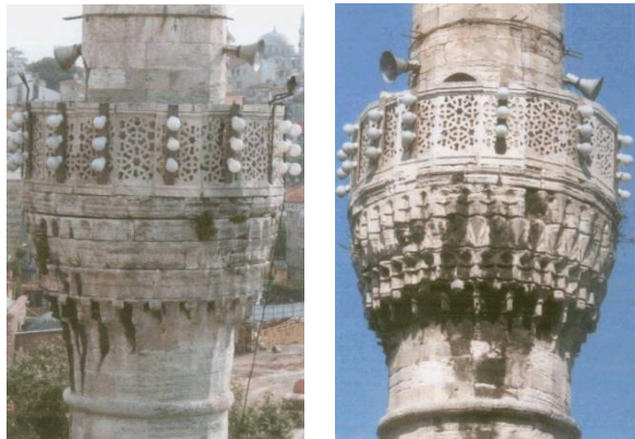
Şekil 4.61 Minare onarım öncesi (Vakıflar Arşivi, 2008)
