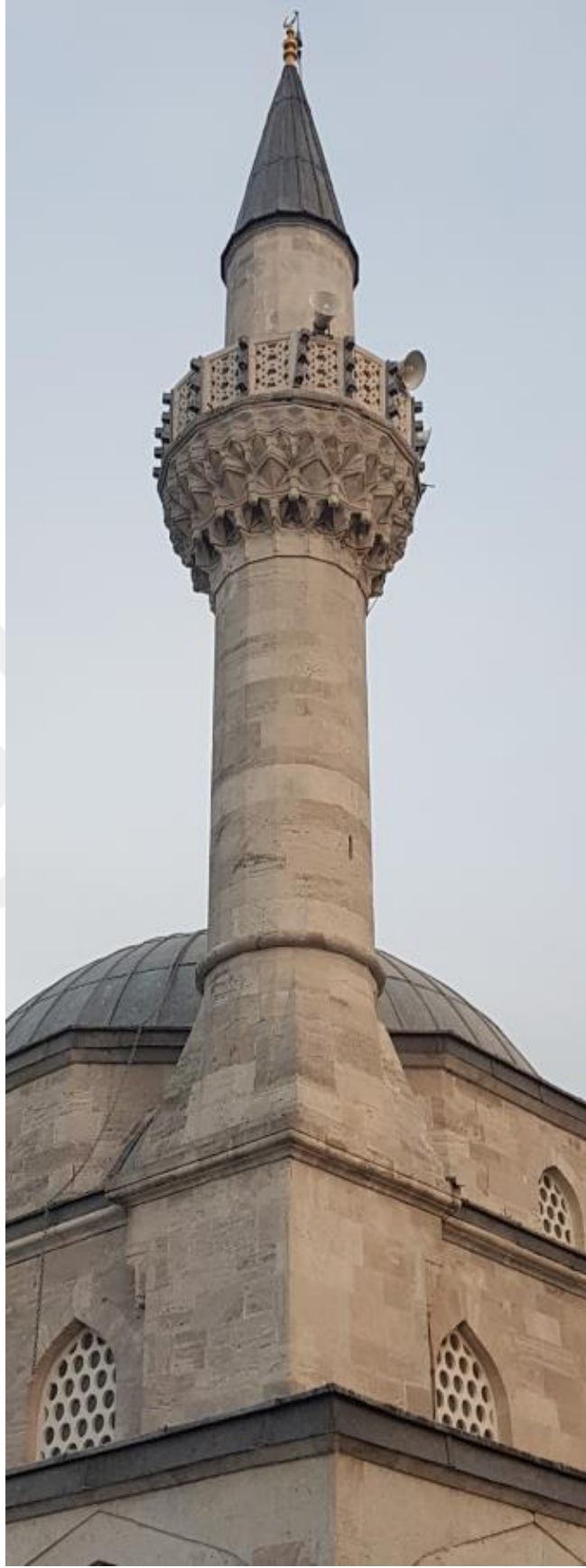
Şekil 5.14 Minare kaidesi ve gövdesinin görünümü (Kasım, 2017)
