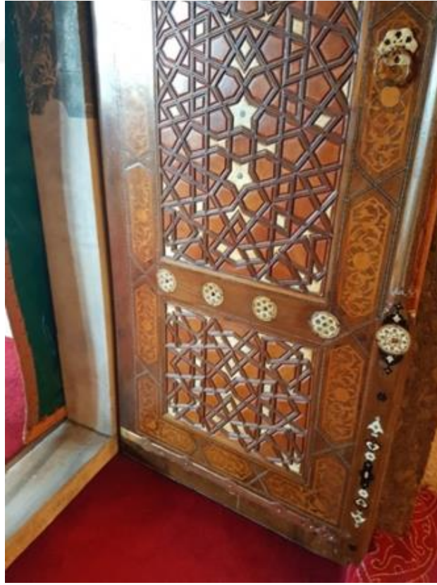
Şekil 4.14 Taç kapıdaki filatolar ve sedeflerin görünüşü (Kasım, 2017)
