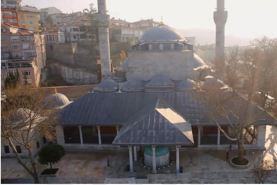
Şekil 4.7 Mihrimah Sultan Cami Ana Giriş Cephesi (Kasım, 2017)
