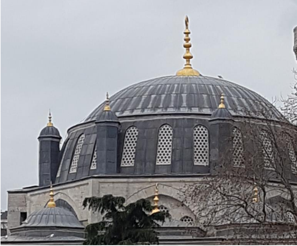
Şekil 6.69 Cami üst örtü kurşunların görünümü (Kasım, 2017)
