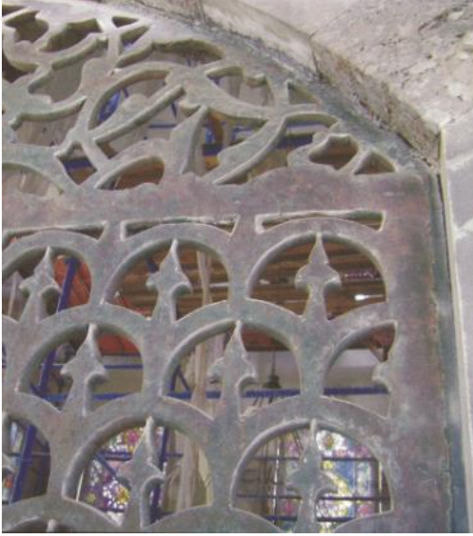
Şekil 5.32 Demir işçiliği restorasyon öncesi
