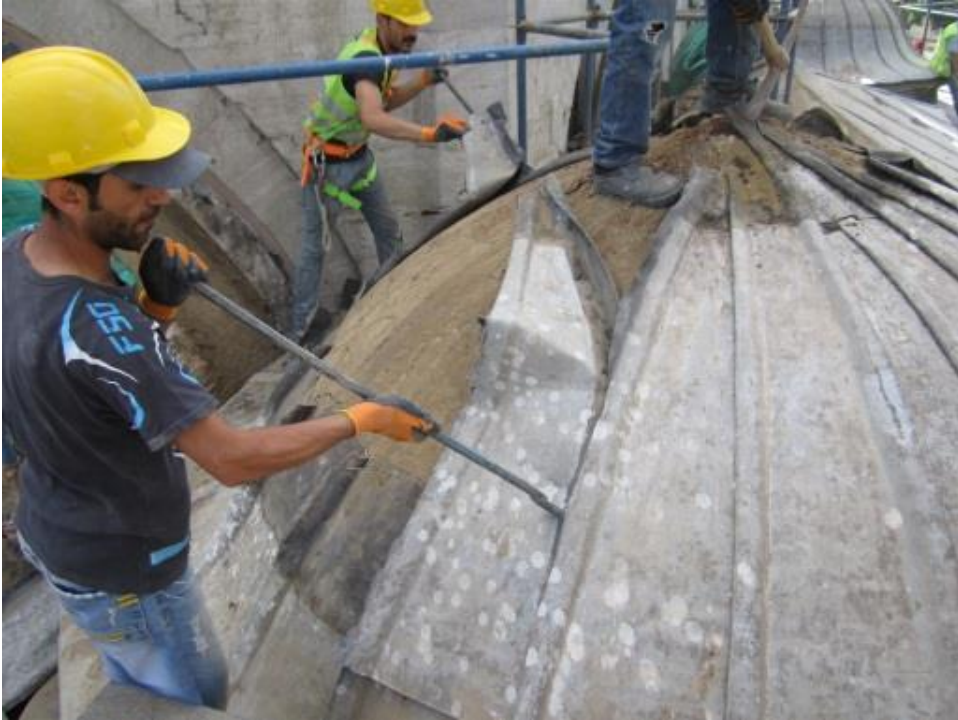
Şekil 6.81 Kurşun sökümü ve yapılan gerekli müdahaleler (An-sa Abide Albümü)
