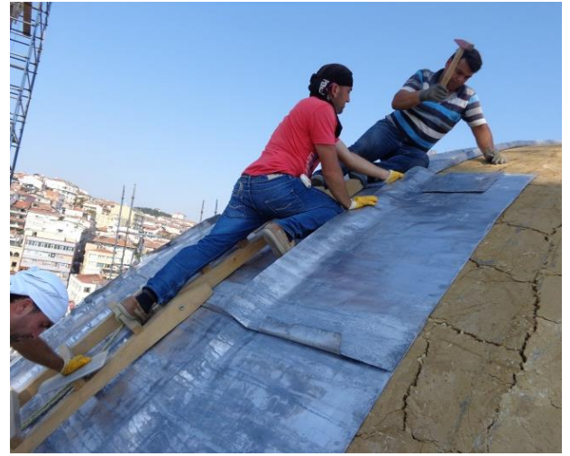
Şekil 6.89 Üst örtü sisteminde kurşun kaplamasının aşamaları (An-sa Abide Arşivi)
