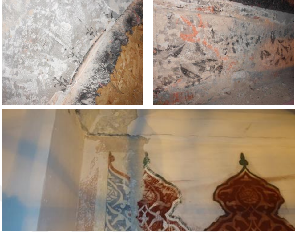
Şekil 4.60 Mihrap Üstü raspaı restorasyon sırasında (Ansa Abide, 2012)
