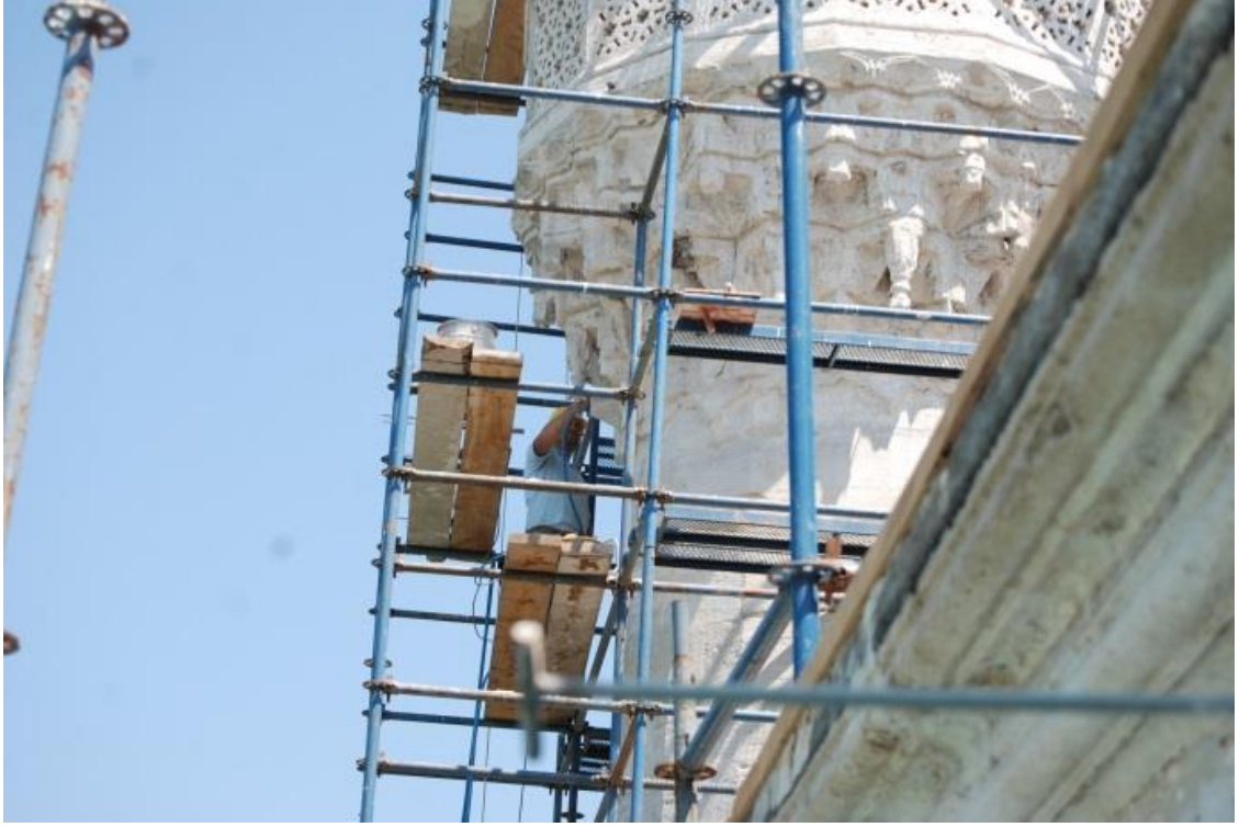
Şekil 6.97 Minare mukarnas sarkıtlarının onarım görünümü (An-sa Abide Arşivi)
