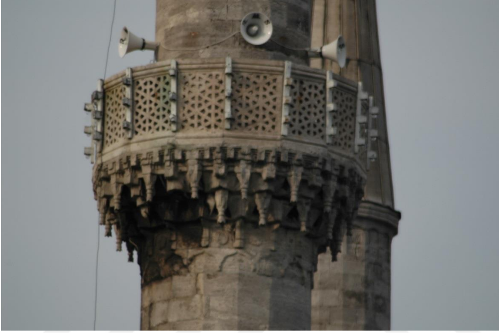
Şekil 6.76 Minarenin Restorasyon öncesi bozulmalarının görünümü (Vakıflar Arşivi)
