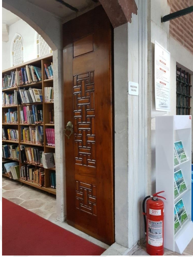
Şekil 5.55 Medresenin dersane bölümünün kapısı ve kitabesi (Ocak, 2018)
