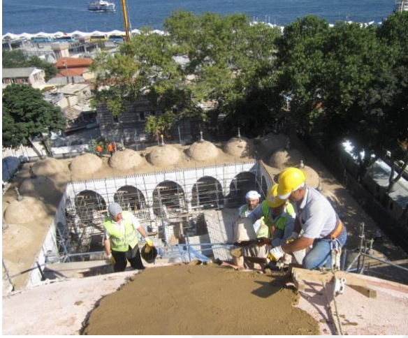
Şekil 6.89 Üst örtü sisteminde kurşun kaplamasının aşamaları (An-sa Abide Arşivi)
