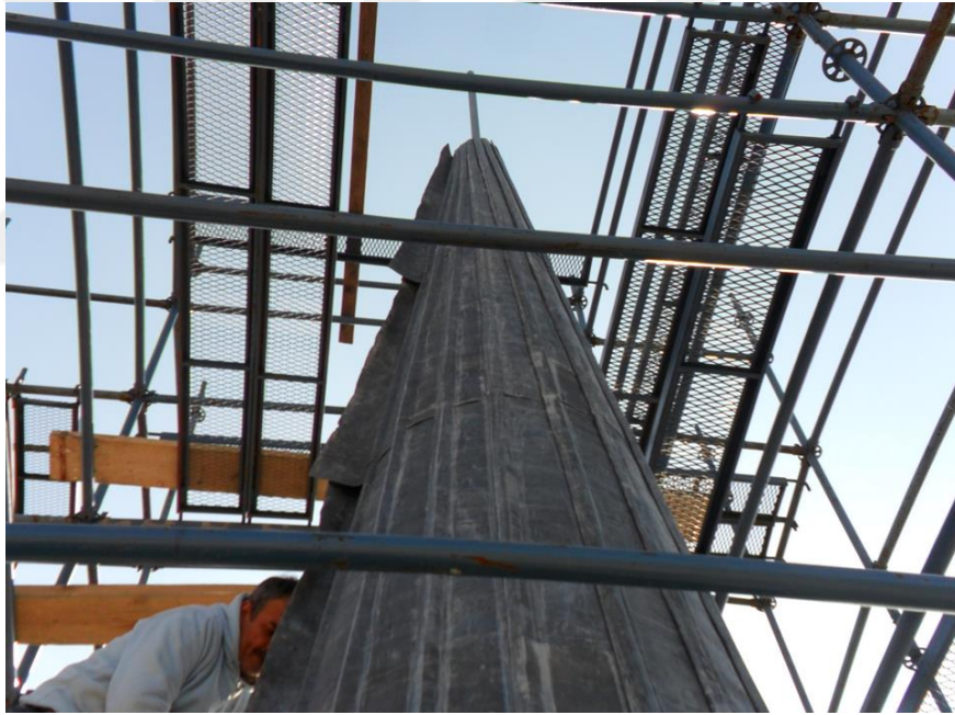
Şekil 4.104 Minare k lahı yapım aŐamaları (Ansa Abide, 2013)
