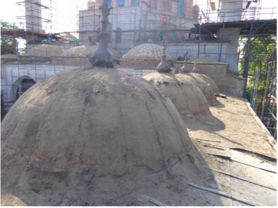
Şekil 6.81 Kurşun sökümü ve yapılan gerekli müdahaleler (An-sa Abide Albümü)
