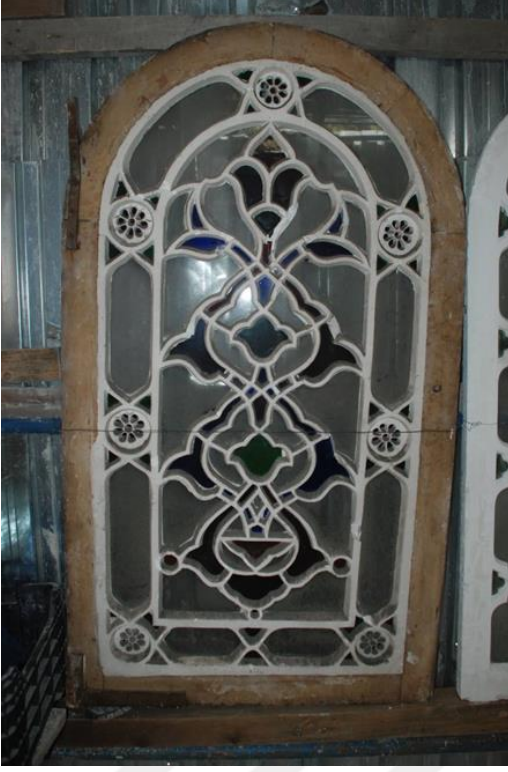
Şekil 4.106 İçlik pencere onarım sonrası (An-sa-Abide, 2012)
