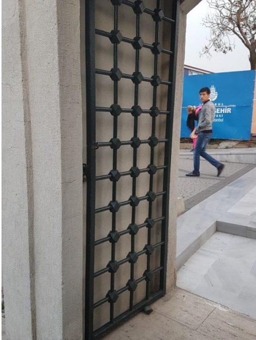
Şekil 5.19 - 5.20 Külliye'nin cadde yönündeki avlu giriş kapısı ve kapının lokmalı parmaklıklarının görüntüsü (Kasım, 2017)
