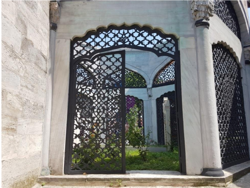
Şekil 6.112 Gülnuş Emetullah Valide-i Sultan Türbesi (Kasım, 2017)
