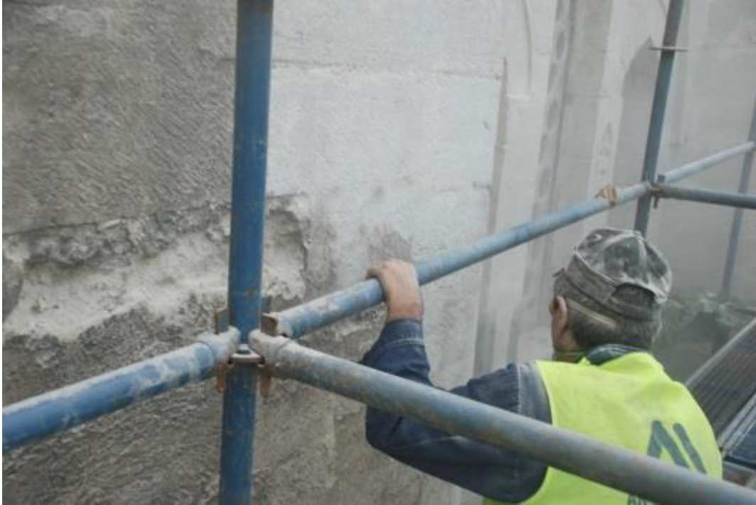
Şekil 6.84 Dış Cephe Temizliği (An-sa Abide Arşivi)
