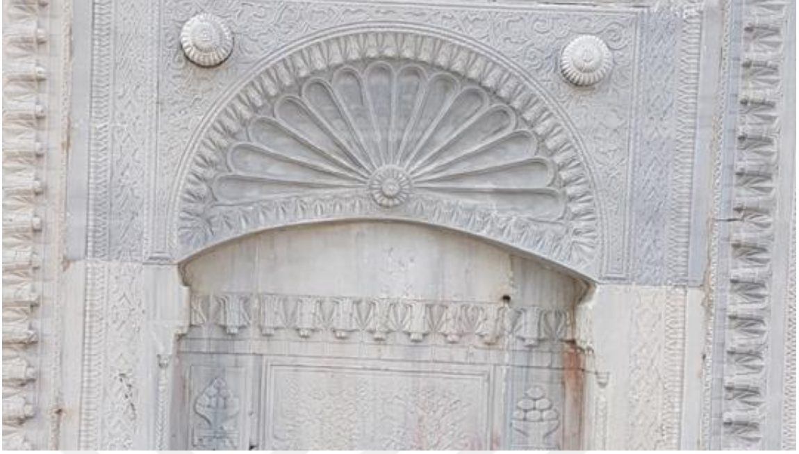
Şekil 6.126 Çeşmenin restorasyon sonrası (Aralık, 2017)
