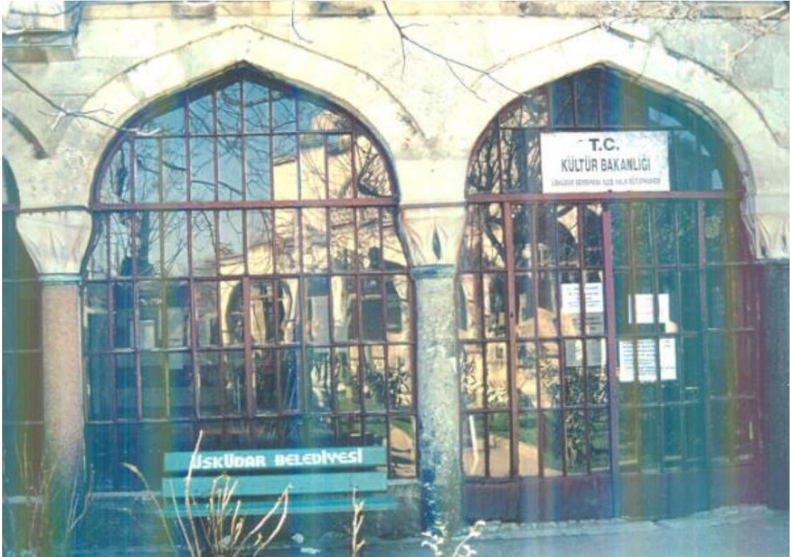
Şekil 5.60 Kütüphanenin demir doğramalı camekanlı hali (Acar Avunduk, 1990)
