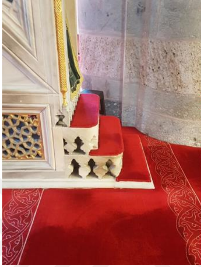
Şekil 4.23 Minberin merdiven basamaklarındaki zambak detayı (Kasım, 2017)
