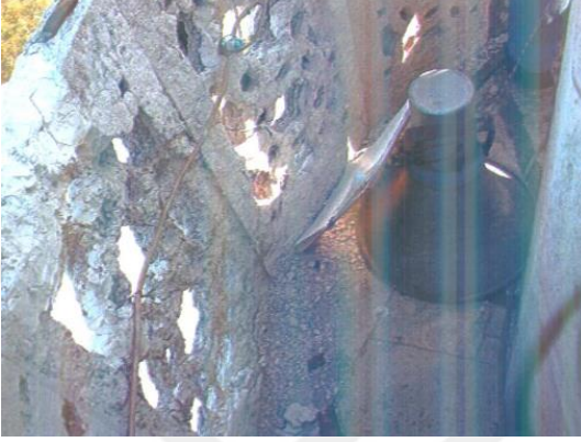
Şekil 5.36 Minare şerefe korkulukları bozulmaları
