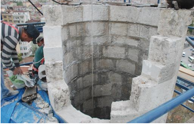
Şekil 4.102 Minare petekte ahşap hatıl çakılması (Ansa Abide, 2013)
