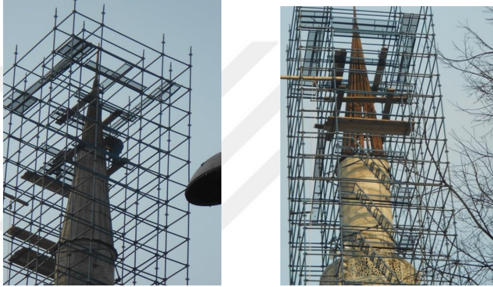
Şekil 4.98 Restorasyon sırasında minare onarım görünümü (Ansa Abide, 2013 )
