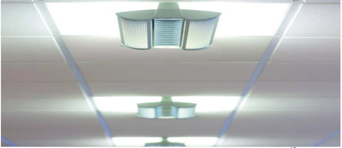
Resim 3.18. Yarı direkt (yarı dolaysız) aydınlatma armatürü 65
