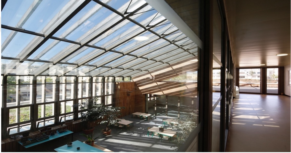
Resim 3.15. Eğitim mekanlarında yeterli ve düzgün dağılımlı doğal aydınlatma örneği. /ECO NURSERY / PRIMARY SCHOOL – France 58 ( https://architizer.com/projects/eco-nursery-primary-school/media/1230841/ )
