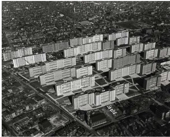
Şekil 2.19 Pruitt-Igoe Yerleşimi, ABD
