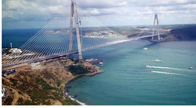
Şekil 3. 10 : İstanbul Yavuz Sultan Selim Köprüsü (URL-7)
