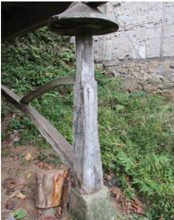
Şekil 4.25. Münferit temelin açığa çıktığı alanlardaki görünümü (Yeşilyurt Tunç, 2017)
