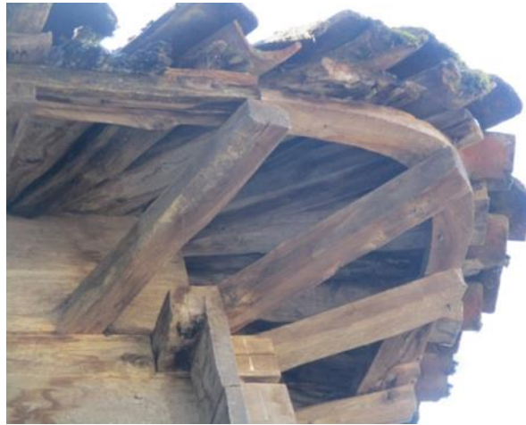
Şekil 4.44. Serender Saçak Dönüşü (Yeşilyurt Tunç, 2017)
