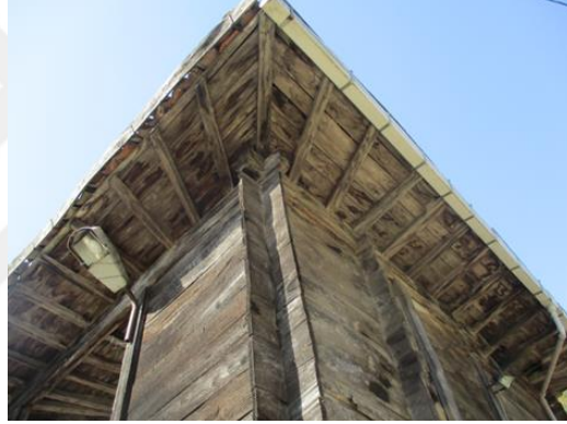
Şekil 4.43. Çatıda kullanılan 25°'lik ahşaplar (Yeşilyurt Tunç, 2017)
