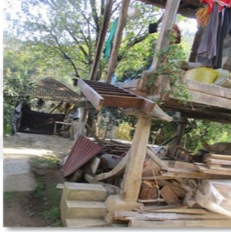
Şekil 4.39. Merdivenin Yerden Kesilmiş Hali (Yeşilyurt Tunç, 2017)
