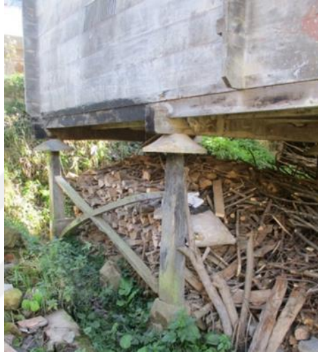
Şekil 4.33. Direkler ve Çalmanlar (Payandalar), (Yeşilyurt Tunç, 2017)
