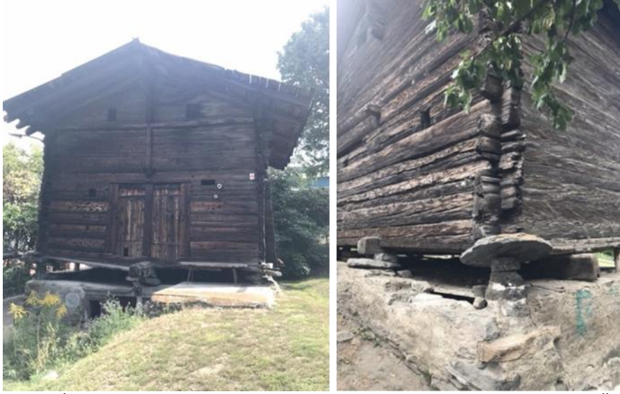
Şekil 4.59. İsviçre, Glis köyünde bulunan ambar yapısı ve teker detayı (Öztürkmen, 2018)
