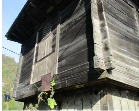
Şekil 4.38. Hava pencerelerinin cephedeki oranını gösteren örnekler (Yeşilyurt Tunç, 2017)
