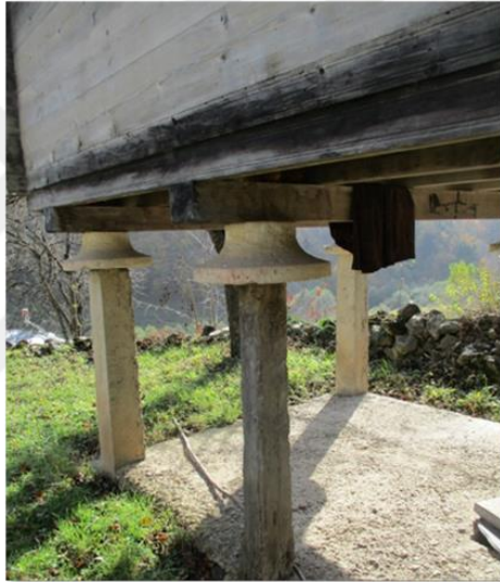
Şekil 4.31. Taş serender tekeri ve betona çevrilen direkler (Yeşilyurt Tunç, 2017)
