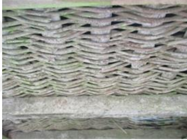
Şekil 4.28. Komar çalısı ile yapılmış bir döşeme (Yeşilyurt Tunç, 2017)
