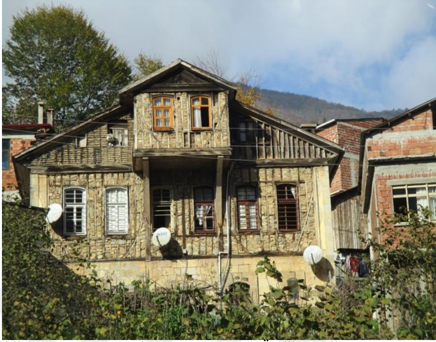
Şekil 3.29. Osman Bey'in Konağı, Yomra-Özdil (Yeşilyurt Tunç, 2017)
