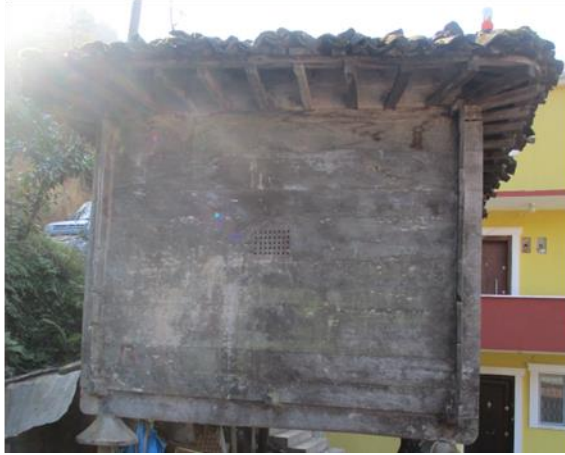
Şekil 4.38. Hava pencerelerinin cephedeki oranını gösteren örnekler (Yeşilyurt Tunç, 2017)
