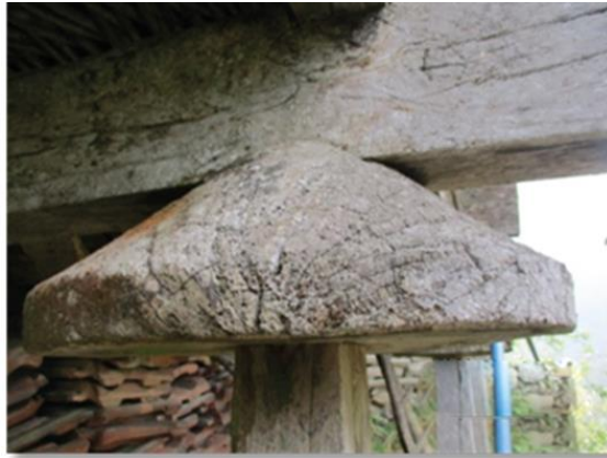
Şekil 4.32. Konik serender tekeri, Yomra-Özdil (Yeşilyurt Tunç, 2017)
