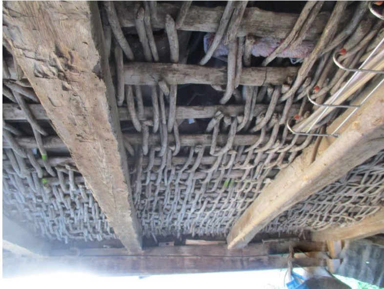
b. Serenderin deforme olmuş döşemesi
