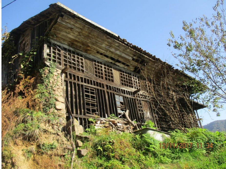
b. Göz dolma sistem ile yapılan Şuayp Karadeniz konutu cephesi.
