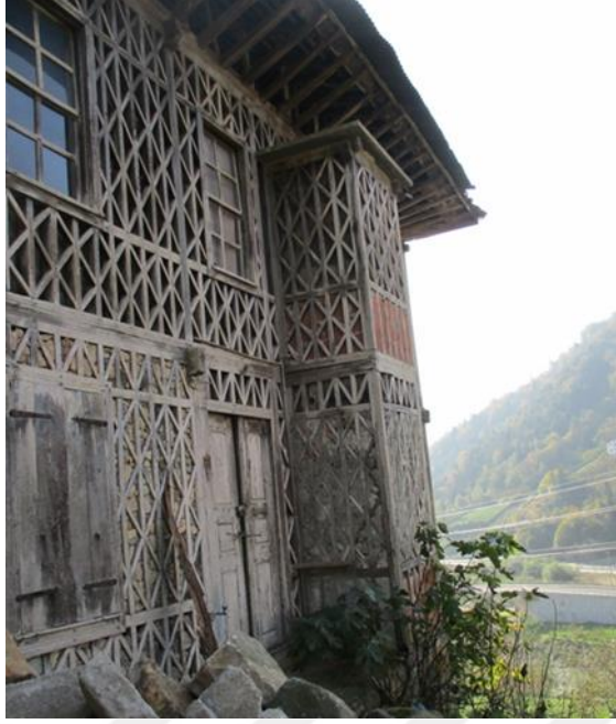
Şekil 3.55. Trabzon, Of, Gürpınar Köyü. Cephe elemanı olarak dışarıdan algılanan tuvalet (Yeşilyurt Tunç, 2017)
