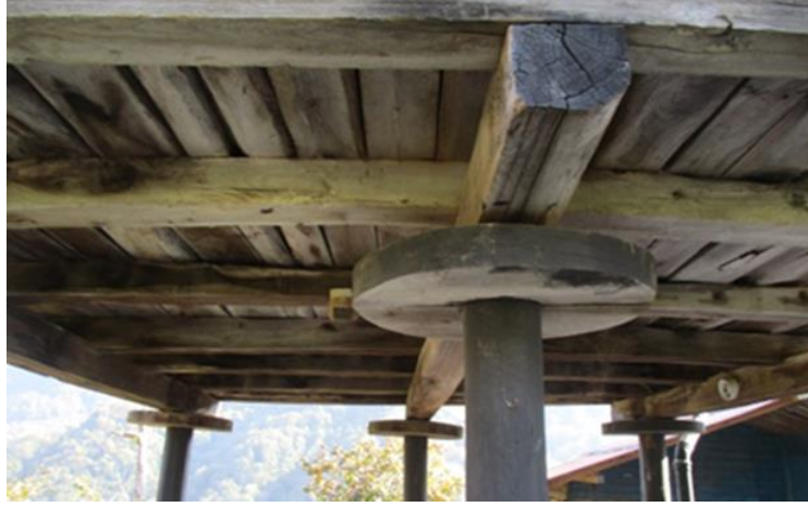
Şekil 4.30. Dairesel serender tekeri, Of- Fındıkoba (Yeşilyurt Tunç, 2017)
