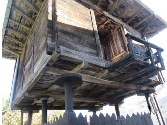
Şekil 4.34. Dairesel Formda Direkler, Of-Fındıkoba (Yeşilyurt Tunç, 2017)
