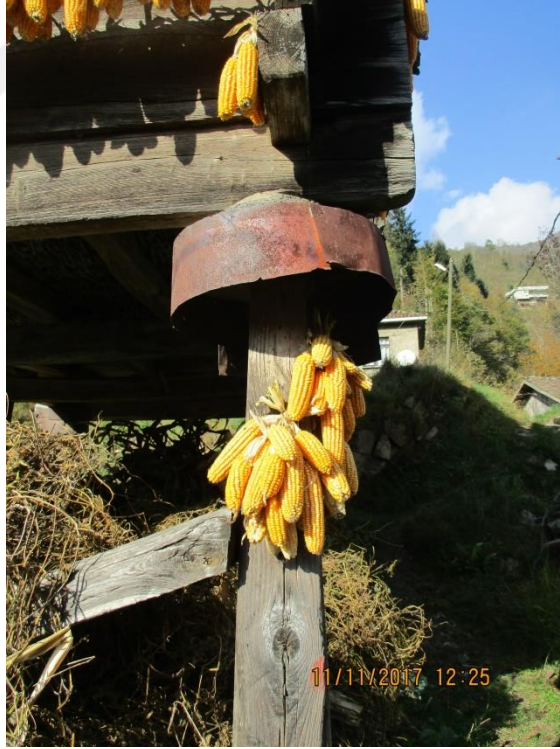
d. b'de bulunan serenderin tekeri, koruma amaçlı kaplanmış
