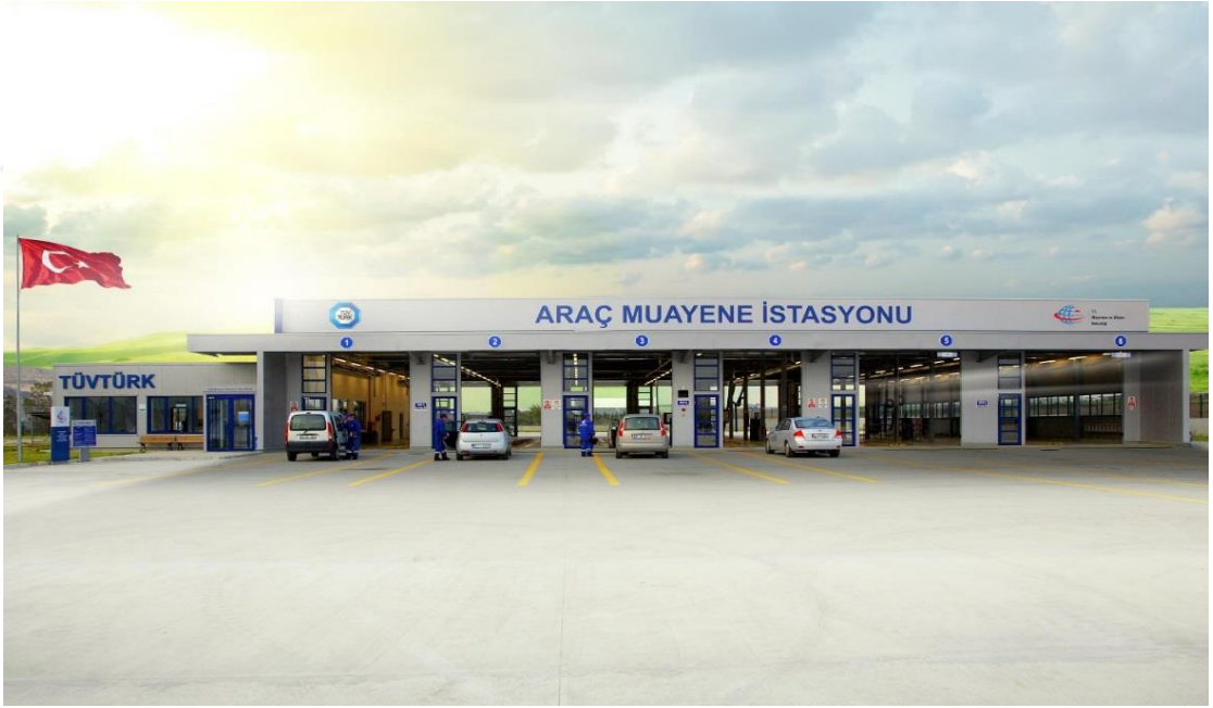
Şekil 5. Sabit Araç Muayene İstasyonu – Kanal Yapısı P4T2
