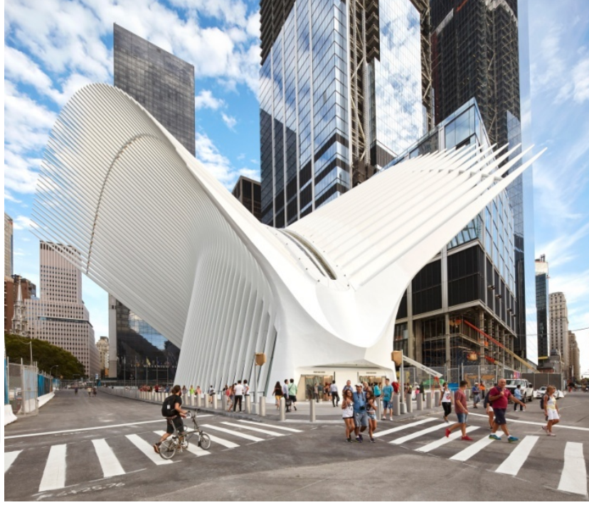
Şekil 4.5. Santiago Calatrava tarafından tasarlanan New York Dünya Ticaret Merkezi istasyonu girişi (Url-8)
