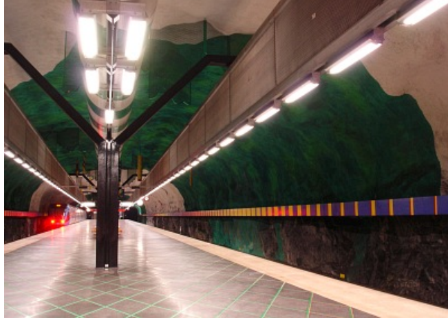
Şekil 4.29. Stockholm metrosunun peron katında birden fazla rengin mekânda kullanılmasıyla mekândaki monotonluğun önüne geçilmesi (Url-12)
