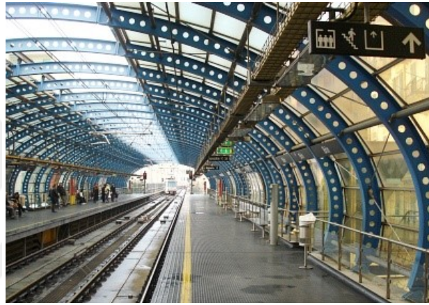
Şekil 4.51. Cenova metro istasyonunun peron katındaki cam kubbe ile mekâna doğal ışığın sokulması (Url-18)
