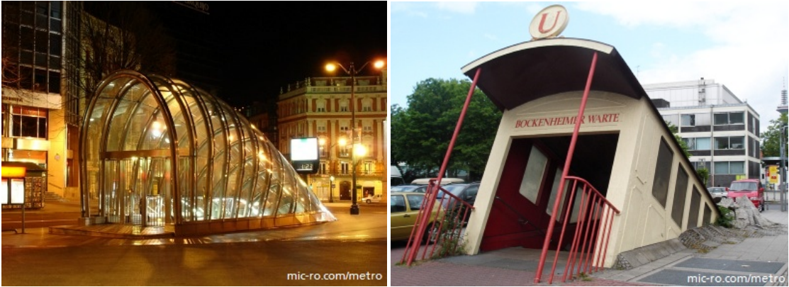
Şekil 4.37.-4.38. Metro istasyonlarının giriş mekânları sırasıyla Bilbao metrosu, Frankfurt metrosu (Url-15)
