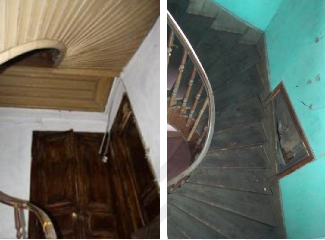
(a) (b) Şekil 5. 42: (a), (b) Ahşap Merdiven (Sarızeybek, 2017).
