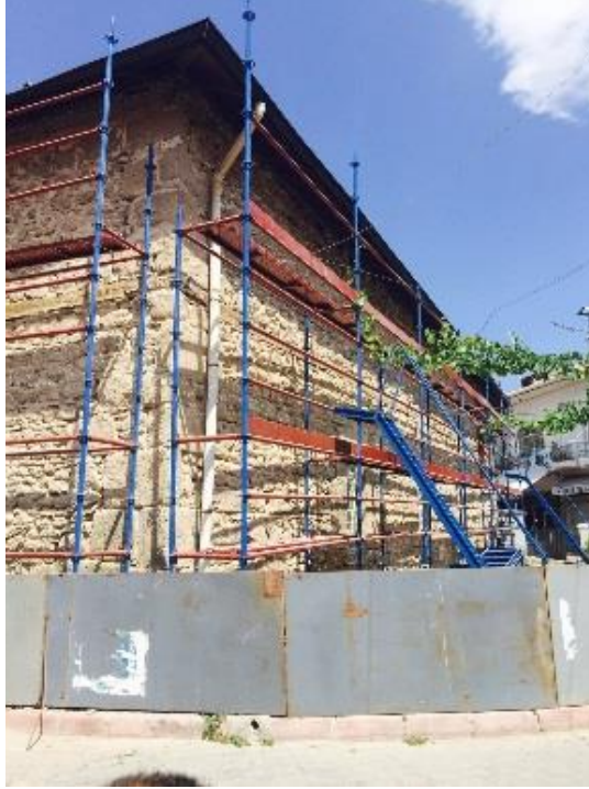
Şekil 4. 25: Kırşehir Çarşı Camii Restorasyonu Dış Cepheden Bir Görünüş (URL 10)
