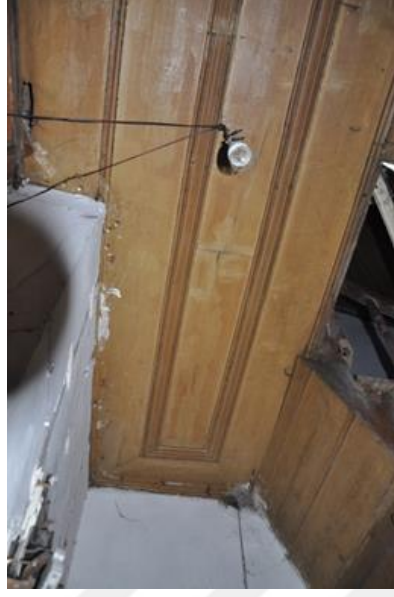
Şekil 5. 105: Merdiven Holü Tavan Kaplaması (Sarızeybek, 2017).
