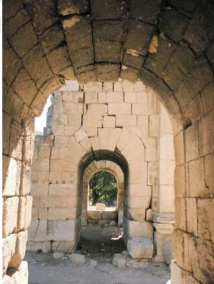
Şekil 3.35: “Tonozda derz ayrılmaları (Anavarza)” (Sesigür, Çelik, & Çılı, 2007).
