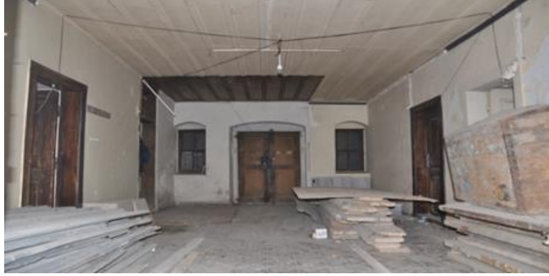
Şekil 5. 91: Planda “1” ile Gösterilen kapı. Müştemilata Geçiş Kapısı (Sarızeybek, 2017).
