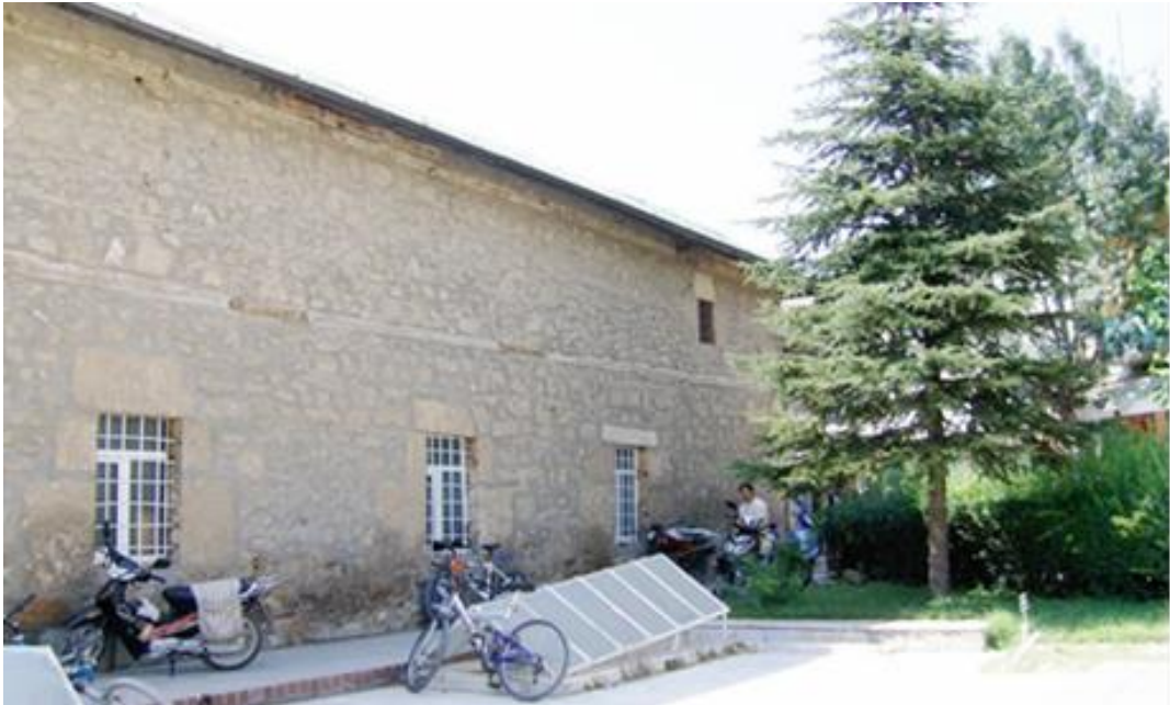
Şekil 4. 18: Doğu Cephesi (Korar, 2007).
