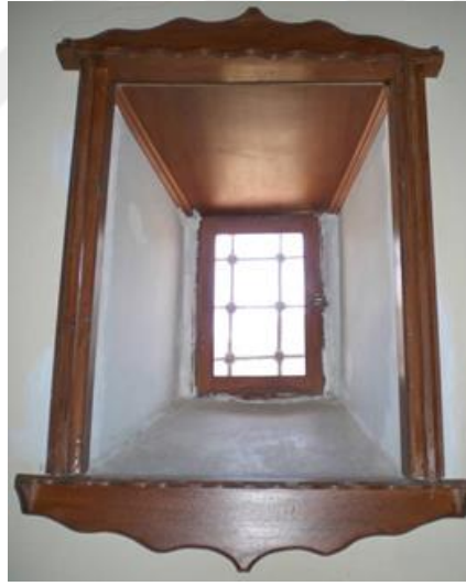
Şekil 4. 59: Mahfil Katı Pencere İ Cephelerindeki Muhdes Ahşap Söveleri (Korar, 2007).
