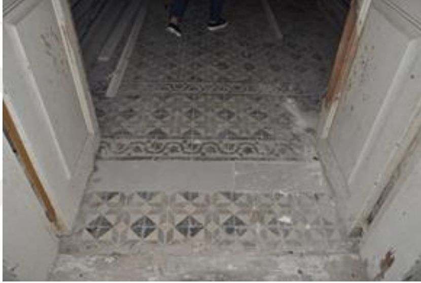
Şekil 5. 9: Zemin Kat Karo Siman Zemin Kaplaması (Sarızeybek, 2017).
