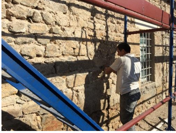
Şekil 4. 23: Kırşehir Çarşı Camii Restorasyonu Dış Cepheden Bir Görünüş (URL 10).
