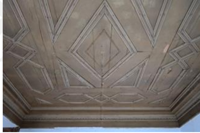
Şekil 5. 106: İkinci Kat Tavan Kaplaması (Sarızeybek, 2017).
