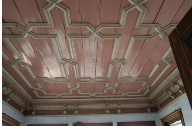
Şekil 5. 102: İkinci Kat Tavan Kaplaması (Sarızeybek, 2017).
