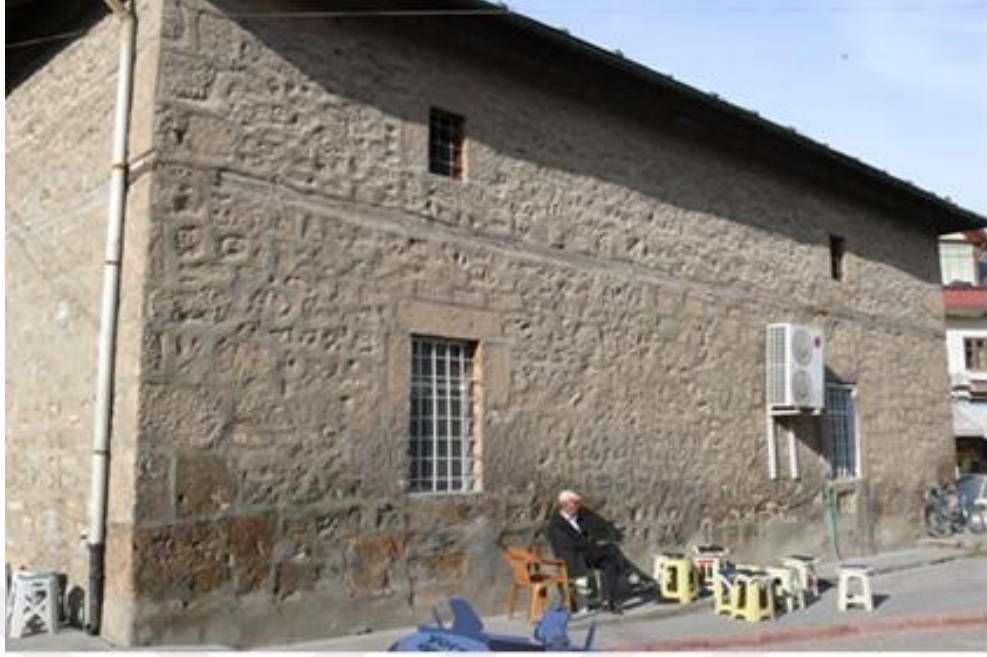
Şekil 4. 17: Güney Cephesi (Korar, 2007).
