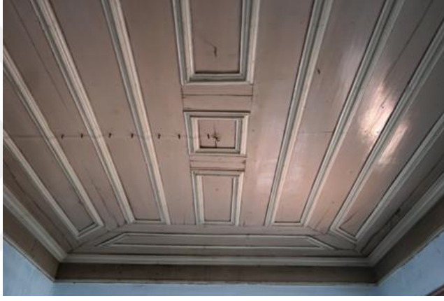
Şekil 5. 103: İkinci Kat Tavan Kaplaması (Sarızeybek, 2017).
