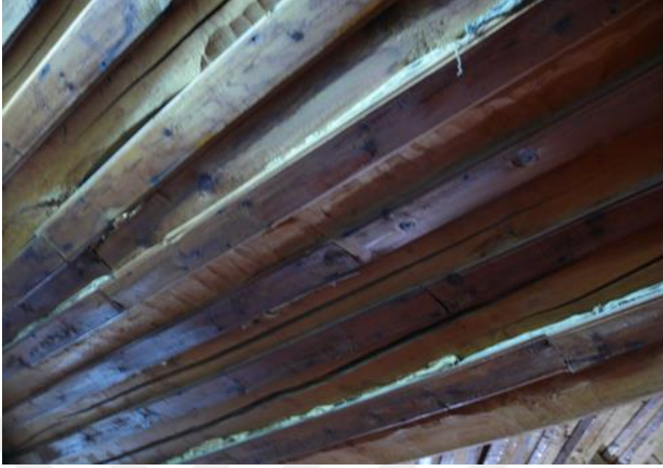
Şekil 4. 43: Tütekli Örtü- Ahşaplarda Açılmalar (Korar, 2007).
