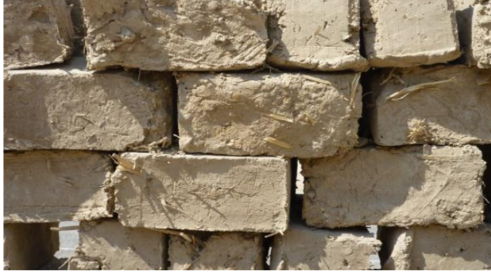
Şekil 3. 14: Kerpiç Duvar (Çağala, 2006).
