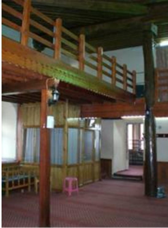
Şekil 4. 64: İmam Odası, Ahşap Kafesleri Sökülmüş Mahfil Katı Görünümü (Korar, 2007).
