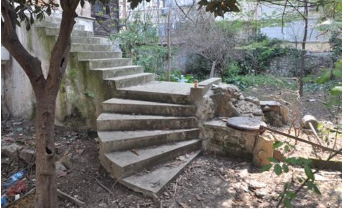
Şekil 5. 111: Giriş Merdiven Basamakları (Sarızeybek, 2017).
