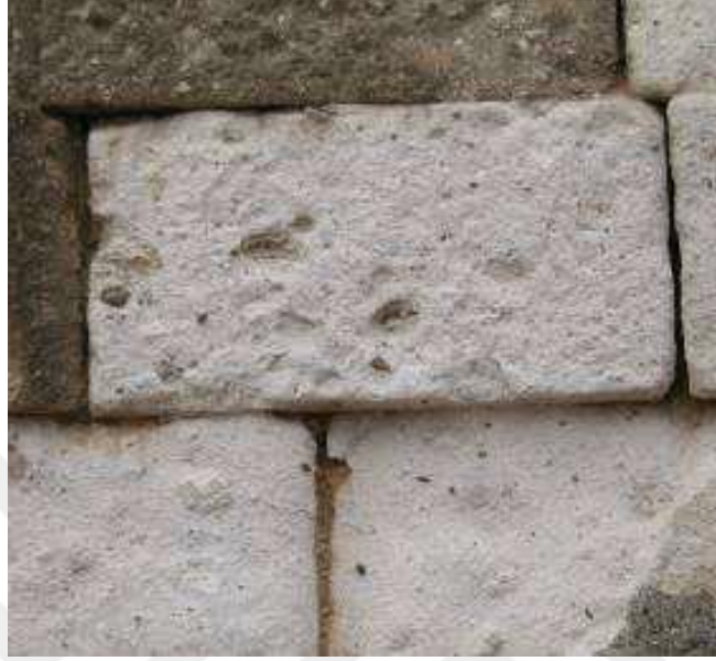
Őekil 3. 20: “ Tař Yzeyinde 5 cm den Az Yzey Kaybı ” (MEB, 2013)
