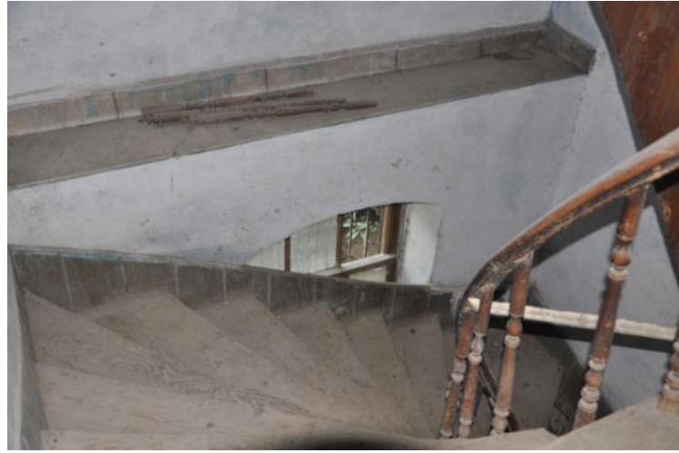
Şekil 5. 7: Merdiven Hattındaki Pencere (Sarızeybek, 2017).
