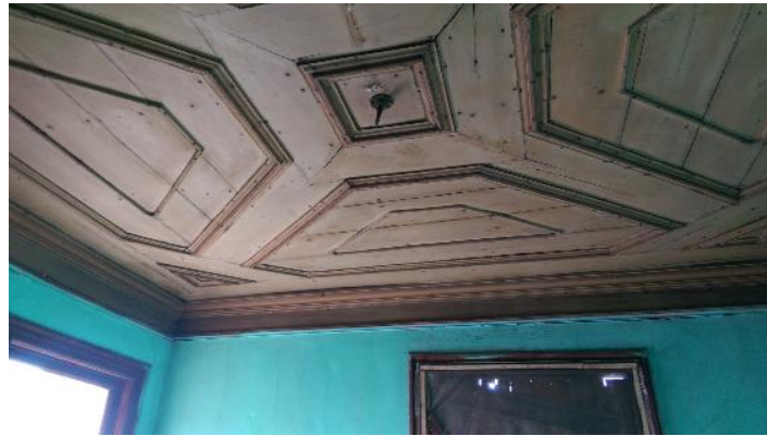
Şekil 5. 107: Merdiven Tavan Kaplaması (Sarızeybek, 2017).
