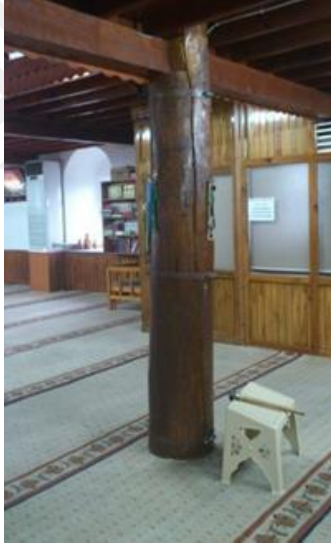
Şekil 4. 42: Ahşap macunu ve Kelepçe Uygulaması Yapılacak Özgün Ahşap Dikmelerden Biri (Korar, 2007).
