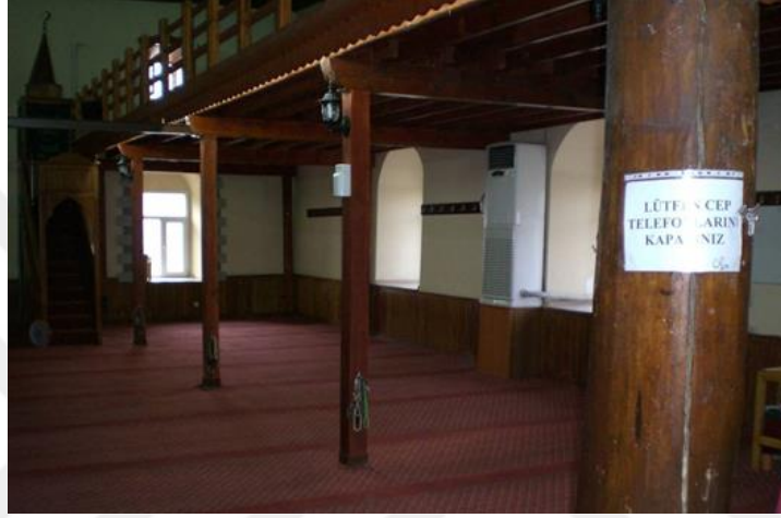
Şekil 4. 58: Uzatılan Mahfil Katının Taşıyan, Muhdes Ahşap Dikmeler (Korar, 2007).
