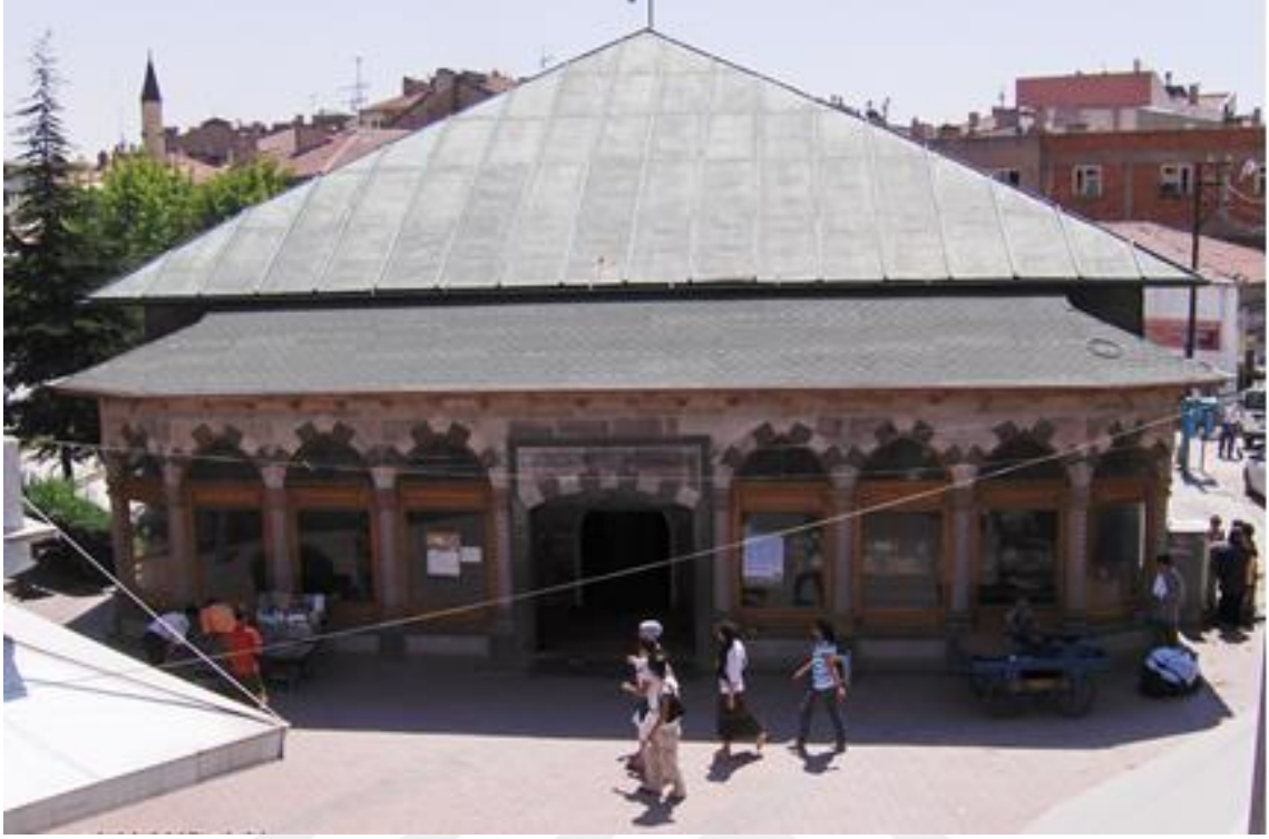
Şekil 4. 5: “Fotoğraf Tarihi Belirsiz, Kırşehir Camii Muhdes Son Cemaat Yeri, Kuzey Cephesi” [Vakıflar Genel Müdürlüğü Raporundan aktaran (Acar, 2018)]
