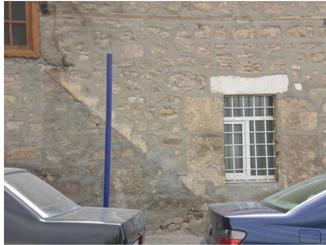
Şekil 4. 53: Mahfil Katına Çıkan Özgün Merdivenin, Batı Cephesinde Kalan İzleri (Korar, 2007).
