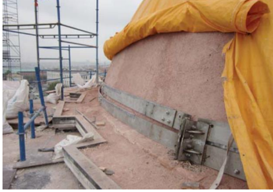
Şekil 3. 33: “Beyazıt Camii Ana Kubbesi Çekme Çemberi Detayı (2013)” (Özel, 2016).
