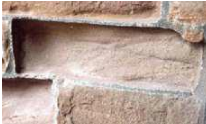
Őekil 3. 21: “ Tař Yzeyinde 5 cm den ok Yzey Kaybı ” (MEB, 2013).
