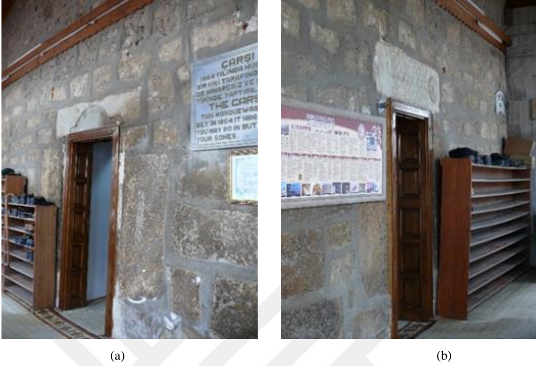
Şekil 4. 48: Giriş Kapısının Sağında ve Solunda Yer Alan kapılar (Korar, 2007).
