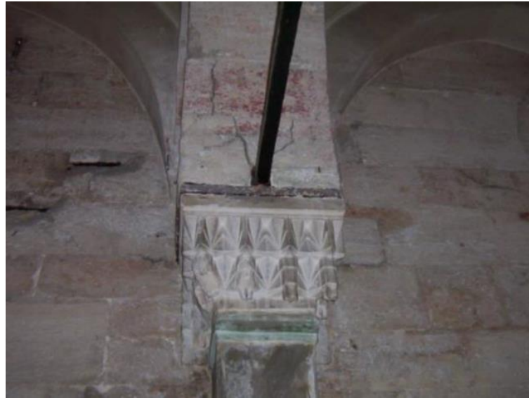
Şekil 3. 37: "Metal Gergilerin Çimento Harci ya da Epoksi İle Birleştirilmesi" (Arun, 2016).
