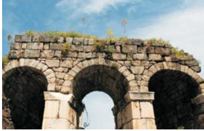
Şekil 3. 36: "İtki Eksikliği Nedeniyle Tonozlarda Hasar (Antalya Kesik Minare)" (Sesigür, Çelik, & Çılı, 2007).
