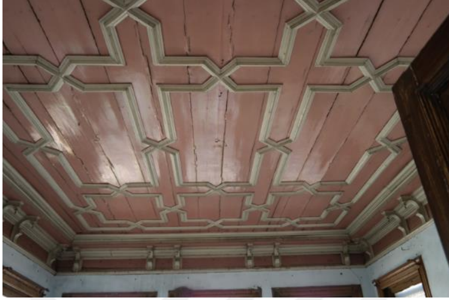
Şekil 5. 45: 2 05 Oda Tavan Kaplaması (Sarızeybek, 2017).
