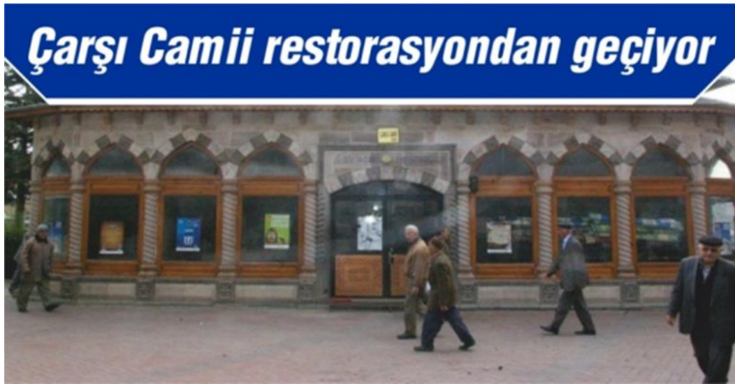
Şekil 4. 22: Kırşehir Çarşı Camii Restorasyona Gireceği Haberi 17 Eylül 2015 (Kırşehir Yeni Yeşilyurt Gazetesi, 2015).
