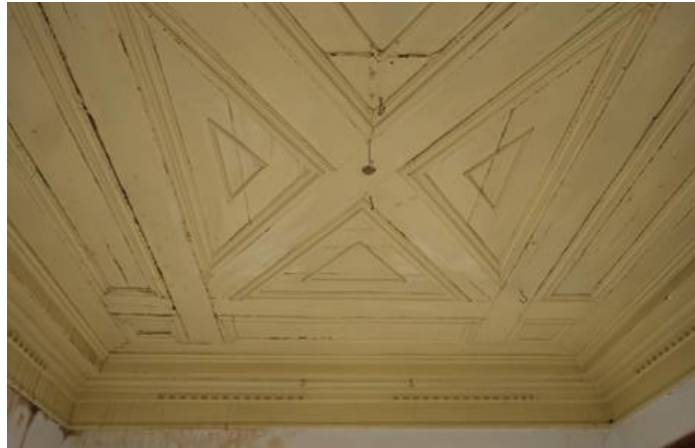
Şekil 5. 104: İkinci Kat Tavan Kaplaması (Sarızeybek, 2017).
