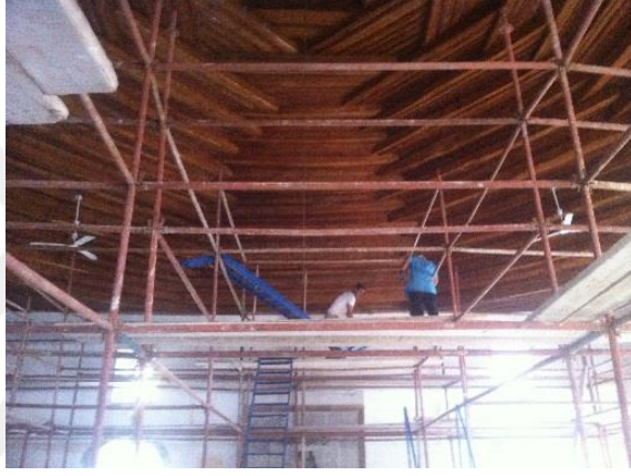
Şekil 4. 24: Kırşehir Çarşı Camii Restorasyonu Ahşap Tütekli Örtüden Bir Görünüş (URL 10).
