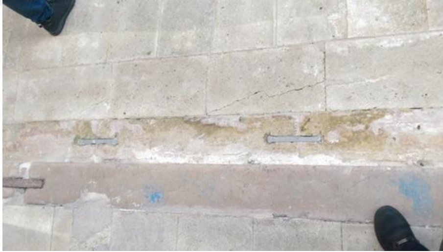
Şekil 3. 28: Atik Valide Şifhanesi Avlusundan Bir Görünüş, Zemin Taşlarını Birbirine Bağlayan Kenetler (Sarızeybek, 2017).
