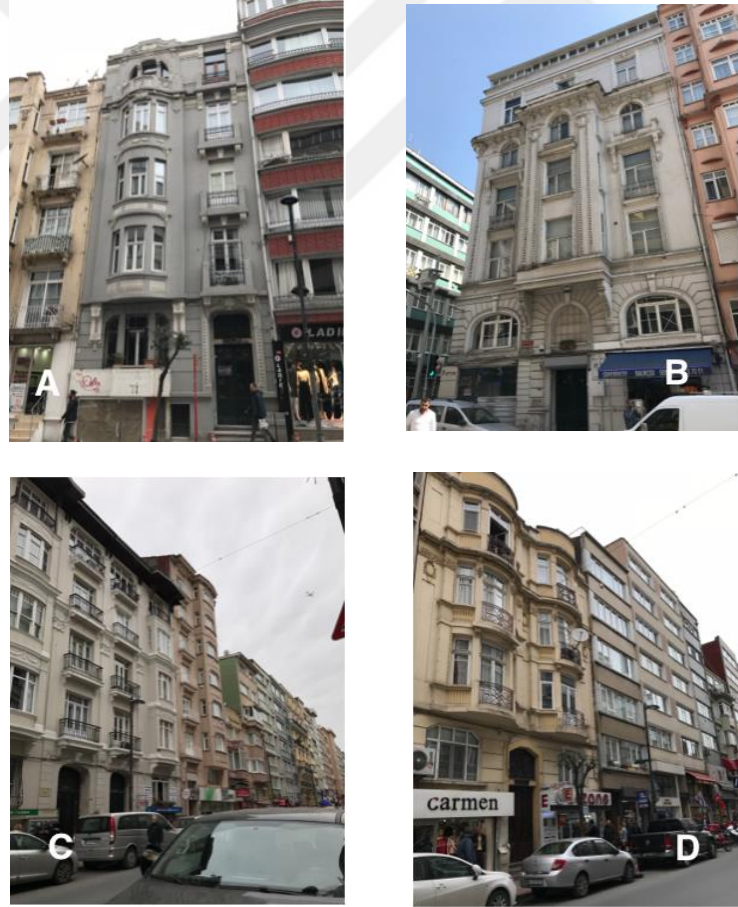
Şekil 4.60. (A),(B) Kurtuluş Ana Caddesi'nde tarihi, kârgir binalar, 27.03.2018. (C),(D) Kurtuluş Caddesi'nde tarihi ve betonarme binalar yan yana, 26.03.2018.
