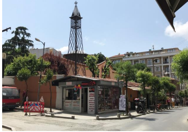
Şekil 3.22. Oniki Apostol Kilisesi, Avukat Caddesi'nden görünüşü, 11.10.2017.
