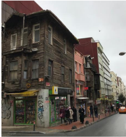
Şekil 4.53. (A) Baruthane Caddesi, Savaş Sokak köşesi, üç adet ahşap bina, 24.03.2018.
