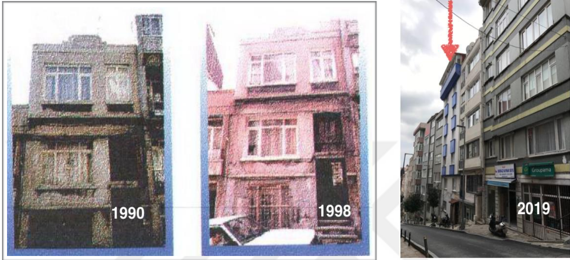
Şekil 4.72. Şahin Sokak'taki bina, 1990-2019, (Tong, 2000), (06.01.2019).
