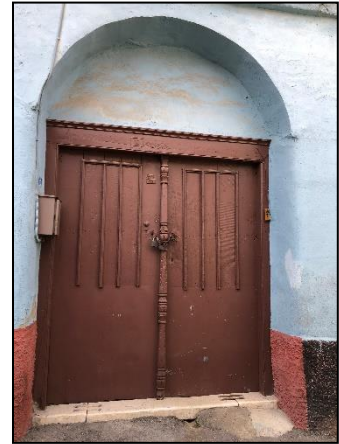
Şekil 3. 71. 118 numaralı ada 5 numaralı parsel ahşap sade giriş kapısı söve örneği (Dizman, 2019)
