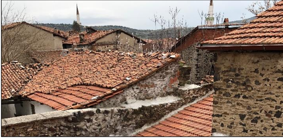
Şekil 3. 54. Alaturka kiremitin marsilya kiremit ile değiştirilmesi (Dizman, 2019)
