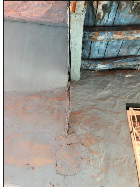
Şekil 3. 4. Cumba destek elemanının kaldırıldığı örnek (Dizman, 2019)
