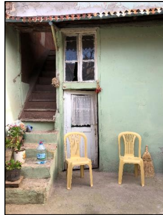
Şekil 3. 117. 118 numaralı ada 7 numaralı parsel dış sofaya çıkan rıhtı kapalı merdiven örneği (Dizman, 2019)
