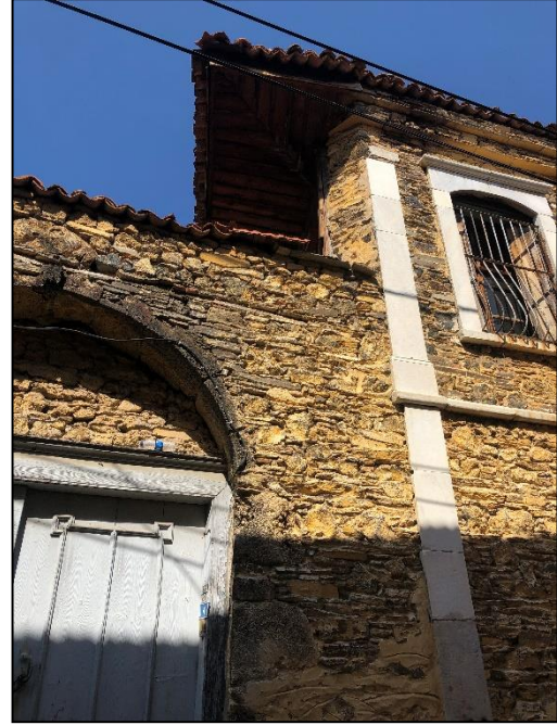
Şekil 3. 80. Köşe dikmesi örnekleri (Dizman, 2019)
