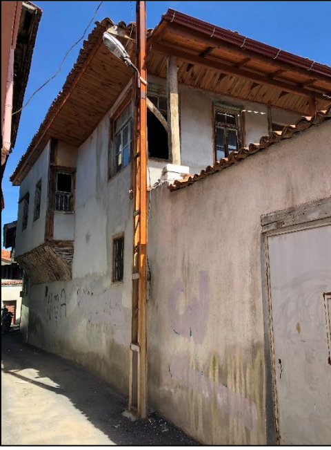
Şekil 3. 24. Kenarda düz cumba örneği (Dizman, 2019)
