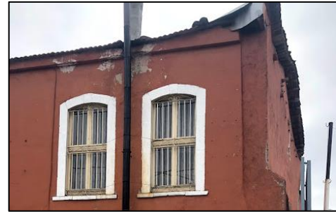
Şekil 3. 86. 113 numaralı ada 3 numaralı parsel sade demir malzemeli parmaklık örneği (Dizman, 2019)
