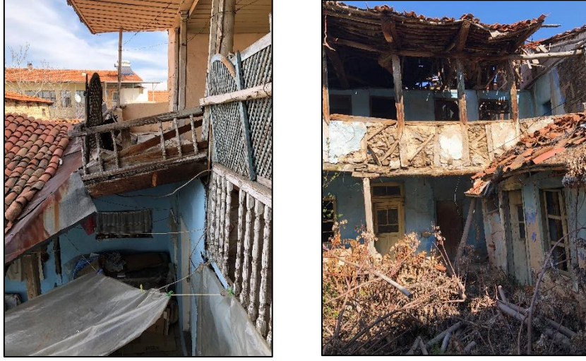
Şekil 3. 127. Taşıyıcı sistem bozulma örnekleri (Dizman, 2019)
