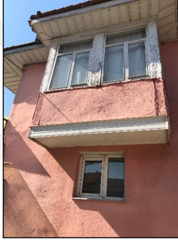
Şekil 3. 76. Boyanmış ahşap malzemeli cumba köşe dikmesi (Dizman, 2019)
