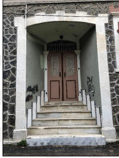
Şekil 3. 41. 114 numaralı ada 9 numaralı parsel kemerli giriş kapısı örneği (Dizman, 2019)
