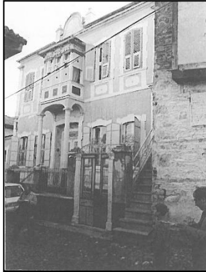
Şekil 3. 93. Kültür ve Turizm Bakanlığı Arşivi, 122 numaralı ada 7 numaralı parsel cumba penceresi kafes detayı (T.Y.)
