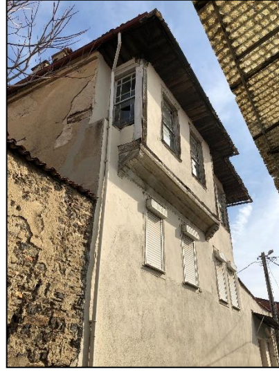
Şekil 3. 52. Cumba çatısı ana çatı ile bütün olan örnek 118 numaralı ada 10 numaralı parsel (Dizman, 2019)
