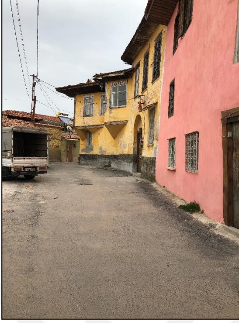
Şekil 3. 26. Testere cumba örneği (Dizman, 2019)
