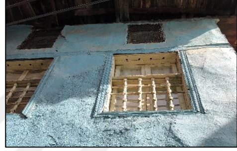
Şekil 3. 82. 117 numaralı ada 22 numaralı parsel yarım ahşap lokma parmaklık örneği (Dizman, 2019)
