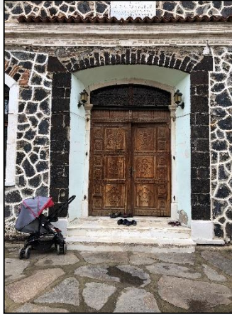
Şekil 3. 68. 111 numaralı ada 11 numaralı parsel taş söveli giriş kapısı örneği (Dizman, 2019)
