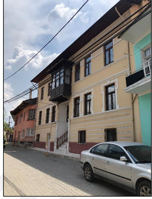
Şekil 3. 23. Ortada düz cumba örneği (Dizman, 2019)
