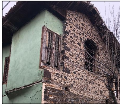
Şekil 3. 89. 111 numaralı ada 9 numaralı parsel ahşap malzemeli yatay ızgaralı kepenk örneği (Dizman, 2019)
