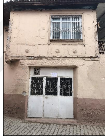
Şekil 3. 76. Boyanmış ahşap malzemeli cumba köşe dikmesi (Dizman, 2019)
