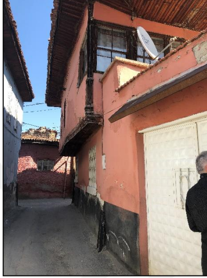
Şekil 3. 72. 116 numaralı ada 1 numaralı parsel çıkma altı ahşap silme örneği (Dizman, 2019)
