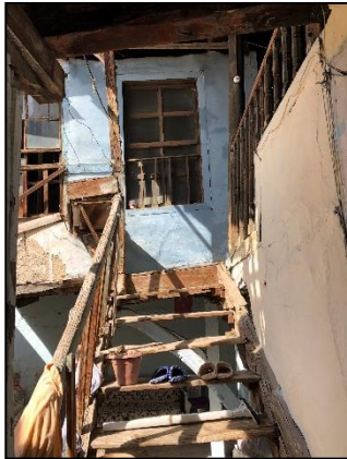
Şekil 3. 116. 118 numaralı ada 4 numaralı parsel dış sofaya çıkan rıhtı açık merdiven örneği (Dizman, 2019)
