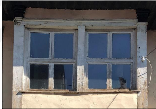
Şekil 3. 46. Ufki kayıt ile iki bölünen pecere örneği (Dizman, 2019)
