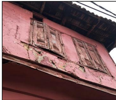
Şekil 3. 90. 114 numaralı ada 16 numaralı parsel yekpare detaylı ahşap malzemeli kepenk örneği (Dizman, 2019)
