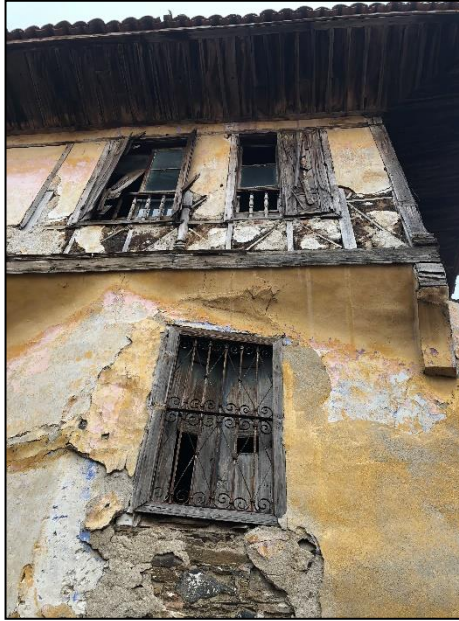
Şekil 3. 103. Ahşap iskelet (Dizman, 2019)
