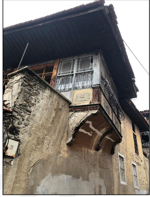
Şekil 3. 27. Kenarda gönyeli cumba örneği (Dizman, 2019)
