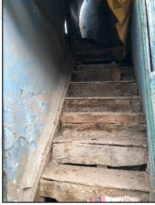
Şekil 3. 114. 113 numaralı ada 10 numaralı parsel merdiven örneği (Dizman, 2019)
