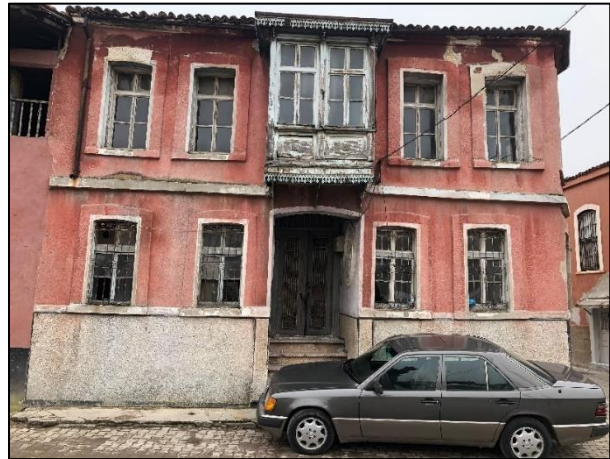
Şekil 3. 75. 111 numaralı ada 1 numaralı parsel taş kat silmesi örneği (Dizman, 2019)
