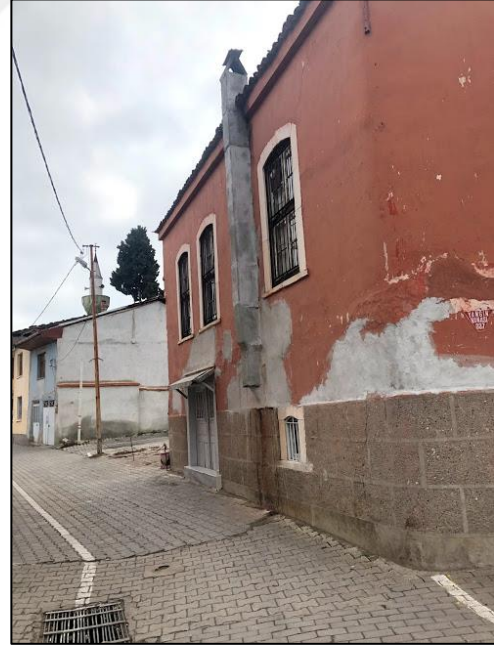
Şekil 3. 18. 109 numaralı ada 2 numaralı parsel geçit girişi (Dizman, 2019)
