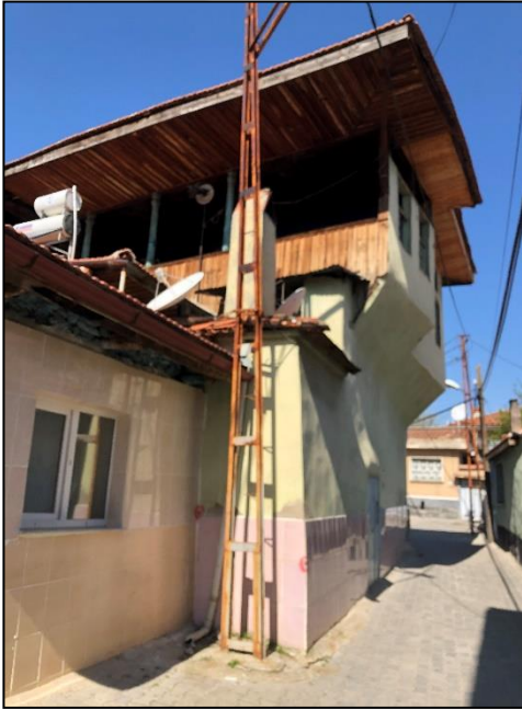
Şekil 3. 36. 116 numaralı ada 20 numaralı parsel üstü sıvalı bağdadi sistem ile dolgulu çıkma örneği (Dizman, 2019)
