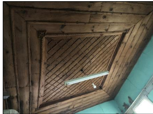
Şekil 3. 123. 116 numaralı ada 1 numaralı parsel çıtakâri teknik ile süslenmiş düz tavan örneği (Dizman, 2019)
