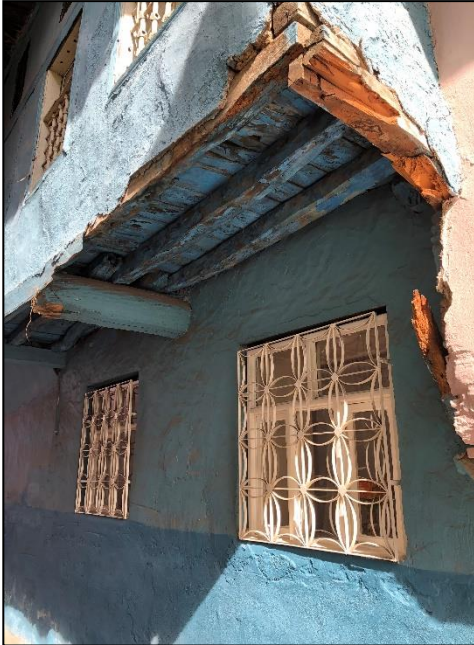
Şekil 3. 3. Cumba destek elemanının kaldırıldığı örnek (Dizman, 2019)
