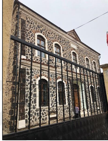
Şekil 3. 73. 111 numaralı ada 11 numaralı parsel dar saçak altı ve katlar arası silme örneği (Dizman, 2019)
