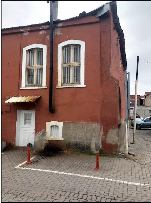
Şekil 3. 57. 109 numaralı ada 1 numaralı parsel altı kaplamasız dar saçak örneği (Dizman, 2019)
