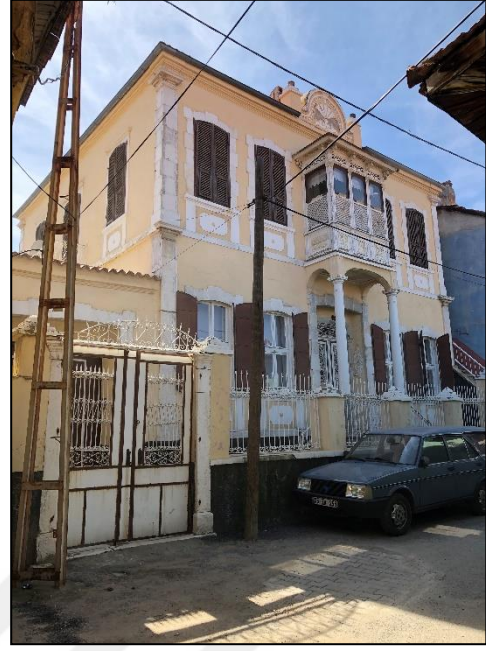
Şekil 3. 35. 122 numaralı ada 7 numaralı parsel kolon üzeri çıkma örneği (Dizman, 2019)
