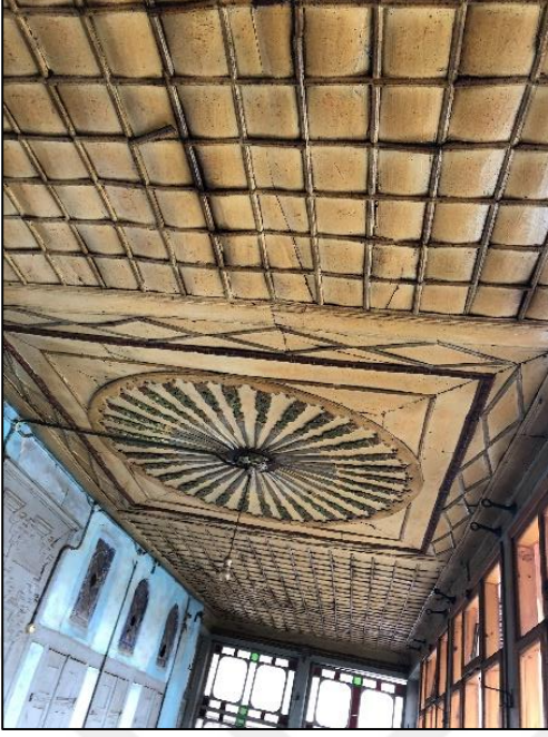
Şekil 3. 59. 111 numaralı ada 10 numaralı parsel sofa üstü, çatı altının ahşap malzeme ile kapatıldığı örnek (Dizman, 2019)
