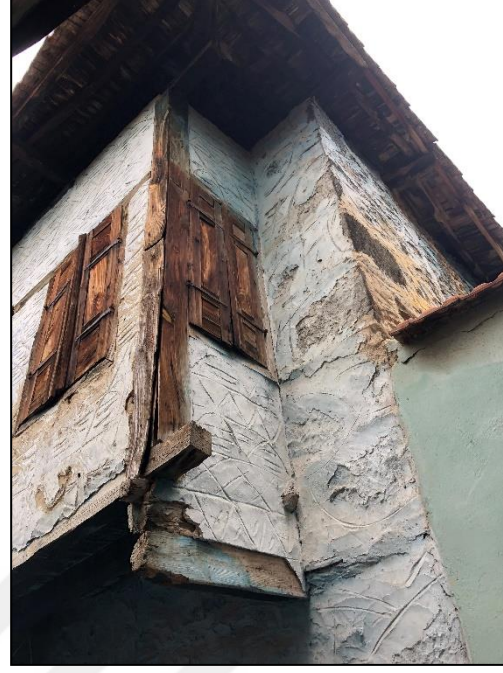
Şekil 3. 79. 111 numaralı ada 12 numaralı parsel sade ahşap malzemeli cumba köşe dikmesi örneği (Dizman, 2019)
