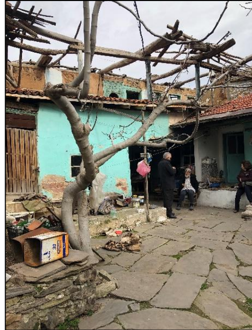
Şekil 3. 107. Avlu zemin döşeme malzemesi, kayrak taşı örneği (Dizman, 2019)
