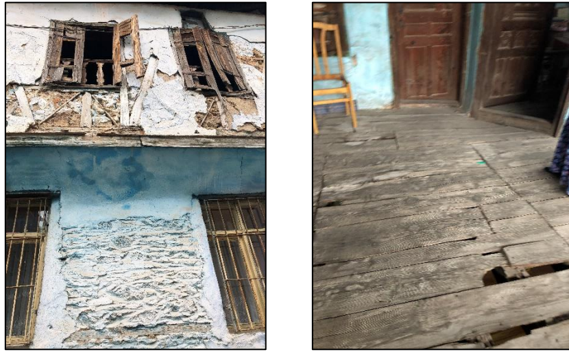
Şekil 3. 128. Malzeme bozulma örnekleri (Dizman, 2019)
