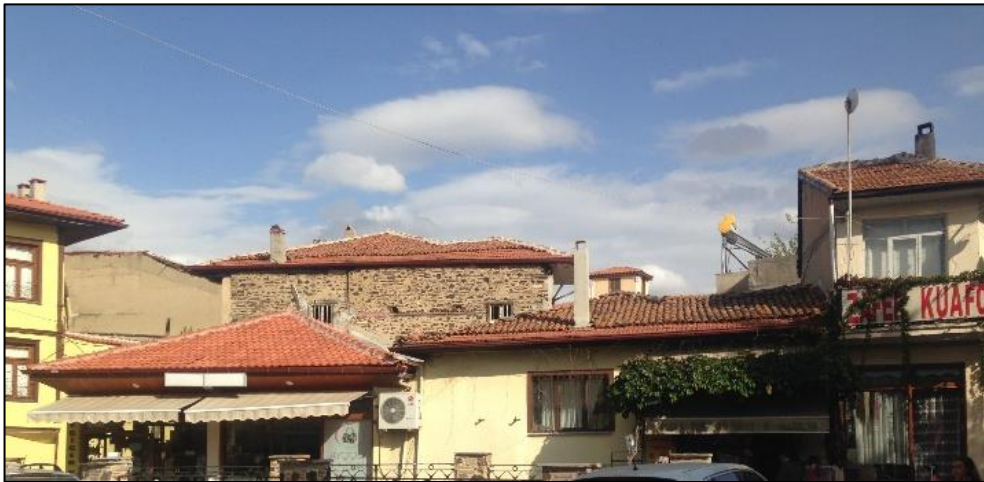
Şekil 3. 53. Saçak uçlarındaki alaturka kiremitin marsilya kiremit ile değiştirilmesi (Dizman, 2019)
