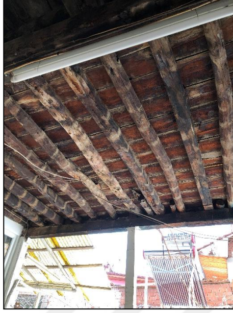
Şekil 3. 102. Ahşap döşeme kirişleri (Dizman, 2019)
