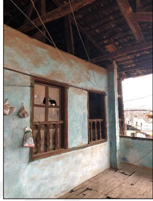
Şekil 3. 60. 111 numaralı ada 12 numaralı parsel sofa üstü, çatı altının kapatılmadığı örnek (Dizman, 2019)
