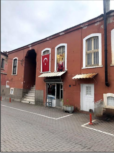
Şekil 3. 17. 109 numaralı ada 2 numaralı parsel bina girişi (Dizman, 2019)
