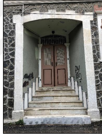
Şekil 3. 69. 114 numaralı ada 9 numaralı parsel taş söveli giriş kapısı örneği (Dizman, 2019)
