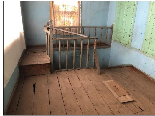
Şekil 3. 118. Çalışma alanındaki ahşap merdiven korkuluğu örnekleri (Dizman, 2019)
