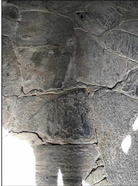
Şekil 3. 106. Avlu zemin döşeme malzemesi, kayrak taşı örneği (Dizman, 2019)
