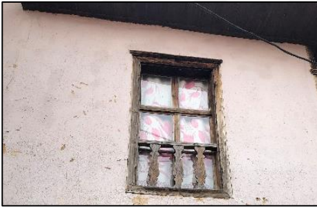
Şekil 3. 83. 114 numaralı ada 6 numaralı parsel ahşap malzemeli parmaklık örneği (Dizman, 2019)
