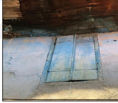
Şekil 3. 88. 109 numaralı ada 9 numaralı parsel yekpare sade ahşap malzemeli kepenk örneği (Dizman, 2019)
