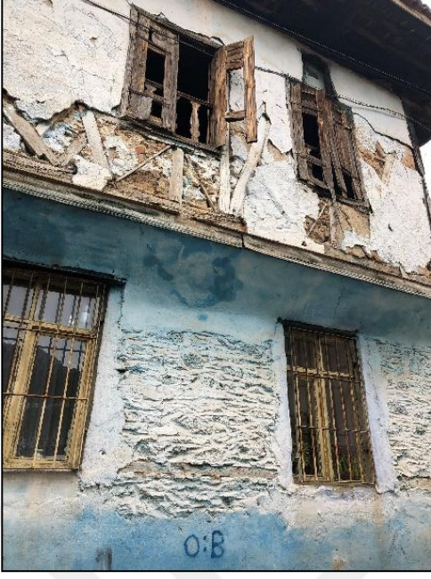
Şekil 3. 97. Yığma sistem ve ahşap karkas yapım sisteminin birlikte kullanıldığı sistem örneği (Dizman, 2019)
