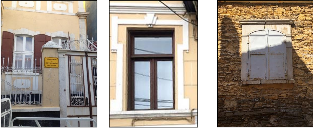
Şekil 3. 66. Taş - tuğla malzemeli pencere sövesi örnekleri (Dizman, 2019)
