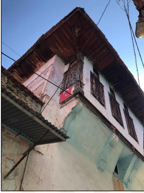
Şekil 3. 78. 116 numaralı ada 35 numaralı parsel işlemeli ahşap cumba köşe dikmesi örneği (Dizman, 2019)
