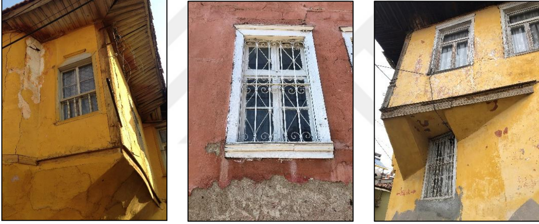
Şekil 3. 65. Düz silmeli ahşap malzemeli pencere sövesi örnekleri (Dizman, 2019)
