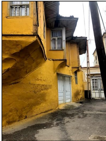
Şekil 3. 74. 122 numaralı ada 8 numaralı parsel ahşap kat silmesi örneği (Dizman, 2019)
