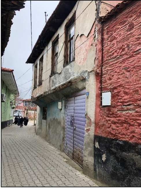
Şekil 3. 28. Cephe boyu gönyeli cumba örneği (Dizman, 2019)
