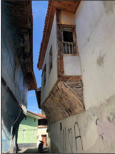
Şekil 3. 37. 110 numaralı ada 1 numaralı parsel üstü sıvasız bağdadi sistem ile dolgulu çıkma örneği (Dizman, 2019)
