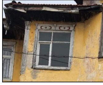
Şekil 3. 67. Detaylı ahşap malzeme pencere sövesi örnekleri (Dizman, 2019)
