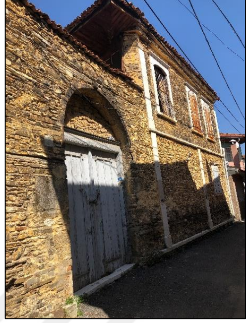
Şekil 3. 98. Yığma sistem örneği (Dizman, 2019)
