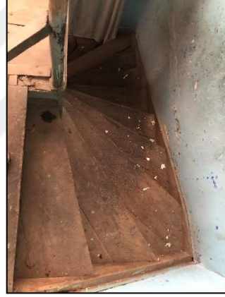
Şekil 3. 115. 113 numaralı ada 20 numaralı parsel merdiven örneği (Dizman, 2019)
