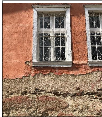
Şekil 3. 47. Ufki Kayıt ile ikiye bölünen pencere örneği (Dizman, 2019)
