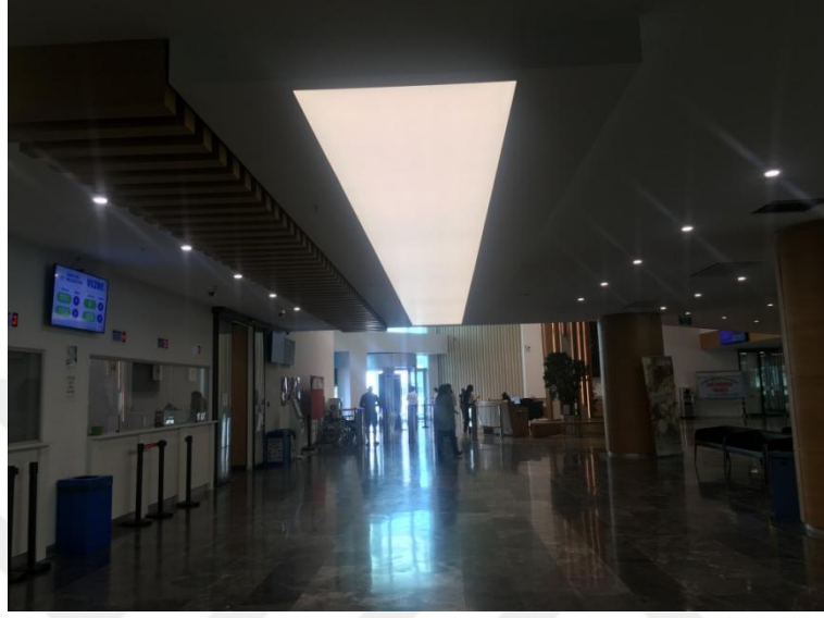
Şekil 3.20. Sarıyer Belediye Binası 180cm Lineer Led Armatür [77].
