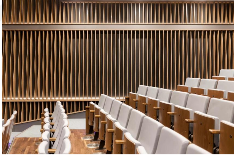
Şekil 3.12. Boğaziçi Kültür ve Sanat Merkezi Salonu Ceviz Ahşap Panel Kaplı Duvar [79].
