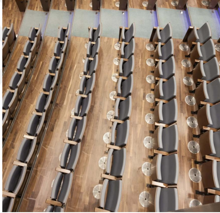
Şekil 3.16. Boğaziçi Kültür ve Sanat Merkezi Salonu Yükseltilmiş Parke Zemin Kaplama [79].
