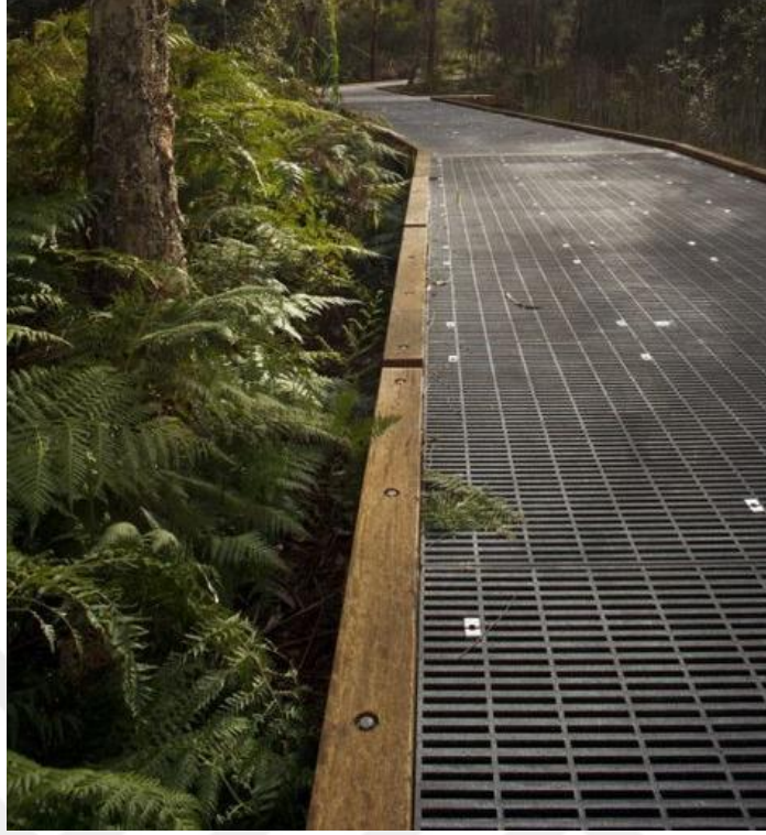
Şekil 1.6. Metal Zemin Uygulaması [32]
