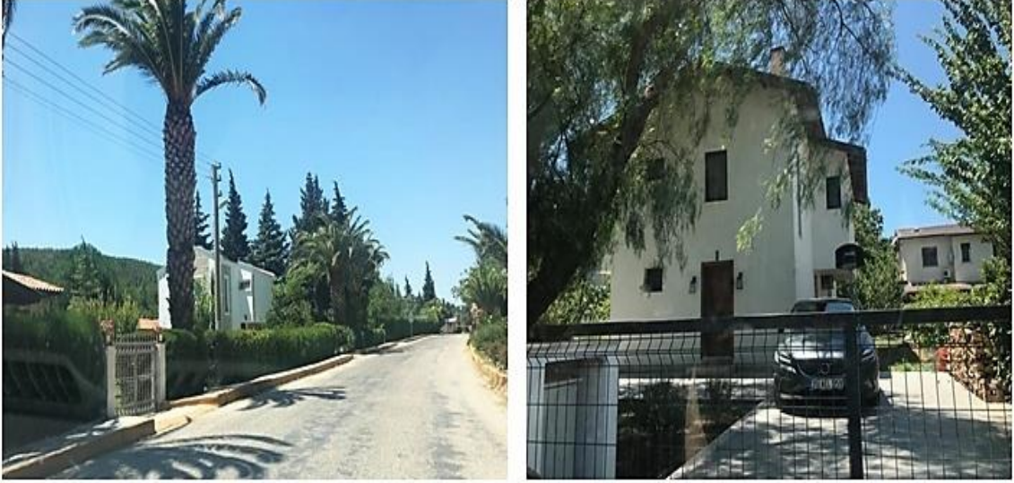
Şekil 77. Altıncöy Sitesindeki Bahçeli Konutlar
