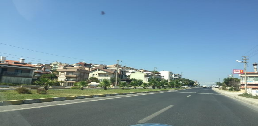
Şekil 70. D300 Yolunun Kıyıda İç Kısımına Doğru Olan Yapılaşmalar
