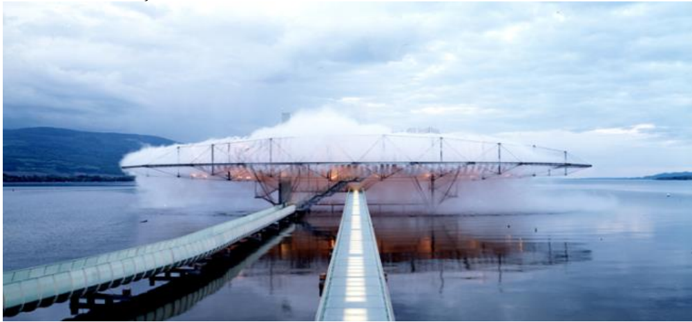
Şekil 2.6. Bulanık Binası'nın Sisli Görünümü
