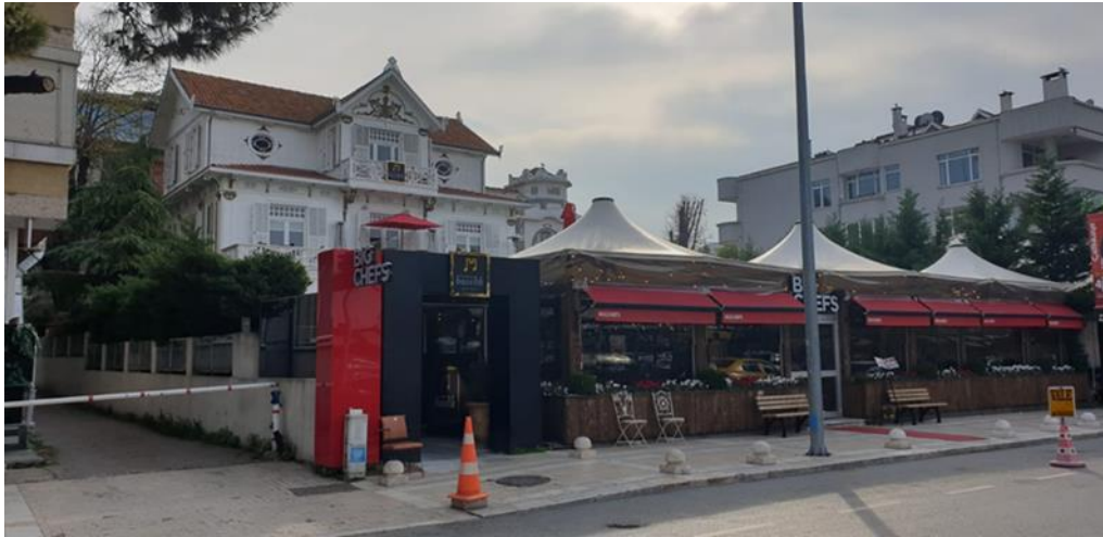
Şekil 62. Kafeterya Bölümünün Güncel Hali, Ön ve Yan Cephe (Antika,B.E., 2019).
