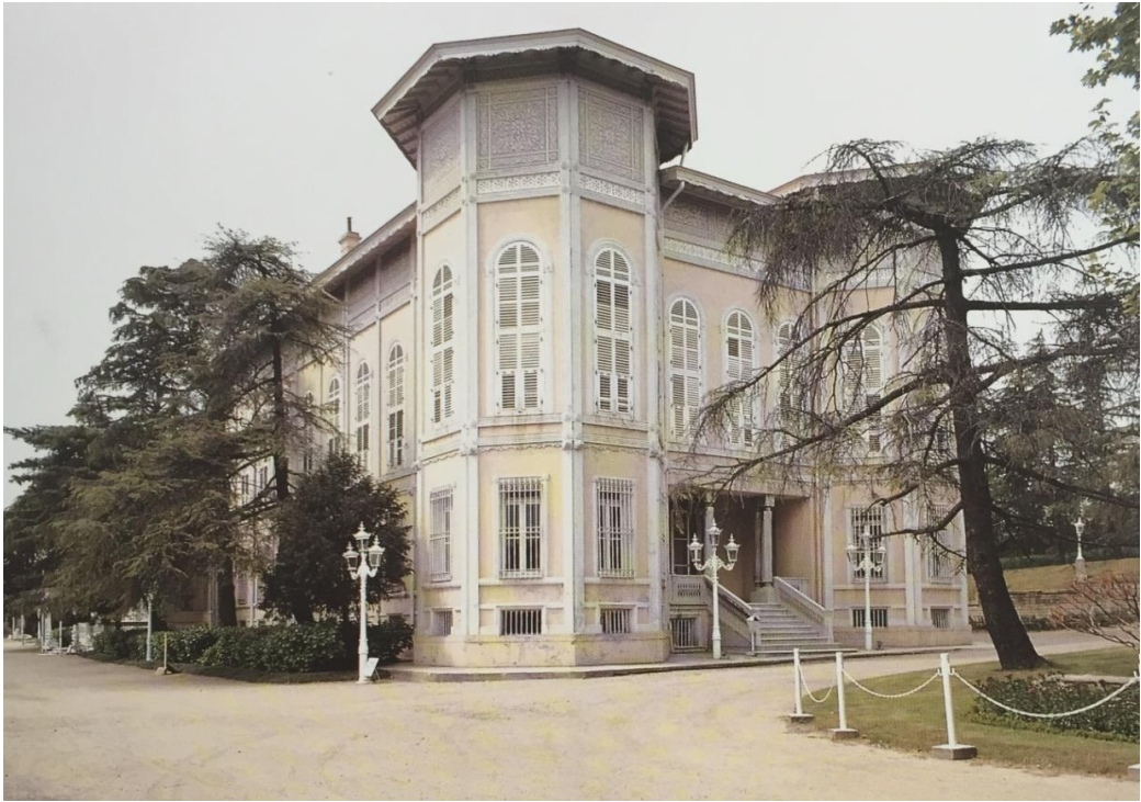
Şekil 106. Şale Köşkü, (Barillari & Godoli, 1997)
