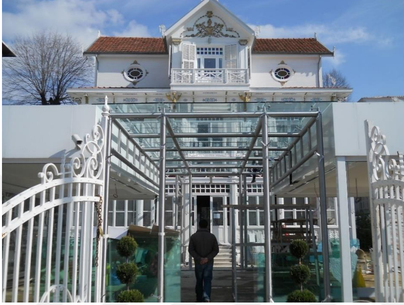
Şekil 57. Köşk Restorasyon sonrası, (Uzun, B, 2015).
