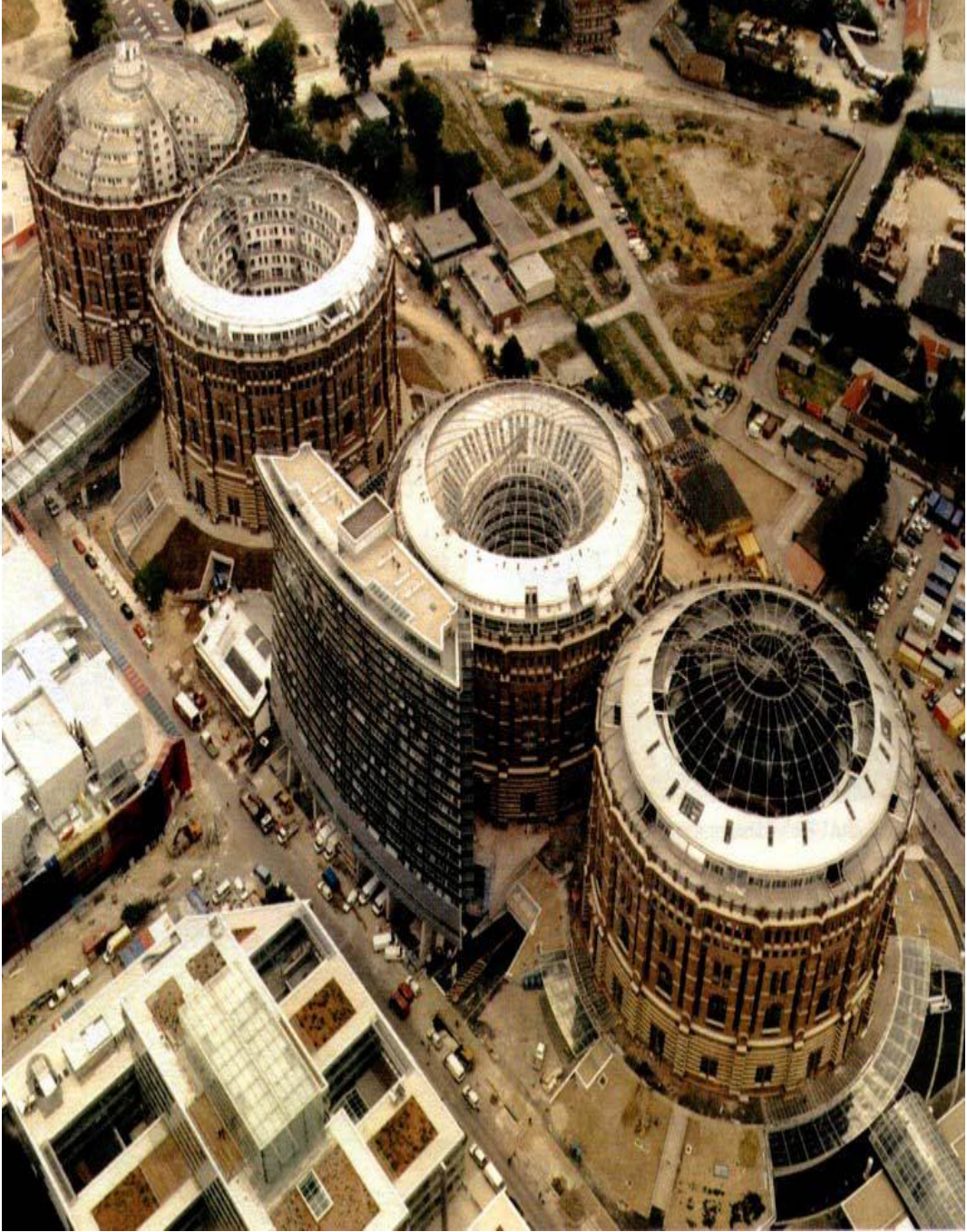
Şekil 18. Viyana Gazometreleri Dönüşüm Sonrası Genel Görünüşü, (Wehdorn, 2002a)
