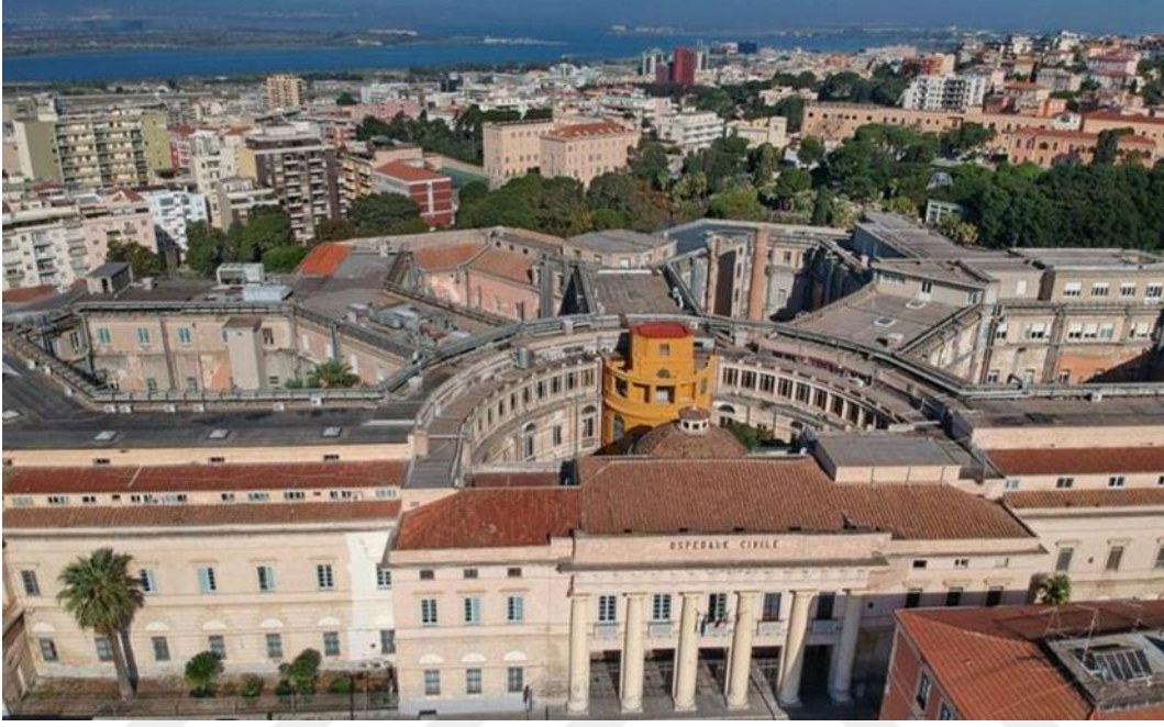
Şekil 32. İşlevlendirme sonrası Hastanenin Ön Cephe Görünüşü, Güncel Hali, (Url-3, 2019).
