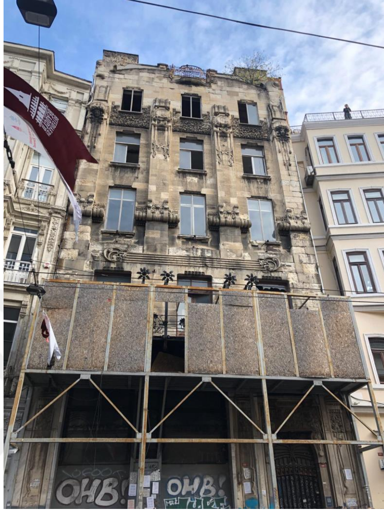
Şekil 96. Botter Apartmanı Ön Görünüşü, (Antika,B.E., 2019).
