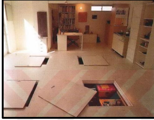
Şekil 4. 57 Döşeme Altı Çözümleri Kaynak: Kürşat,2006 E.T. 05.02.2018
