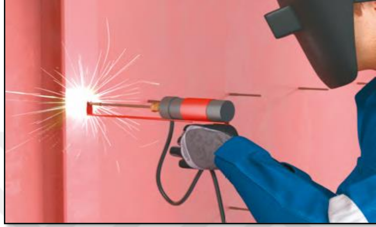
Resim 4-70: Çivi kaynatma (Rockwool)
