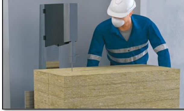
Resim 4-72: İzolasyon kesimi (Rockwool)
