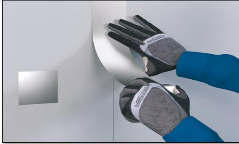
Resim 4-76: İzolasyon folyo kaplaması (Rockwool)
