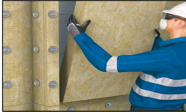
Resim 4-74: Profile izolasyon uygulaması (Rockwool)
