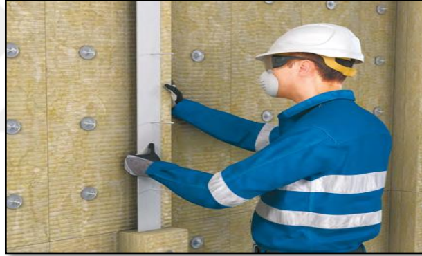
Resim 4-73: İzolasyon uygulaması (Rockwool)
