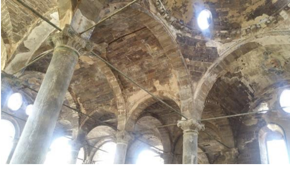
Foto.104 : Kayseri Endürlük Karamanlı Kilisesinin içten örtü sistemi
