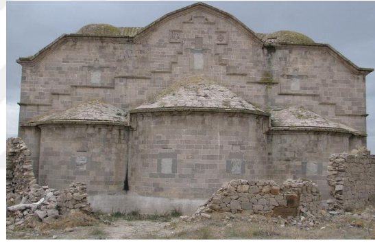
Foto.343:Niğde Konaklı (Misti) Karamanlı Kilisesinin doğu cephede üç apsisi
