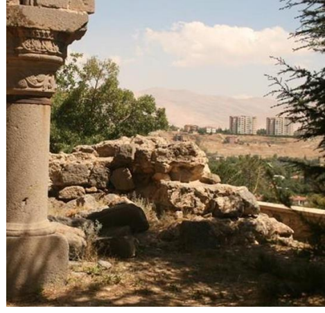
Foto.292:Niğde Hamamlı (Kurdunos) Karamanlı Kilisesi çan kulesinin kalıntıları
