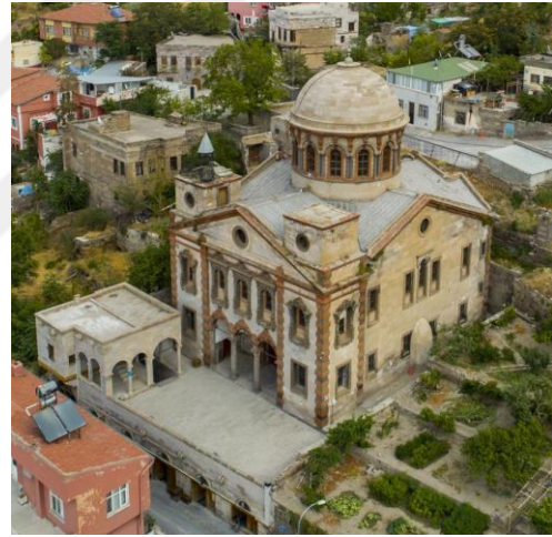
Foto.113: Kayseri Talas Panaya Karamanlı Kilisesi (Foto. Kayseri Büyükşehir Belediyesi, Havadan Kayseri )
