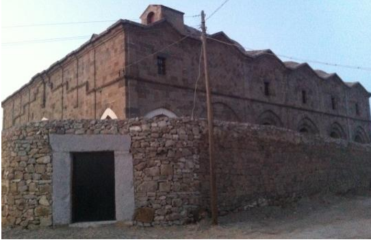
Foto.342:Niğde Konaklı (Misti) Karamanlı Kilisesine güneybatı ihata duvarından giriş
