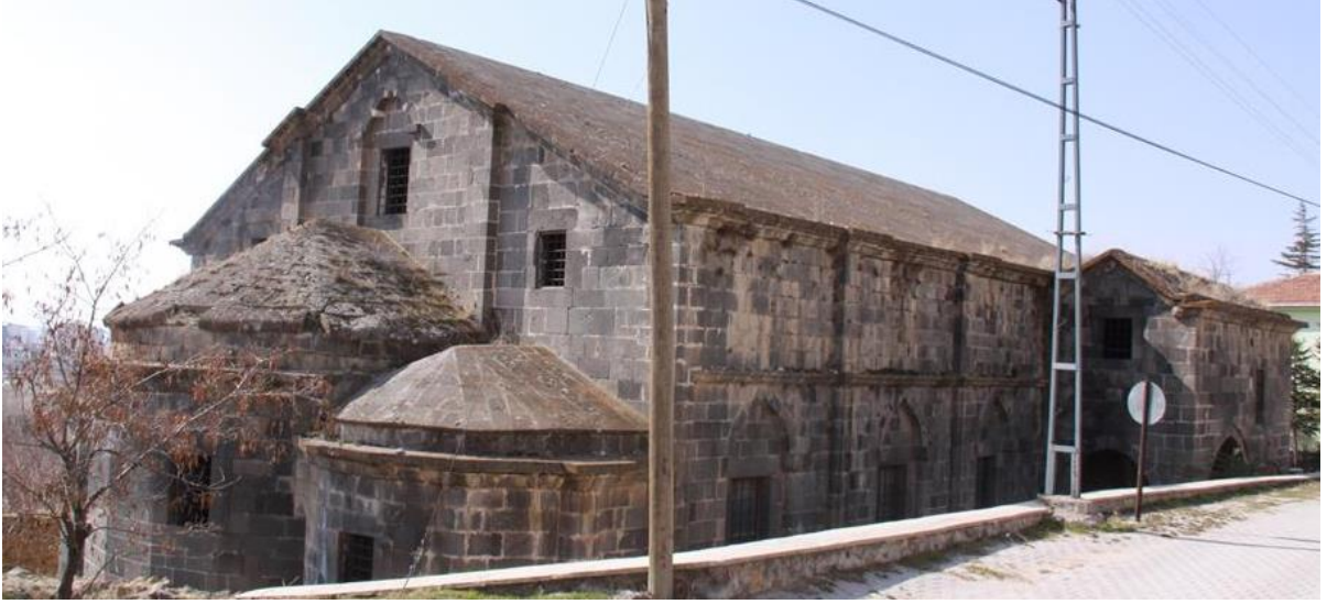
Foto.290 : Niğde Hamamlı (Kurdunos) Karamanlı Kilisesinin kuzeydoğu cephesi
