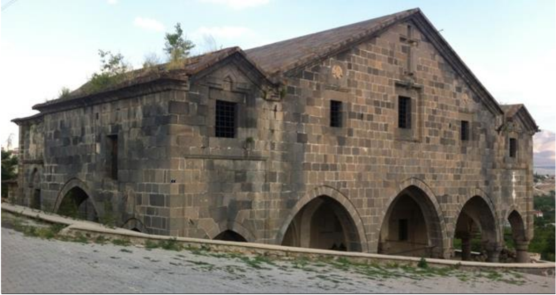
Foto.288 : Niğde Hamamlı (Kurdunos) Karamanlı Kilisesinin kuzeybatı cephesi
