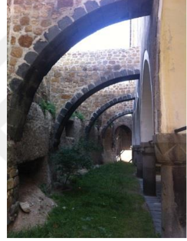
Foto.323, 324 : Niğde Karamanlı Kilisesi narteksi ( 323 ) ve batıda uçan payandaları ( 324 )
