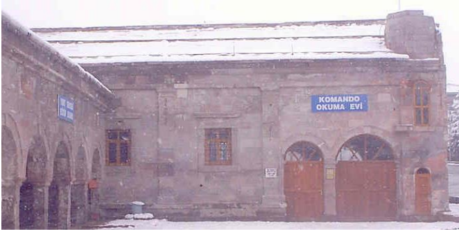
Foto.149:Zincidere Aziz Haralambos Şapelinin kuzey cephesi (C.Ekin, 2004)
