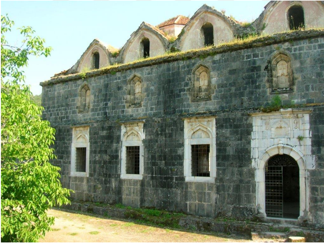
Foto 455 : Muğla Fethiye Kayaköy Pırgotıssa Kilisesinin fenerli çatısı
