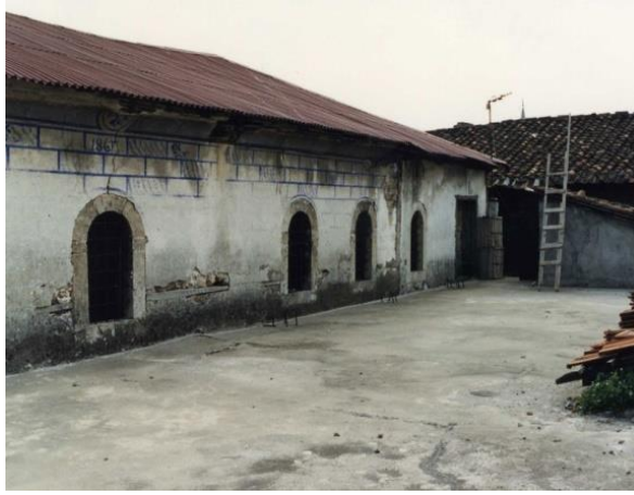
Foto.36 : Antalya Agios Georgios Karamanlı Kilisesinin restorasyon öncesi güney cephedeki ekler
