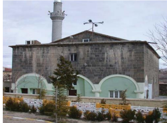
Foto.366:NiğdeKumluca (Aravan) Karamanlı Kilisesinin batı cephesi
