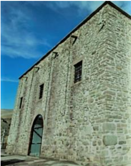
Foto.176:Konya Sille Aya Eleni Karamanlı Kilisesinin batı cephesi
