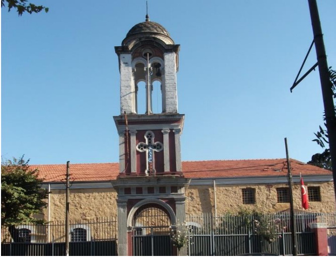
Foto.65:İstanbul Samatya Konstantin Helena Karamanlı Kilisesin kuzey cephesi ve çan kulesi (C.Ekin, 2017)
