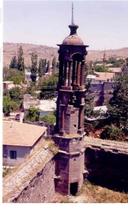
Foto.103:Kayseri Endürlük Kilisesinin çan kulesi (C.Ekin, 2005)
