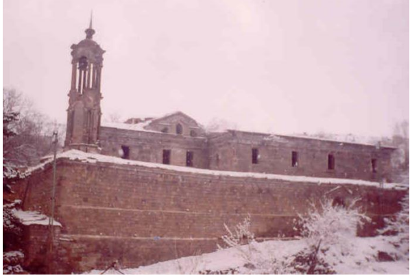
Foto.97:Kayseri Endürlük Karamanlı Kilisesinin ve ihata duvarı, çan kulesi kuzey cephesi ( C.Ekin'den, 2005)
