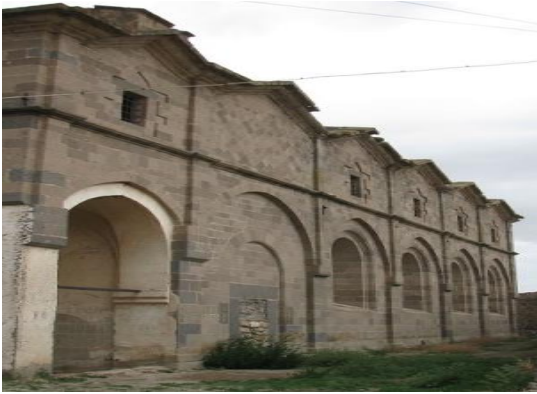
Foto.347:Niğde Konaklı (Misti) Karamanlı Karamanlı Kilisesinin güney cephesi
