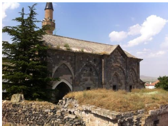
Foto.222:Nevşehir Özlüce (Zile) Karamanlı Kilisesinin güney cephesi (C.Ekin, 2017 )
