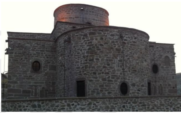
Foto.175:Konya Sille Aya Eleni Karamanlı Kilisesinin doğu cephe (C.Ekin, 2017)
