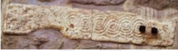
Foto.183:Konya Sille Aya Eleni Karamanlı Kilisesi güney cephede devşirme malzeme (ambon parçası, C.Ekin, 2017)
