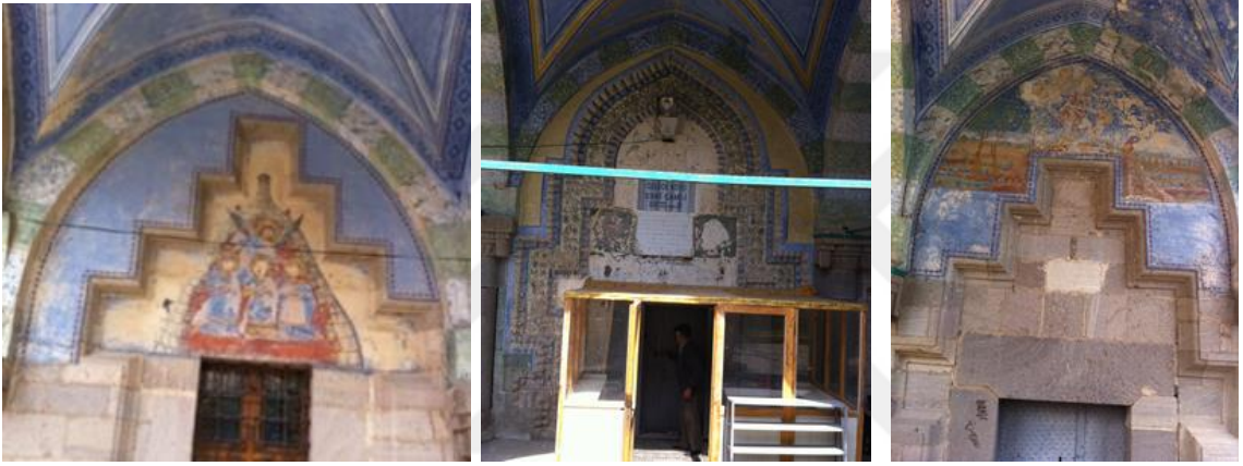
Foto.225- 227 : Nevşehir Özlüce (Zile) Karamanlı Kilisesinin narteks doğu duvarında kuzey pencere (225), eksendeki (226) ve güneydeki giriş (227) ( C.Ekin, 2017 )
