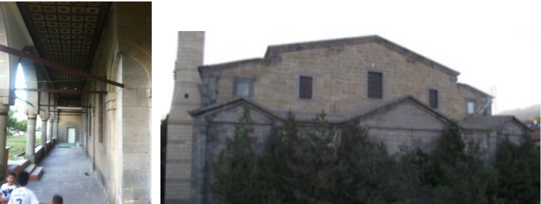
Foto.272, 273 : Niğde Fertek Karamanlı Kilisesi kuzey narteks ( 272 ) ve doğu ( 273 ) cephe
