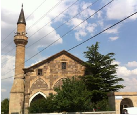
Foto.219: Nevşehir Özlüce (Zile) Karamanlı Kilisesinin batı cephesi (C.Ekin,2017 )
