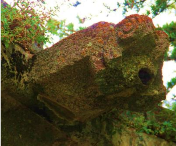
Foto.398 : Niğde Yeşilburç Karamanlı Kilisesinin doğu cephesinde çörtlen
